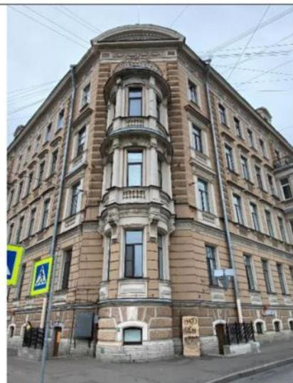
эркеры в уровне 2-3-го этажей, на волутообразных кронштейнах, завершенные в уровне 4-го этажа балконами, – местоположение (два на фасаде со стороны Большого пр., два – со стороны 4-й линии), габариты, конфигурация (прямоугольные в плане);
