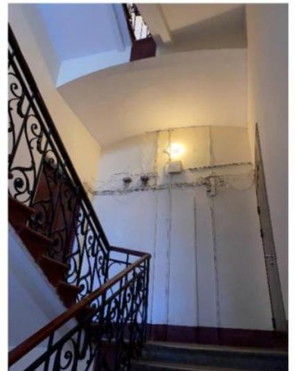
ограждение маршей – материал (черный металл), техника исполнения (ковка, горячий прокат, слесарная сборка), рисунок (вертикальные стержни; на лестницах лицевых корпусов – геометрический орнамент с мотивом завитков);
