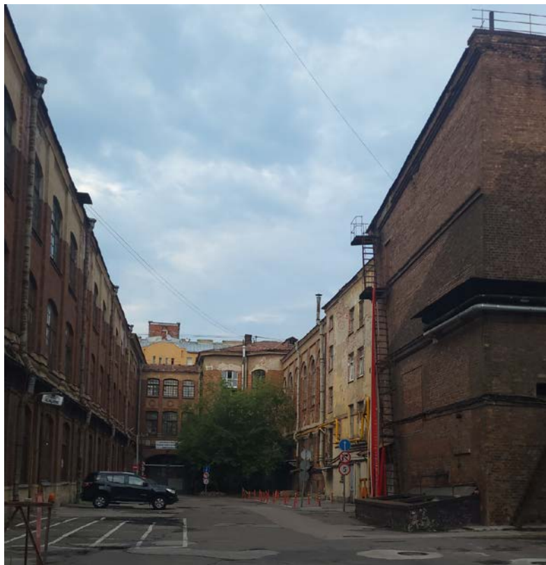
Фото 1. Объект культурного наследия регионального значения «Государственная типография» (Чкаловский пр., 15; Гатчинская ул., 26; Ораниенбаумская ул., 27) . Дата съемки:01.09.2024
