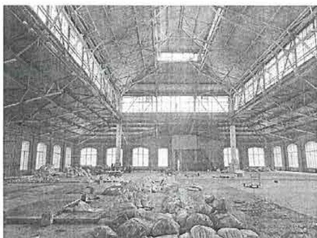
22. Помещение второго этажа (двухэтажного дворового корпуса)
