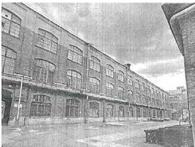
4. Вид на восточный фасад объекта культурного наследия («П»-образный трехэтажный корпус)
