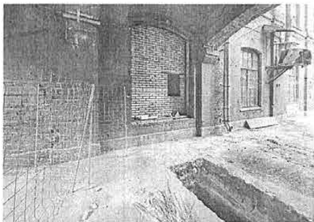
8. Северный проезд (между трехэтажным и двухэтажным корпусом)
