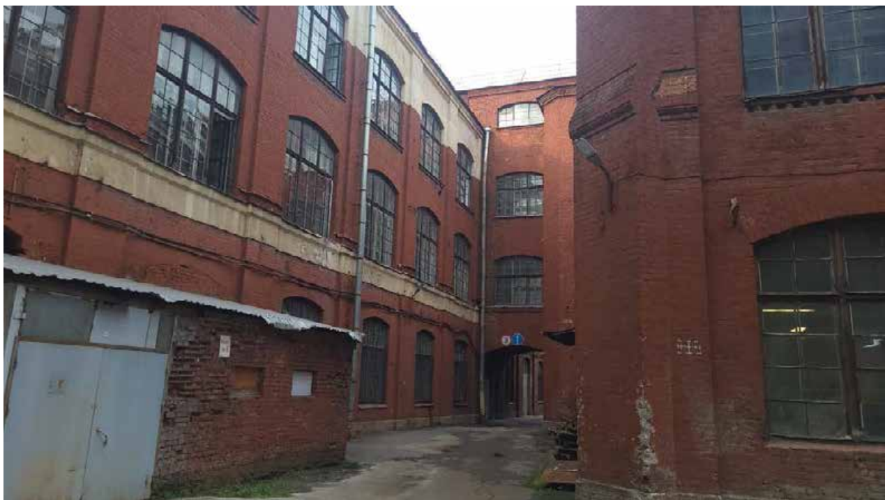
Фото 4. Объект культурного наследия регионального значения «Государственная типография» (Чкаловский пр., 15; Гатчинская ул., 26; Ораниенбаумская ул., 27) . Дата съемки:01.09.2024
