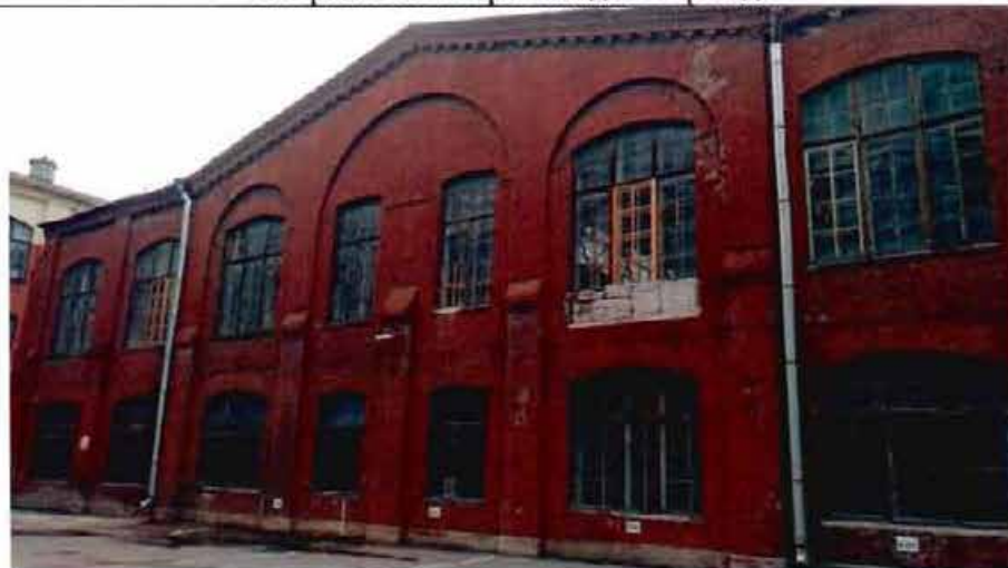
3. Фрагмент юго-западного фасада
