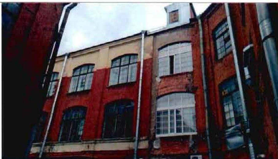
4. Фрагмент дворового фасада
