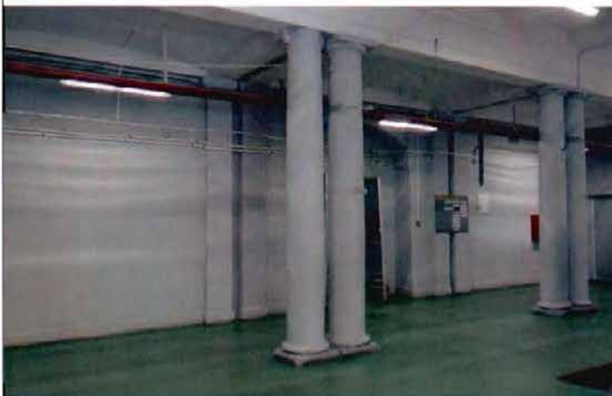
6. Вестибюль парадного входа
