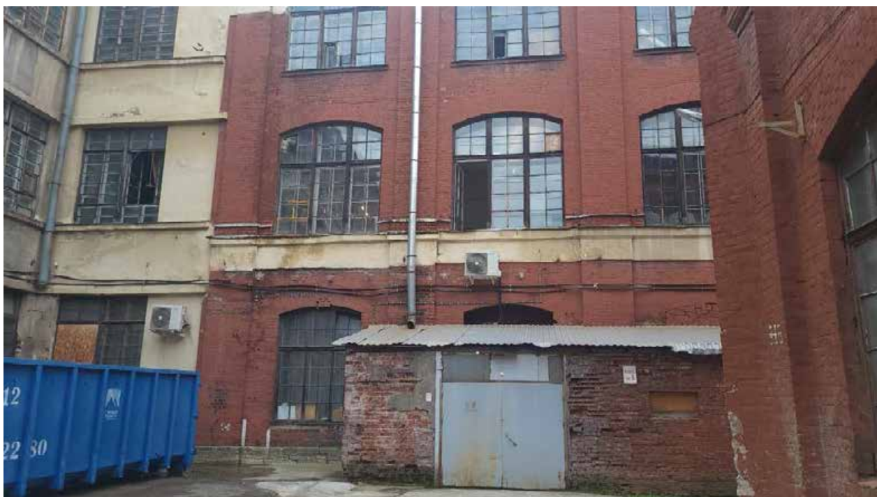
Фото 3. Объект культурного наследия регионального значения «Государственная типография» (Чкаловский пр., 15; Гатчинская ул., 26; Ораниенбаумская ул., 27) . Дата съемки:01.09.2024
