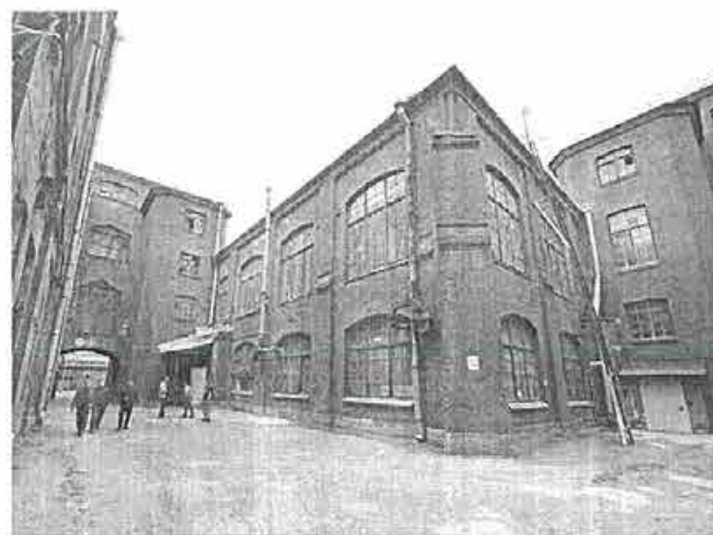
5. Фрагмент северо-восточного фасада объекта культурного наследия (двухэтажный дворовой корпус)
