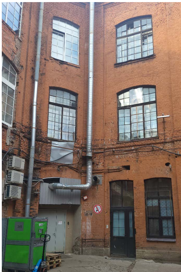
Фото 8. Объект культурного наследия регионального значения «Государственная типография» (Чкаловский пр., 15; Гатчинская ул., 26; Ораниенбаумская ул., 27) . Дата съемки:01.09.2024
