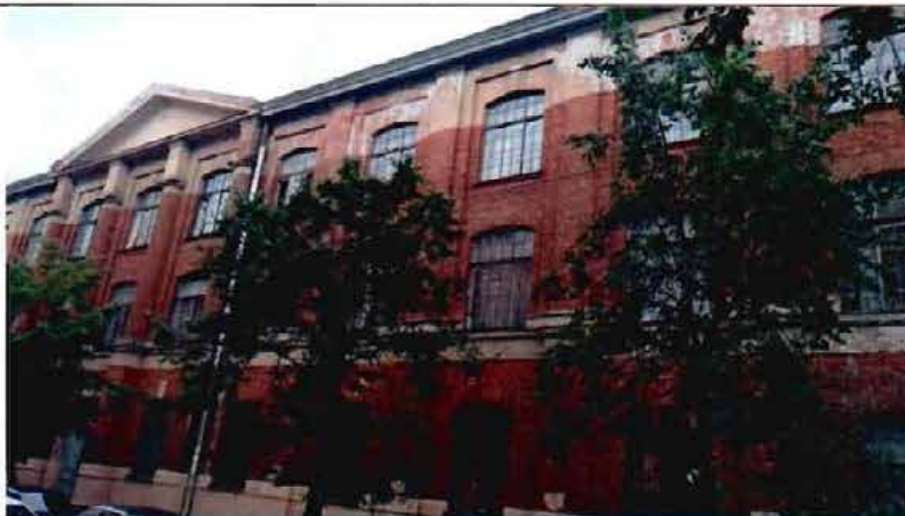
1. Фрагмент северо-восточного фасада
