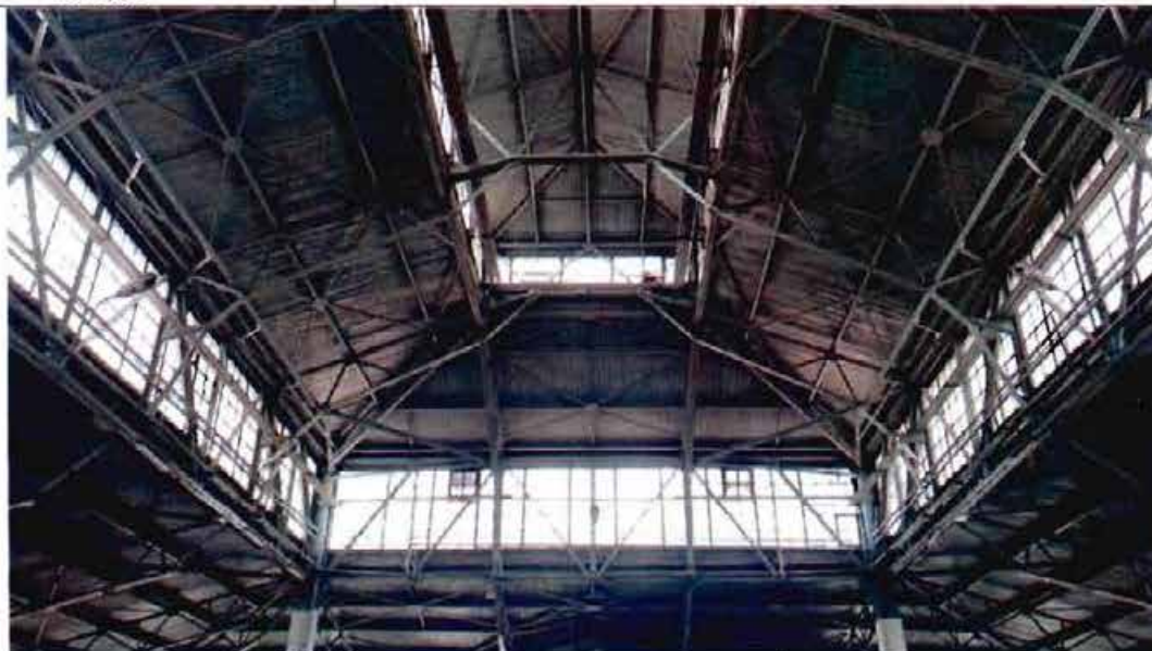
7. Металлоконструкции светового фонаря
