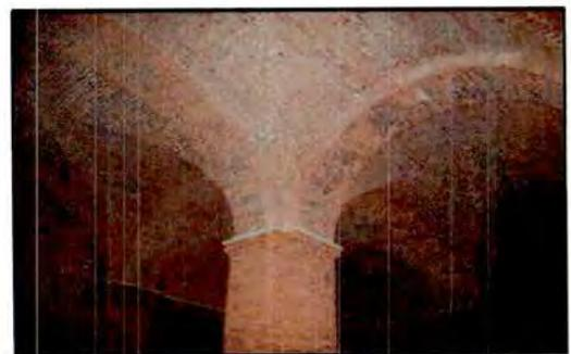
пилон, цилиндрический свод с распалубками на подпружных арках (1Н, пом. 53 (два сводчатых перекрытия в центральной части));
