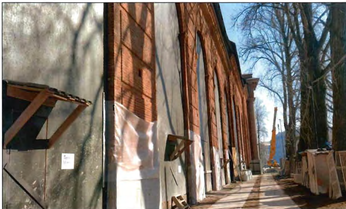
27. Фрагмент южного дворового фасада объекта культурного наследия.
