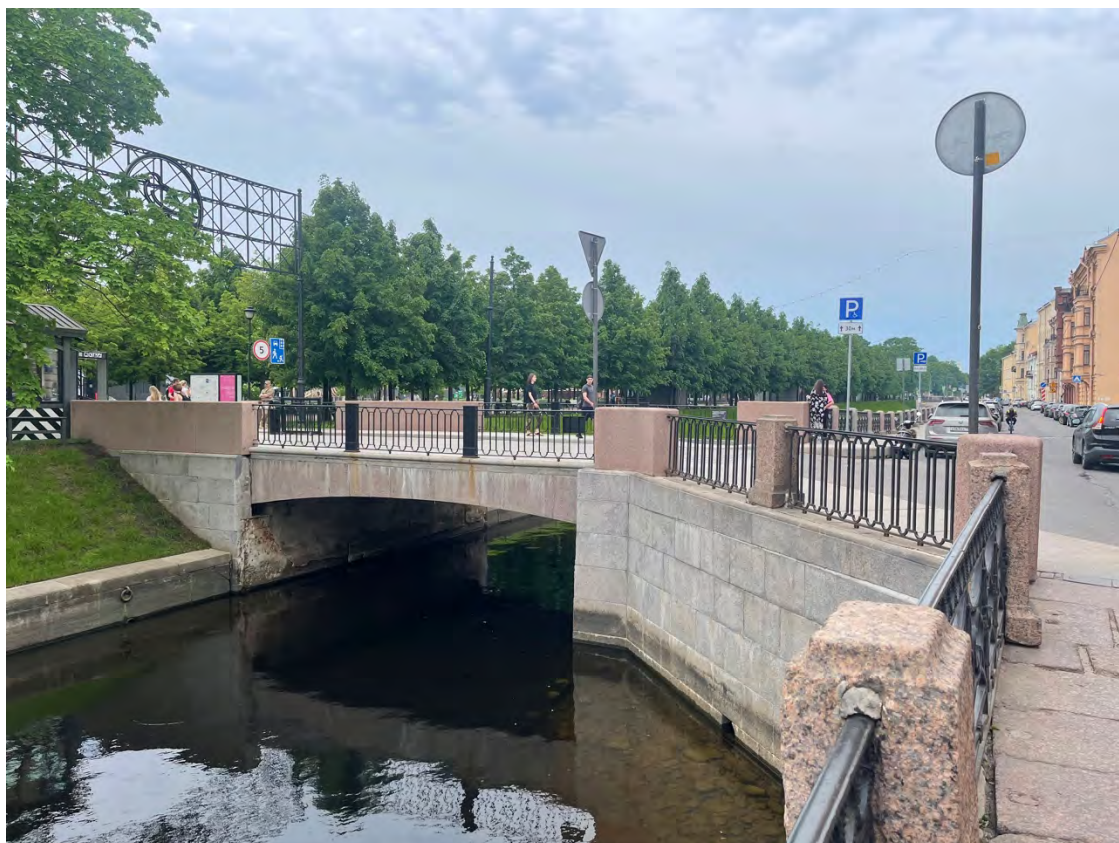
5. Вид на 1-й мост Круштейна;
