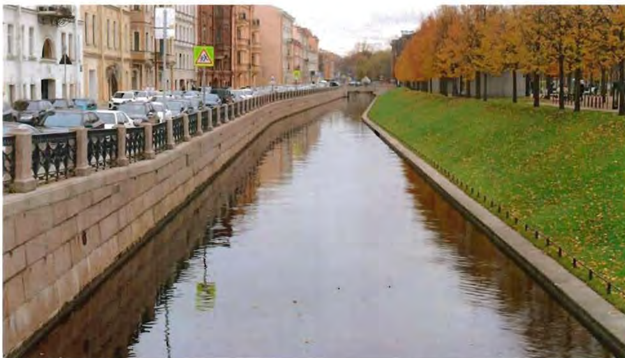
1. Вид на объект культурного наследия со 2-го моста Круштейна в северо-восточную сторону.
