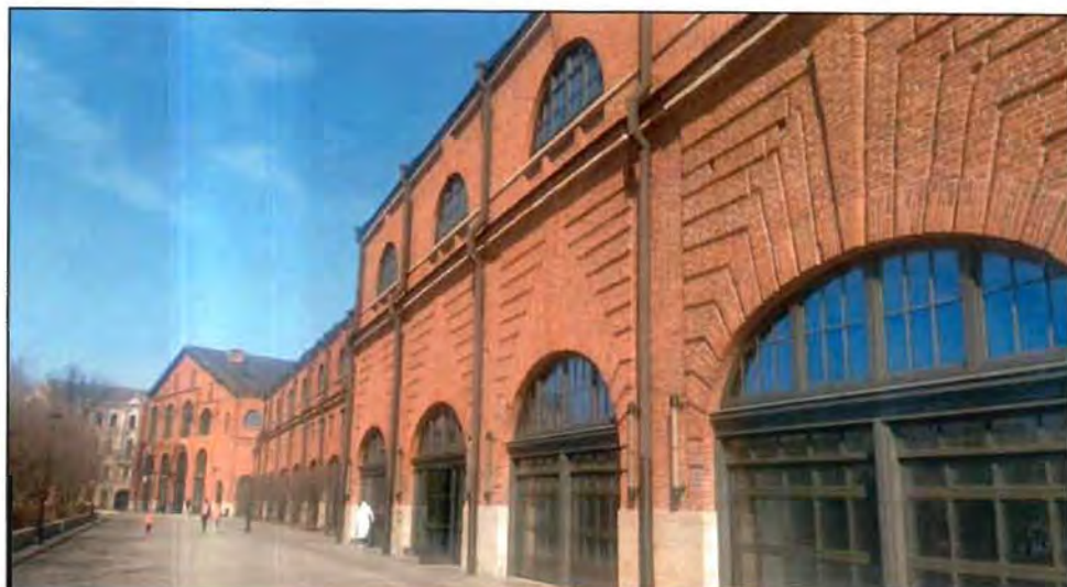
3. Западный фасад объекта культурного наследия.
