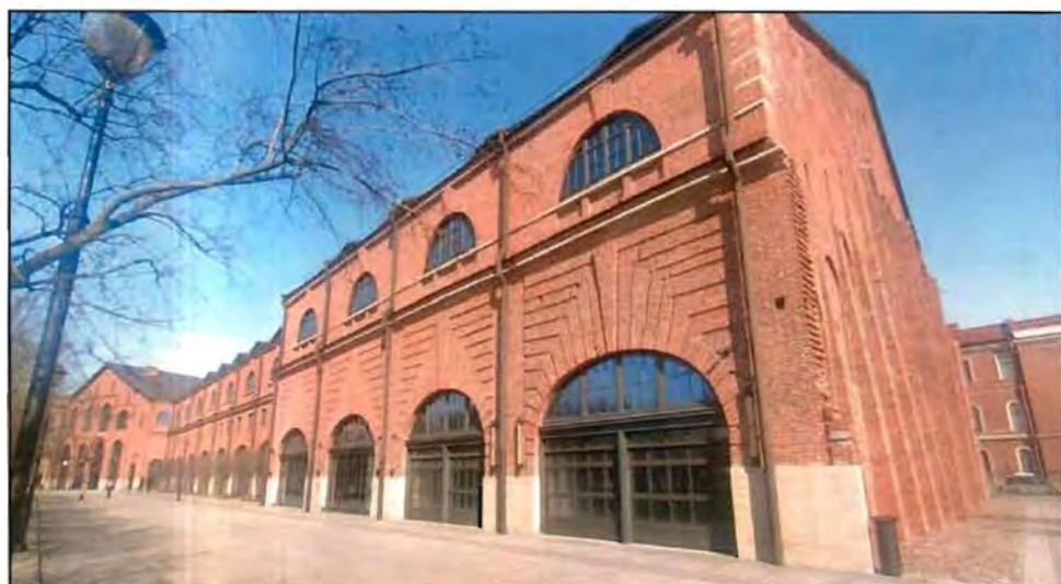
4. Западный фасад объекта культурного наследия.
