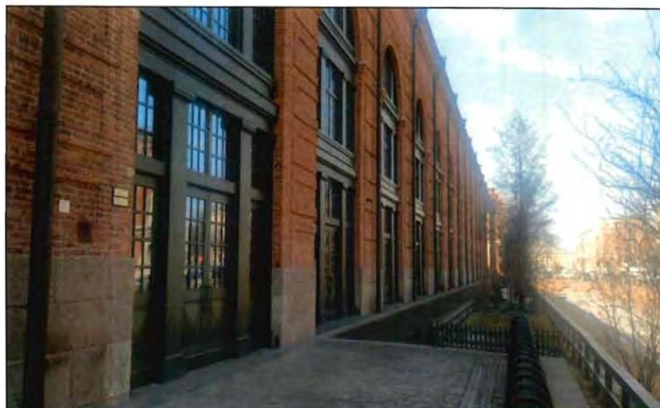
8. Восточный фасад объекта культурного наследия.
