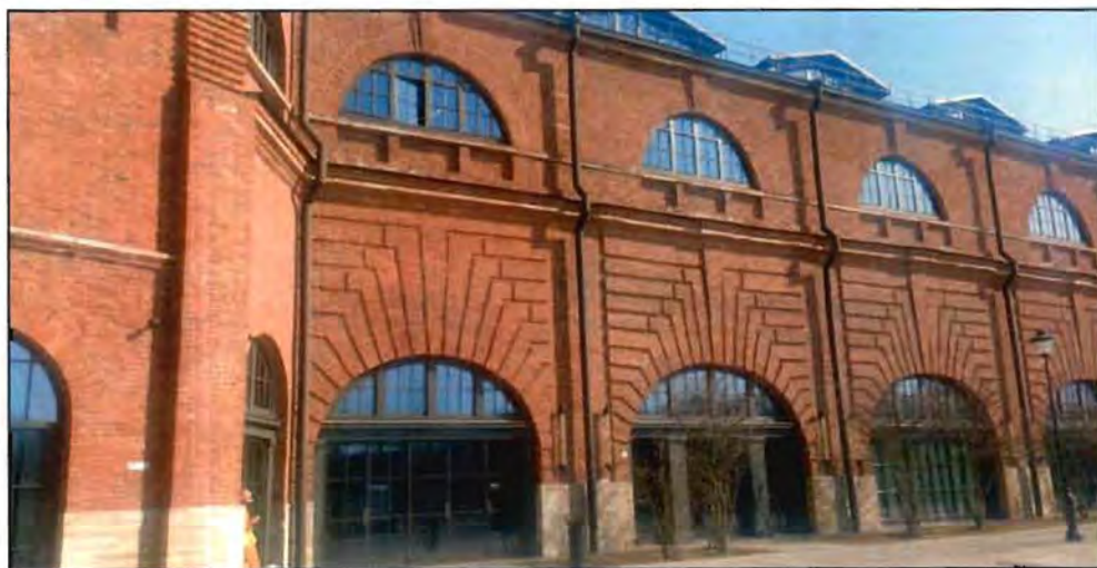
5. Фрагмент западного фасада объекта культурного наследия.
