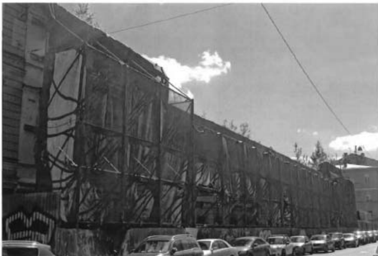
2. Вид на объект культурного наследия с северо-восточной стороны.
