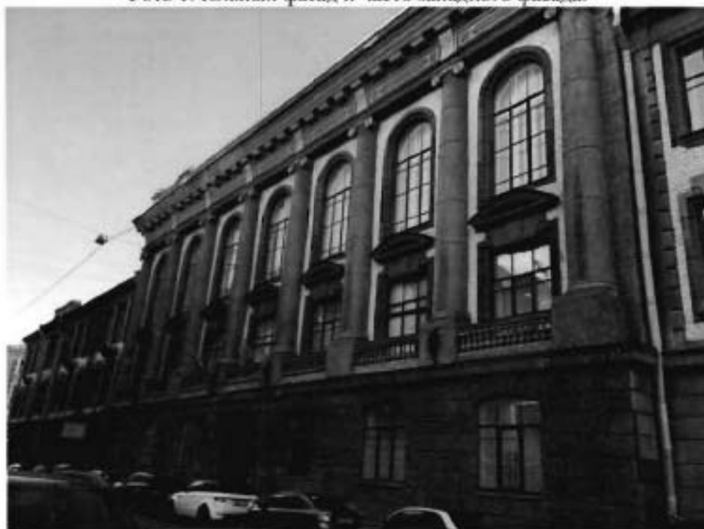
Фото 2. Часть южного фасада.
