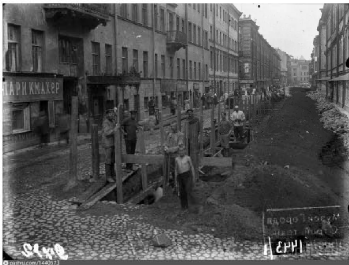
55. Капитализационные работы в Демидовом переулке. 1920–1930 гг. // Источник: https://rastvu.com/p/1440573 (дата обращения: 25.04.2024).
