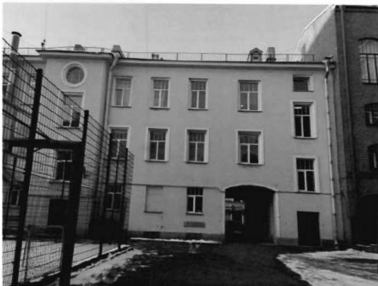
Фото 7. Дворовый фасад (западный).
