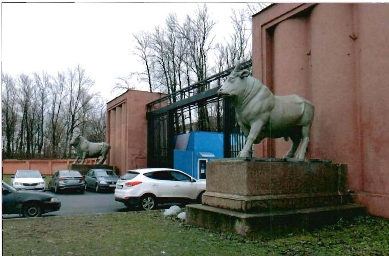
1. Общий вид с севера.
