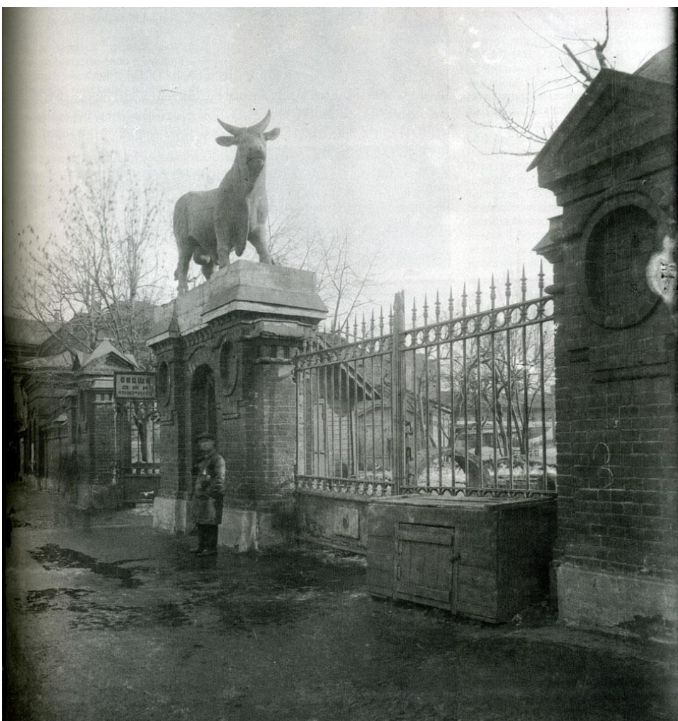
Илл. 33. Пилон ворот и вид на бывшее здание Мясной биржи. 1932 // Москомнаследие
