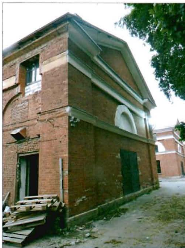
12. «Хлебный амбар» (наб. Обводного кан., 5, лит. Б). Северный фасад. Вид с северо-востока.
