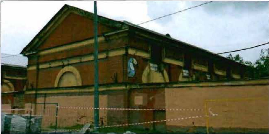
6. «Хлебный амбар» (наб. Обводного кан., 5, лит. А). Общий вид с юго-востока.
