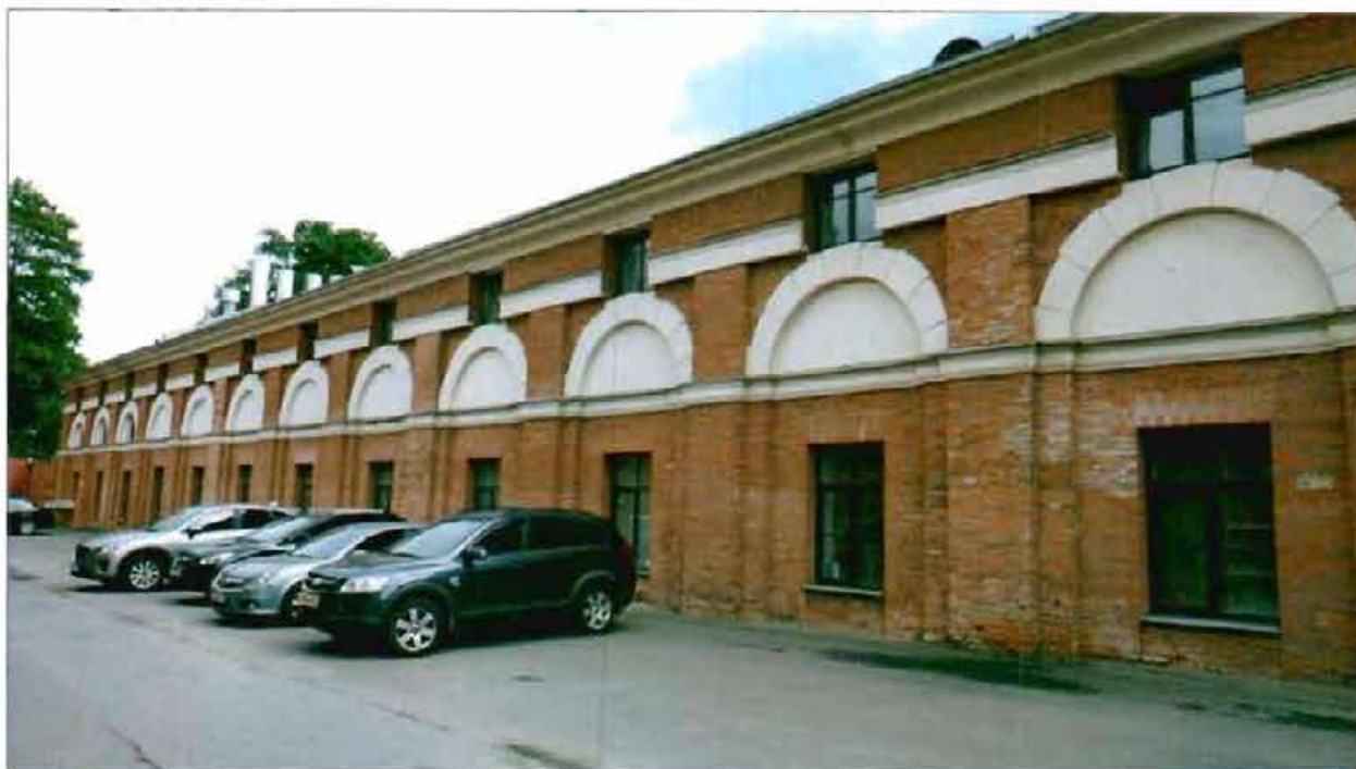
18. «Хлебный амбар» (наб. Обводного кан., 5, лит. Б). Западный фасад. Вид с юго-запада.
