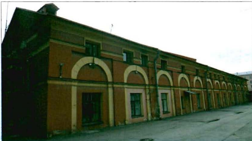
22. «Хлебный амбар» (наб. Обводного кан., 5а, лит. А). Общий вид с северо-запада.
