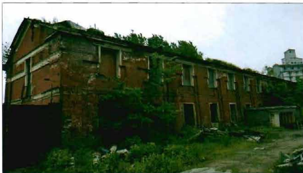
4. «Хлебный амбар» (наб. Обводного кан., 3, лит. А). Общий вид с северо-запада.
