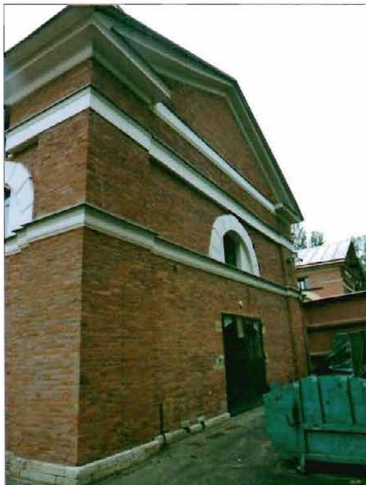
17. «Хлебный амбар» (наб. Обводного кан., 5, лит. Б). Северный фасад. Вид с северо-востока.
