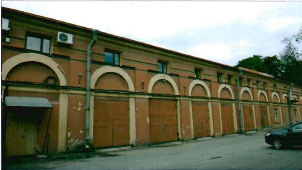
21. «Хлебный амбар» (наб. Обводного кан., 5а, лит. А). Восточный фасад. Вид с востока.
