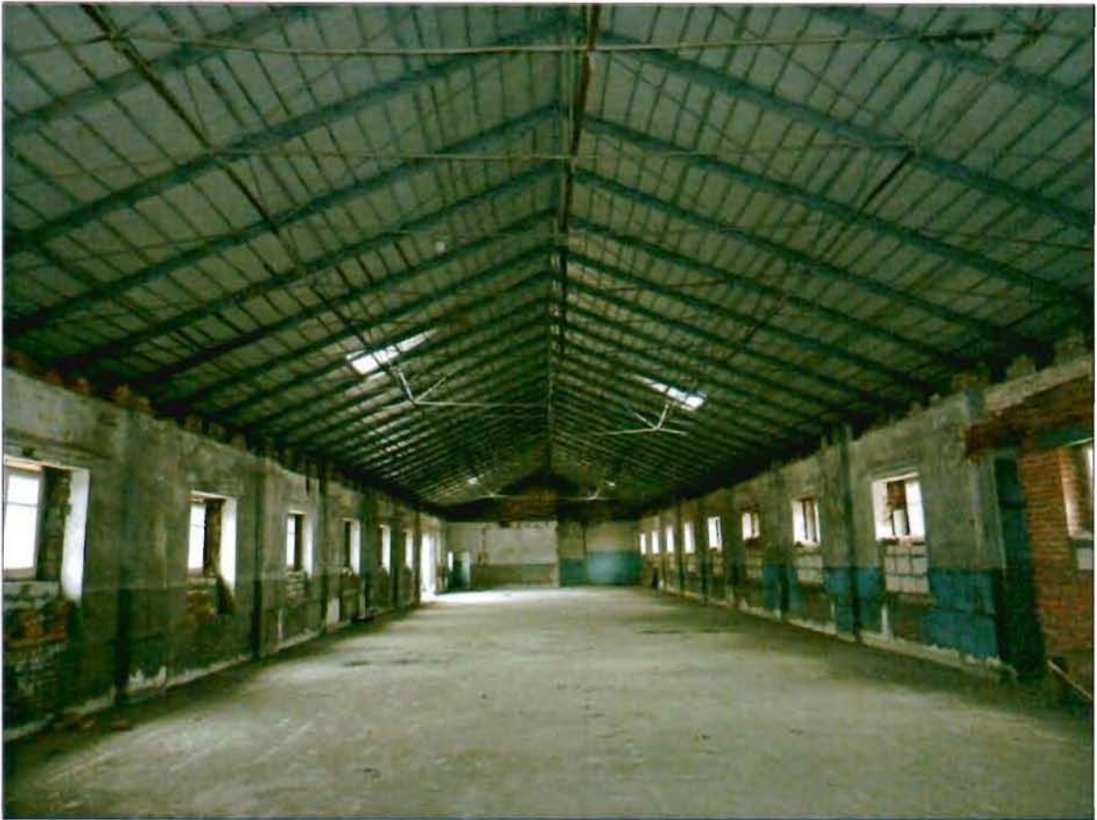
14. «Хлебный амбар» (наб. Обводного кан., 5, лит. Б). Металлические фермы перекрытия.
