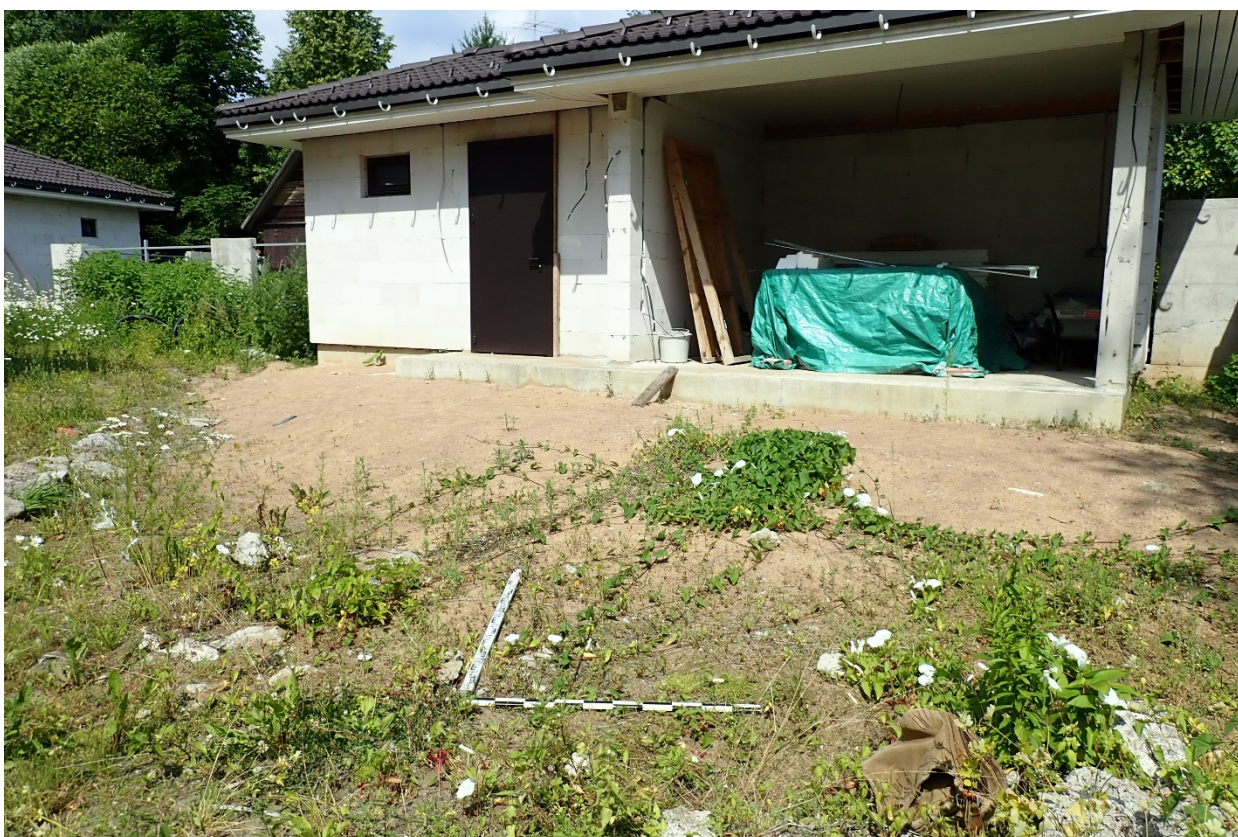
Рис.15. Объект №1. Земельный участок по адресу г. Санкт-Петербург, г. Сестрорецк, 6-я Тарховская ул., д. 42, кад. № 78:38:0011213:380. Шурф 1. До начала работ. Вид с Ю.
