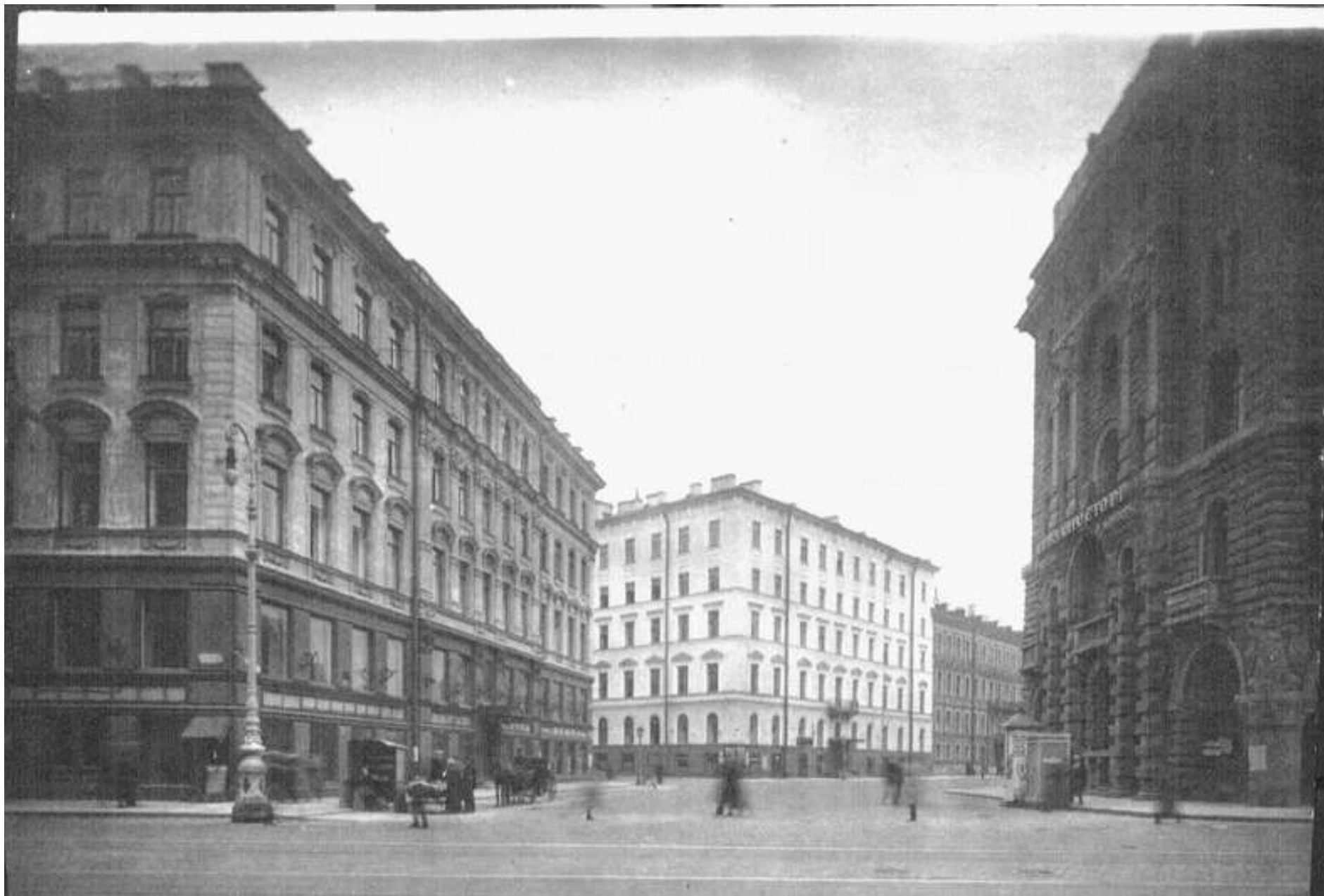
68. Дом на Невском пр. 11/2. Фасад со стороны ул. Гоголя (Невского проспекта). Фото 1926 г. // Источник: ЦГАКФФД СПб. Инв. № Гр. 65427.
