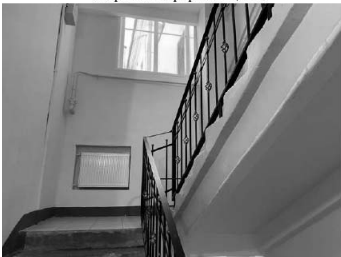
64. Фрагмент интерьера лестницы 5ЛК
