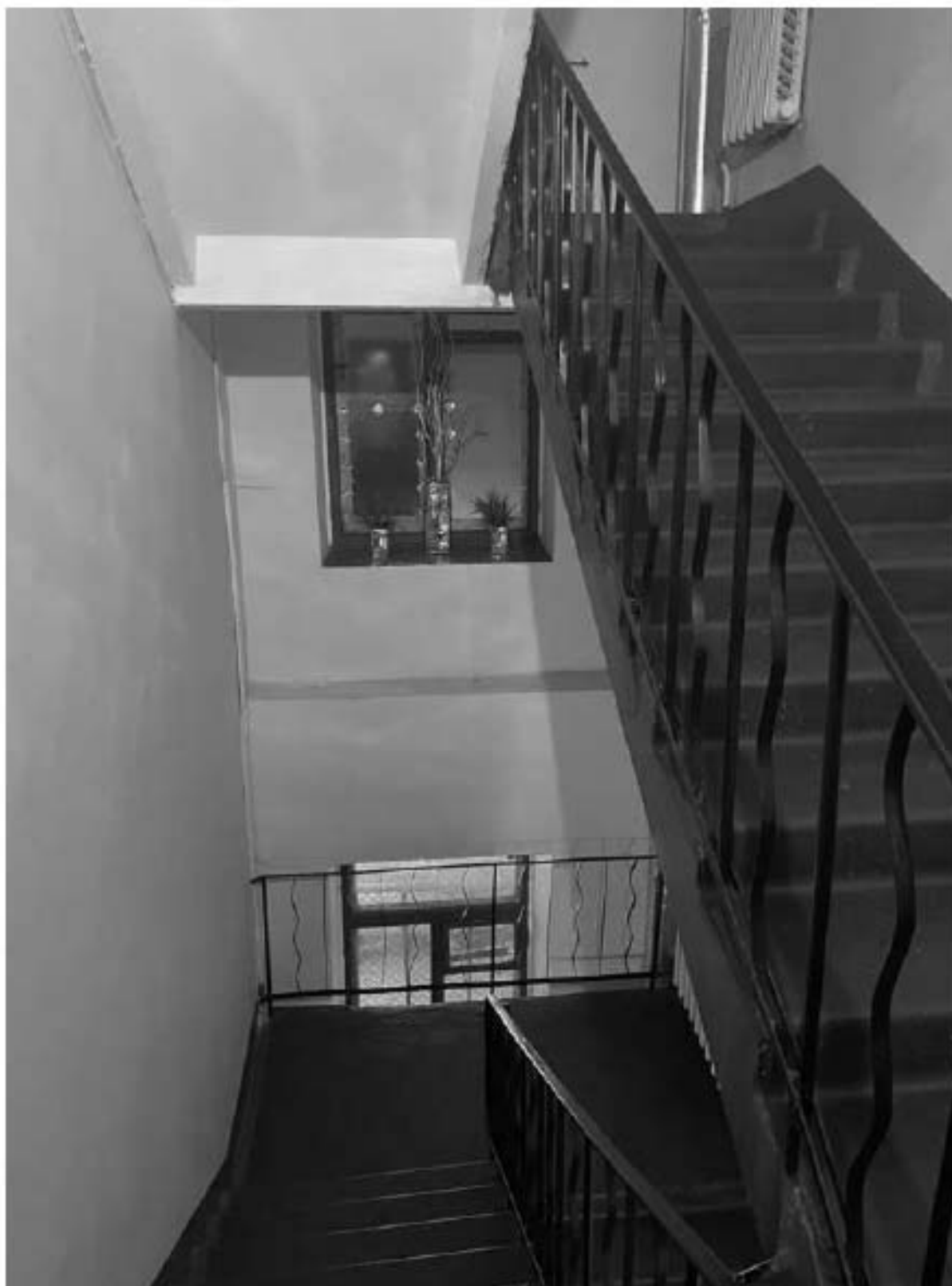
41. Фрагмент интерьера лестницы 8ЛК
