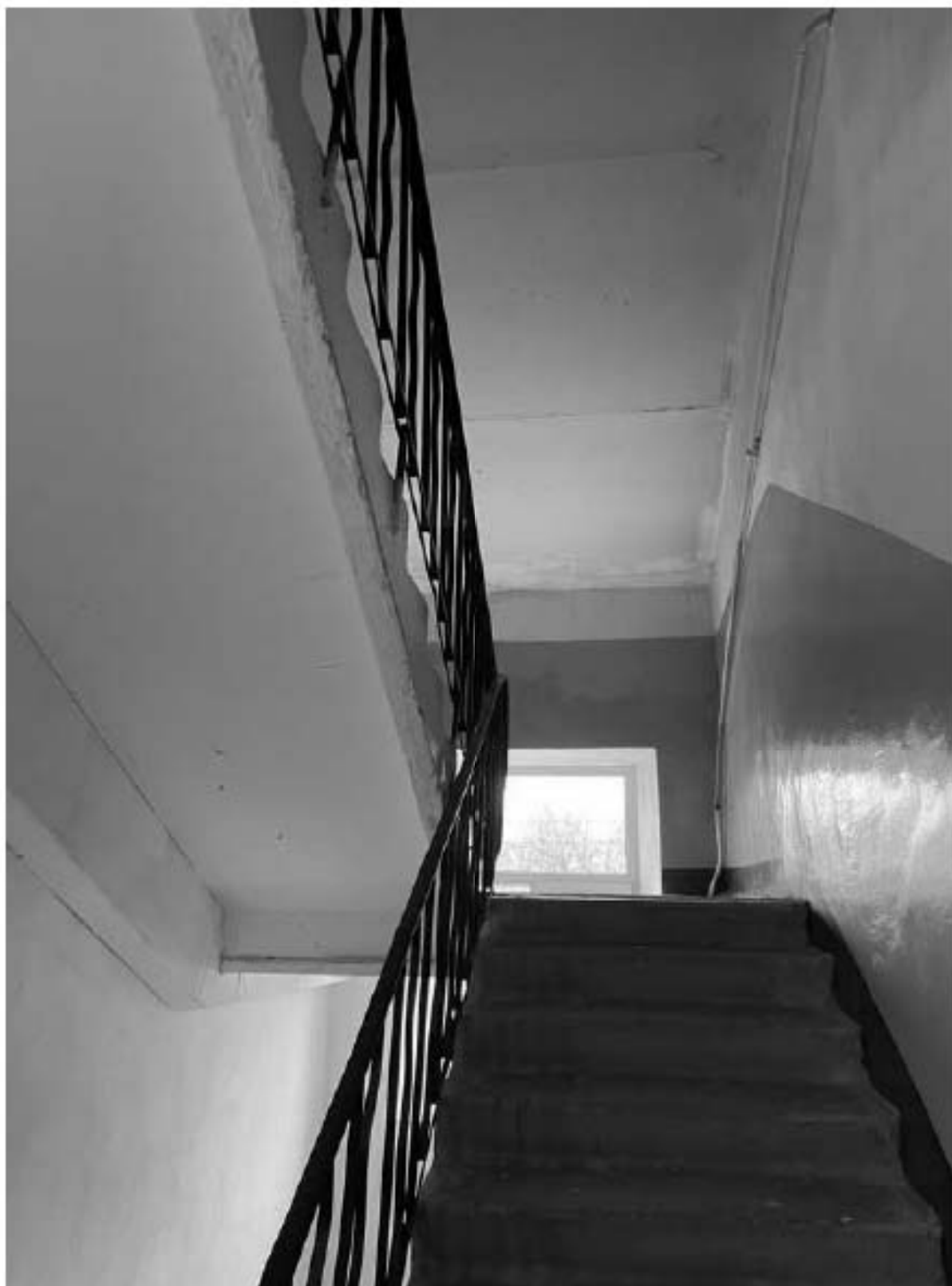
74. Фрагмент интерьера лестницы ЗЛК
