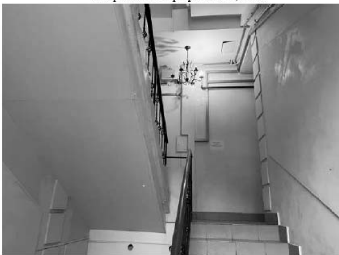
78. Фрагмент интерьера лестницы 4ЛК
