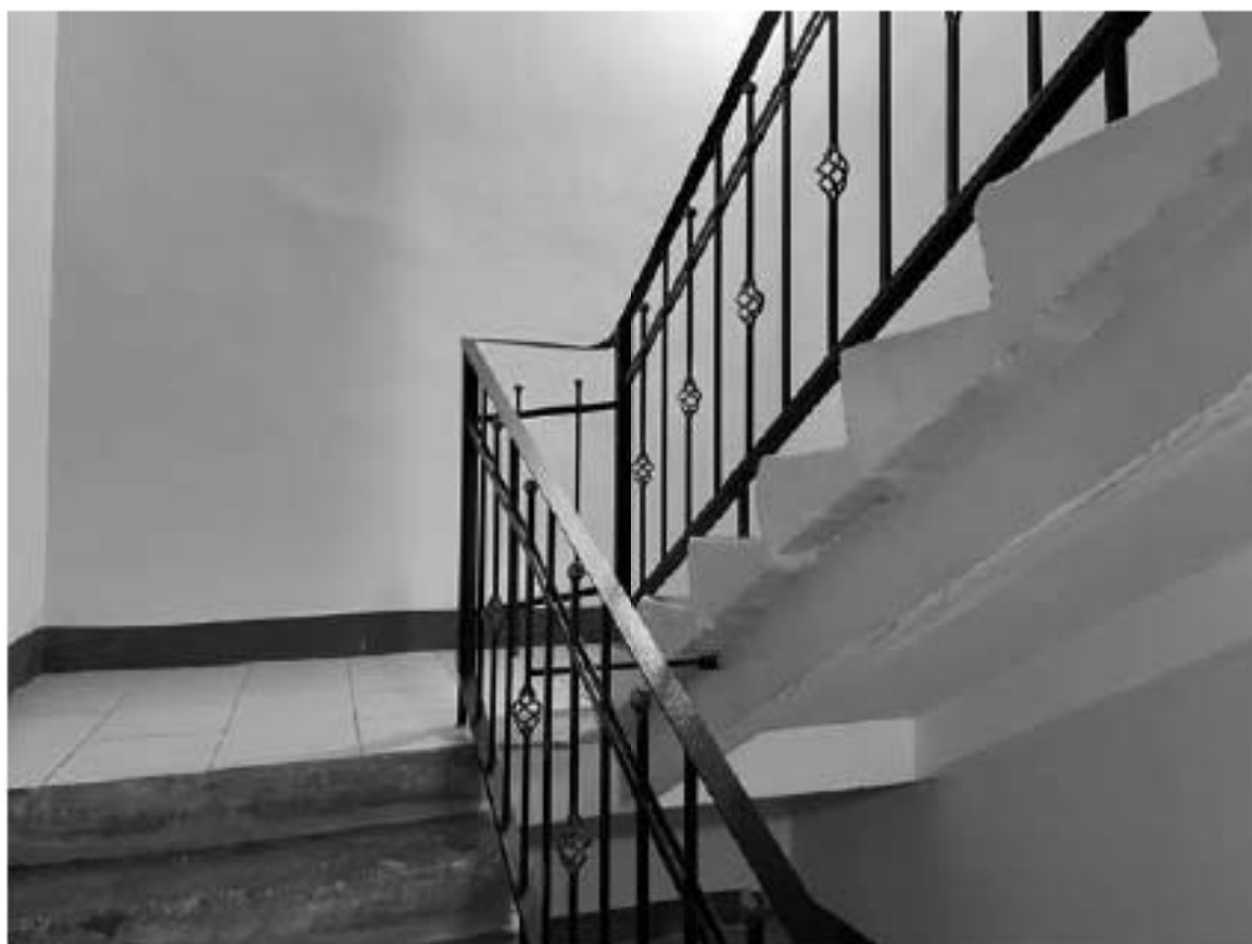
63. Фрагмент интерьера лестницы 5ЛК
