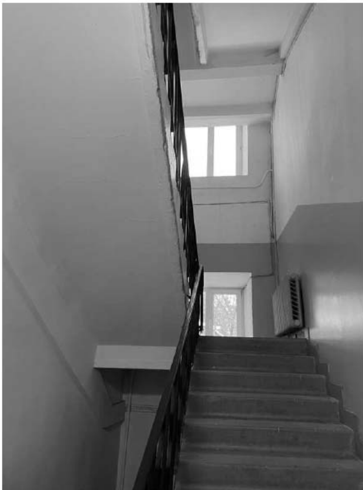
70. Фрагмент интерьера лестницы ЗЛК
