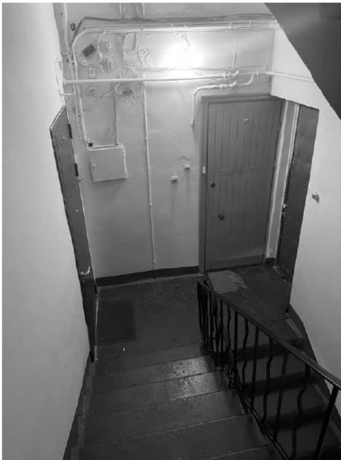
40. Фрагмент интерьера лестницы 8ЛК
