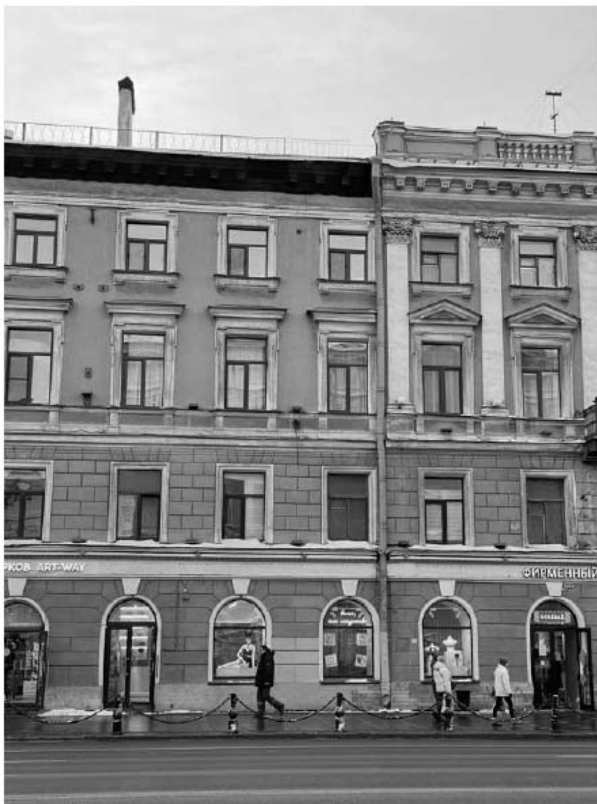
7. Фрагмент фасада по Невскому проспекту
