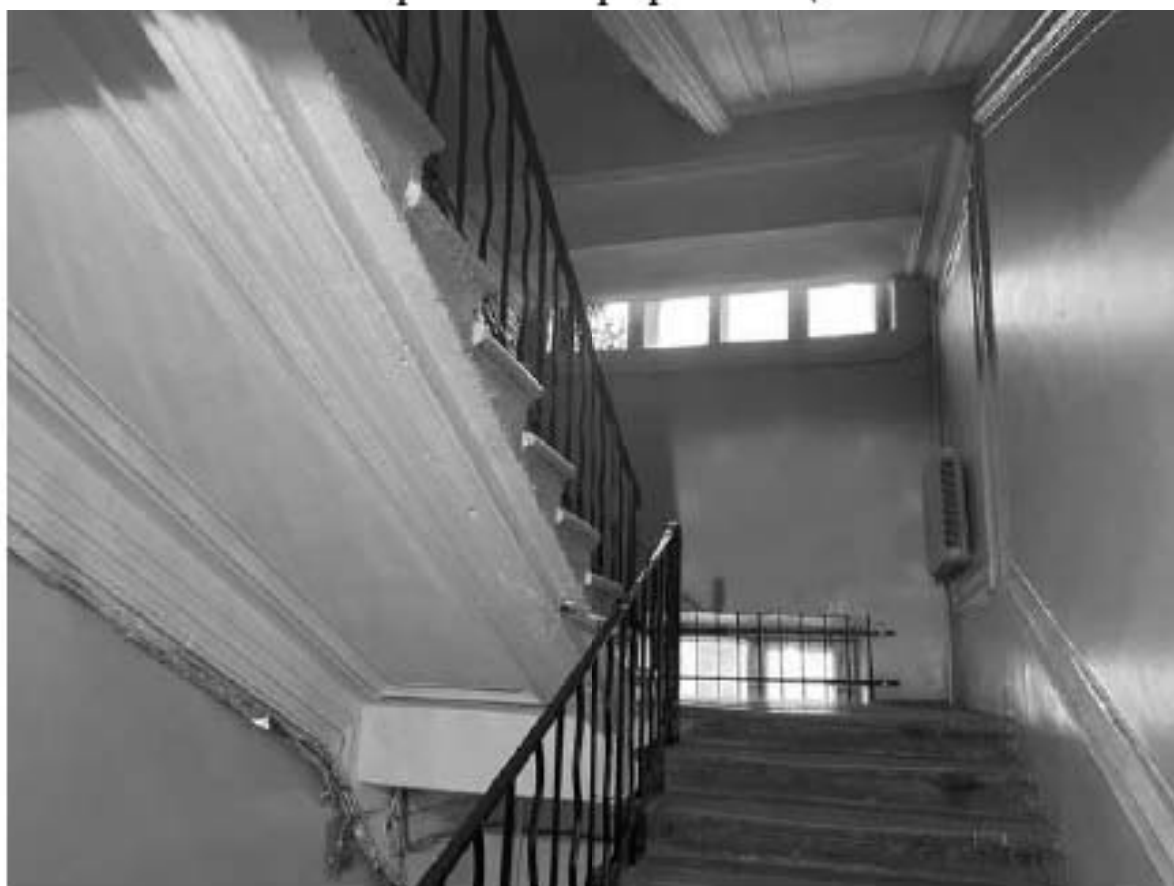
52. Фрагмент интерьера лестницы 2ЛК
