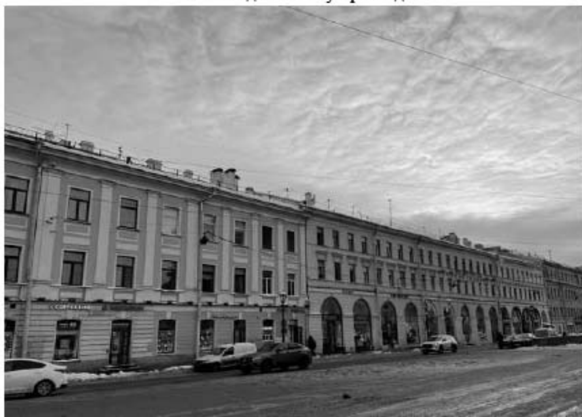
15. Фасад по каналу Грибоедова
