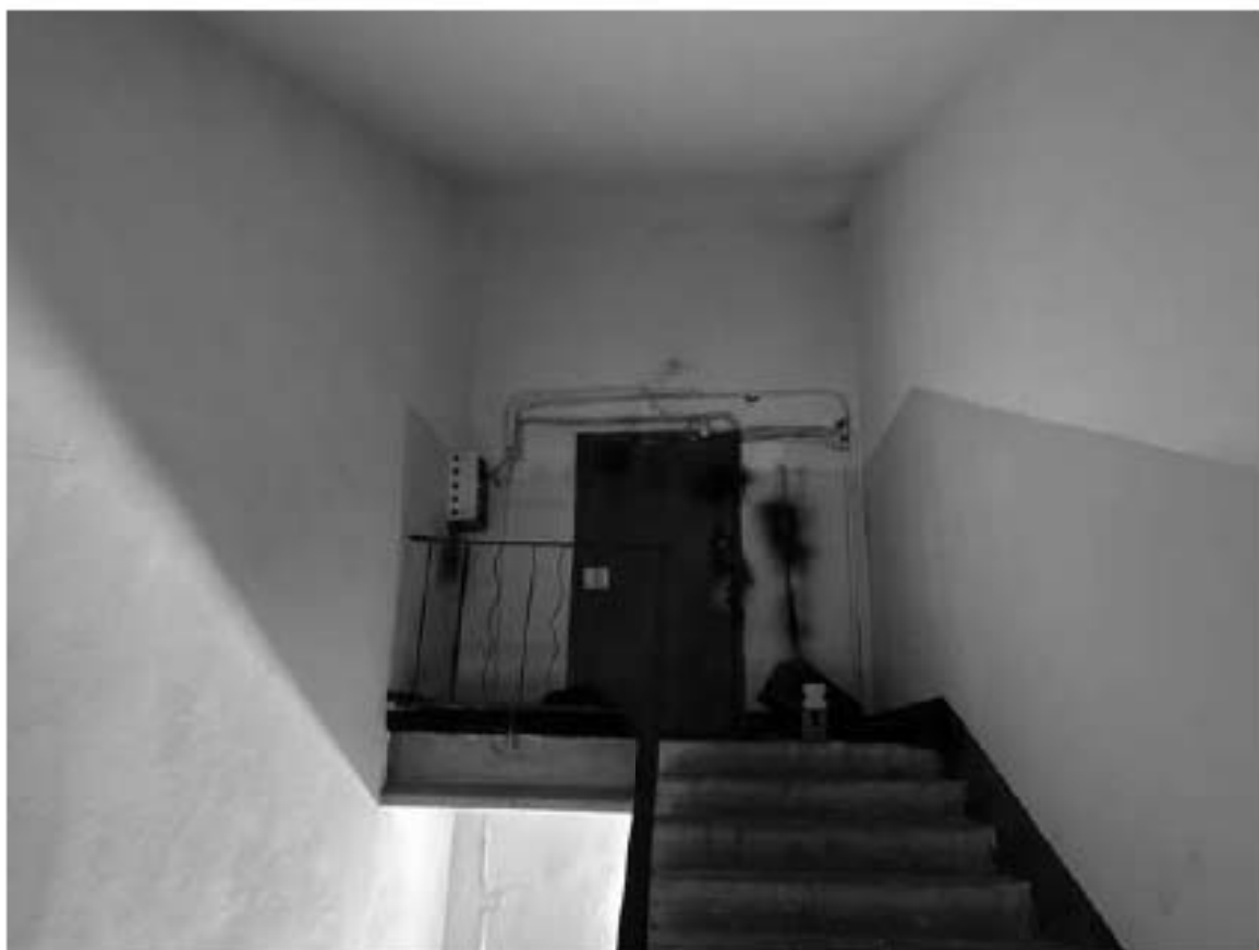
89. Фрагмент интерьера лестницы 6ЛК
