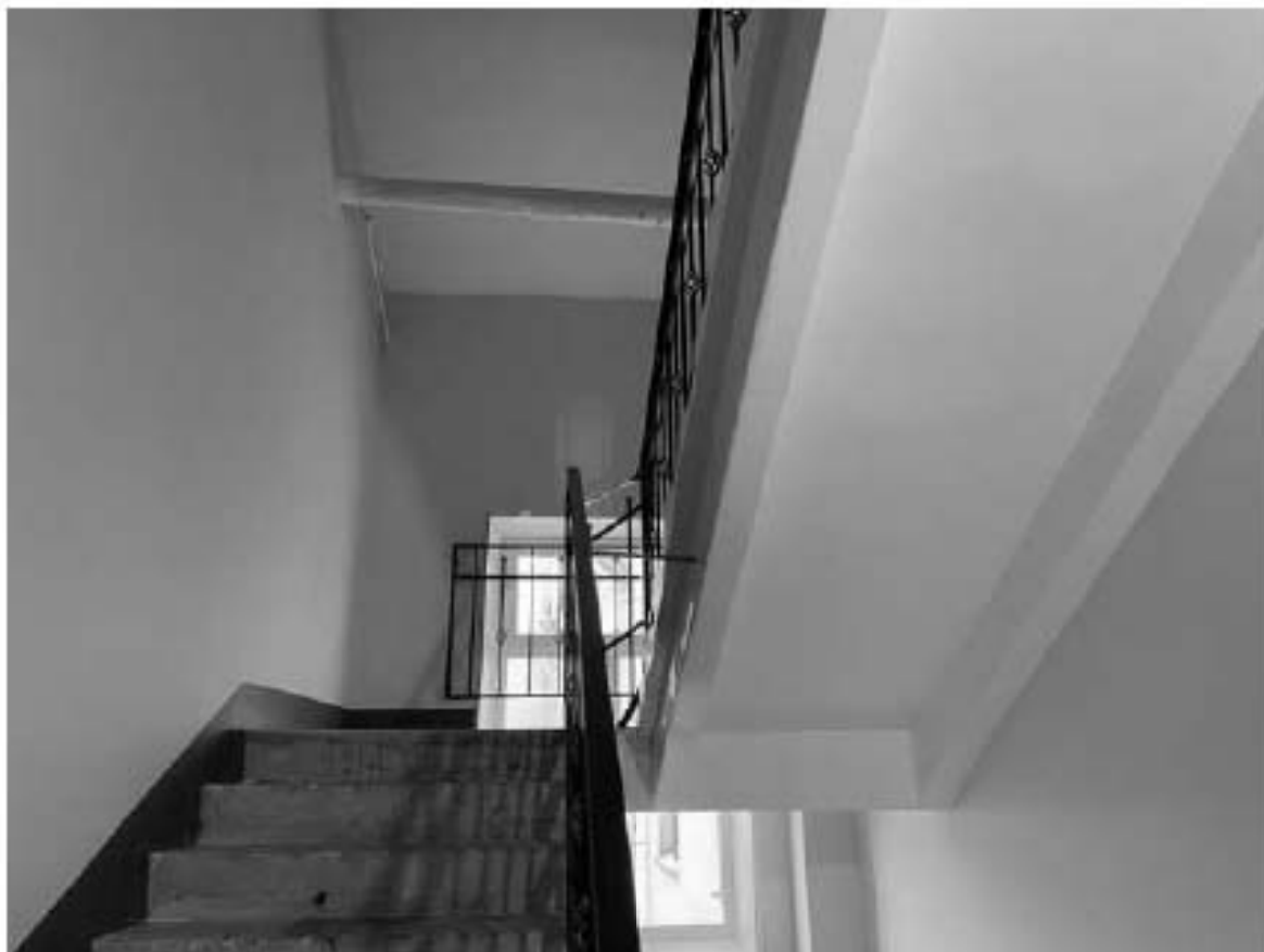
67. Фрагмент интерьера лестницы 5ЛК
