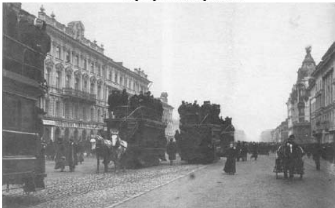
185. Конки на Невском проспекте. 1906 г. Фотоальбом "От конки до трамвая. Из истории петербургского транспорта", 1993 г.
