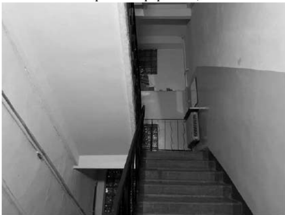
92. Фрагмент интерьера лестницы 7ЛК
