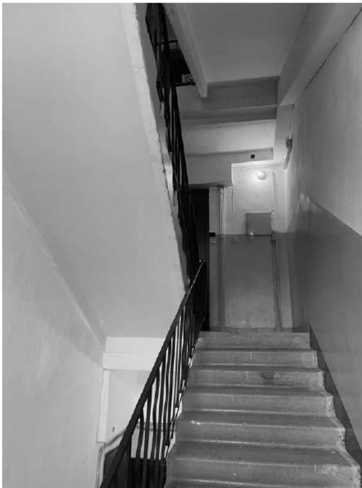
73. Фрагмент интерьера лестницы ЗЛК
