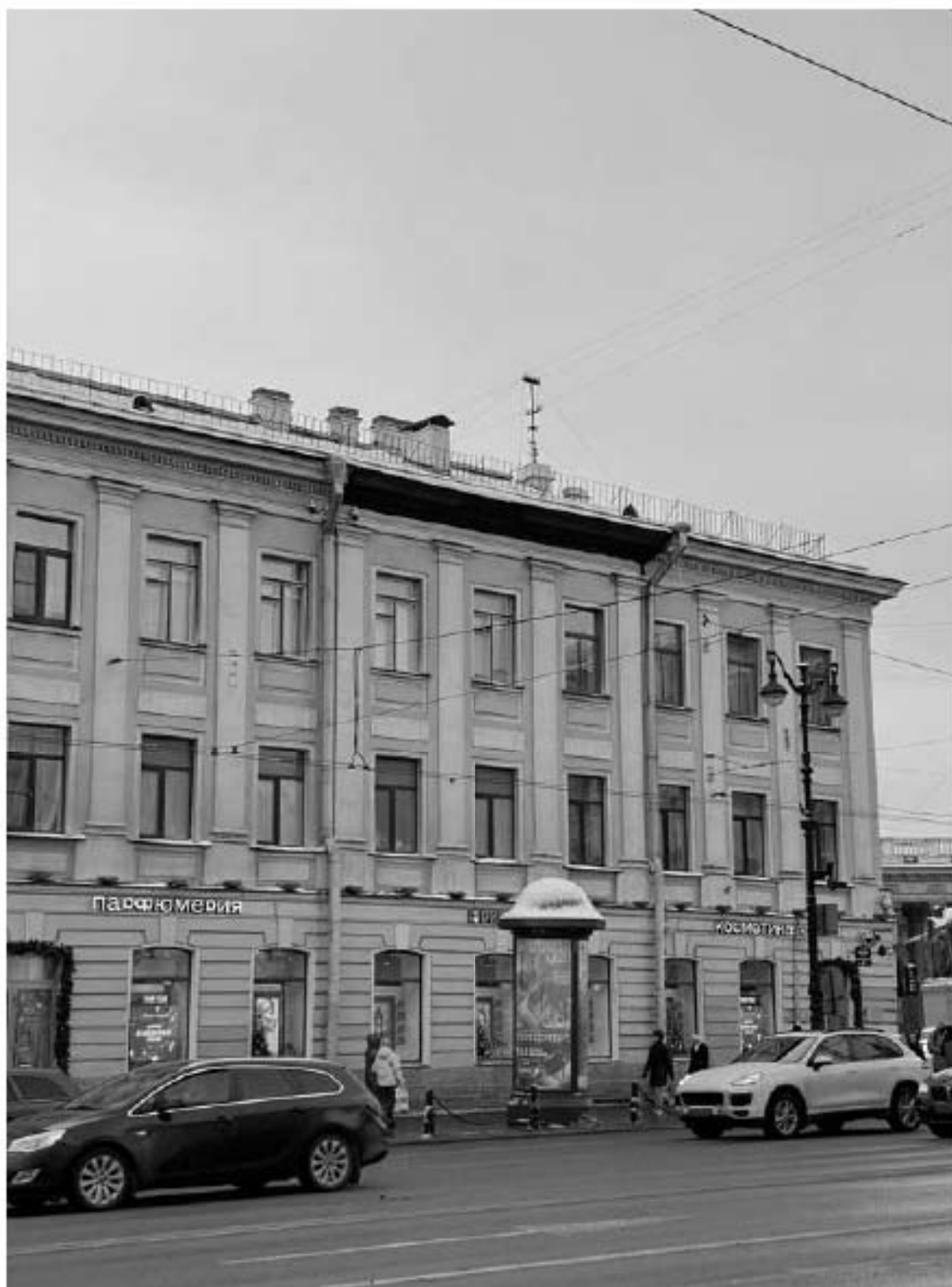
13. Фрагмент фасада по Невскому проспекту
