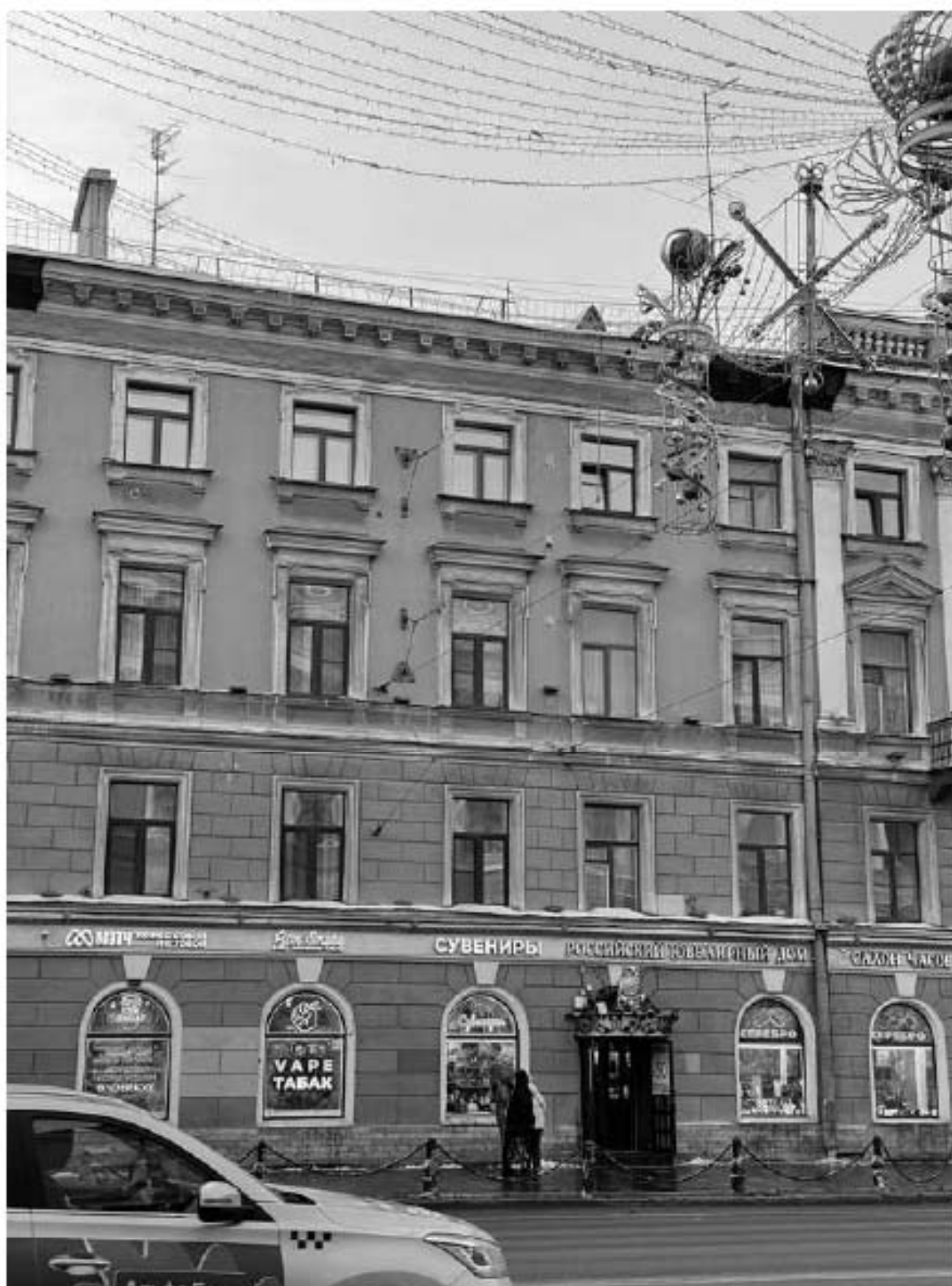
10. Фрагмент фасада по Невскому проспекту
