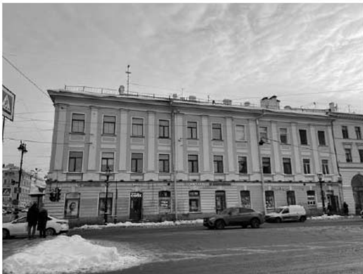
14. Фасад по каналу Грибоедова
