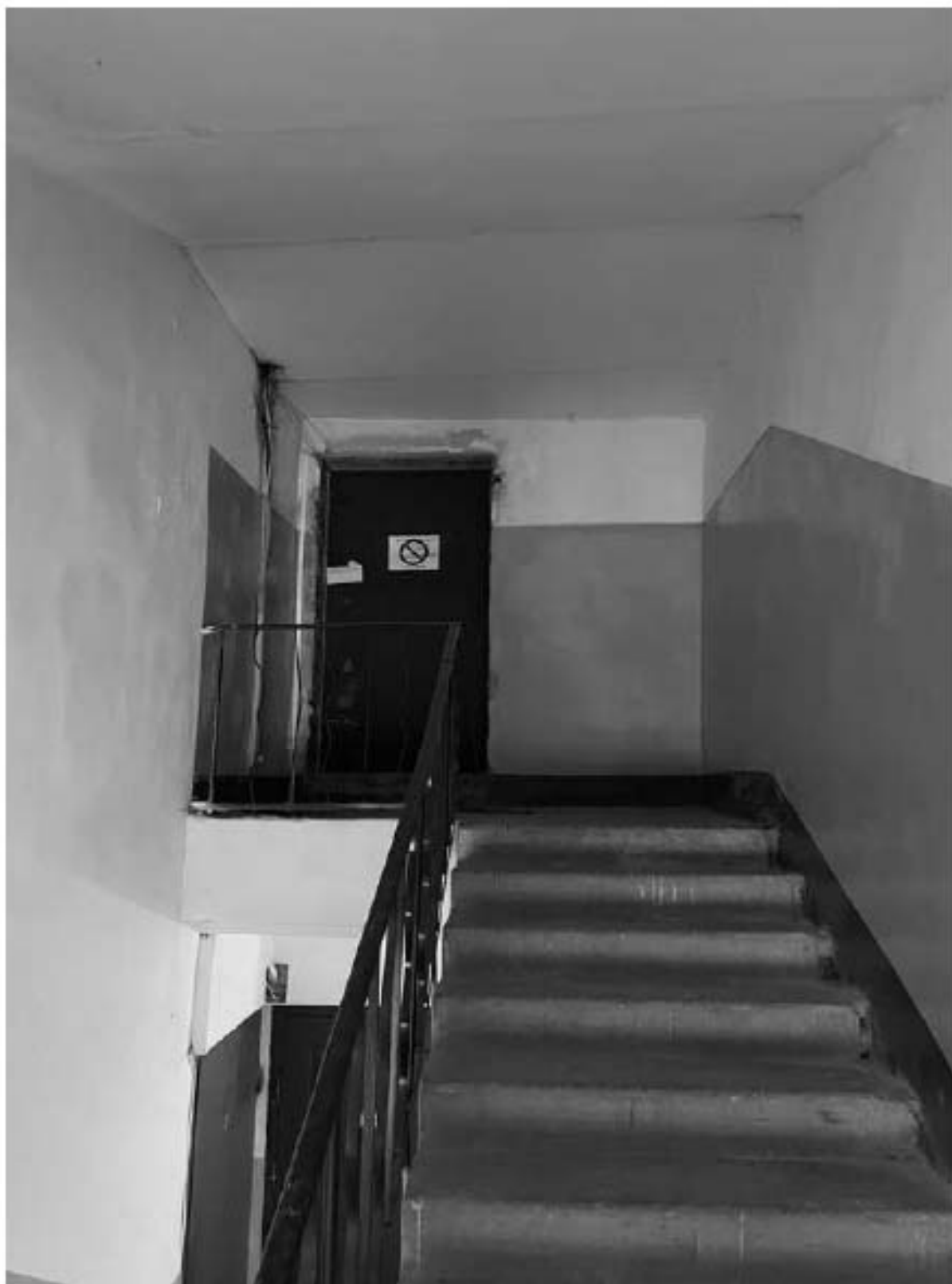
75. Фрагмент интерьера лестницы ЗЛК
