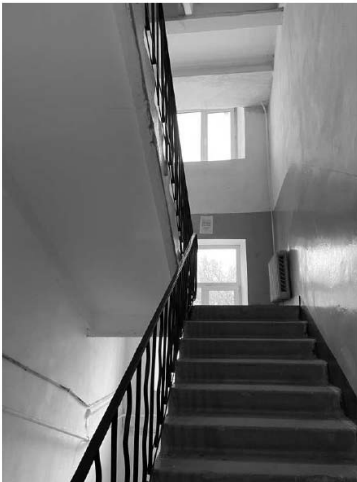
72. Фрагмент интерьера лестницы ЗЛК
