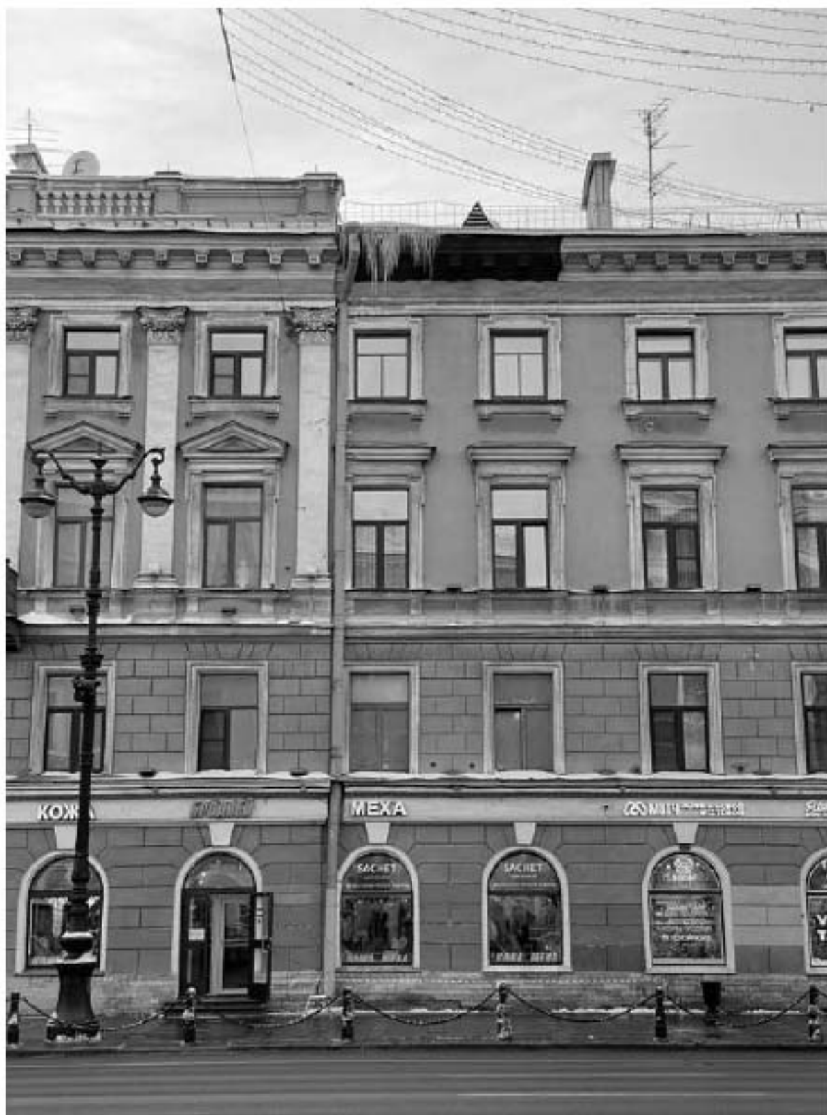
9. Фрагмент фасада по Невскому проспекту
