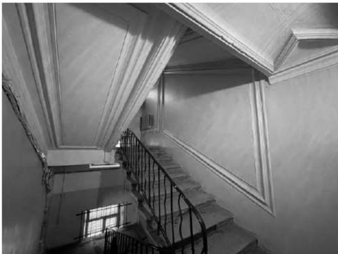
51. Фрагмент интерьера лестницы 2ЛК
