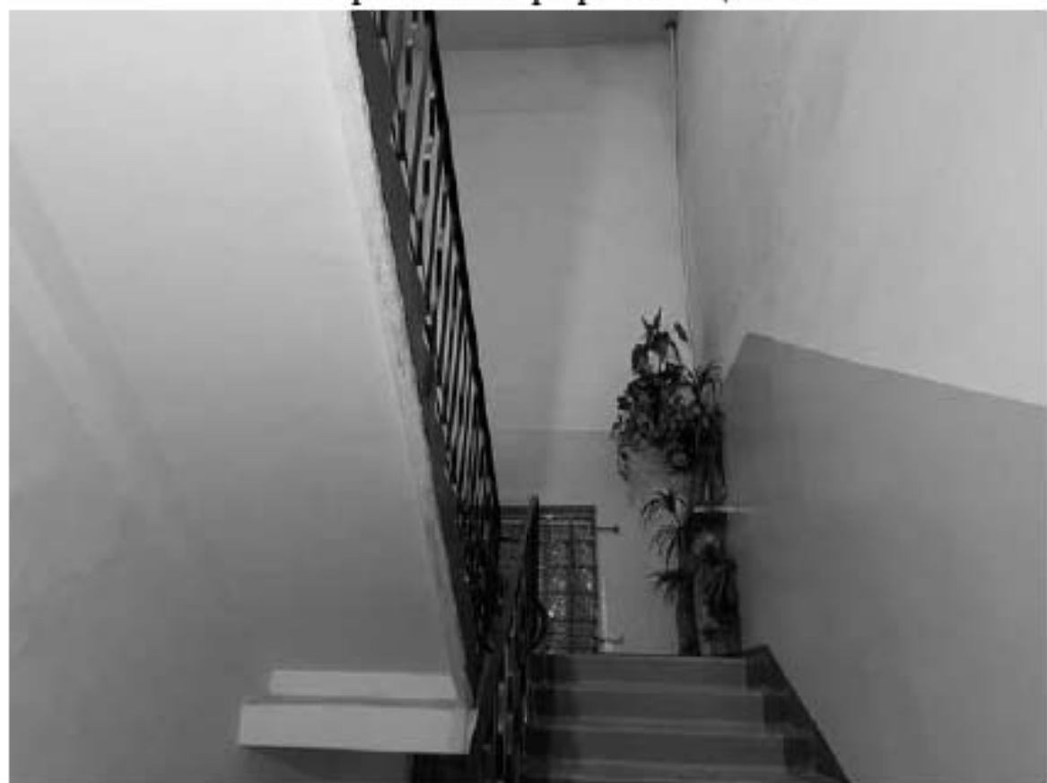
94. Фрагмент интерьера лестницы 7ЛК
