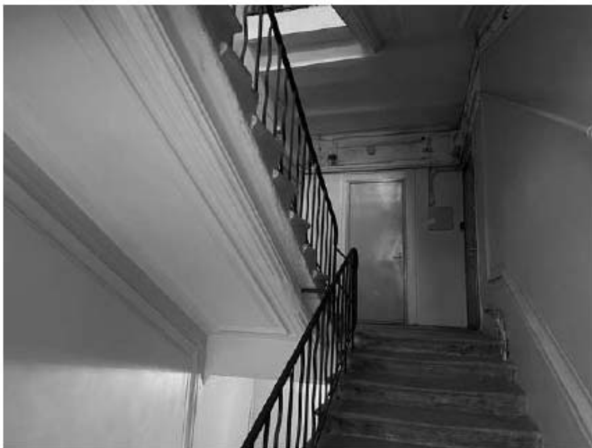
53. Фрагмент интерьера лестницы 2ЛК
