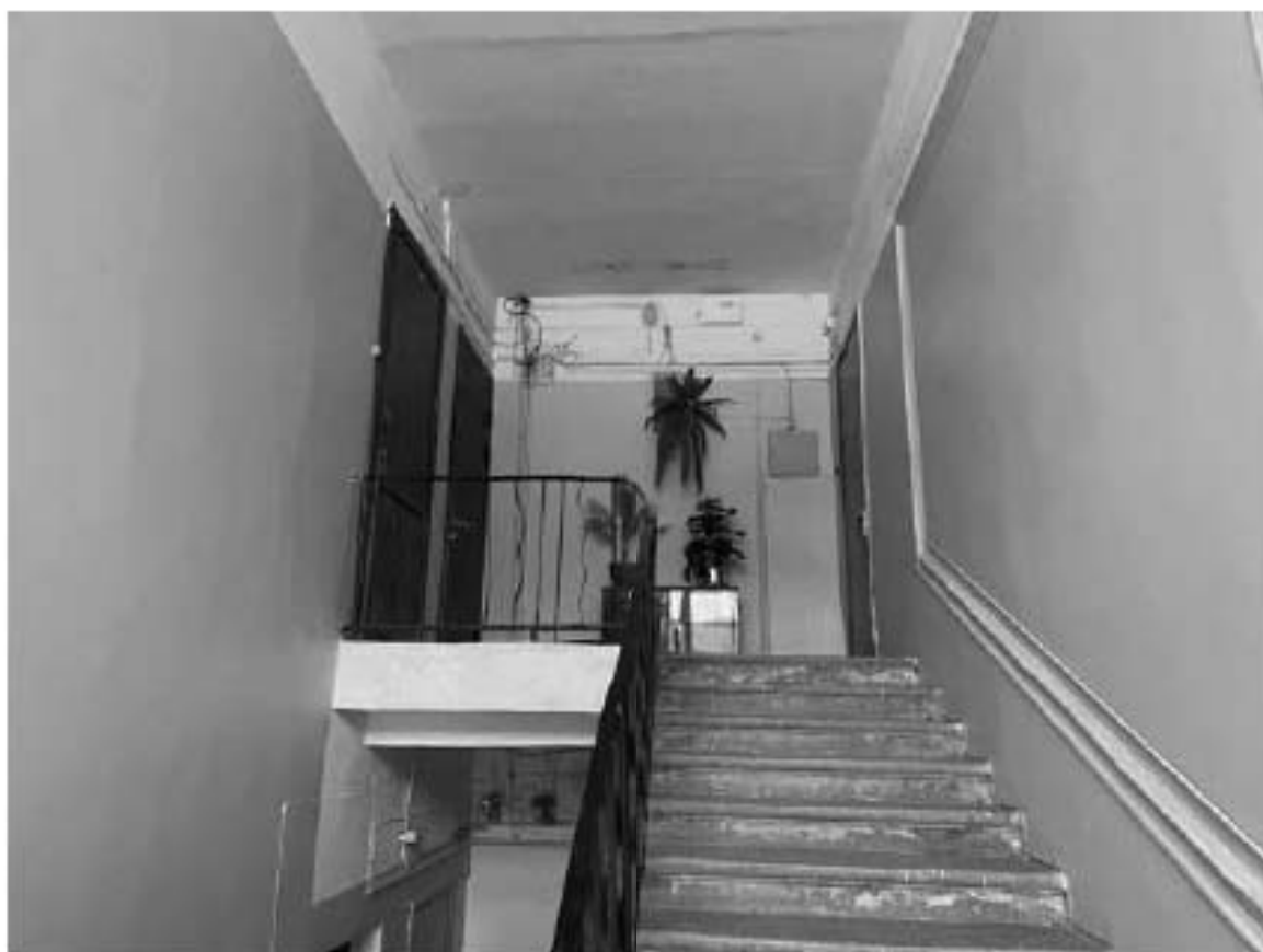
55. Фрагмент интерьера лестницы 2ЛК
