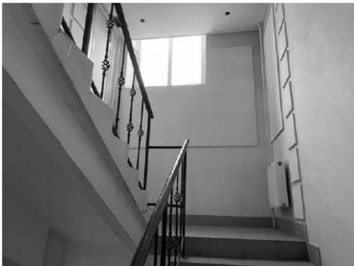
77. Фрагмент интерьера лестницы 4ЛК
