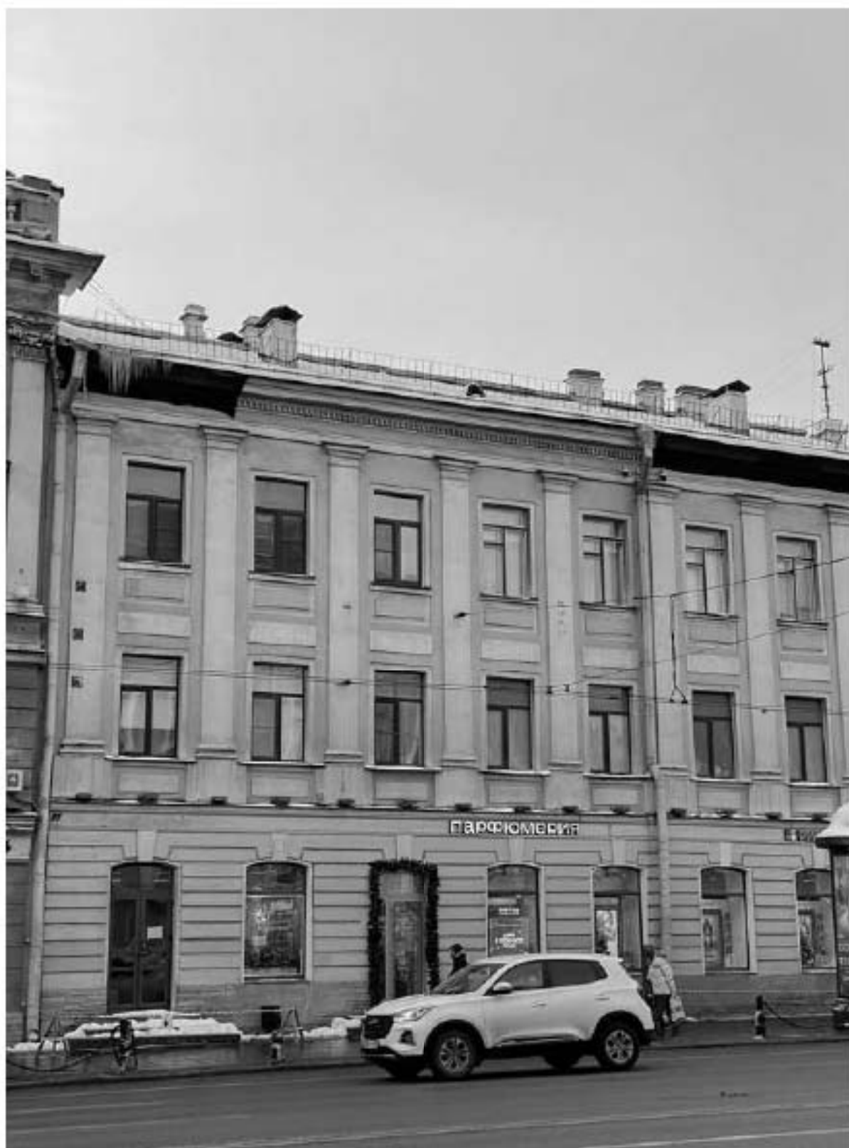
12. Фрагмент фасада по Невскому проспекту
