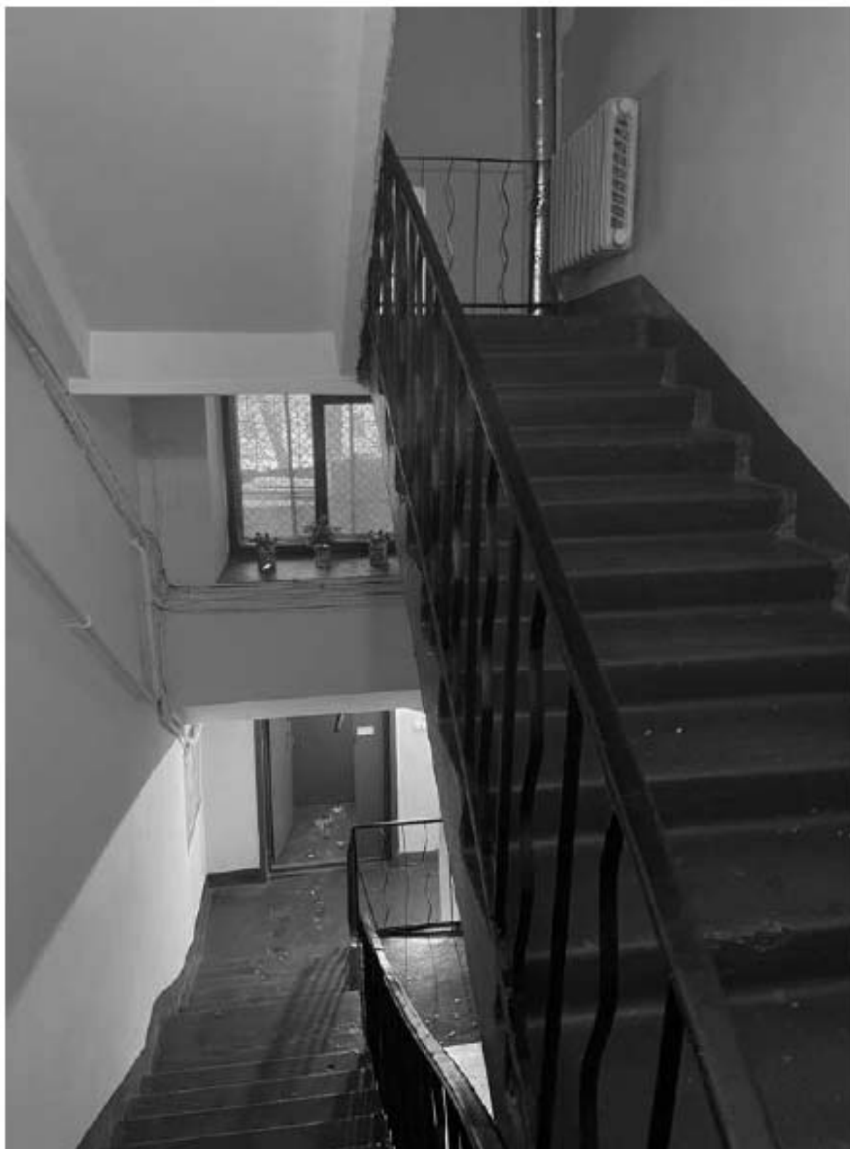
39. Фрагмент интерьера лестницы 8ЛК
