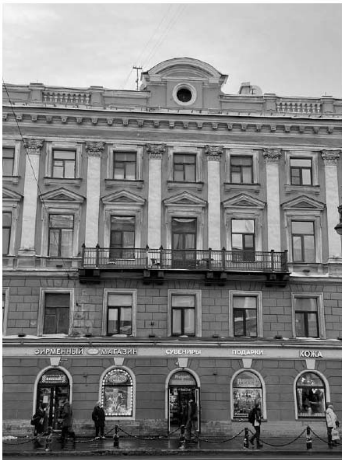
8. Фрагмент фасада по Невскому проспекту
