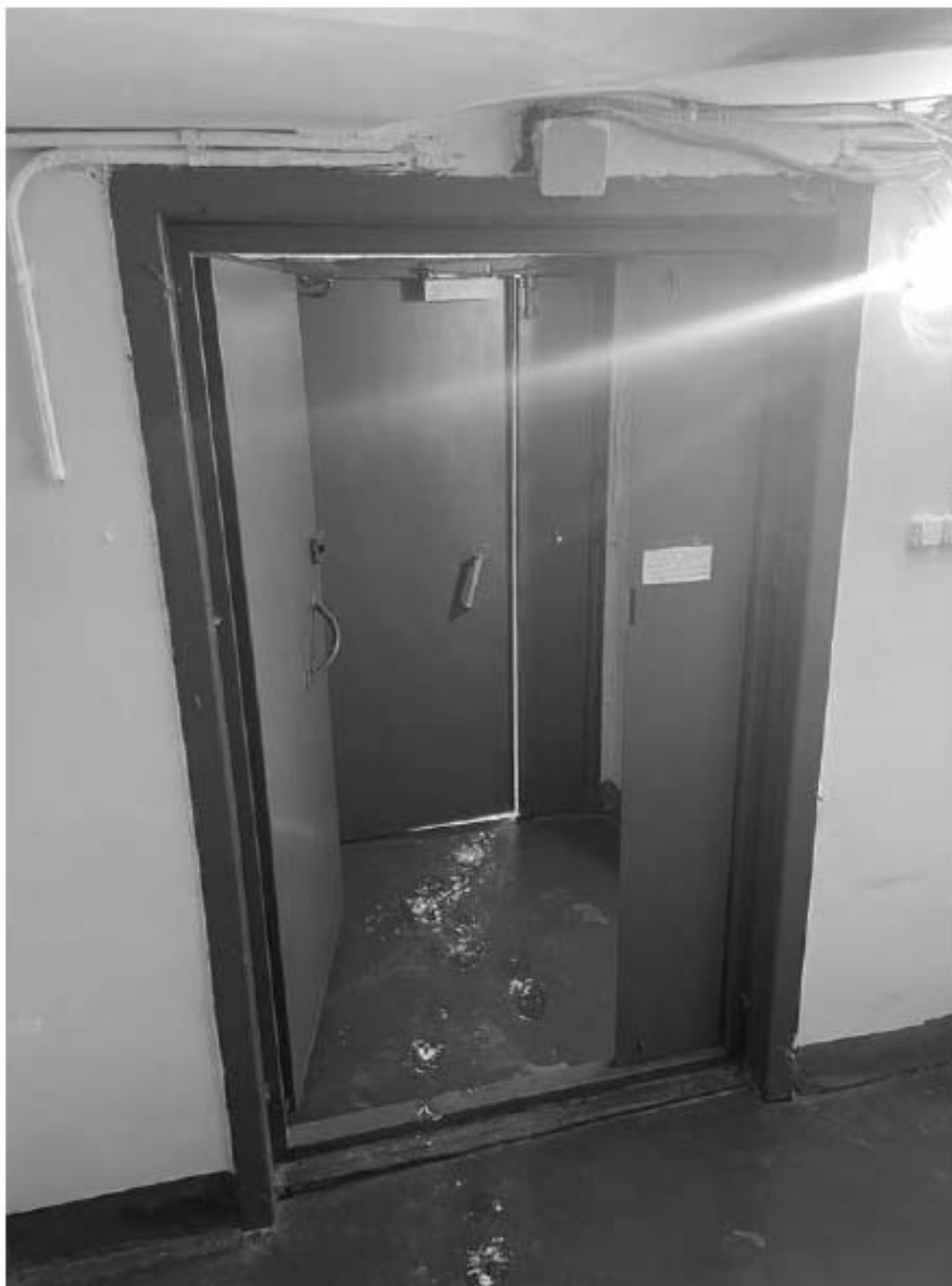
38. Фрагмент интерьера лестницы 8ЛК
