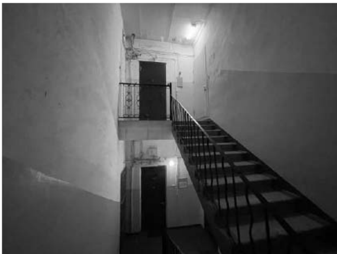
95. Фрагмент интерьера лестницы 7ЛК
