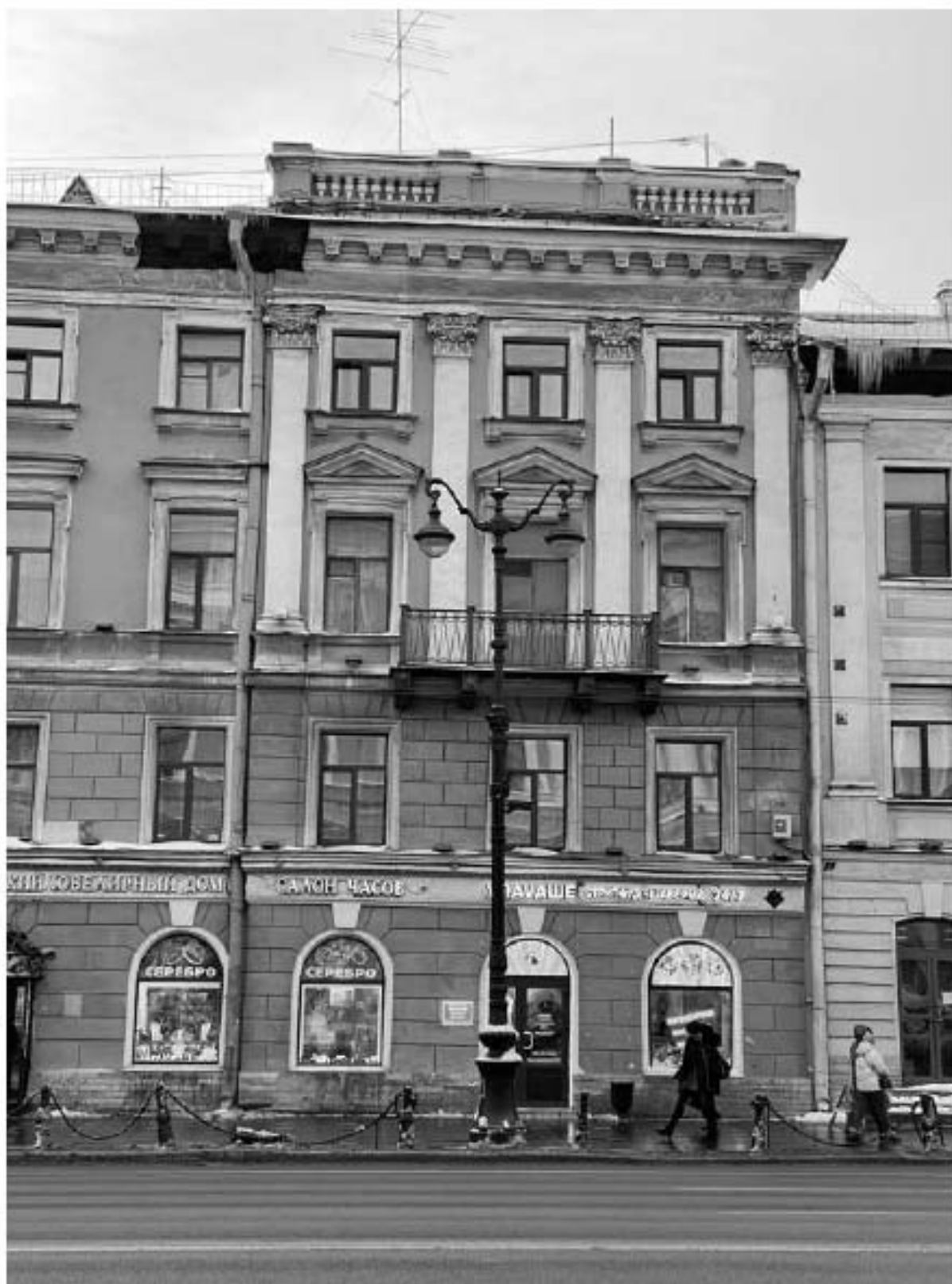
11. Фрагмент фасада по Невскому проспекту
