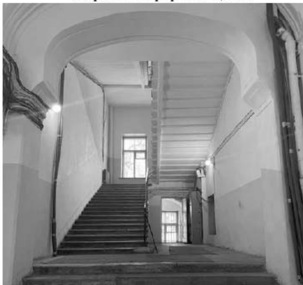
58. Фрагмент интерьера лестницы 1ЛК
