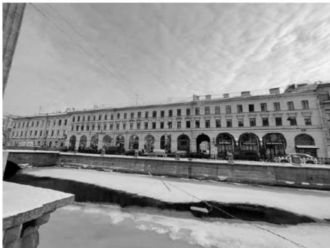
16. Фасад по каналу Грибоедова
