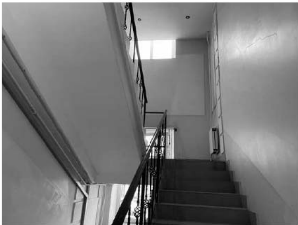
79. Фрагмент интерьера лестницы 4ЛК
