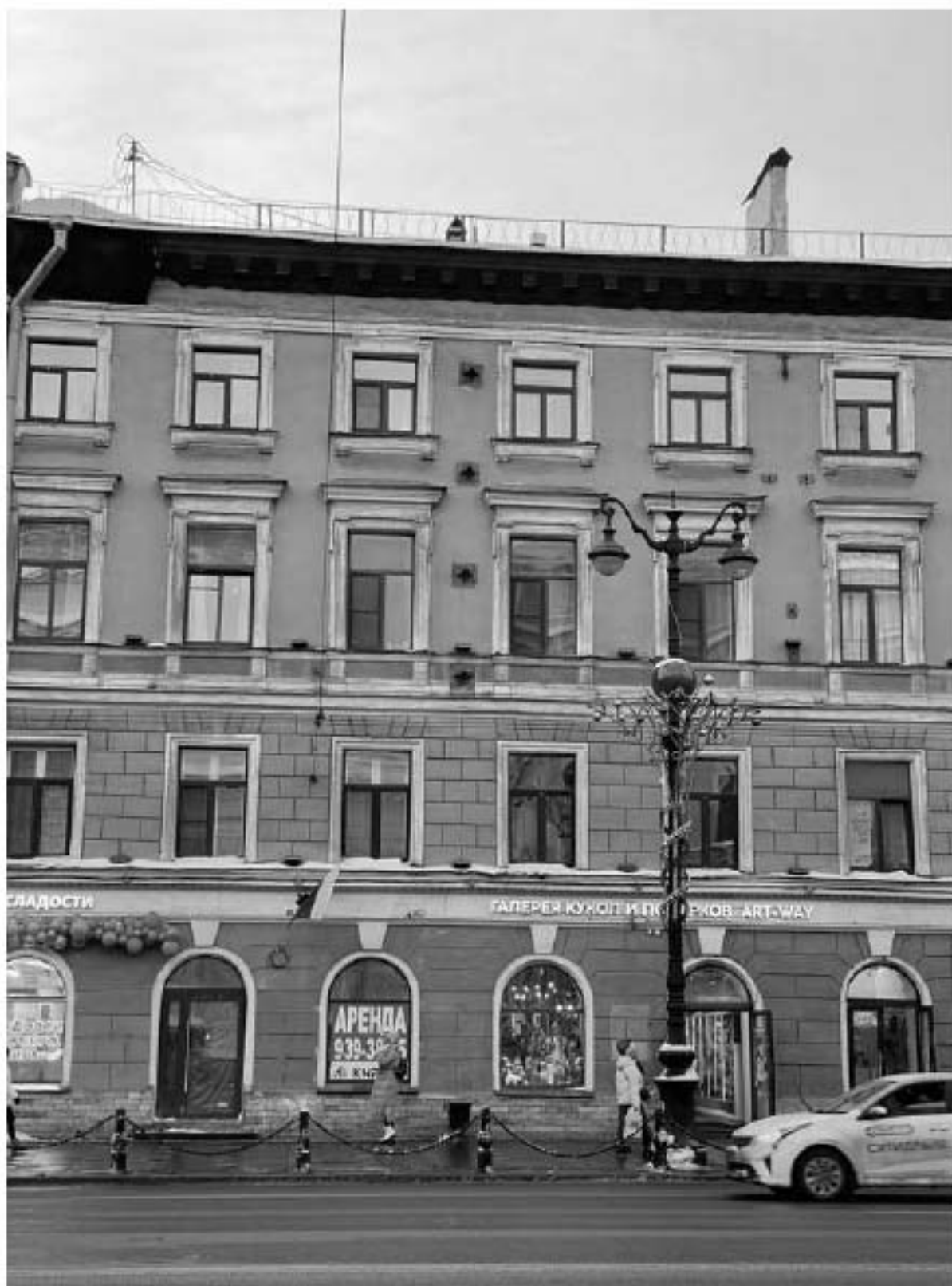
6. Фрагмент фасада по Невскому проспекту
