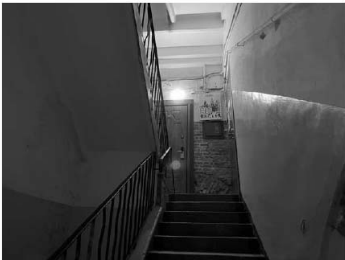
91. Фрагмент интерьера лестницы 7ЛК
