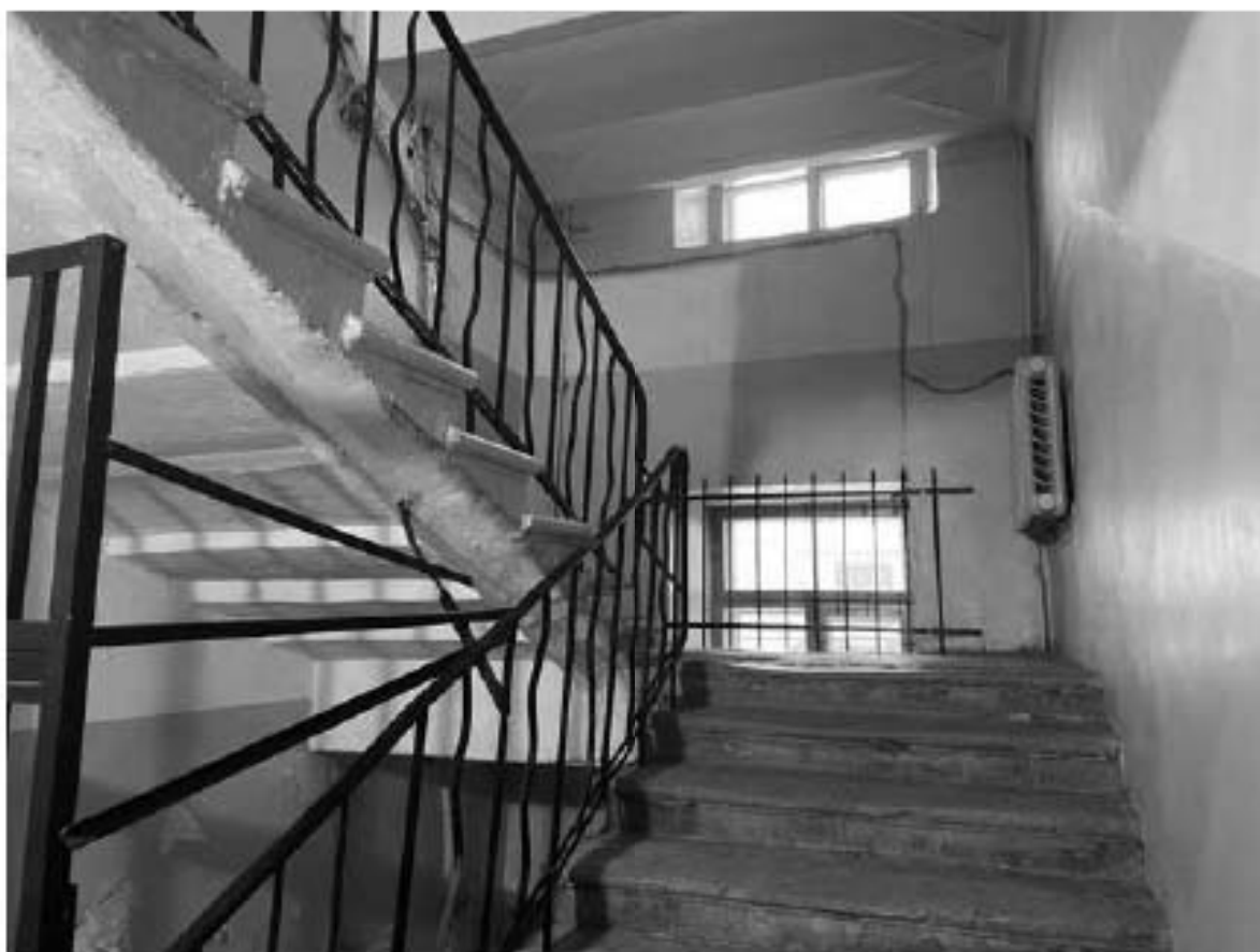
49. Фрагмент интерьера лестницы 2ЛК
