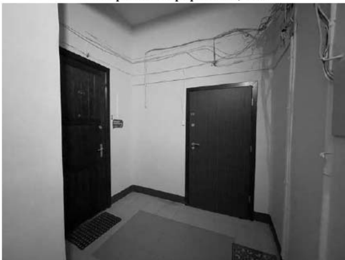
66. Фрагмент интерьера лестницы 5ЛК
