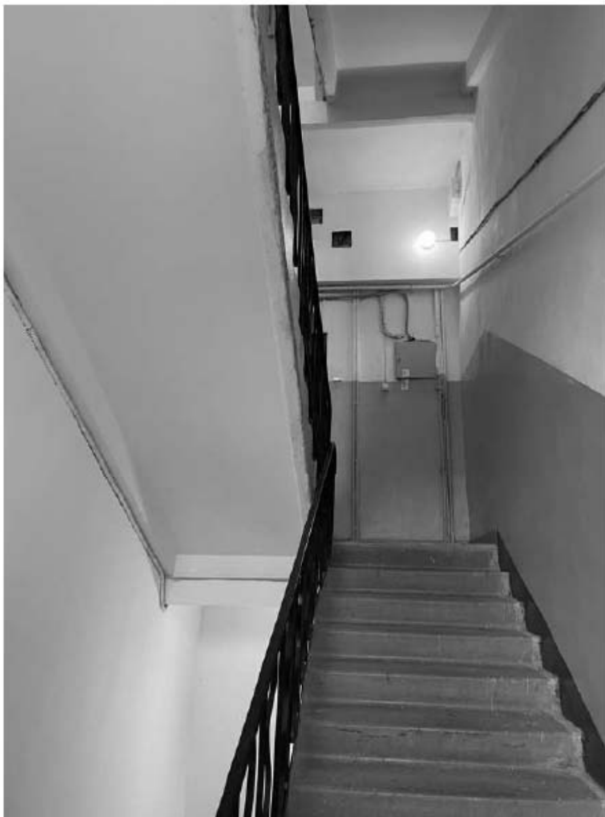
71. Фрагмент интерьера лестницы ЗЛК
