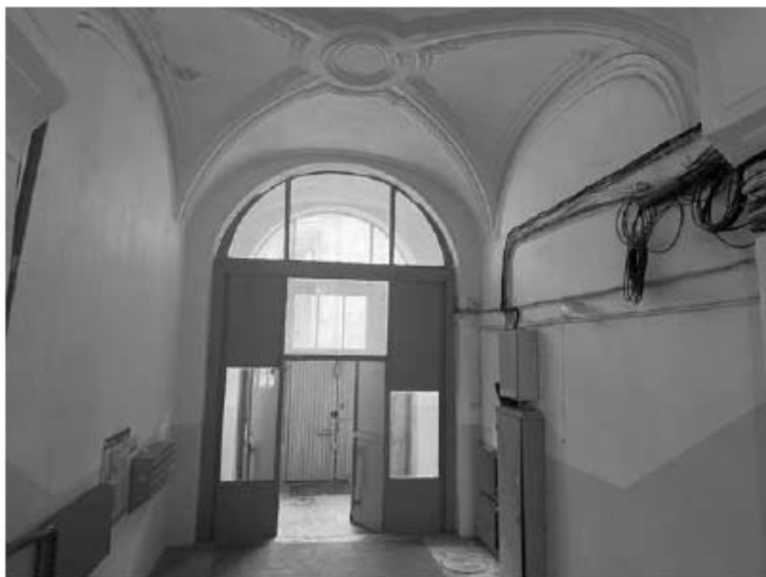
57. Фрагмент интерьера лестницы 1ЛК
