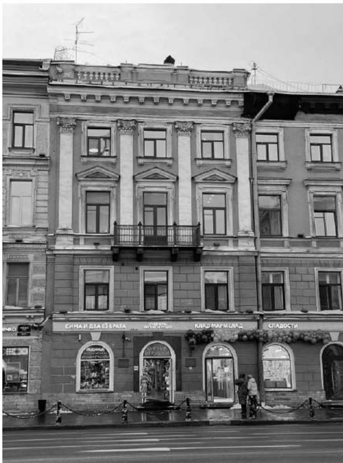
5. Фрагмент фасада по Невскому проспекту
