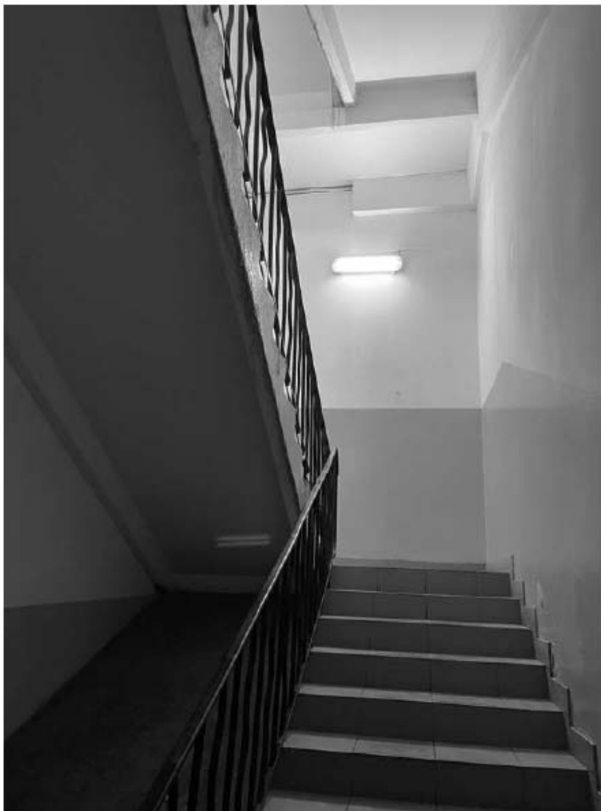
69. Фрагмент интерьера лестницы ЗЛК
