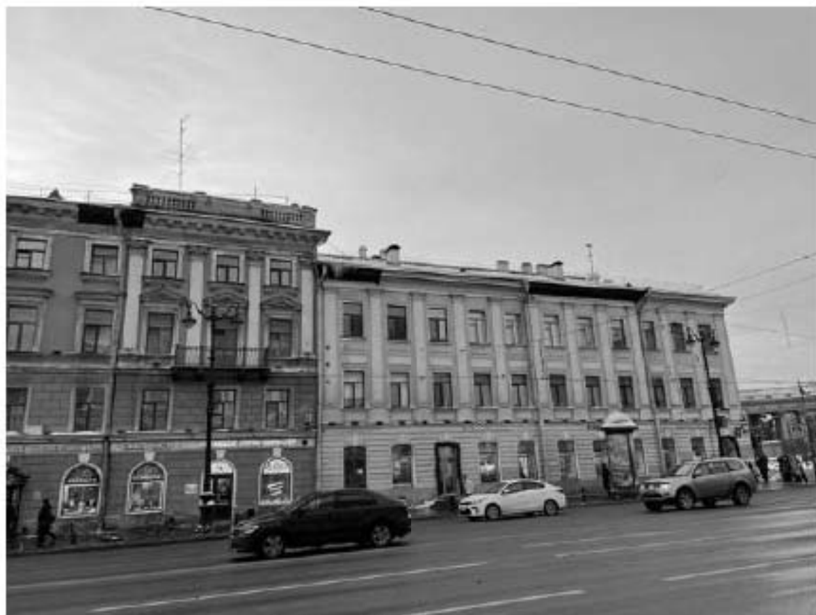
1. Вид с Невского проспекта
