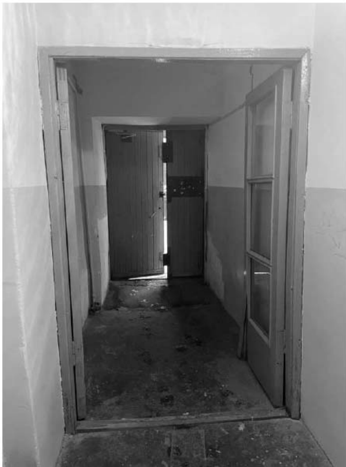
48. Фрагмент интерьера лестницы 2ЛК
