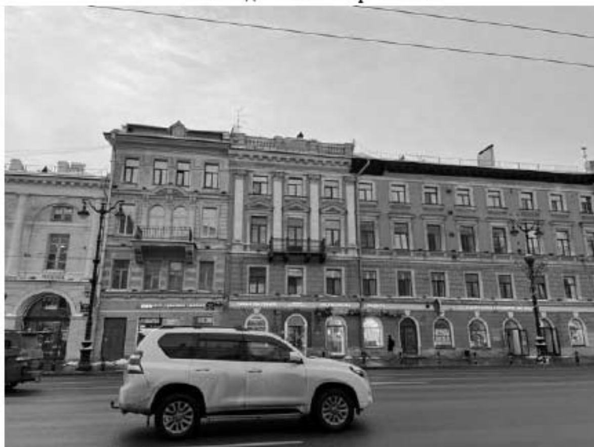
4. Фрагмент фасада по Невскому проспекту
