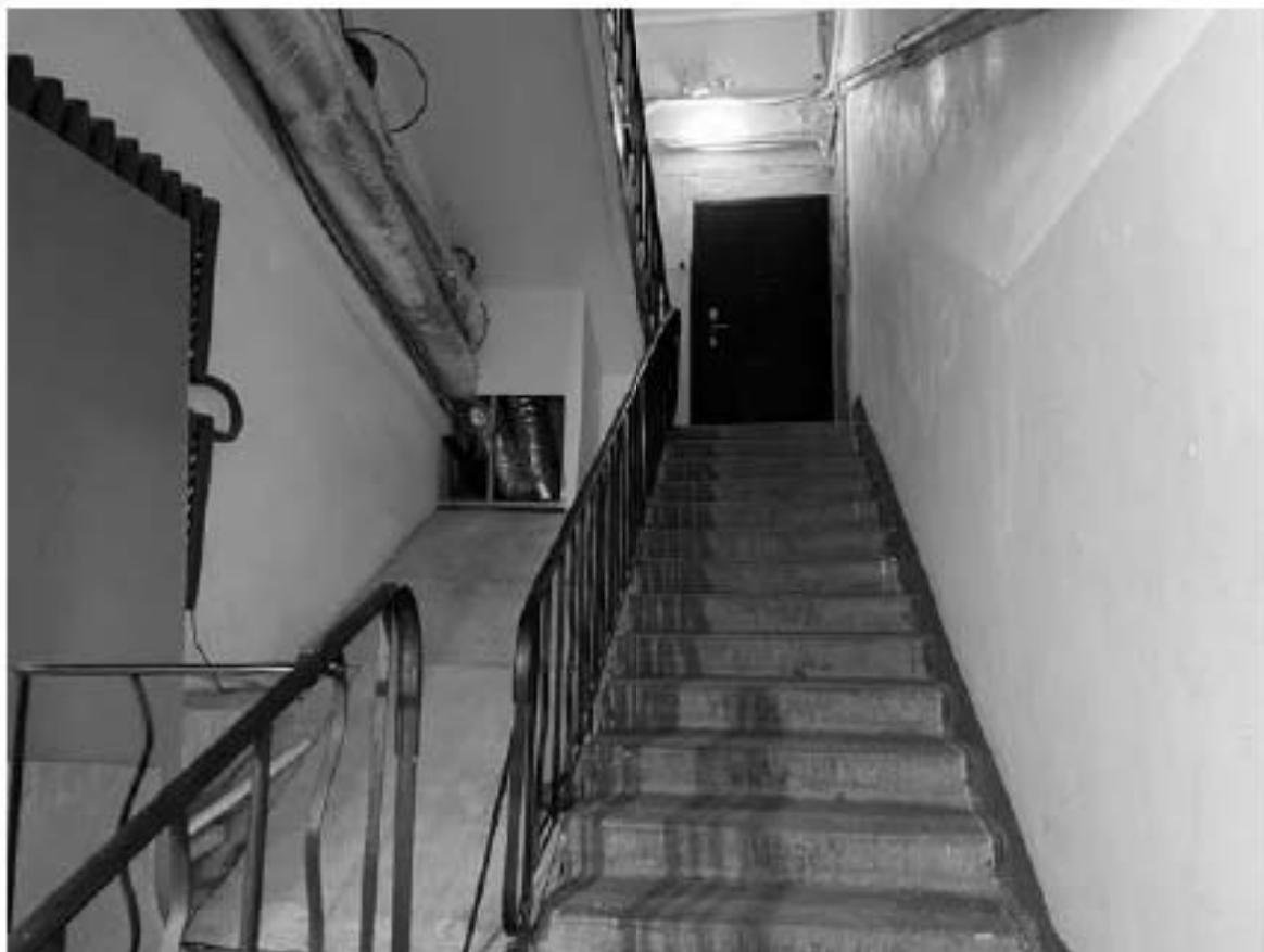
83. Фрагмент интерьера лестницы 6ЛК
