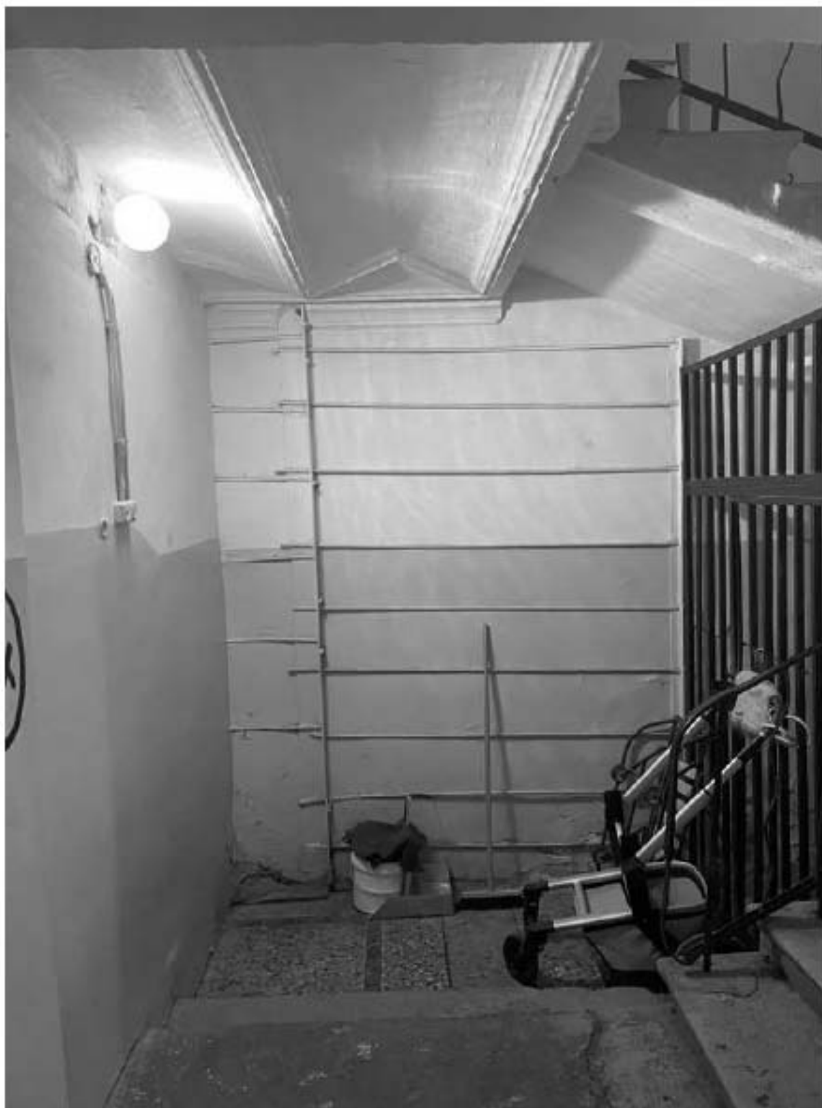
47. Фрагмент интерьера лестницы 2ЛК
