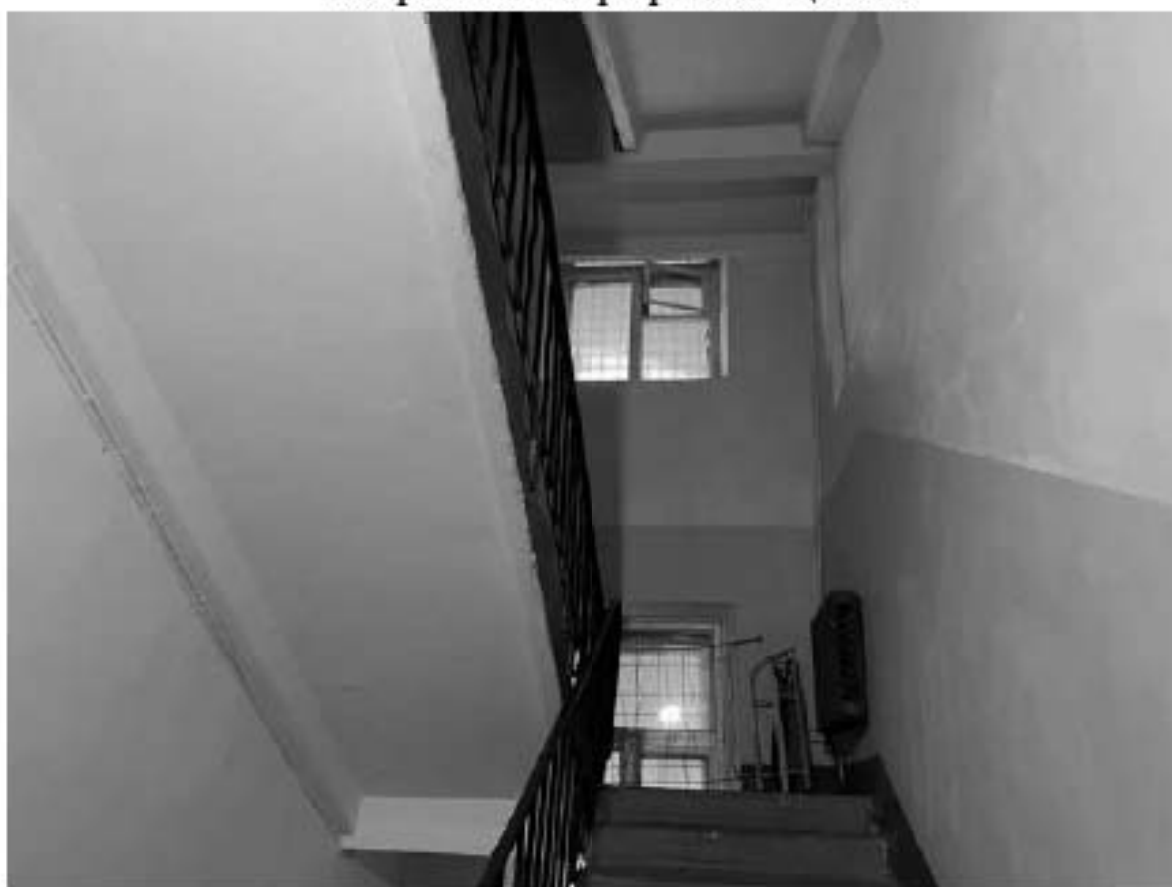
86. Фрагмент интерьера лестницы 6ЛК
