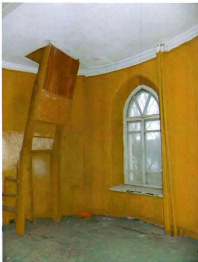
11. Помещение башни 3 этаж
