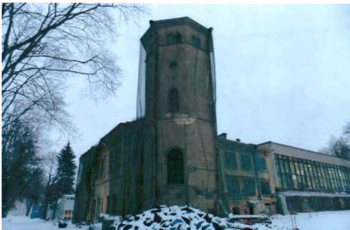
2. Западный и южный фасады
