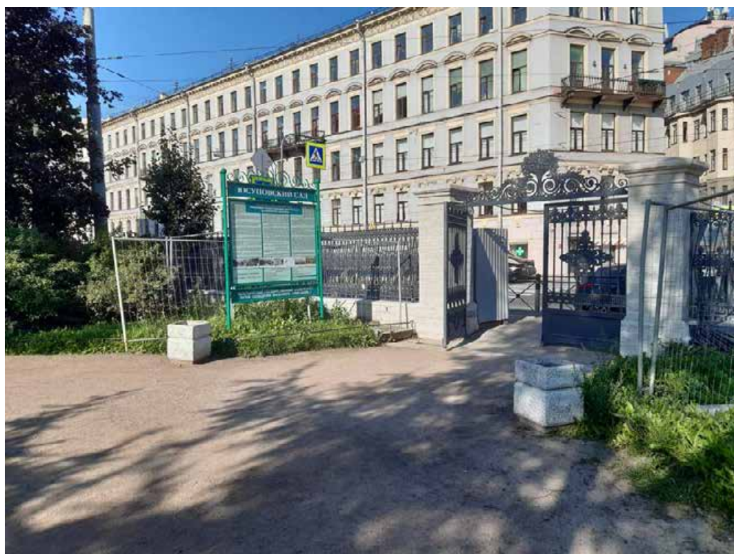
Фото 4. Вид на объект культурного наследия федерального значения «Ограда с воротами», входящего в состав объекта культурного наследия федерального значения «Дворец Юсуповых» (со стороны Юсуповского сада)
