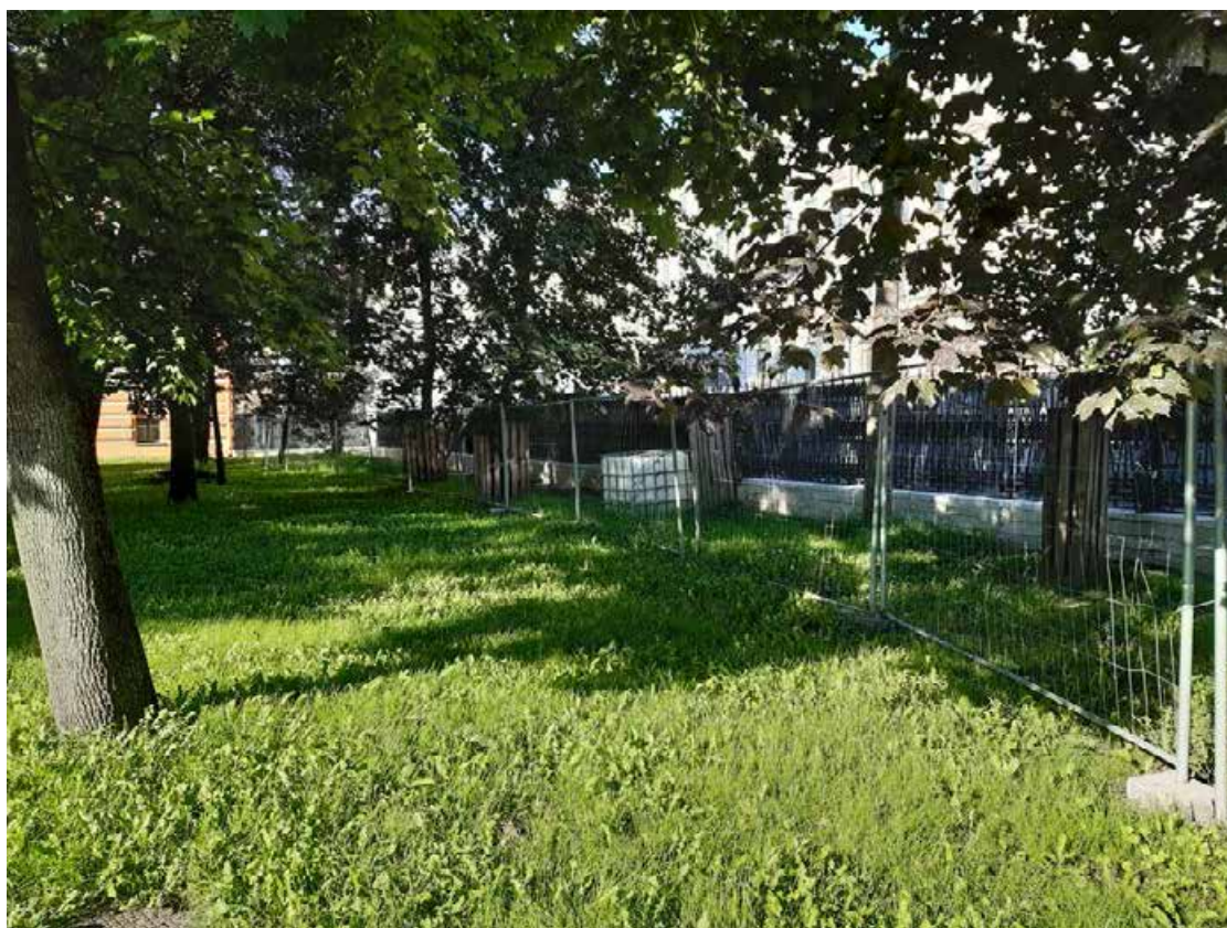
Фото 8 Вид на объект культурного наследия федерального значения «Ограда с воротами», входящего в состав объекта культурного наследия федерального значения «Дворец Юсуповых» (со стороны Юсуповского сада)
