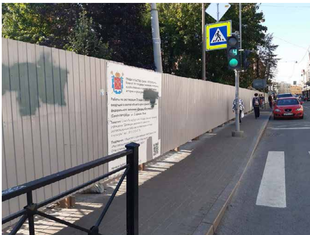
Фото 2. Вид на объект культурного наследия федерального значения «Ограда с воротами», входящего в состав объекта культурного наследия федерального значения «Дворец Юсуповых» (со стороны Садовой улицы)
