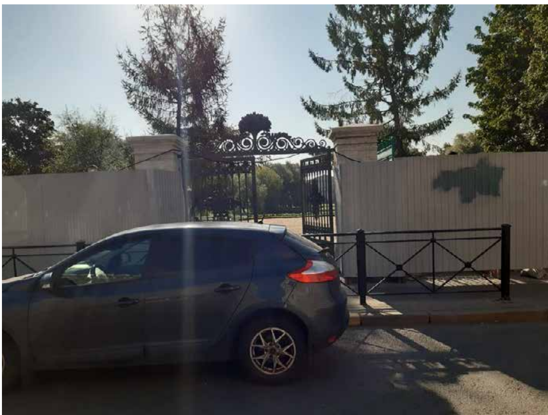
Фото 3. Вид на объект культурного наследия федерального значения «Ограда с воротами», входящего в состав объекта культурного наследия федерального значения «Дворец Юсуповых» (со стороны Садовой улицы)
