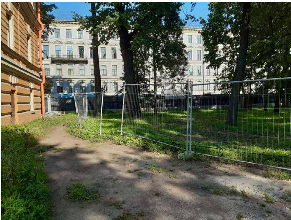
Фото 9 Вид на объект культурного наследия федерального значения «Ограда с воротами», входящего в состав объекта культурного наследия федерального значения «Дворец Юсуповых» (со стороны Юсуповского сада)
