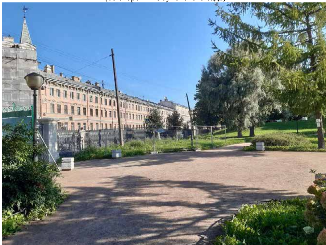
Фото 6. Вид на объект культурного наследия федерального значения «Ограда с воротами», входящего в состав объекта культурного наследия федерального значения «Дворец Юсуповых» (со стороны Юсуповского сада)
