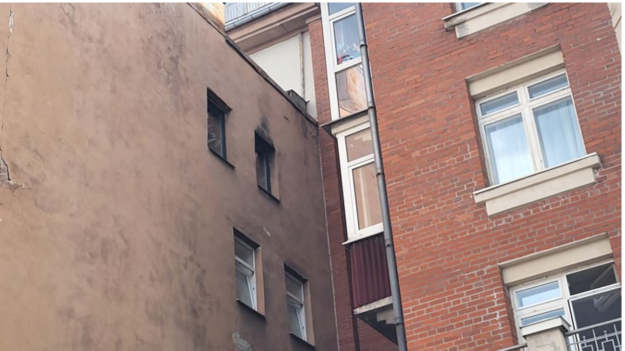
7. Выявленный объект культурного наследия «Дом Э.И. Гейдериха», расположенный по адресу: г. Санкт-Петербург, Сампсониевский Большой пр., 84. Дата: 01.09.24 г.
