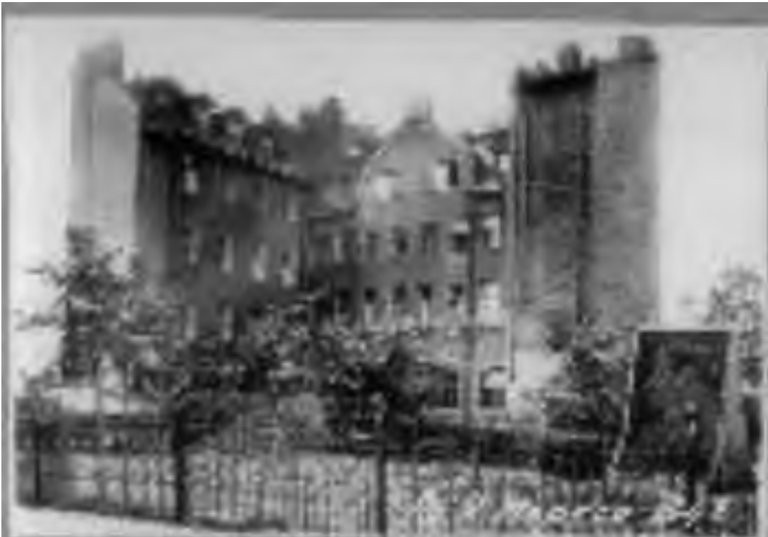
8. 1900-е гг. Двор и вид на дом № 84а. ЦГАКФФД СПб. Фотодокументы. Оп. 1ГР-47. Ед. хр. 70687.
