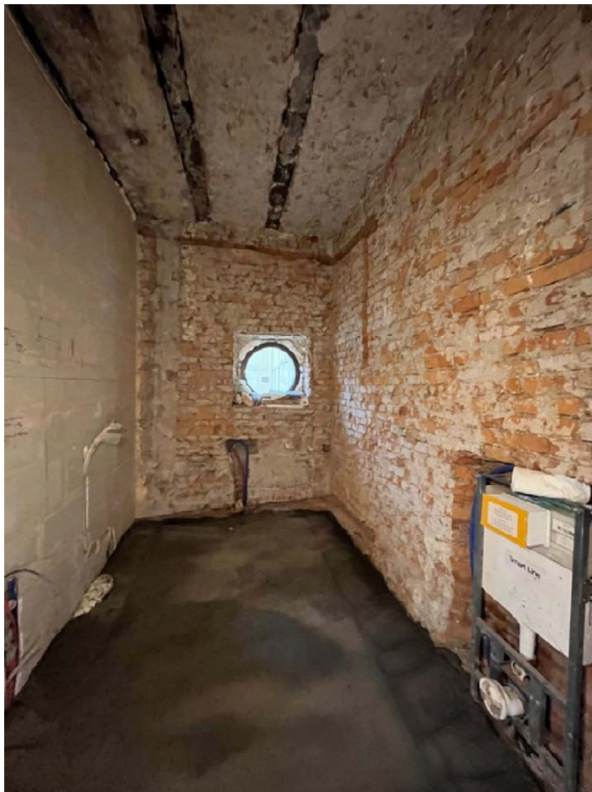
Фото №8. Помещения №№ 5, 6. Перегородка между помещениями демонтирована.
