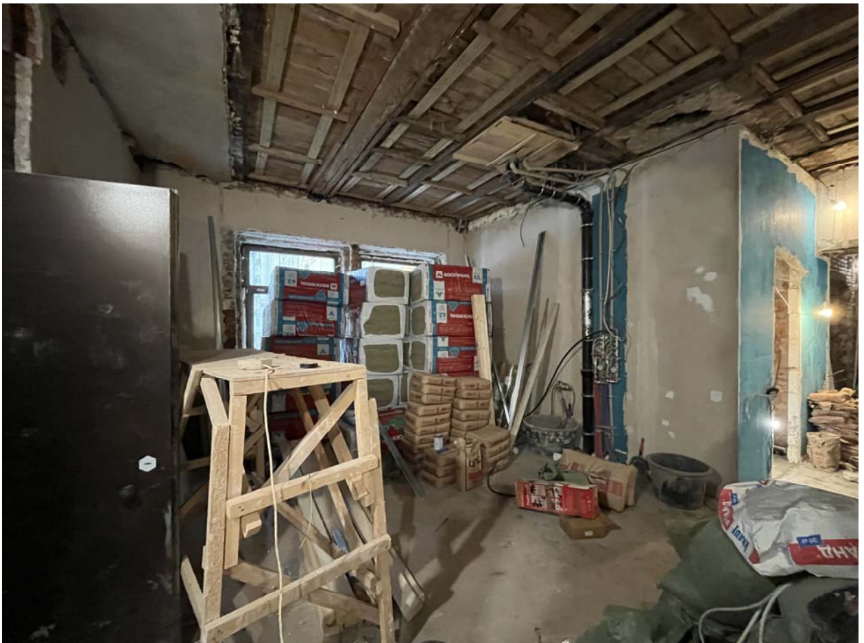
Фото №7. Помещения №№ 1, 2. Перегородка между помещениями демонтирована.
