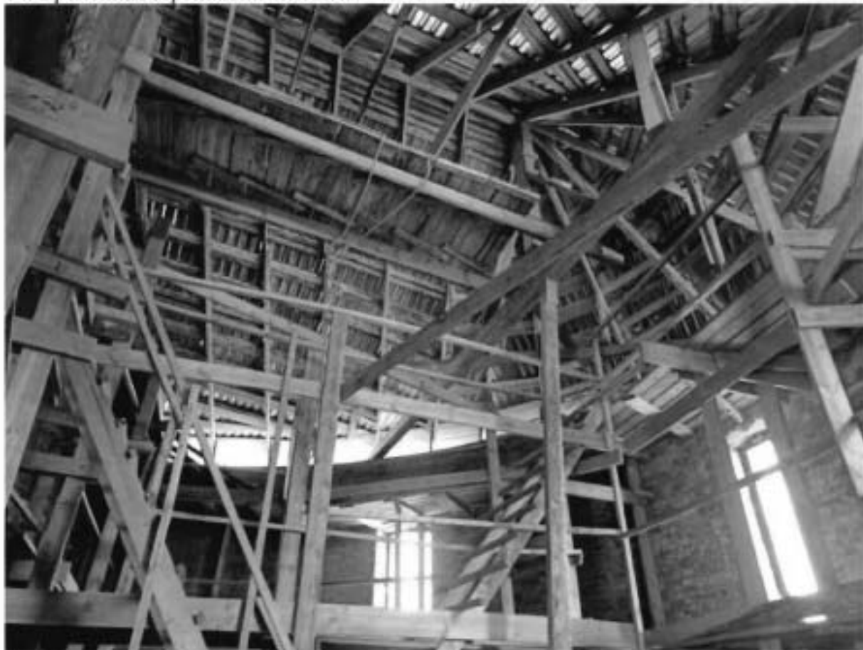
14. Временная стропильная система.
