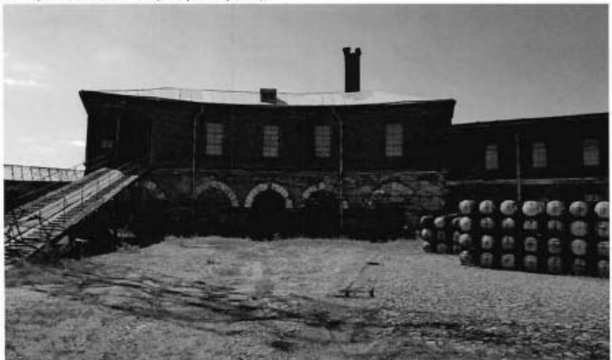
2. Фронтальная башня (северный фасад).
