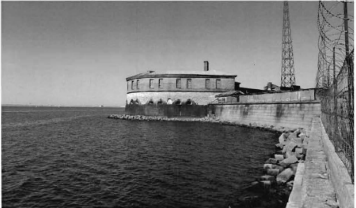
1. Фронтальная башня (южный фасад).
