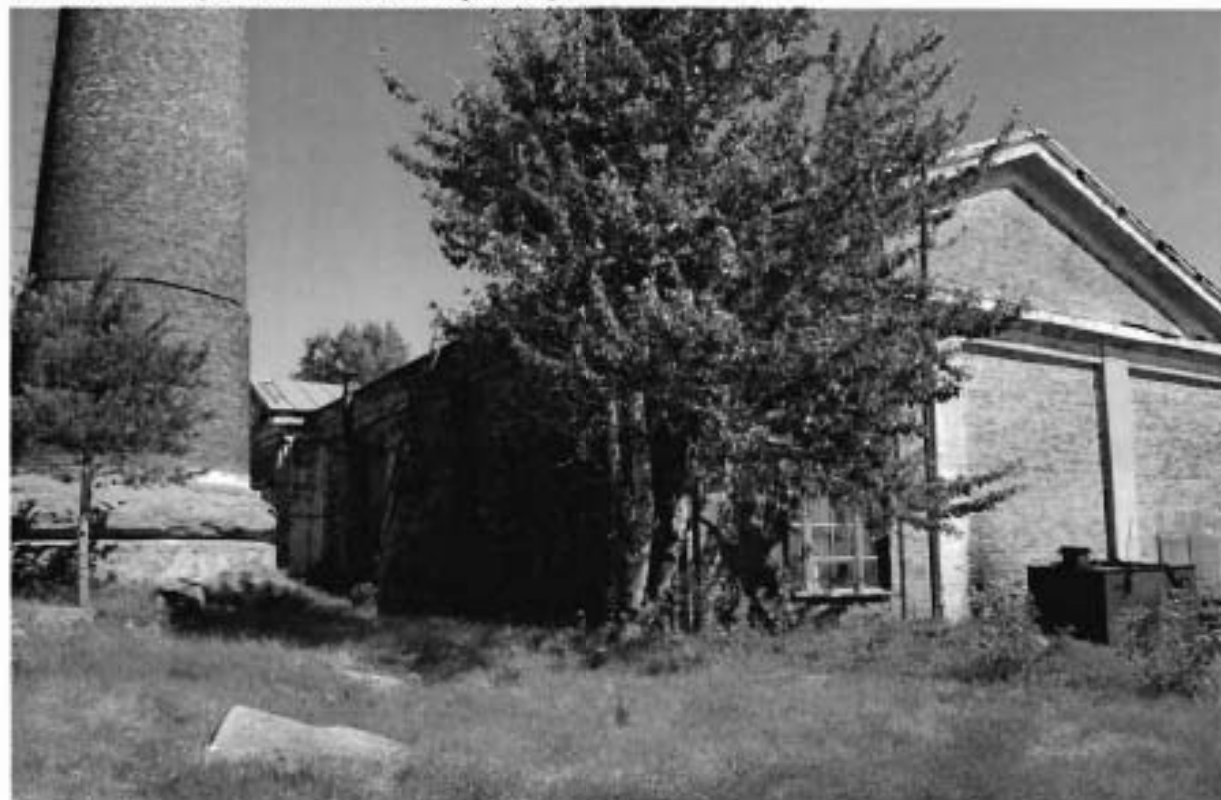
11. Котельная (западный и южный фасады).
