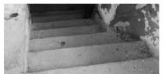
межэтажные лестницы – местоположение, габариты, тип (маршевые), материал (известняк) и профиль ступеней,
