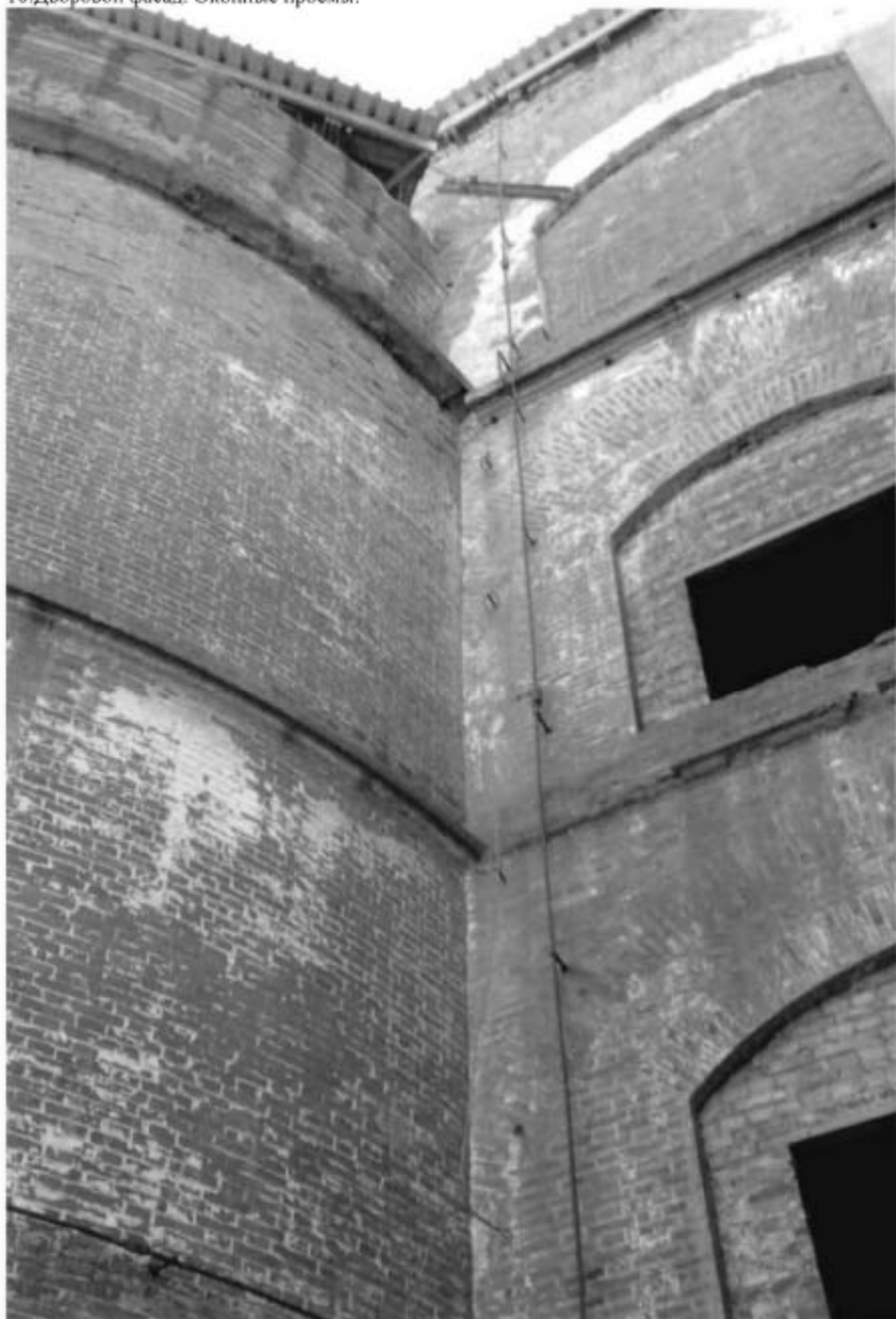
16. Дворовой фасад. Оконные проемы.
