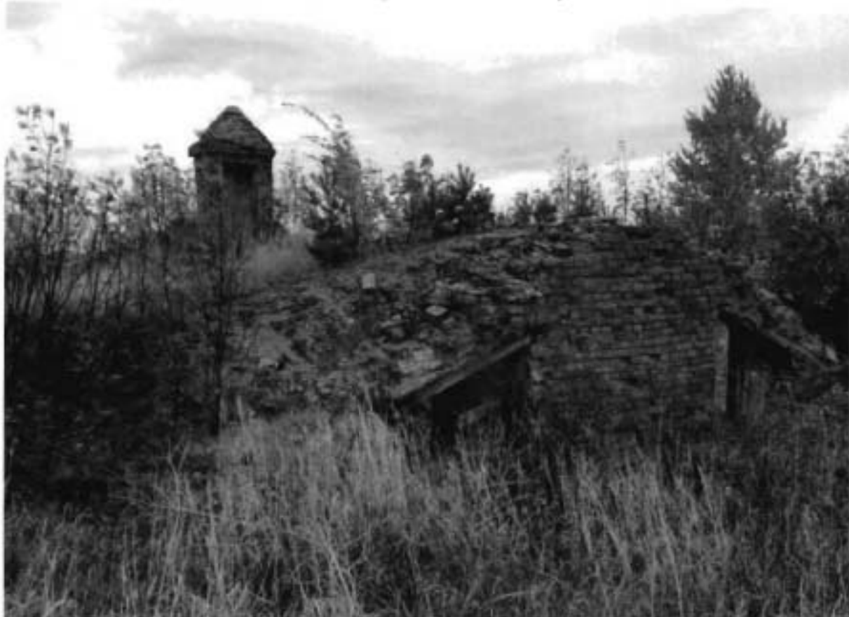
15. Кухня и пекарня. Западный фасад (фото от 05.10.2021).
