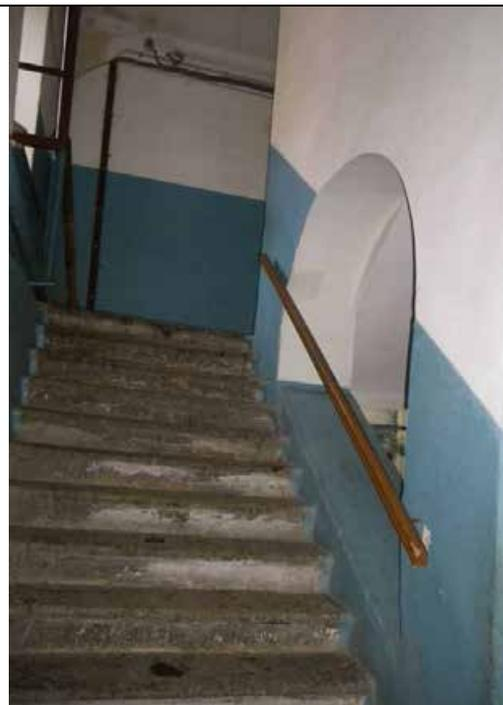
2-ЛК – местоположение (в уровне 1-4-го этажей), габариты, конфигурация, тип (одномаршевая), конструкция (на косоурах), материал ступеней и площадок (известняк);
