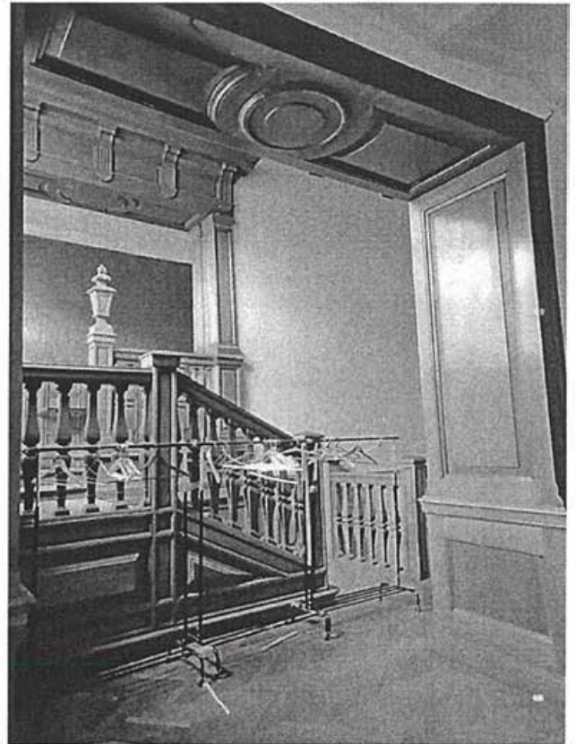
23. Проем оформленный деревянными филенками
