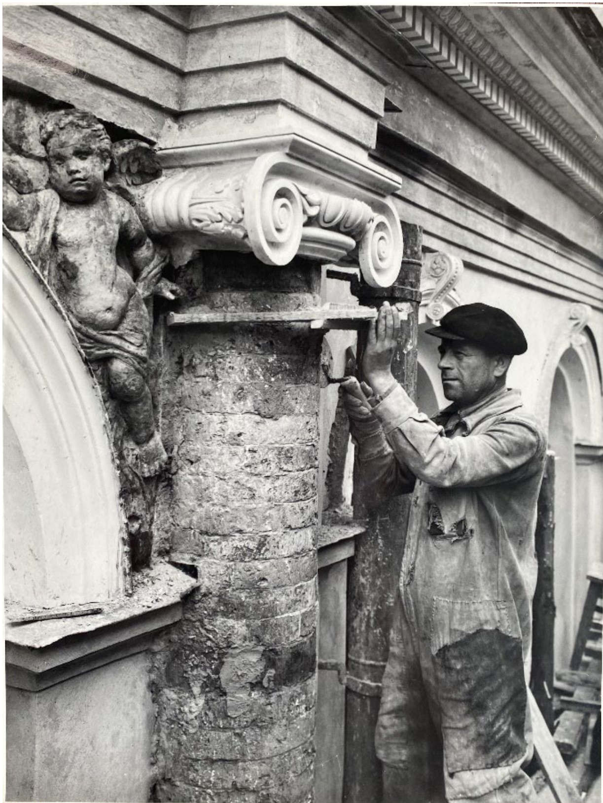
14. Реставрация колонн. 1949 г. Источник: ЦГАНТД СПб. Ф. 488. Оп. 36. Д. 56. Л. 4.
