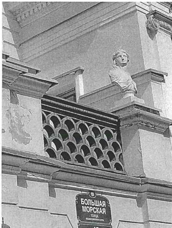
4. Восточный лицевой фасад объекта культурного наследия
