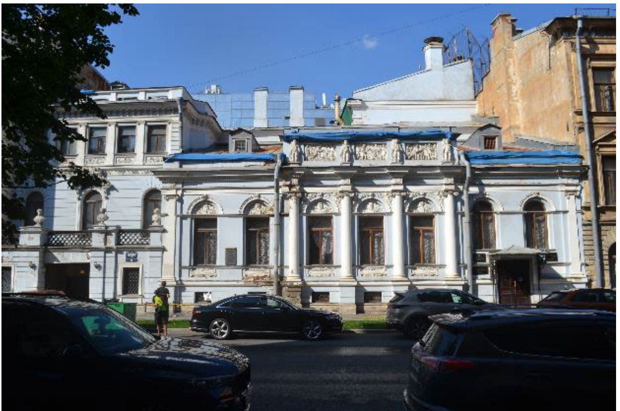
1. Юго-восточный лицевой фасад объекта культурного наследия федерального значения «Дом Демидова П.Н. (Гагариной В.Ф.)», расположенного по адресу: г. Санкт-Петербург, Большая Морская ул., д. 45, литера А. 02.10.2024
