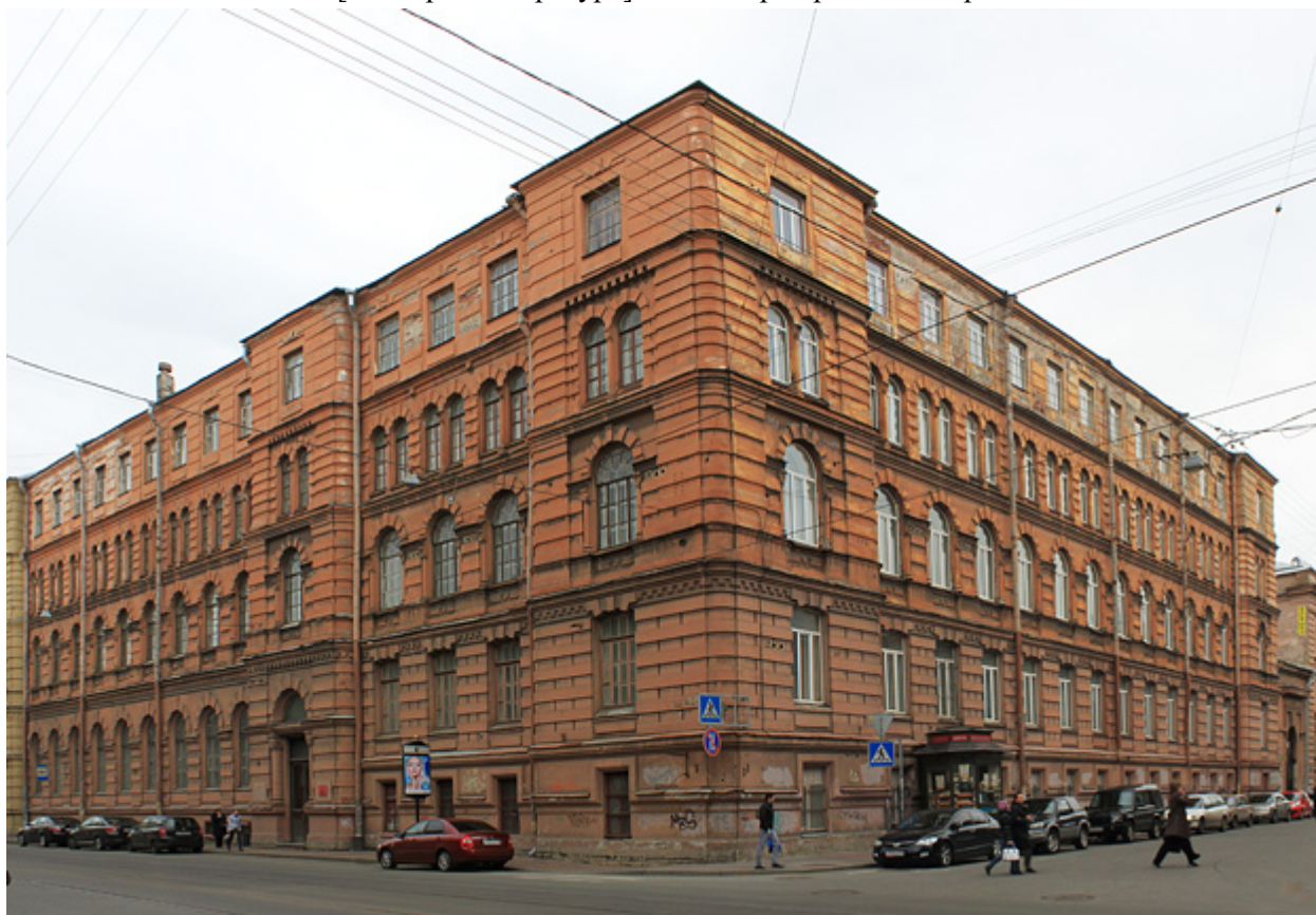
18. 2011 г. — 3-я военная гимназия - Кадетский корпус императора Александра II (левая часть) - Поликлиника военной комендатуры // Citywalls.ru – архитектурный сайт Петербурга [Электронный ресурс]. URL: https://www.citywalls.ru/house1749.html .
