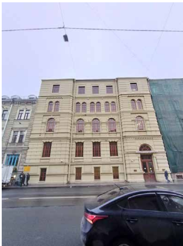
Фото 5. Фрагмент лицевого фасада выявленного объекта культурного наследия «Здание Третьей военной гимназии» (по Садовой ул.)
