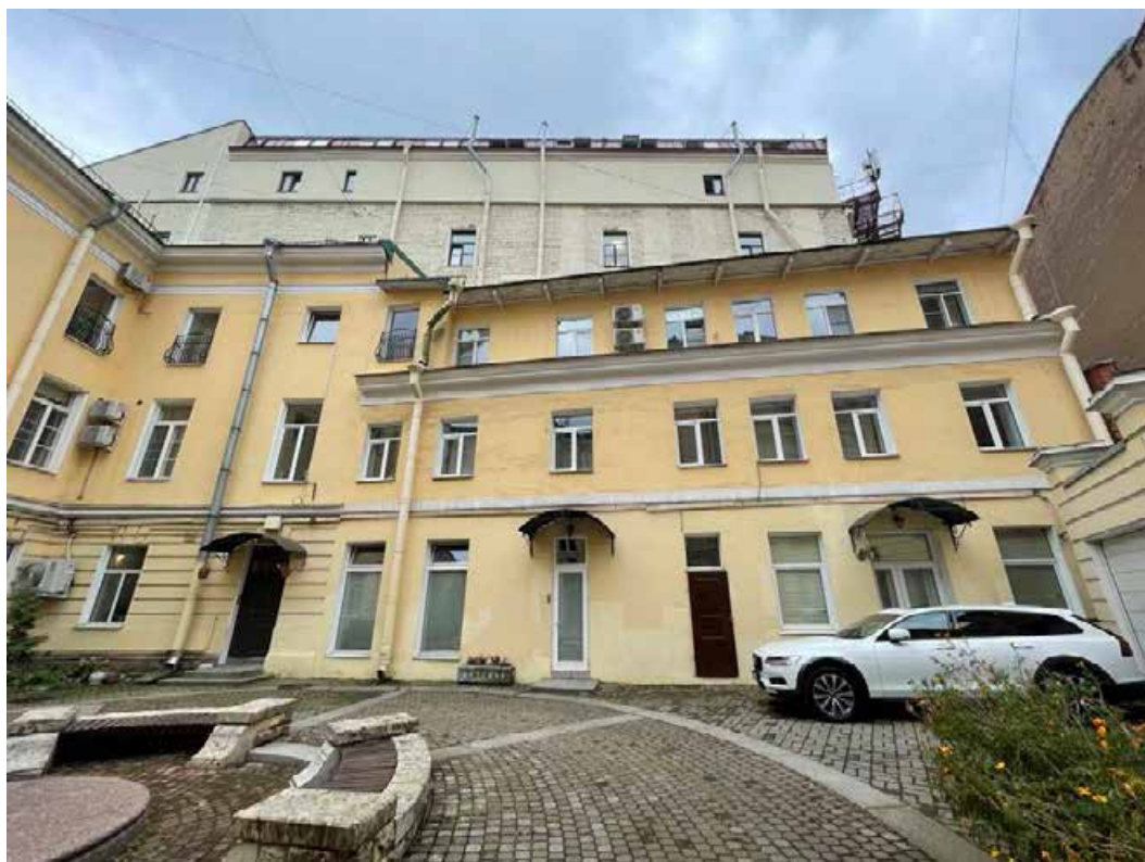
Фото 7. Фрагмент дворового фасада объекта культурного наследия федерального значения «Дом Аракчеева А.А.»
