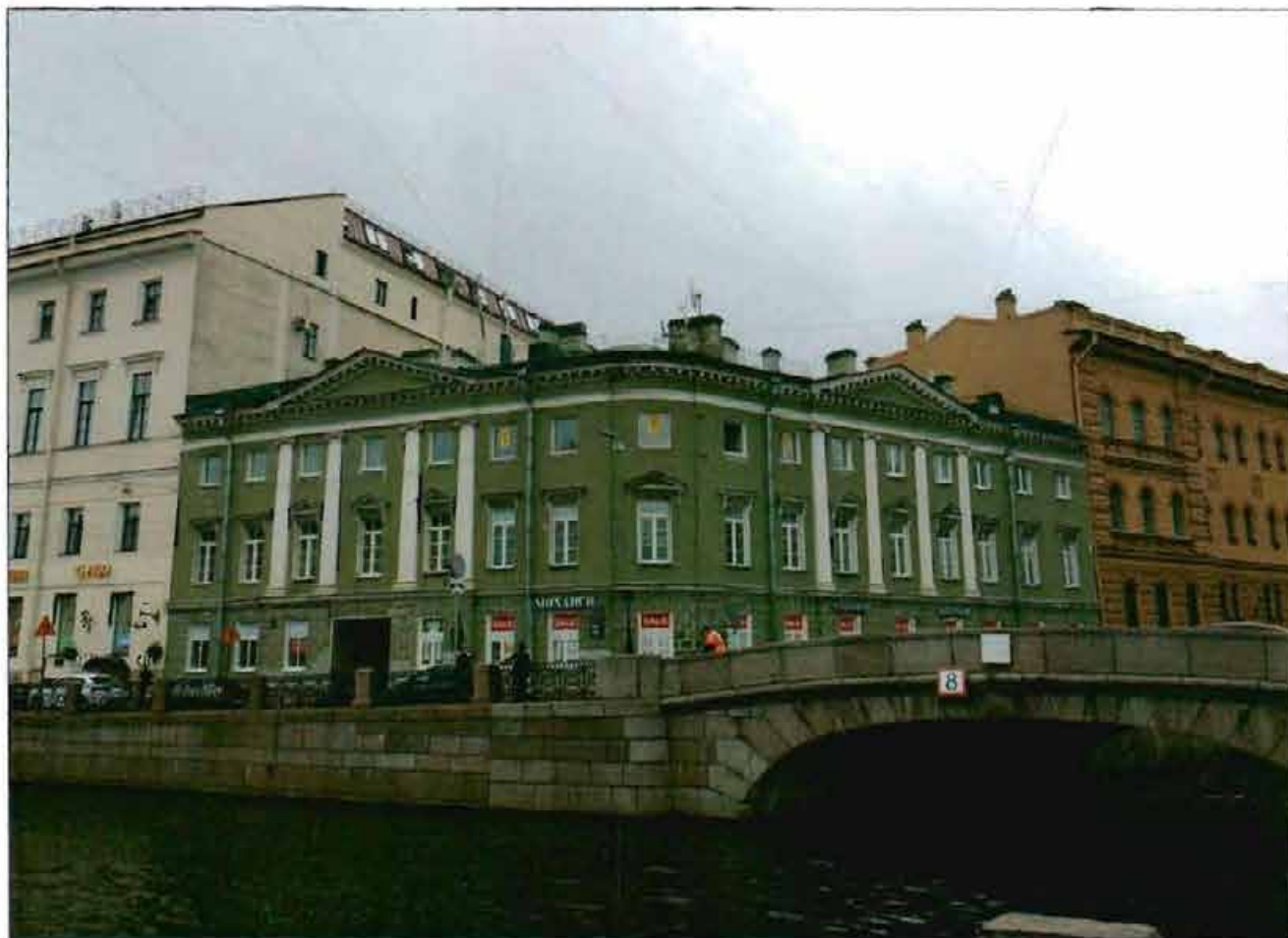
1. Общий вид с востока.
