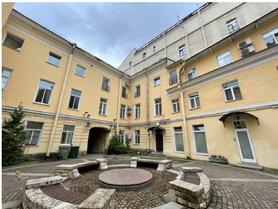
Фото 4. Фрагмент дворового фасада объекта культурного наследия федерального значения «Дом Аракчеева А.А.»
