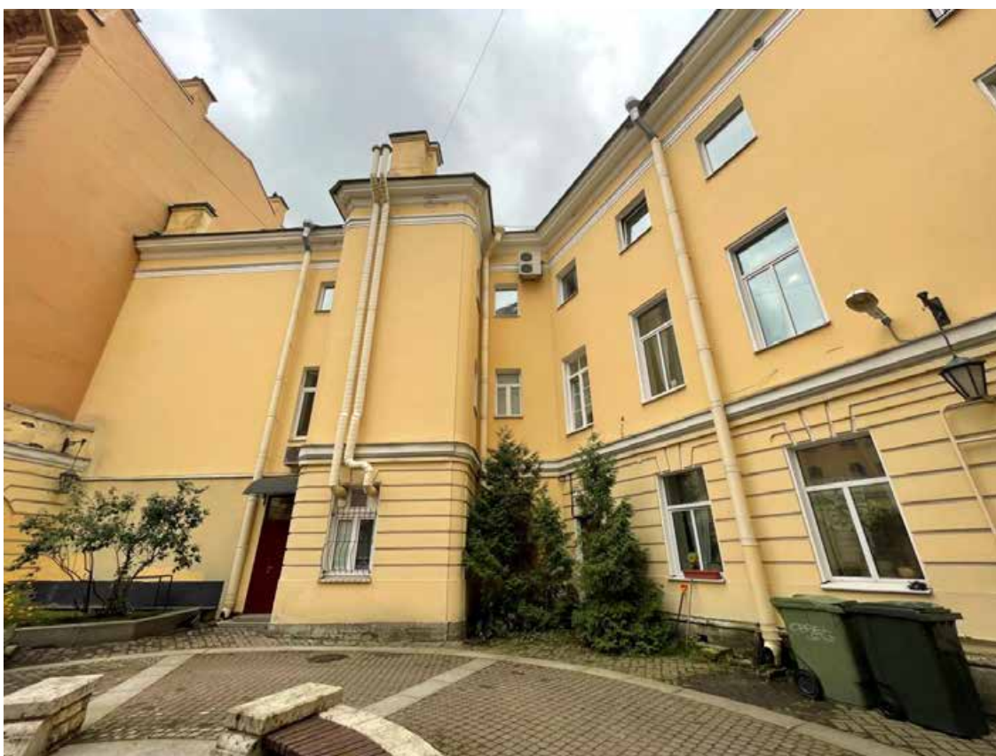
Фото 6. Фрагмент дворового фасада объекта культурного наследия федерального значения «Дом Аракчеева А.А.»
