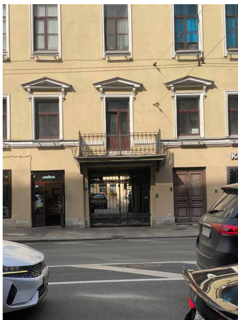
2. Здание по адресу: Санкт-Петербург, Невский проспект, д. 6, Лит. А. Фрагмент лицевого фасада
