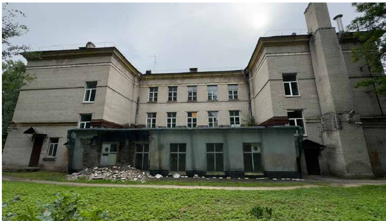
3. Общий вид фасада Государственного бюджетного общеобразовательного учреждения средняя общеобразовательная школа №471 Выборгского района Санкт-Петербурга, по адресу: г. Санкт-Петербург, п. Парголово, Осиновая Роща, Школьный пер., д. 1, лит. А, г. Санкт-Петербург, п. Парголово, Осиновая Роща, Школьный пер., д. 1, лит. Б;
