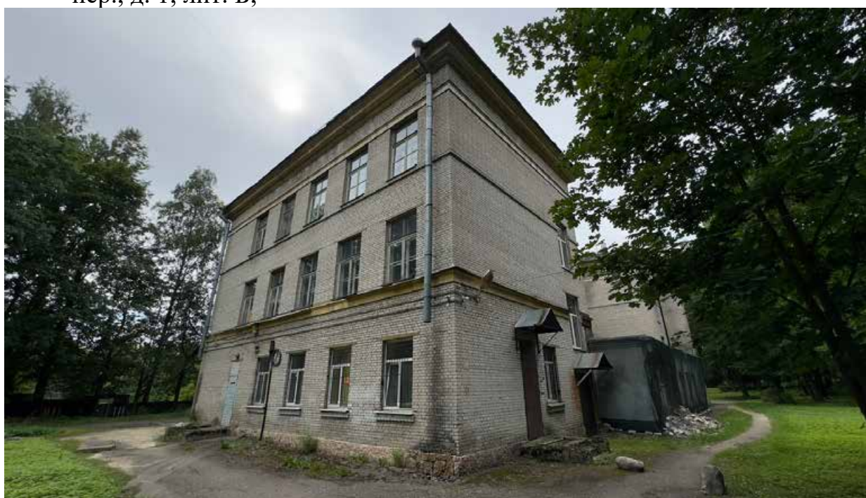
4. Общий вид фасада Государственного бюджетного общеобразовательного учреждения средняя общеобразовательная школа №471 Выборгского района Санкт-Петербурга, по адресу: г. Санкт-Петербург, п. Парголово, Осиновая Роща, Школьный пер., д. 1, лит. А, г. Санкт-Петербург, п. Парголово, Осиновая Роща, Школьный пер., д. 1, лит. Б;
