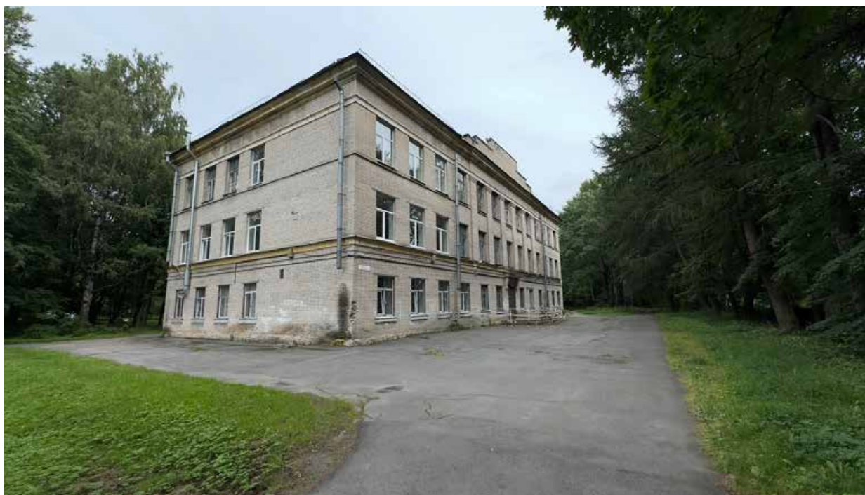
1. Общий вид фасада Государственного бюджетного общеобразовательного учреждения средняя общеобразовательная школа №471 Выборгского района Санкт-Петербурга, по адресу: г. Санкт-Петербург, п. Парголово, Осиновая Роща, Школьный пер., д. 1, лит. А, г. Санкт-Петербург, п. Парголово, Осиновая Роща, Школьный пер., д. 1, лит. Б;
