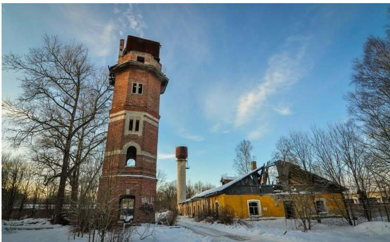
Илл. 46. Усадьба Осиновая Роща. Водонапорная башня. Фото 2018 г. Источник: https://www.drive2.ru/l/517294383419098033/
