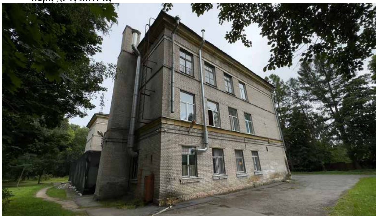
2. Общий вид фасада Государственного бюджетного общеобразовательного учреждения средняя общеобразовательная школа №471 Выборгского района Санкт-Петербурга, по адресу: г. Санкт-Петербург, п. Парголово, Осиновая Роща, Школьный пер., д. 1, лит. А, г. Санкт-Петербург, п. Парголово, Осиновая Роща, Школьный пер., д. 1, лит. Б;
