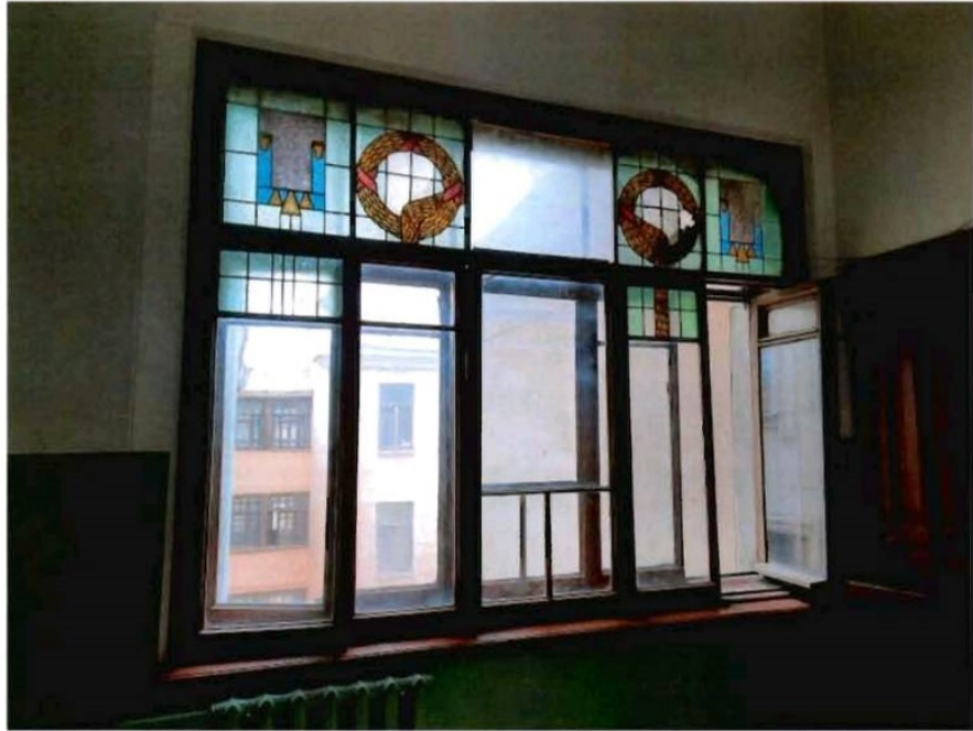
22. Интерьеры объекта культурного наследия. Помещения парадной лестницы 9ЛК
