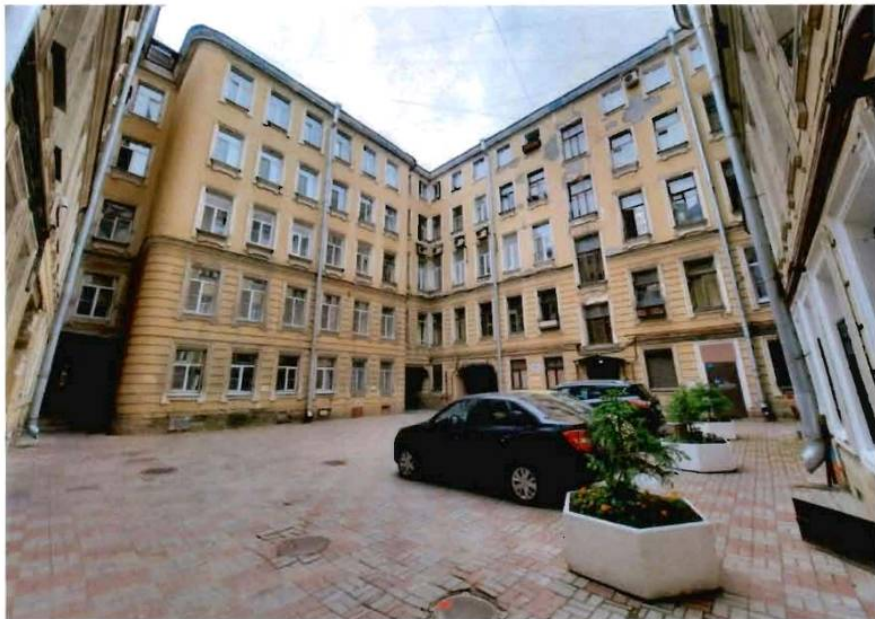
3. Общий вид на северный внутренний двор объекта культурного наследия (северо-восточный и северо-западный фасады)
