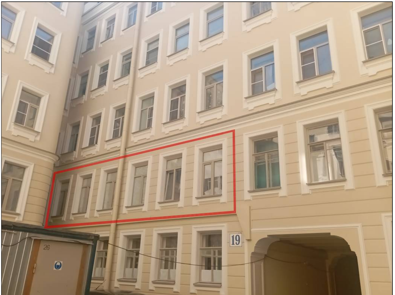
6. Общий вид дворовых фасадов во внутреннем дворе (северном). Окна квартиры №54.
