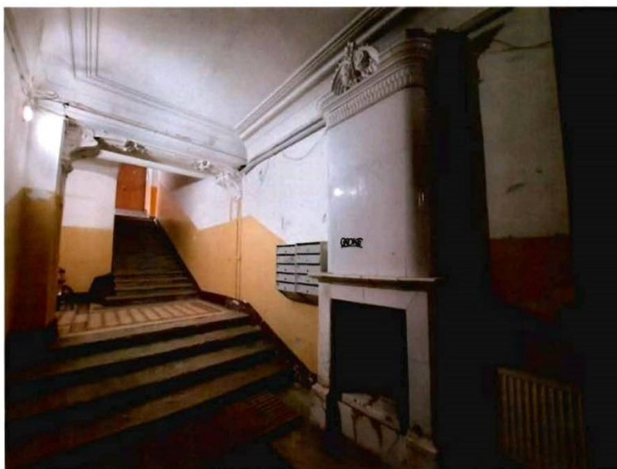
17. Интерьеры объекта культурного наследия. Помещения парадной лестницы 7ЛК
