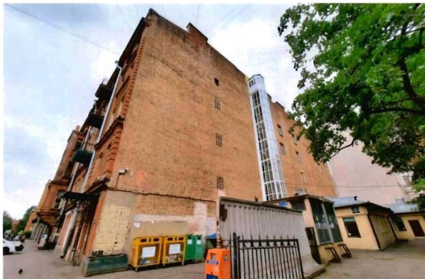
8. Общий вид на юго-восточный фасад объекта культурного наследия
