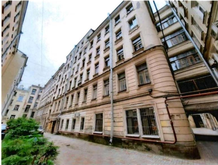
4. Общий вид на северо-западный фасад объекта культурного наследия
