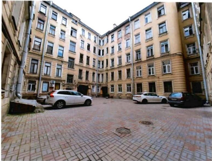
6. Общий вид на южный внутренний двор объекта культурного наследия (северо-западный и юго-западный фасады)
