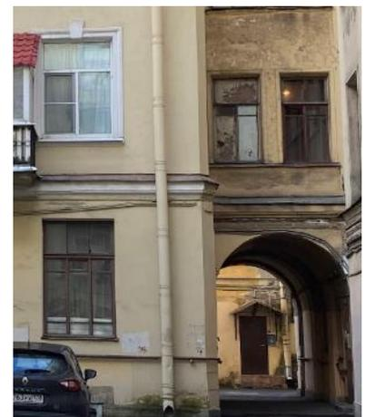
оформление оконных проемов тонкими наличниками, профилированными наличниками с замковыми камнями, подоконными фигурными досками;
