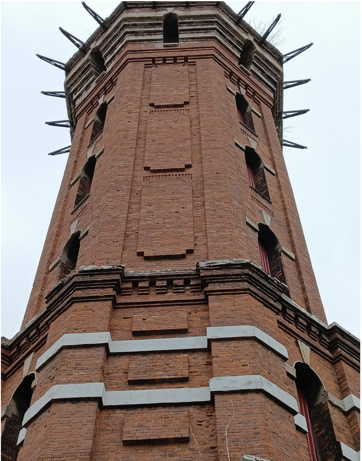
Фото 9. Выявленный объект культурного наследия «Водонапорная башня», расположенный по адресу: Санкт-Петербург, наб. Обводного канала, д. 118, литера Л, входящий в состав выявленного объекта культурного наследия «Комплекс построек Варшавского вокзала», расположенного по адресу: Санкт-Петербург, Обводного кан. наб., д. 118. Юго-восточная грань фасада. Обработка стен третьего яруса плоскими угловыми лопатками, двумя рядами плоских кирпичных поясов, обработка стен четвертого-шестого ярусов плоскими нишами с кирпичными филенками, кирпичными городчатыми поясками.
