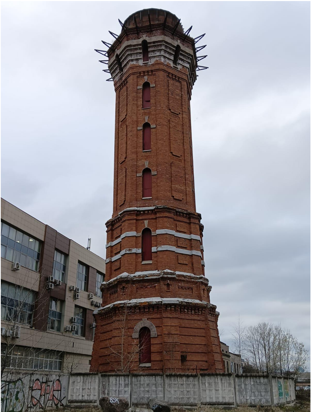
Фото 3. Выявленный объект культурного наследия «Водонапорная башня», расположенный по адресу: Санкт-Петербург, наб. Обводного канала, д. 118, литера Л, входящий в состав выявленного объекта культурного наследия «Комплекс построек Варшавского вокзала», расположенного по адресу: Санкт-Петербург, Обводного кан. наб., д. 118. Южная грань фасада (с оконными проемами).
