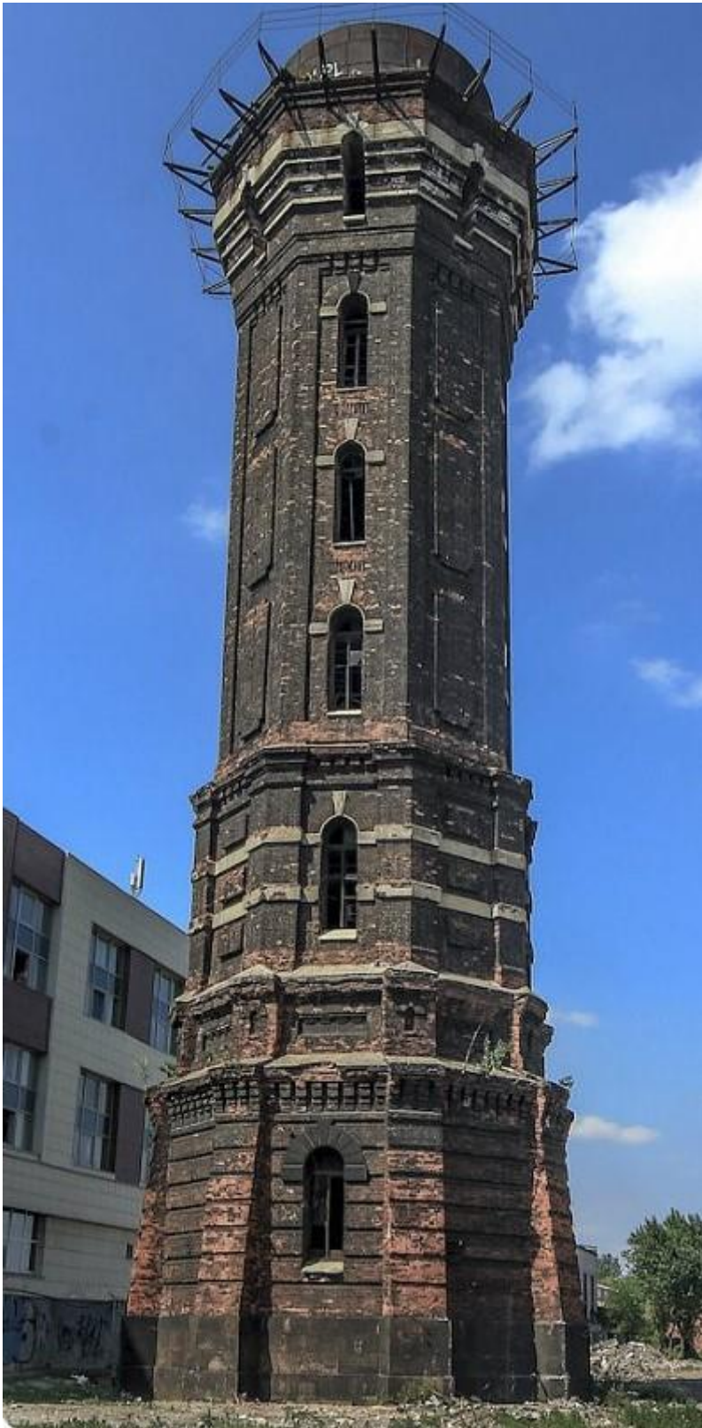
Иллюстрация 19. Башня водонапорная станции Санкт-Петербург -Варшавский. 2013.
