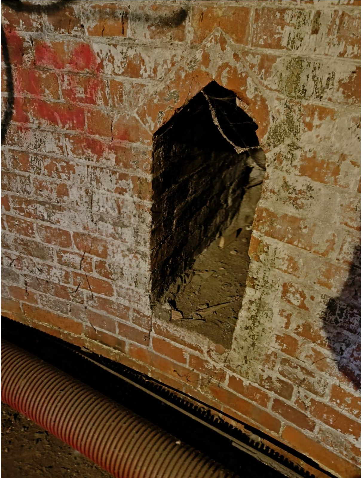
Фото 11. Выявленный объект культурного наследия «Водонапорная башня», расположенный по адресу: Санкт-Петербург, наб. Обводного канала, д. 118, литера Л, входящий в состав выявленного объекта культурного наследия «Комплекс построек Варшавского вокзала», расположенного по адресу: Санкт-Петербург, Обводного кан. наб., д. 118. Ниша стрельчатого очертания в отметке первого уровня.
