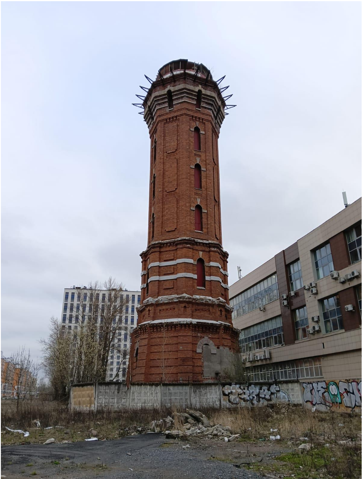
Фото 1. Выявленный объект культурного наследия «Водонапорная башня», расположенный по адресу: Санкт-Петербург, наб. Обводного канала, д. 118, литера Л, входящий в состав выявленного объекта культурного наследия «Комплекс построек Варшавского вокзала», расположенного по адресу: Санкт-Петербург, Обводного кан. наб., д. 118. Северная грань фасада (с оконными проемами).
