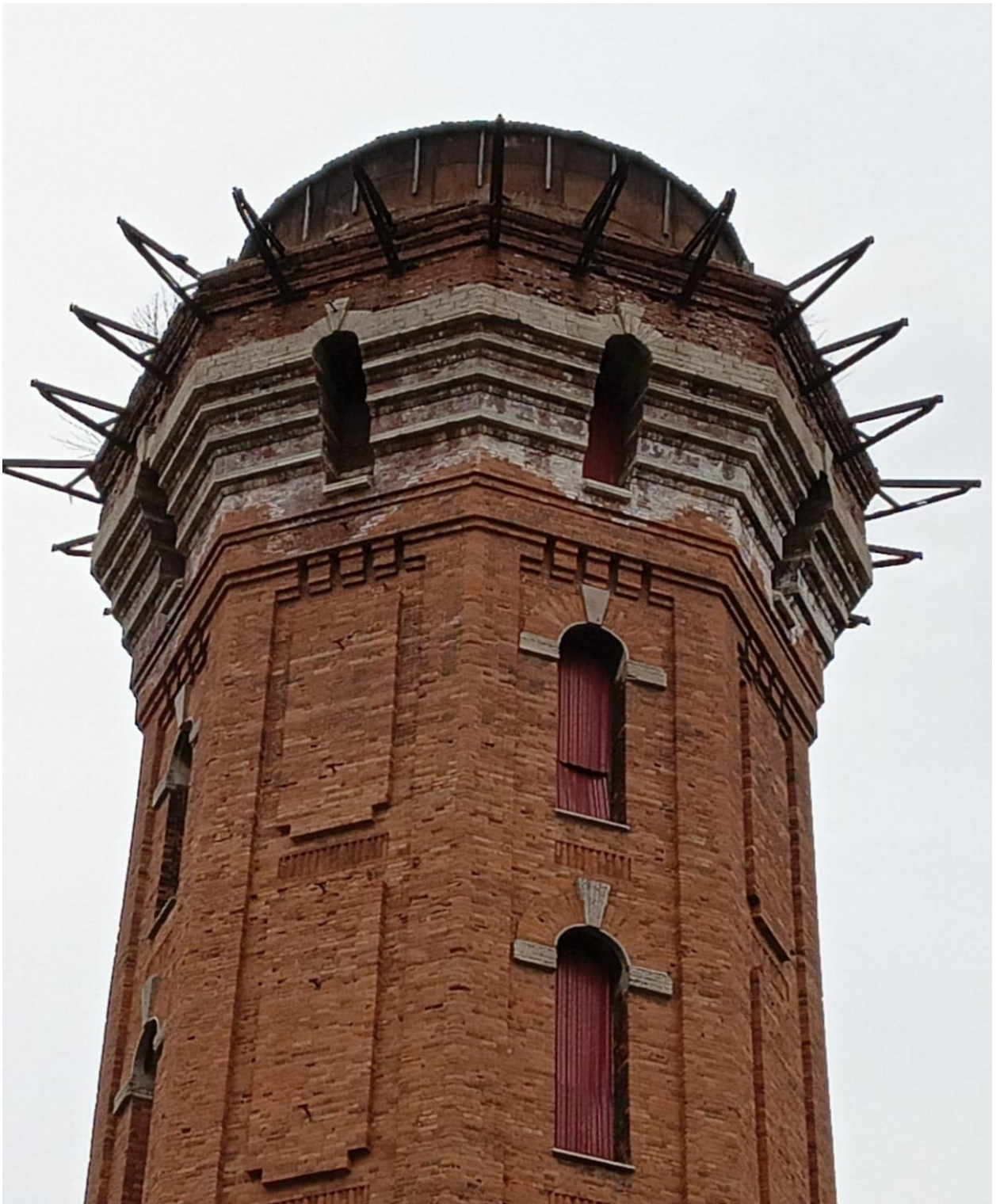
Фото 6. Выявленный объект культурного наследия «Водонапорная башня», расположенный по адресу: Санкт-Петербург, наб. Обводного канала, д. 118, литера Л, входящий в состав выявленного объекта культурного наследия «Комплекс построек Варшавского вокзала», расположенного по адресу: Санкт-Петербург, Обводного кан. наб., д. 118. Юго-западная грань фасада, оформление седьмого яруса в виде машикули; венчающий карниз, кирпичный, профилированный, небольшого выноса. Разрушение верхних рядов кирпичной кладки, высолы.
