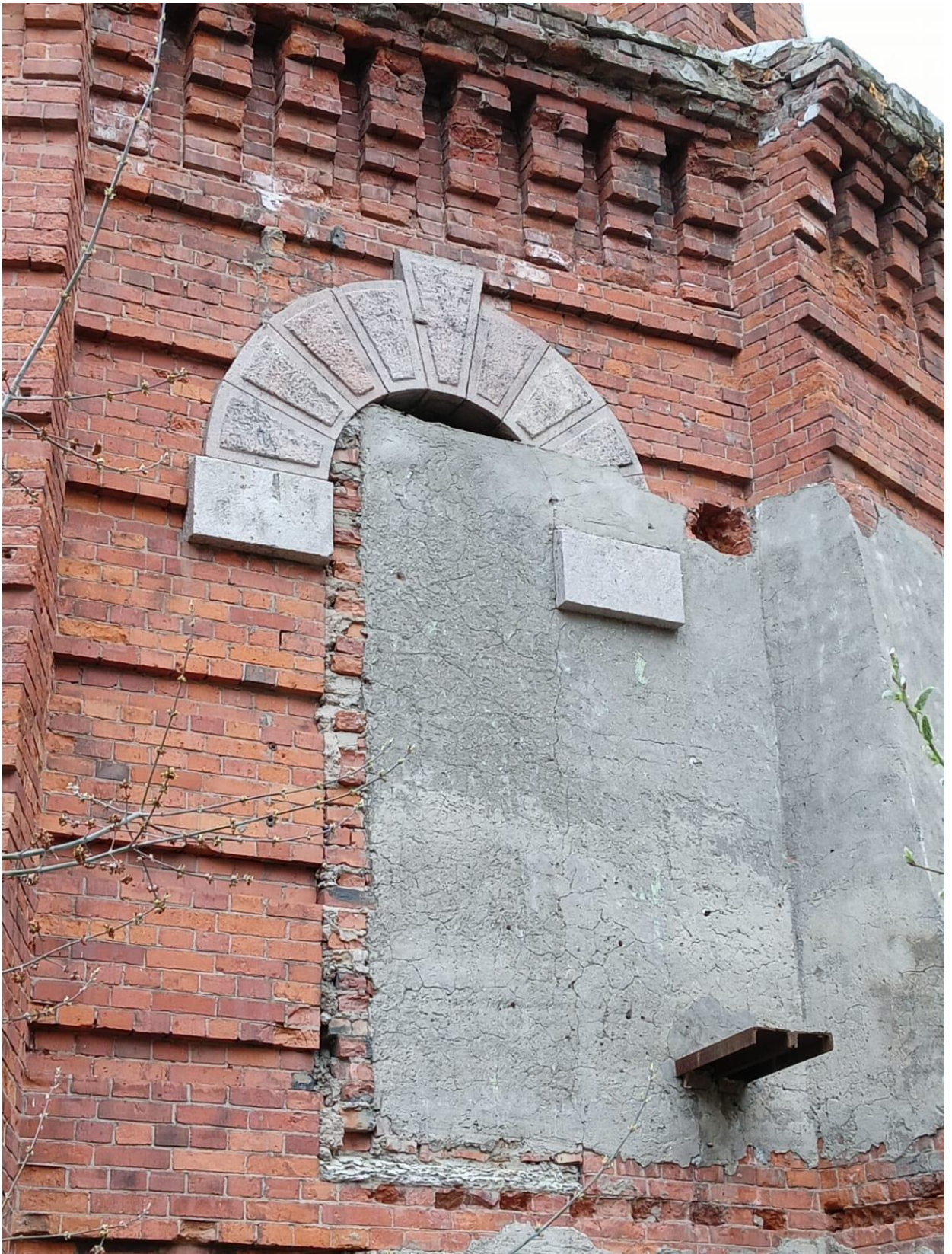
Фото 8. Выявленный объект культурного наследия «Водонапорная башня», расположенный по адресу: Санкт-Петербург, наб. Обводного канала, д. 118, литера Л, входящий в состав выявленного объекта культурного наследия «Комплекс построек Варшавского вокзала», расположенного по адресу: Санкт-Петербург, Обводного кан. наб., д. 118. Северная грань фасада. Поздняя закладка оконного проема первого яруса.
