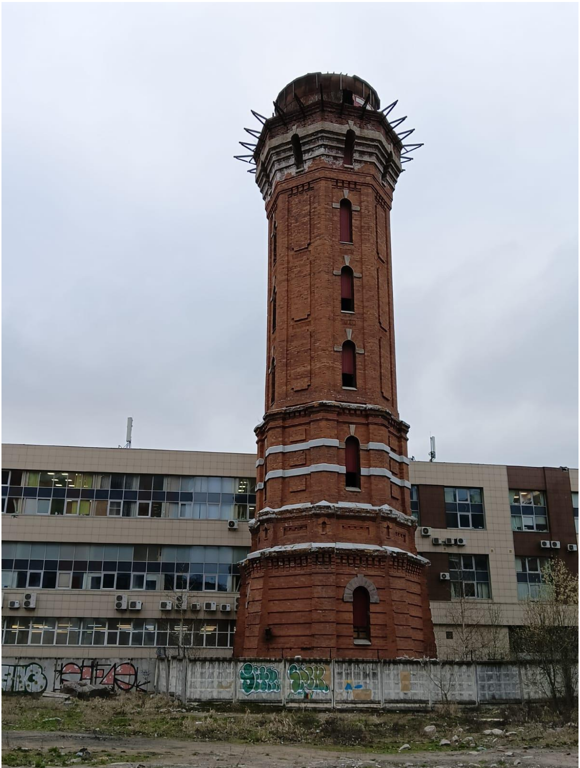
Фото 2. Выявленный объект культурного наследия «Водонапорная башня», расположенный по адресу: Санкт-Петербург, наб. Обводного канала, д. 118, литера Л, входящий в состав выявленного объекта культурного наследия «Комплекс построек Варшавского вокзала», расположенного по адресу: Санкт-Петербург, Обводного кан. наб., д. 118. Восточная грань фасада (с оконными проемами).
