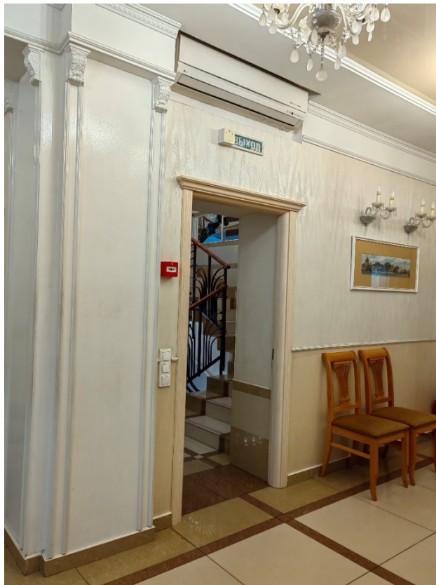
17. Выявленный объект культурного наследия здание магазина «Хрусталь» Ю.С. Нечаева-Мальцева», расположенного по адресу: Санкт-Петербург, 1-я Красноармейская улица, дом 6, литера Б. 2 этаж Коридор.
