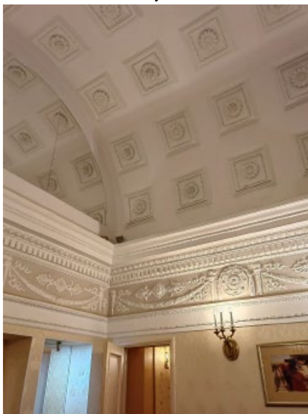
12. Выявленный объект культурного наследия здание магазина «Хрусталь» Ю.С. Нечаева-Мальцева», расположенного по адресу: Санкт-Петербург, 1-я Красноармейская улица, дом 6, литера Б. Зал ожидания регистрации и подачи документов.
