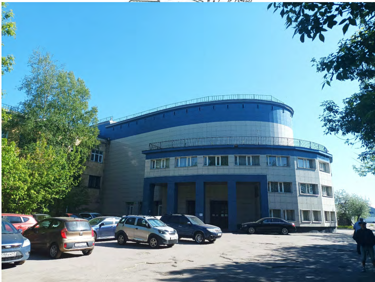
4. Объект культурного наследия регионального значения «Здание Института инженеров Гражданского воздушного флота». Вид объекта с севера. Фрагмент фасада. Дата съемки: 02.05.2024г.
