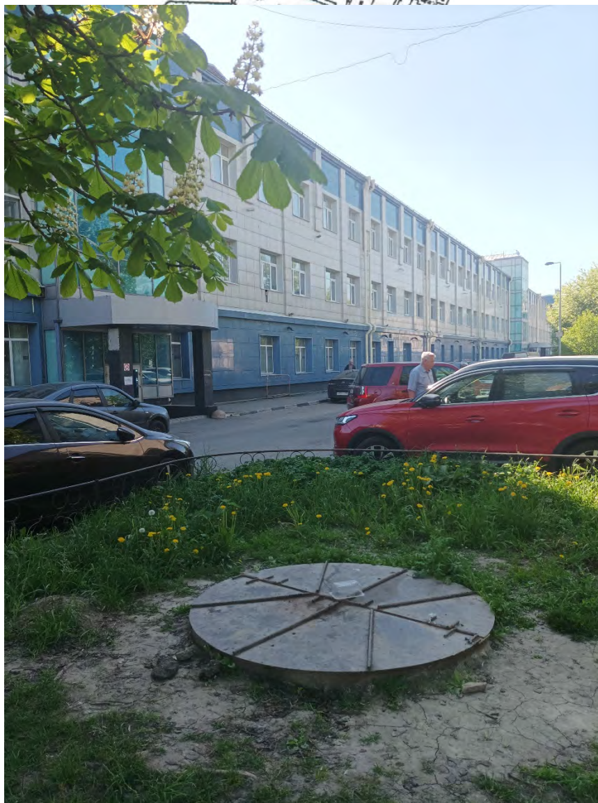
26. Объект культурного наследия регионального значения «Здание Института инженеров Гражданского воздушного флота». Земельный участок проектирования реконструкции тепловых сетей. Дата съемки: 02.05.2024г.
