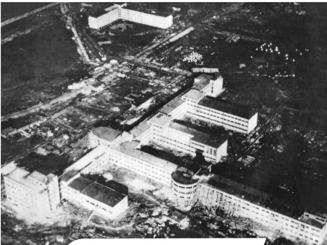
7. «Здание Института инженеров Гражданского воздушного флота». Вид с самолета. 1935 г. Источник: www.pastvu.com
