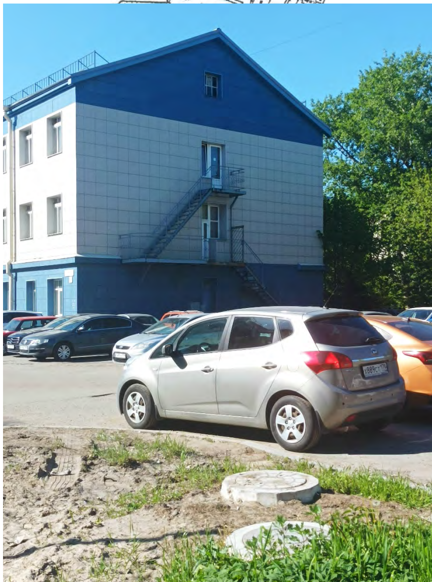
23. Объект культурного наследия регионального значения «Здание Института инженеров Гражданского воздушного флота». Земельный участок проектирования реконструкции тепловых сетей. Дата съемки: 02.05.2024г.
