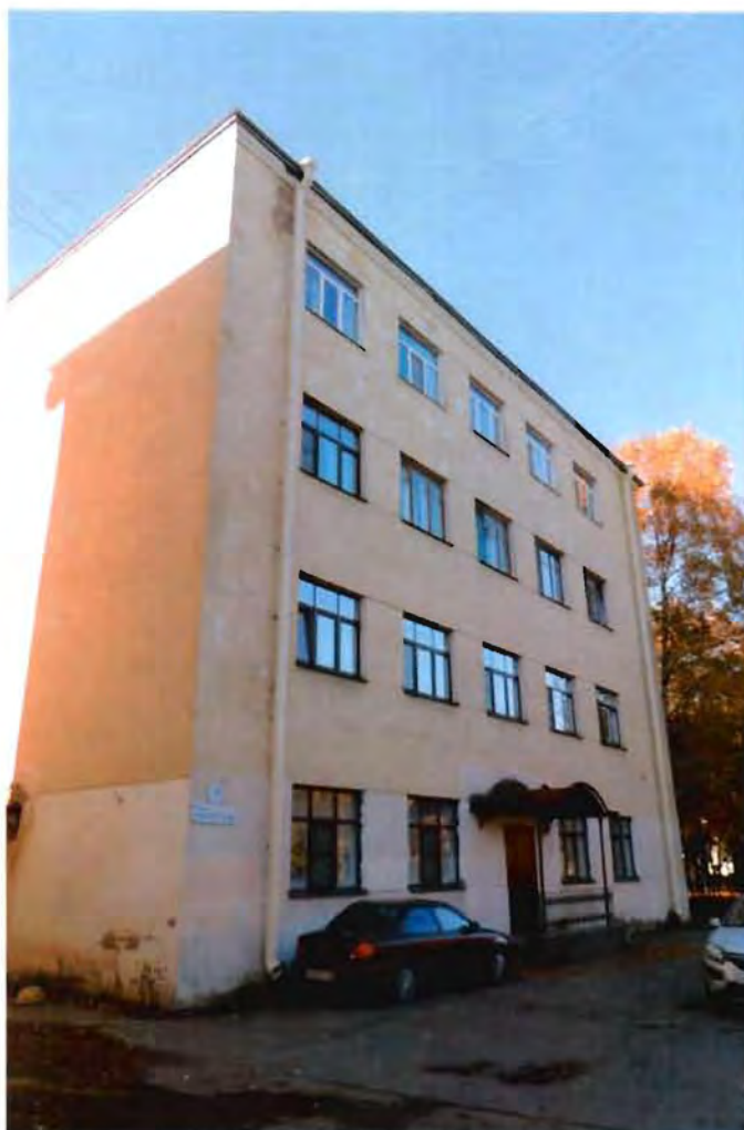
4. Торцевой северный корпус.
