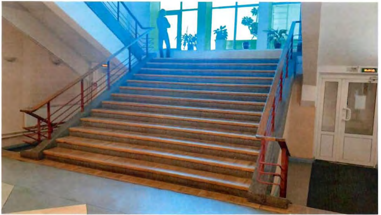
6. Распашная лестница в главном корпусе (пом. 10-Н(2)).
