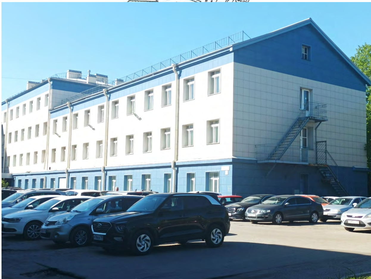
17. Объект культурного наследия регионального значения «Здание Института инженеров Гражданского воздушного флота». Вид объекта с юго-востока. Фрагмент фасада. Дата съемки: 02.05.2024г.
