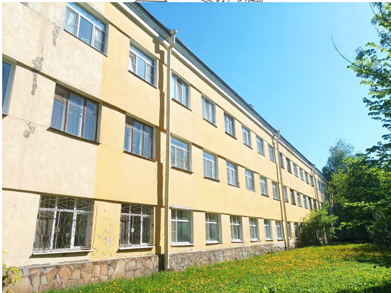
5. Объект культурного наследия регионального значения «Здание Института инженеров Гражданского воздушного флота». Вид объекта с севера. Фрагмент фасада. Дата съемки: 02.05.2024г.
