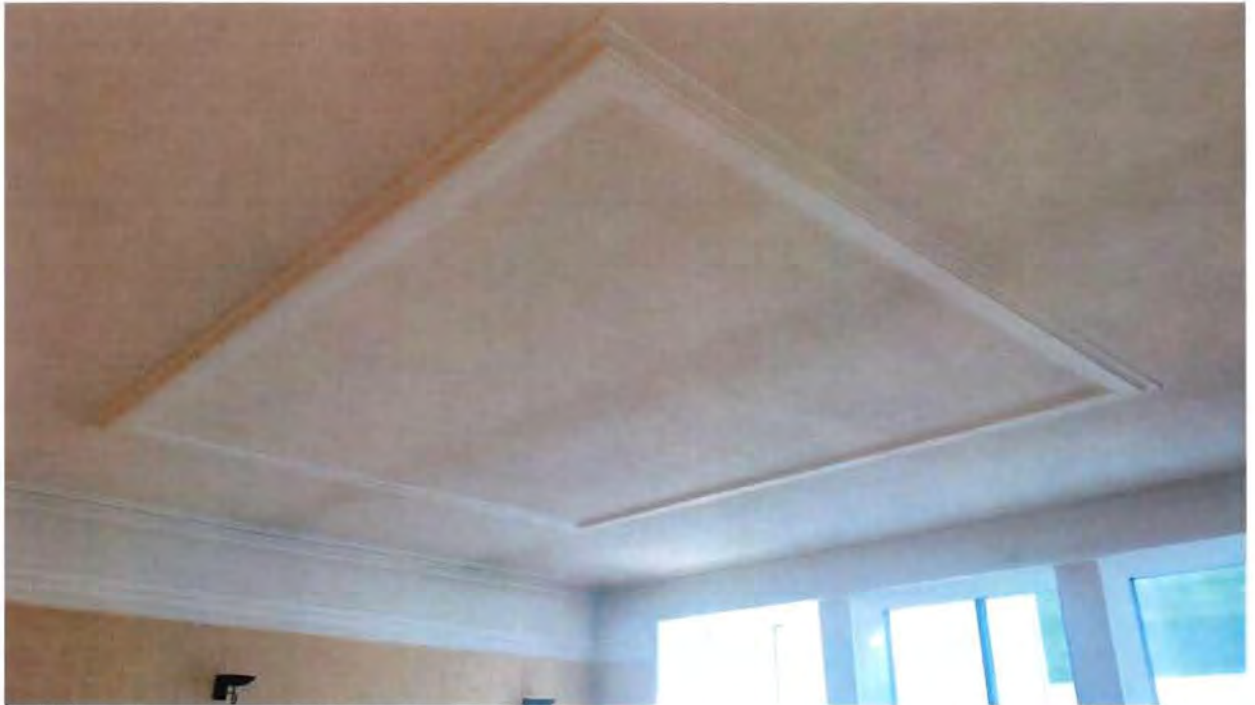
7. Профилированные тяги в оформлении потолка лестничной клетки (пом. 10-Н (67)).
