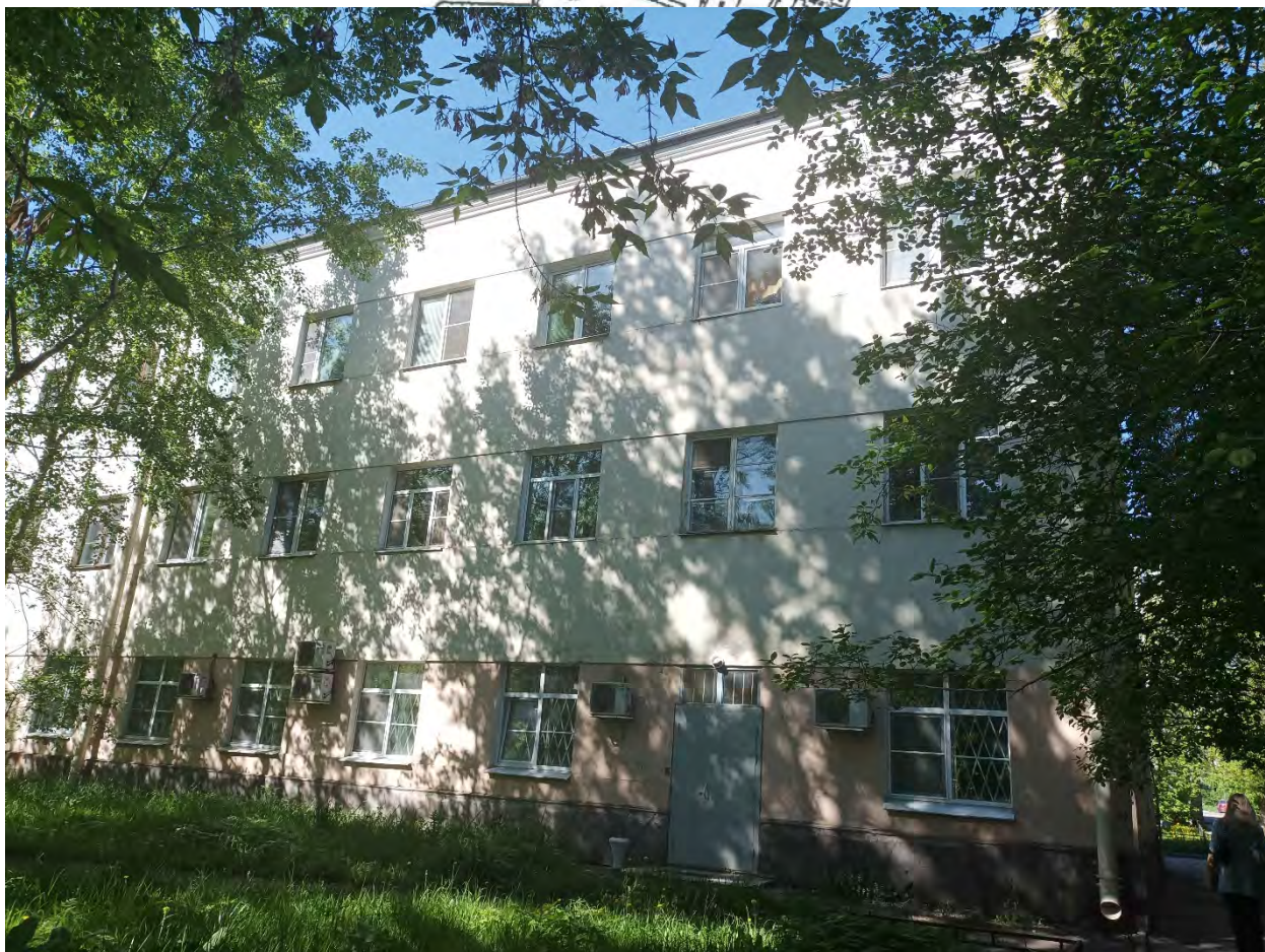
12. Объект культурного наследия регионального значения «Здание Института инженеров Гражданского воздушного флота». Вид объекта с юга. Фрагмент фасада. Дата съемки: 02.05.2024г.
