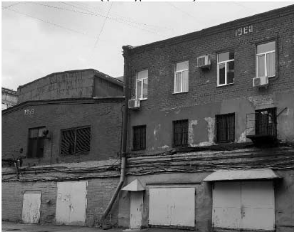
Рис. 34. Фотофиксация построек, расположенных на участке обследования с выложенными на фасаде датами постройки «1959», «1960». Фото 2024 г. Вид на север.
