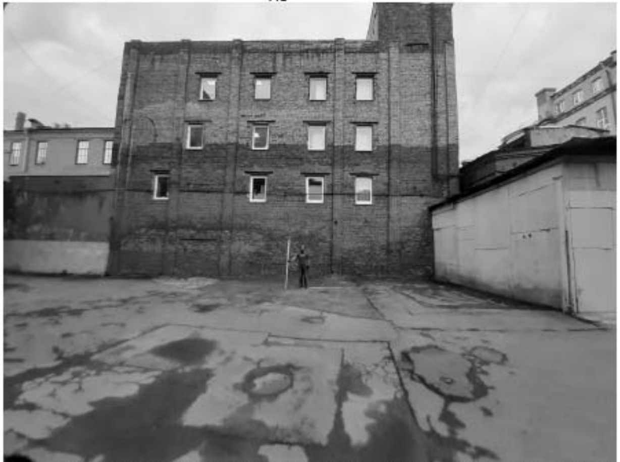
Рис. 48. Санкт-Петербург, Центральный р-н, ул. Новгородская, д. 14, литера А. Общий вид участка. Точка съемки 8. Вид на юго-запад.
