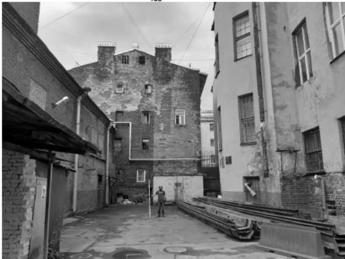
Рис. 44. Санкт-Петербург, Центральный р-н, ул. Новгородская, д. 14, литера А. Общий вид участка. Точка съемки 4. Вид на юго-запад.
