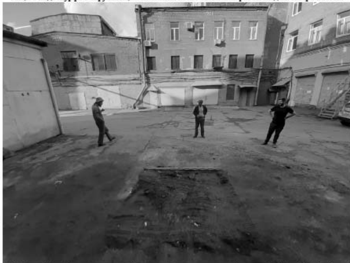
Рис. 72. Санкт-Петербург, Центральный р-н, ул. Новгородская, д. 14, литера А. Шурф 1. Фотофиксация после рекультивации вид на северо-восток.
