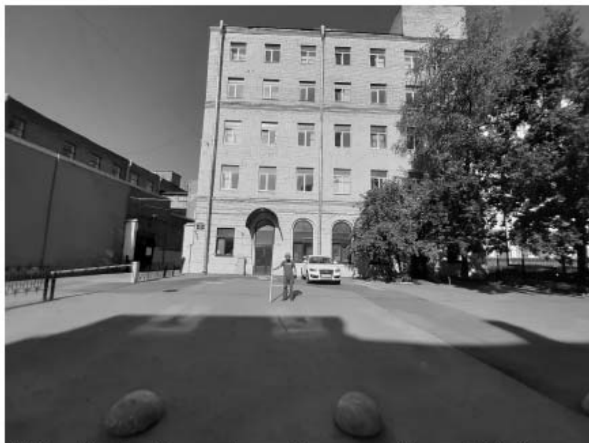
Рис. 51. Санкт-Петербург, Центральный р-н, ул. Новгородская, д. 14, литера А. Общий вид участка. Точка съемки 10. Вид на северо-запад.
