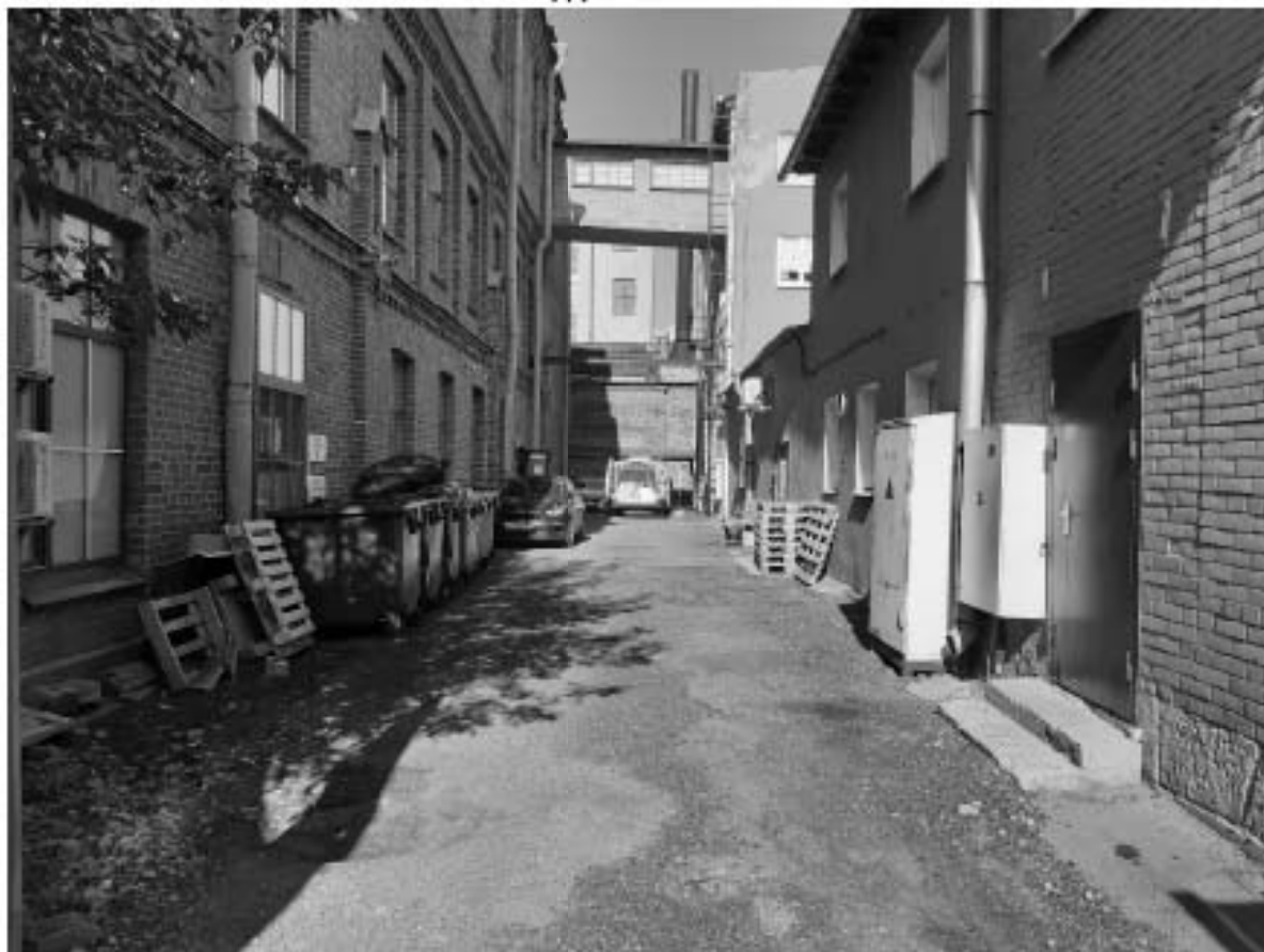
Рис. 50. Санкт-Петербург, Центральный р-н, ул. Новгородская, д. 14, литера А. Общий вид участка. Точка съемки 9. Вид на северо-запад.
