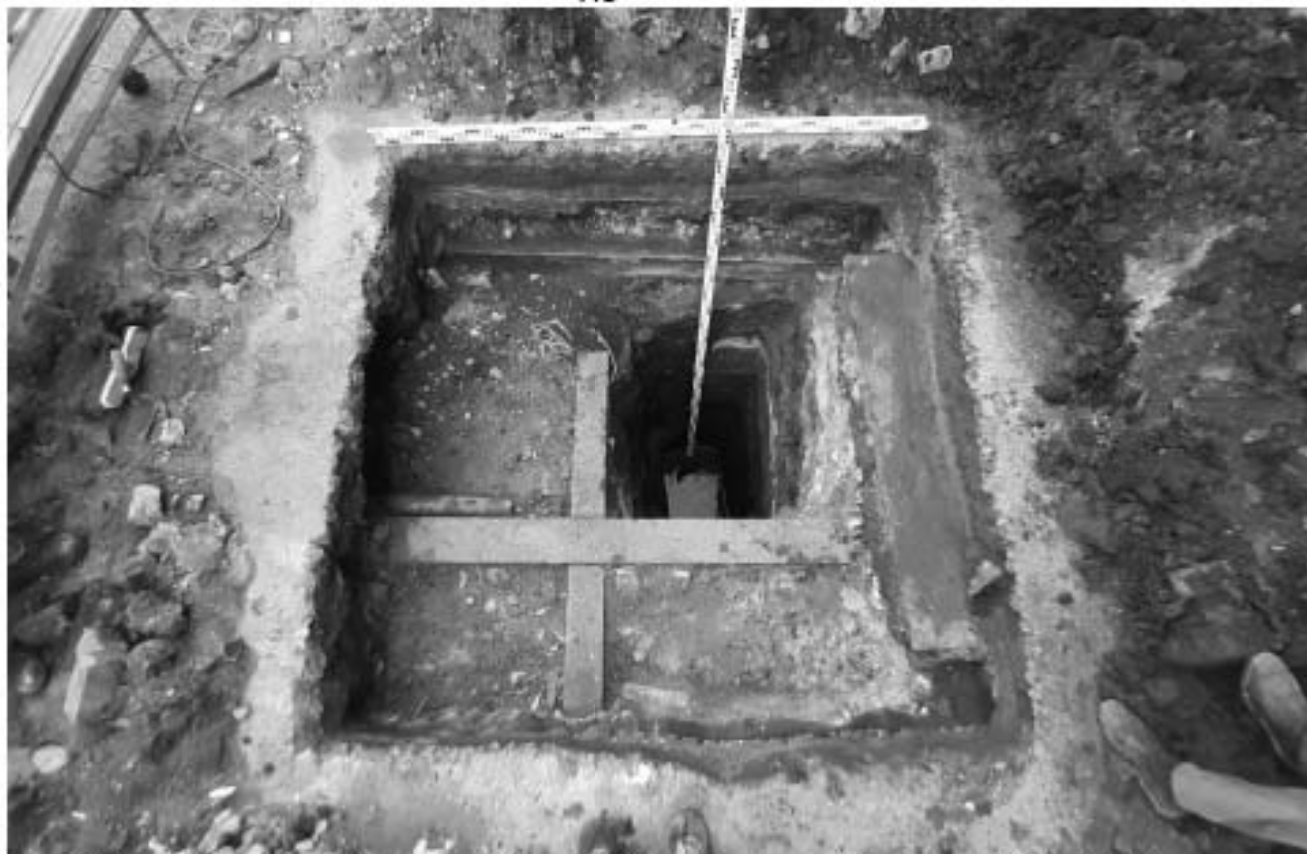
Рис. 60. Санкт-Петербург, Центральный р-н, ул. Новгородская, д. 14, литера А. Шурф 1. Фотофиксация по матерiku (светло-серой супеси), затопленному грунтовыми фодами. Вид на северо-восток.
