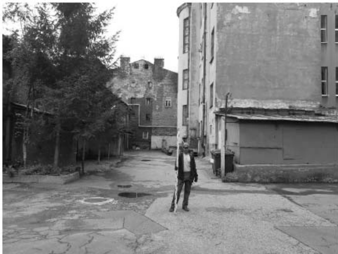
Рис. 41. Санкт-Петербург, Центральный р-н, ул. Новгородская, д. 14, литера А. Общий вид участка. Точка съемки 1. Вид на юго-запад.
