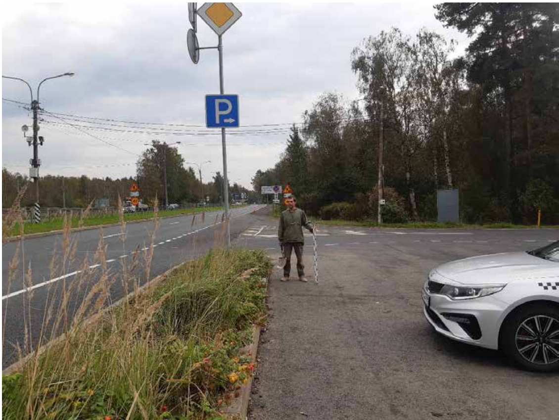
Рис. 19. Санкт-Петербург, Курортный район, Реконструкция Вокзальной ул. в пос. Солнечное. Общий вид трассы. Точка съемки 1. Вид на юго-восток.
