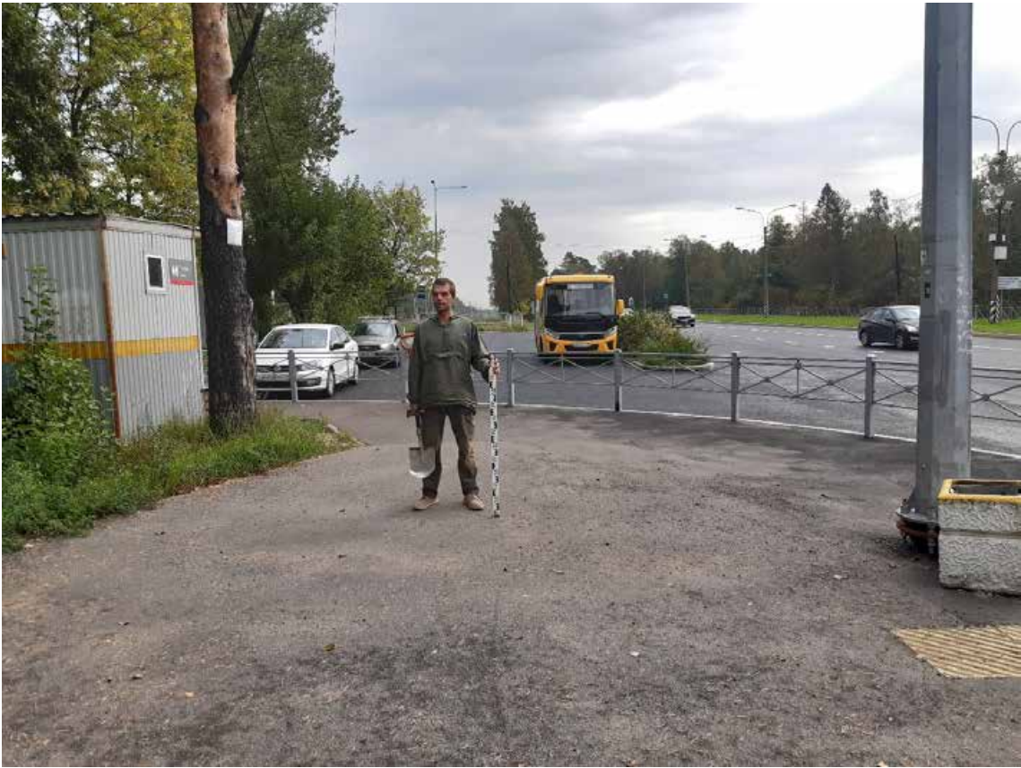
Рис. 20. Санкт-Петербург, Курортный район, Реконструкция Вокзальной ул. в пос. Солнечное. Общий вид трассы. Точка съемки 2. Вид на юго-восток.
