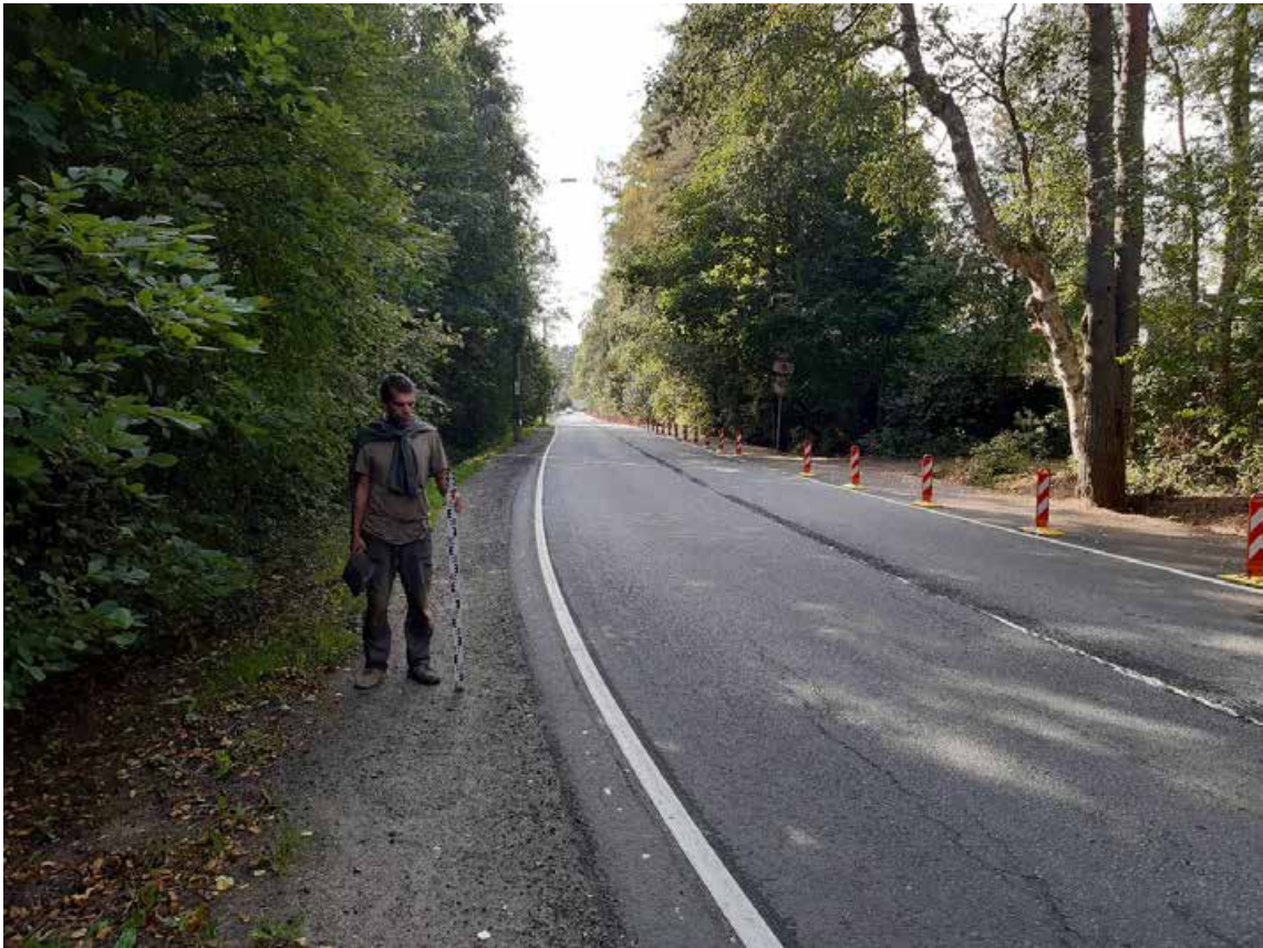
Рис. 34. Санкт-Петербург, Курортный район, Реконструкция Вокзальной ул. в пос. Солнечное. Общий вид трассы. Точка съемки 12. Вид на запад-юго-запад.
