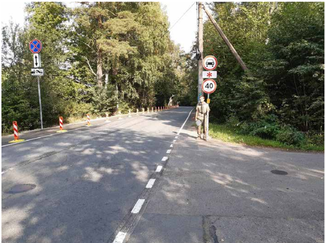
Рис. 35. Санкт-Петербург, Курортный район, Реконструкция Вокзальной ул. в пос. Солнечное. Общий вид трассы. Точка съемки 13. Вид на восток-северо-восток.
