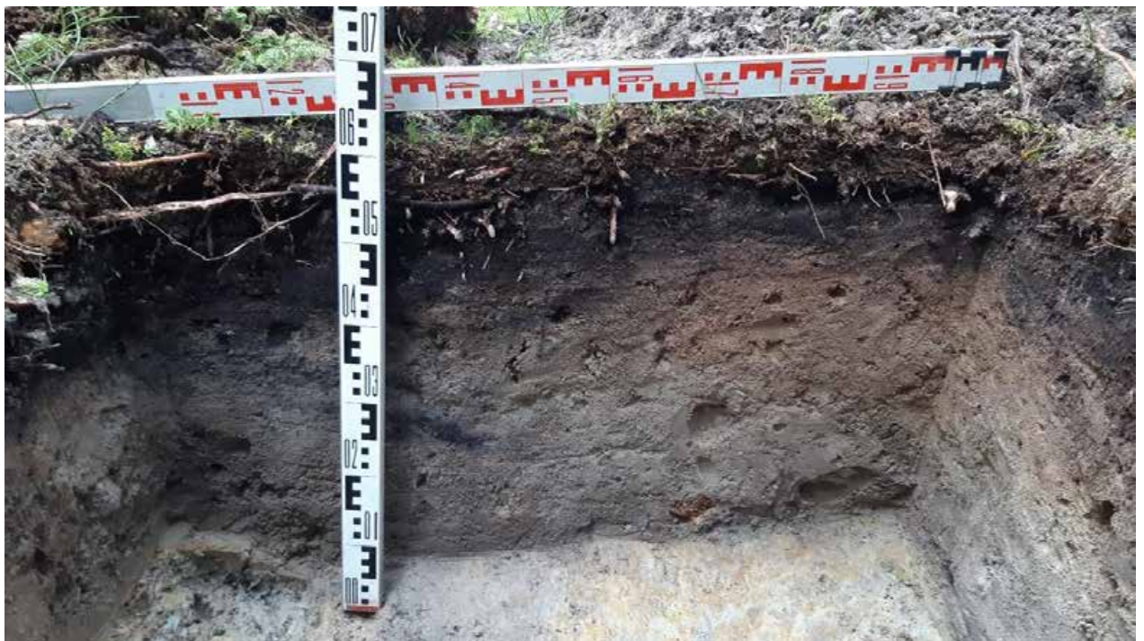
Рис. 69. Санкт-Петербург, Курортный район, Реконструкция Вокзальной ул. в пос. Солнечное. Шурф 4. Фотофиксация стратиграфии западной стенки.
