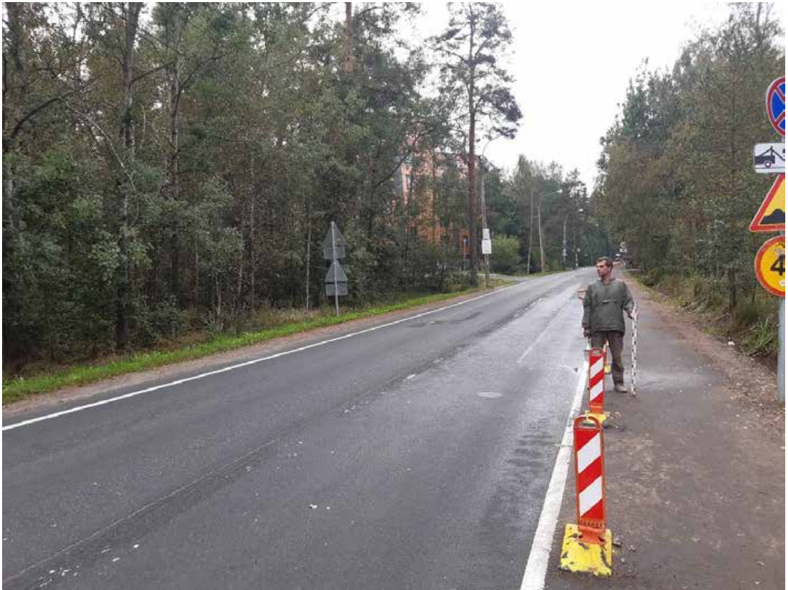
Рис. 22. Санкт-Петербург, Курортный район, Реконструкция Вокзальной ул. в пос. Солнечное. Общий вид трассы. Точка съемки 3. Вид на юго-запад.
