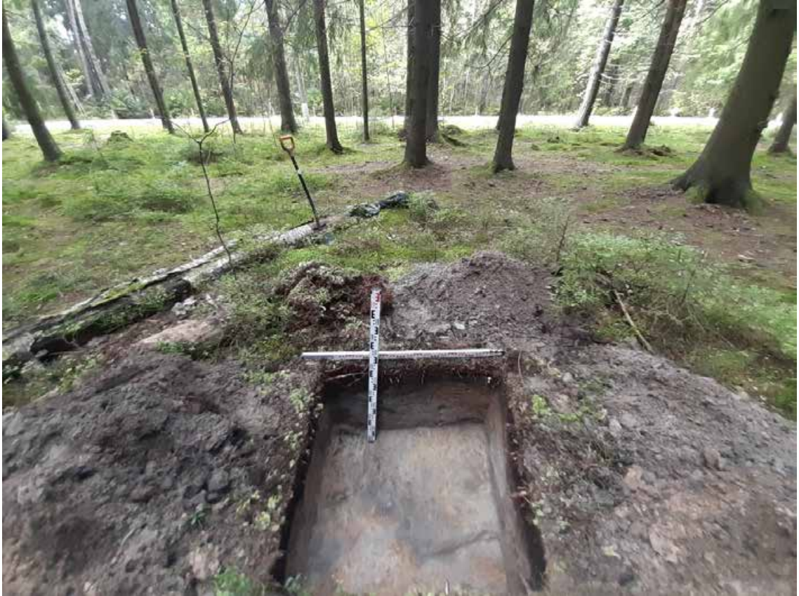
Рис. 70. Санкт-Петербург, Курортный район, Реконструкция Вокзальной ул. в пос. Солнечное. Шурф 4. Фотофиксация с окружающим пейзажем. Вид на запад.
