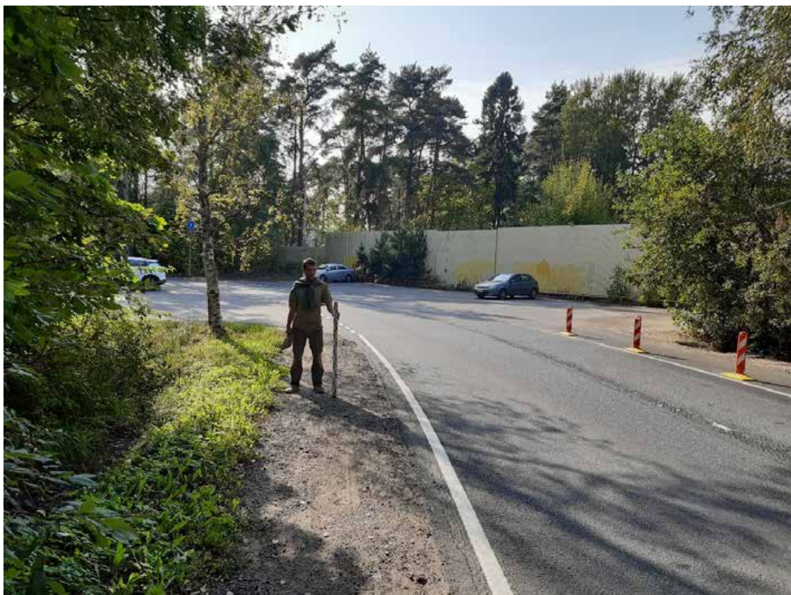
Рис. 37. Санкт-Петербург, Курортный район, Реконструкция Вокзальной ул. в пос. Солнечное. Общий вид трассы. Точка съемки 15. Вид на запад-юго-запад.
