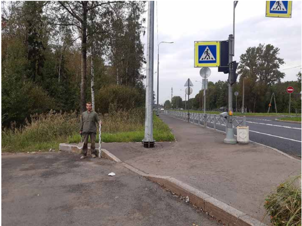
Рис. 16. Санкт-Петербург, Курортный район, Реконструкция Вокзальной ул. в пос. Солнечное. Общий вид трассы. Точка съемки 1. Вид на северо-запад.
