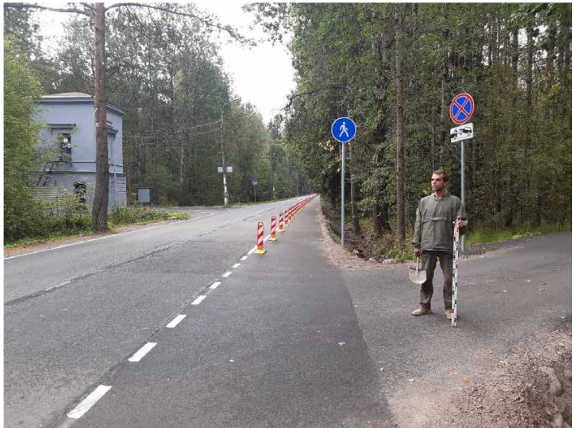
Рис. 23. Санкт-Петербург, Курортный район, Реконструкция Вокзальной ул. в пос. Солнечное. Общий вид трассы. Точка съемки 4. Вид на юго-запад.
