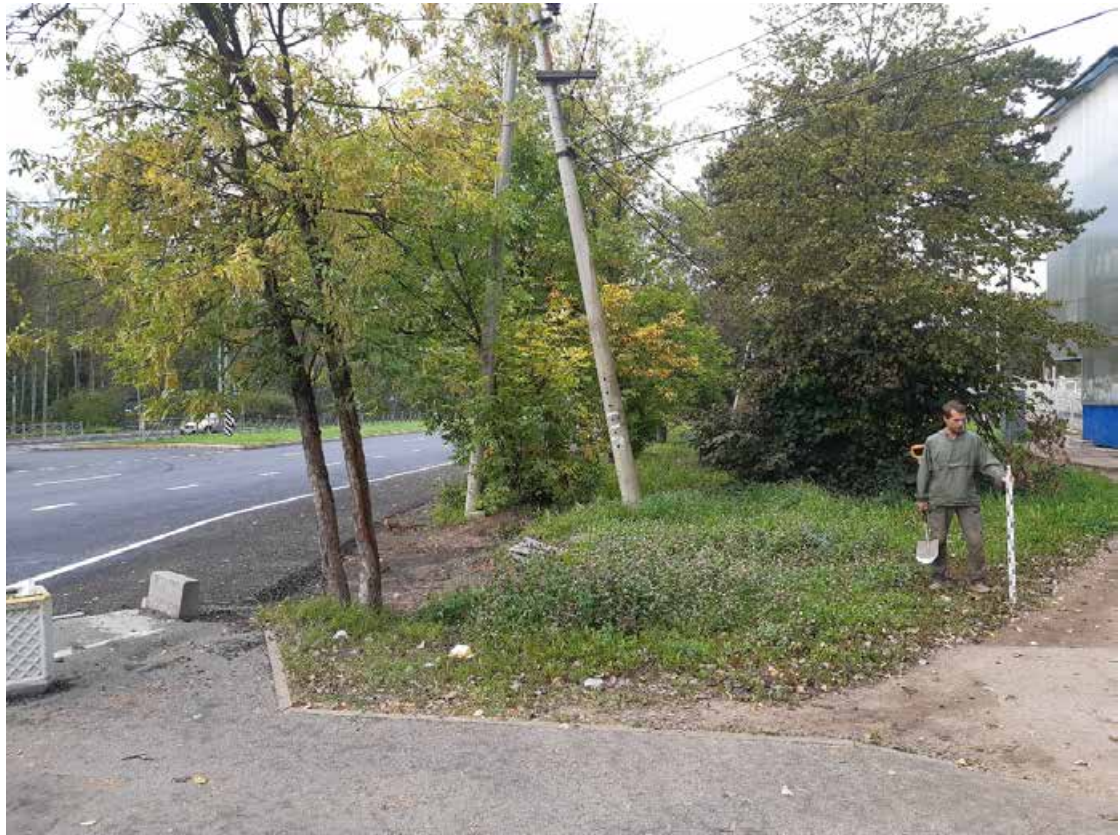
Рис. 21. Санкт-Петербург, Курортный район, Реконструкция Вокзальной ул. в пос. Солнечное. Общий вид трассы. Точка съемки 3. Вид на северо-запад.
