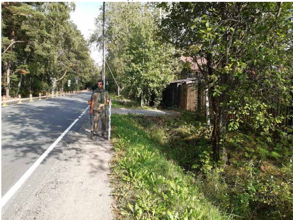
Рис. 36. Санкт-Петербург, Курортный район, Реконструкция Вокзальной ул. в пос. Солнечное. Общий вид трассы. Точка съемки 14. Вид на восток-северо-восток.
