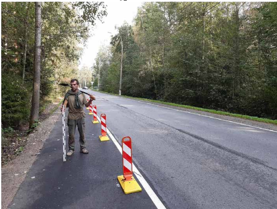
Рис. 26. Санкт-Петербург, Курортный район, Реконструкция Вокзальной ул. в пос. Солнечное. Общий вид трассы. Точка съемки 6. Вид на северо-восток.
