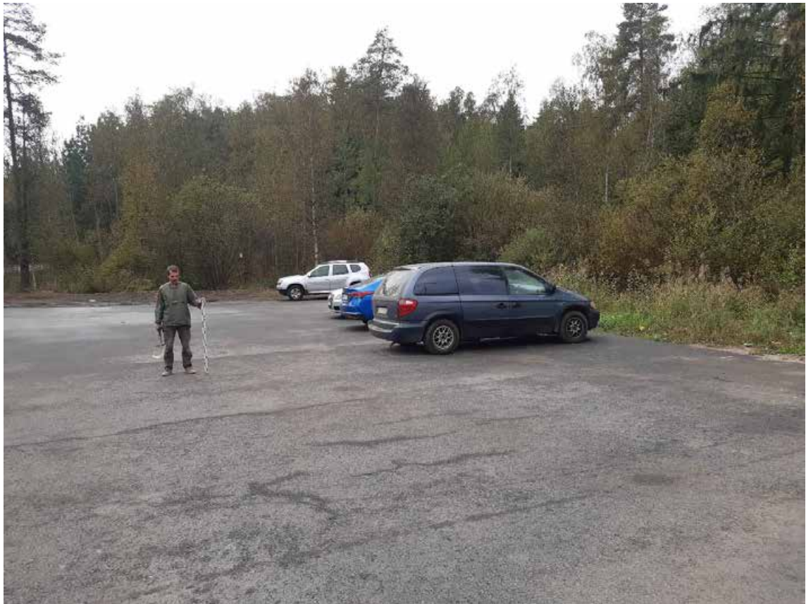
Рис. 17. Санкт-Петербург, Курортный район, Реконструкция Вокзальной ул. в пос. Солнечное. Общий вид трассы. Точка съемки 1. Вид на юго-запад.
