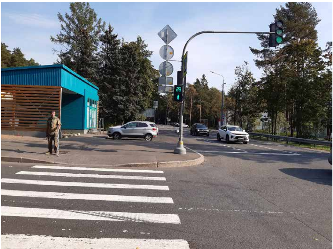
Рис. 41. Санкт-Петербург, Курортный район, Реконструкция Вокзальной ул. в пос. Солнечное. Общий вид трассы. Точка съемки 18. Вид на восток.
