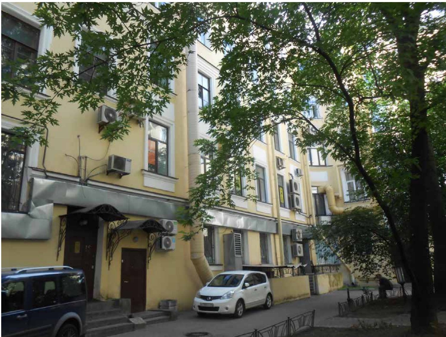
13. «Дом Меншиковых (Русско-Азовского банка)». Санкт-Петербург, Караванная ул., дом 11/64, литера А. Южный дворовый фасад. Фрагмент. Фото: 02.09.2024.
