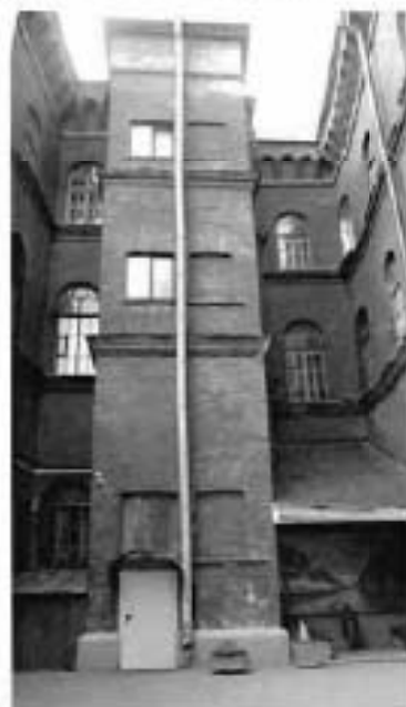
7. Юго-западный дворовой фасад.
