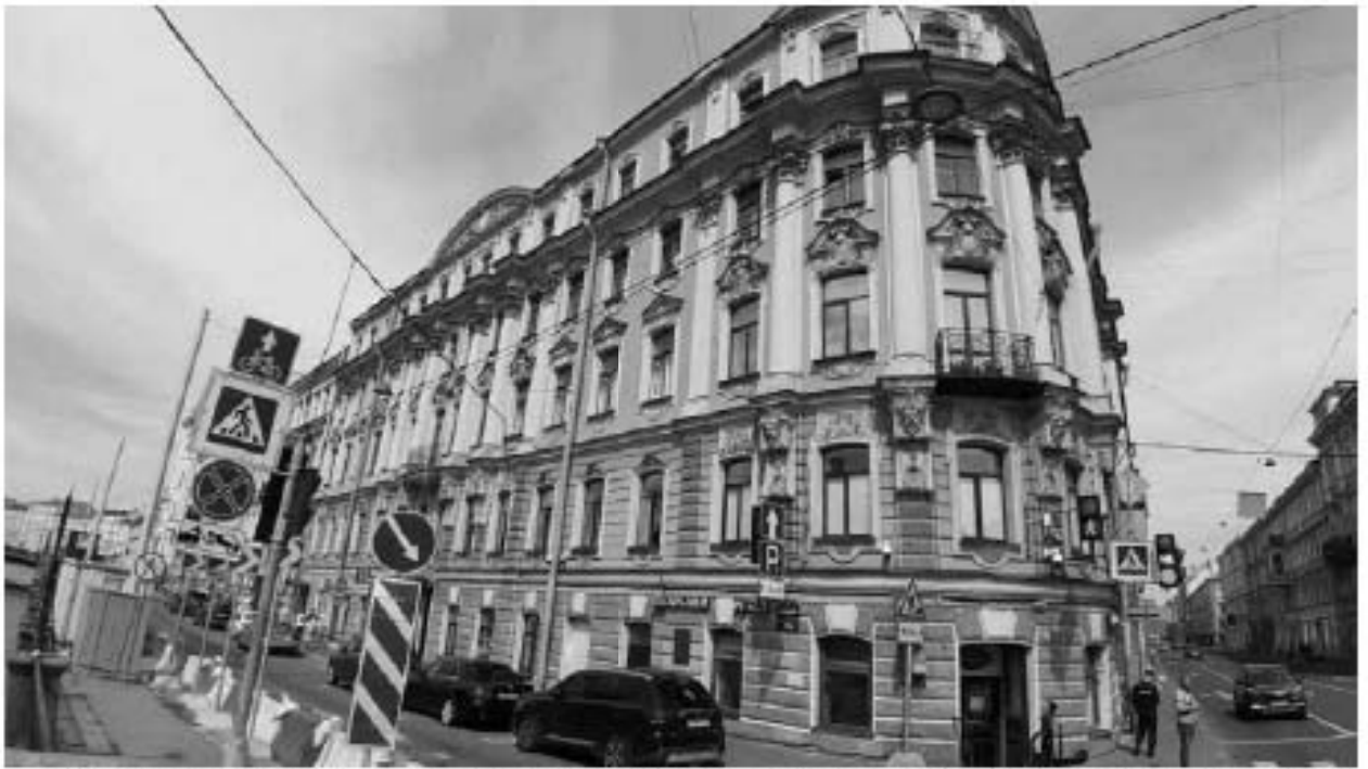
13. Дом С.О. Китнера (наб. канала Грибоедова, д. 79/23, лит. А). Лицевой фасад по наб. канала Грибоедова. Штиглиц М.С. 11.06.2024.
