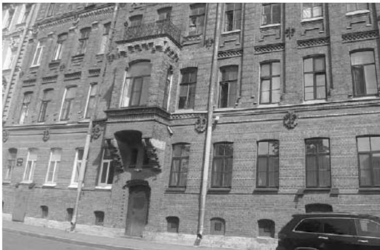
41. Доходный дом (в составе «Дом и фабрика шелковых изделий А.И.Ниссена») (наб. реки Фонтанки, д. 183, лит. А). Фото мест установки оборудования и прокладки кабельных трасс. Лицевой фасад. Штиглиц М.С. 11.06.2024.
