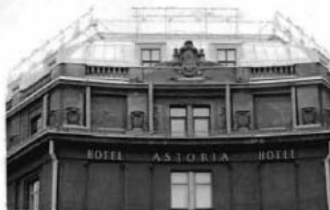
2. Фрагмент юго-западного фасада.
