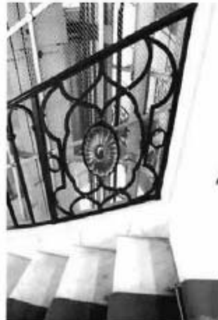
33. Фрагмент перильного ограждения лестницы.
