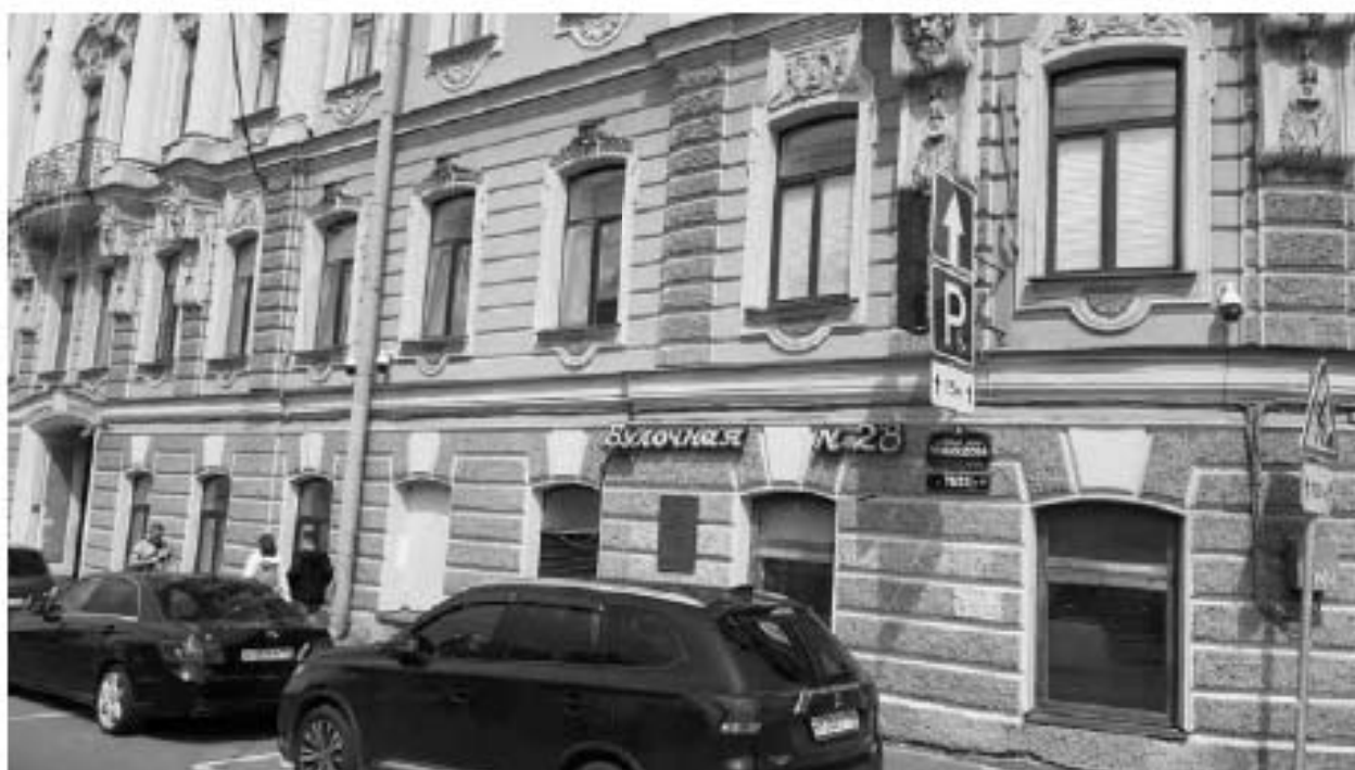
15. Дом С.О. Китнера (наб. канала Грибоедова, д. 79/23, лит. А). Лицевой фасад. Фото мест установки оборудования и прокладки кабельных трасс. Штиглиц М.С. 11.06.2024.
