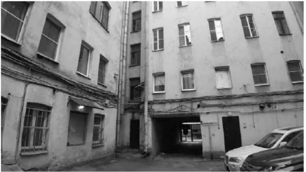
31. Доходные дома Н.И. Львовой (А.Д. Сивкова) (Московский пр., д. 63, лит. А). Дворовый фасад. Фото мест установки оборудования и прокладки кабельных трасс. Штиглиц М.С. 11.06.2024.
