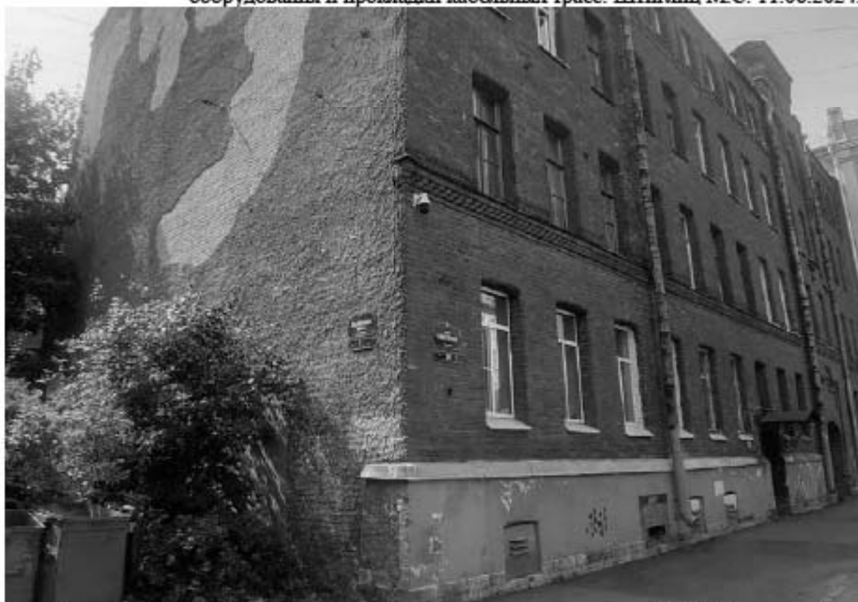
44. Доходный дом (в составе «Дом и фабрика шелковых изделий А.И.Ниссена») (наб. реки Фонтанки, д. 183, лит. А). Лицевой фасад. Фото мест установки оборудования и прокладки кабельных трасс. Штиглиц М.С. 11.06.2024.
