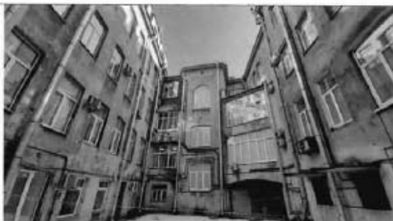
5. Фрагмент дворового фасада
