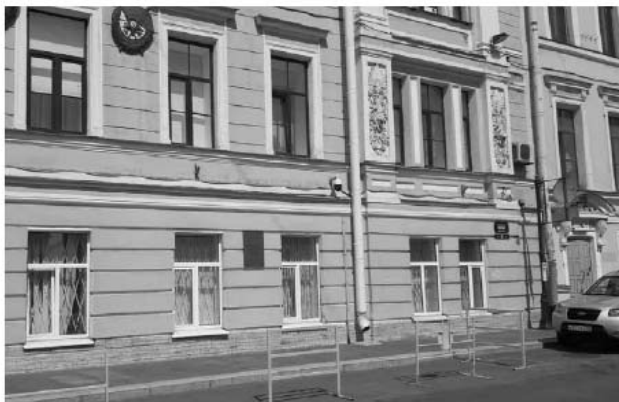
11. Дом Первого Российского страхового общества (Большая Морская ул., д. 40, лит. А). Лицевой фасад. Фото мест установки оборудования и прокладки кабельных трасс. Штиглиц М.С. 11.06.2024.
