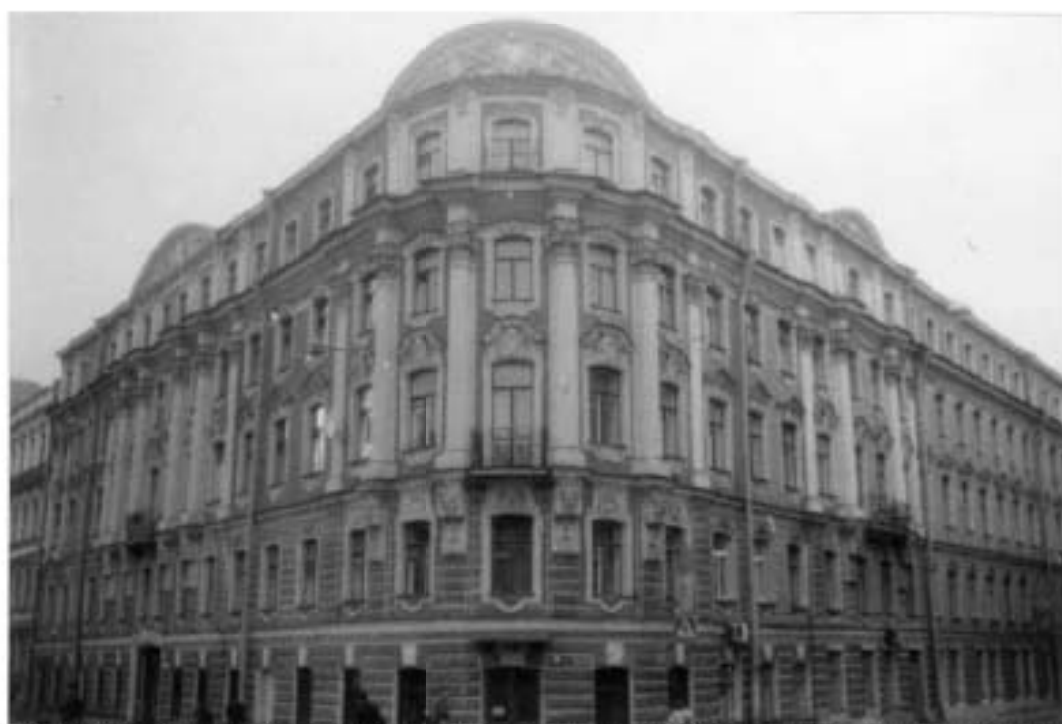
16. Дом С.О. Китнера (наб. канала Грибоедова, д. 79/23, лит. А). Фото 1999 (21).
