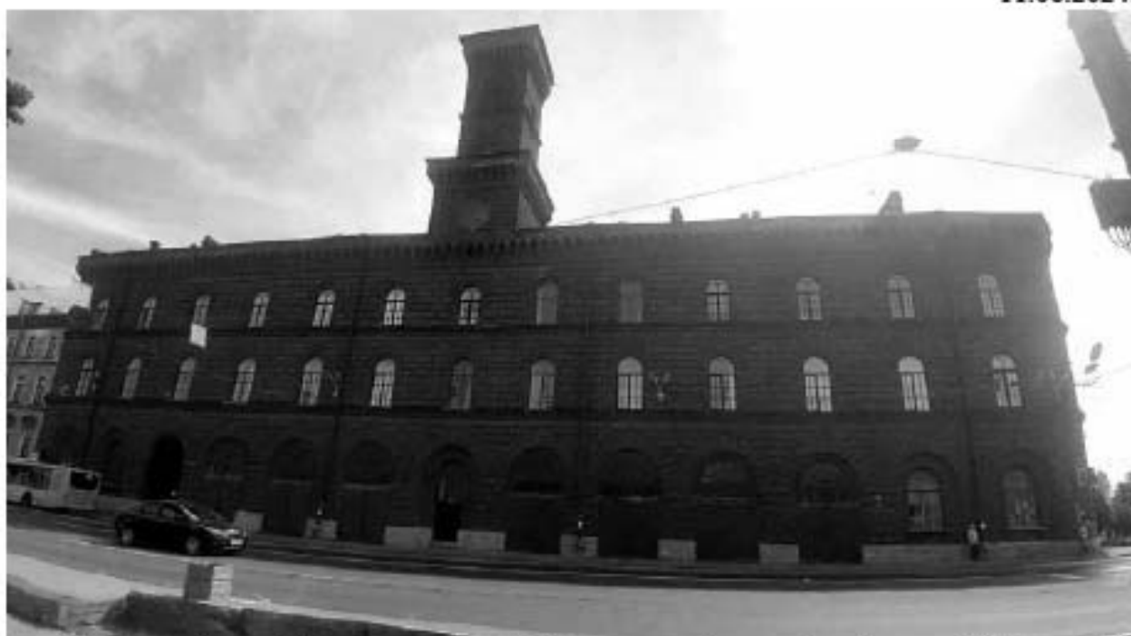
16. Съезжий дом 4-й Адмиралтейской (Коломенской) части (пл. Репина, 1/201, лит. А). Лицевой фасад. Вид с пл. Репина. Штиглиц М.С. 11.06.2024.
