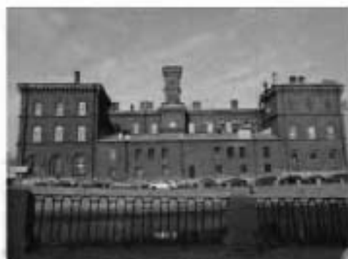
1. Восточный фасад вдоль наб. кан. Грибоедова
