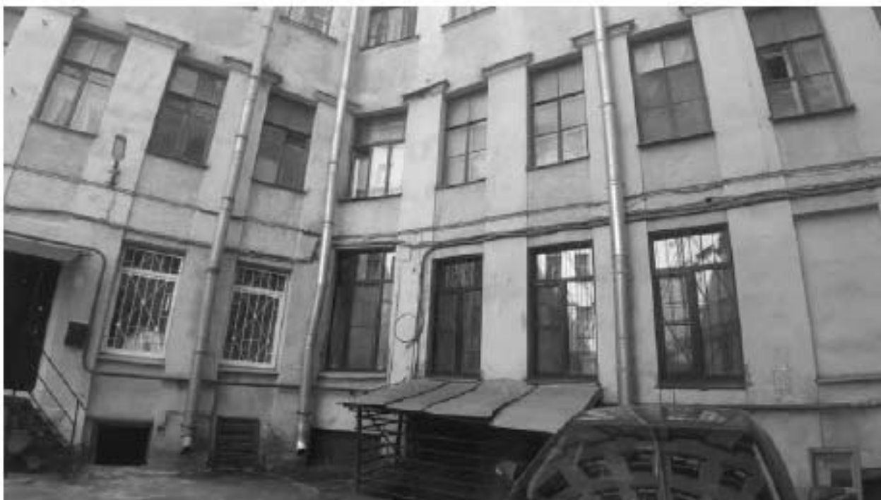
53. Дом С.И. и Б.И.Марголиных (наб. реки Фонтанки, д. 131, лит. А). Дворовый фасад. Штиглиц М.С. 11.06.2024.
