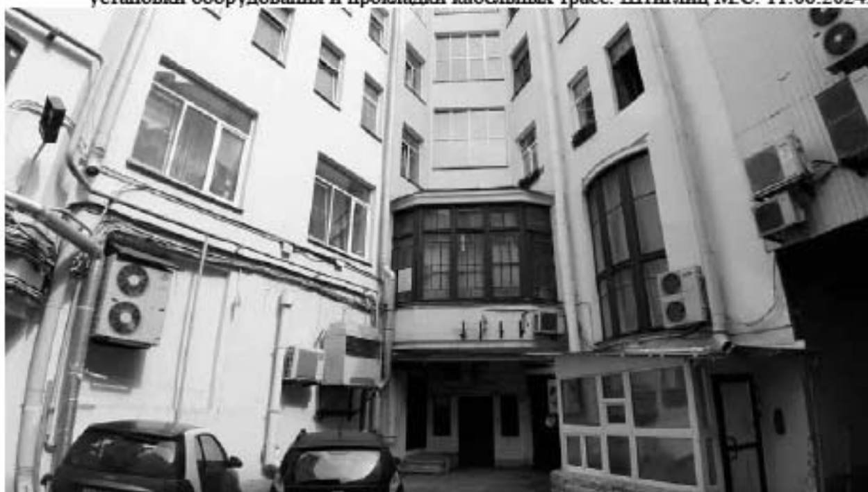
26. Дом Я.И. Перетца (Московский пр., д. 1/2, лит.А). Дворовый фасад. Фото мест установки оборудования и прокладки кабельных трасс. Штиглиц М.С. 11.06.2024.
