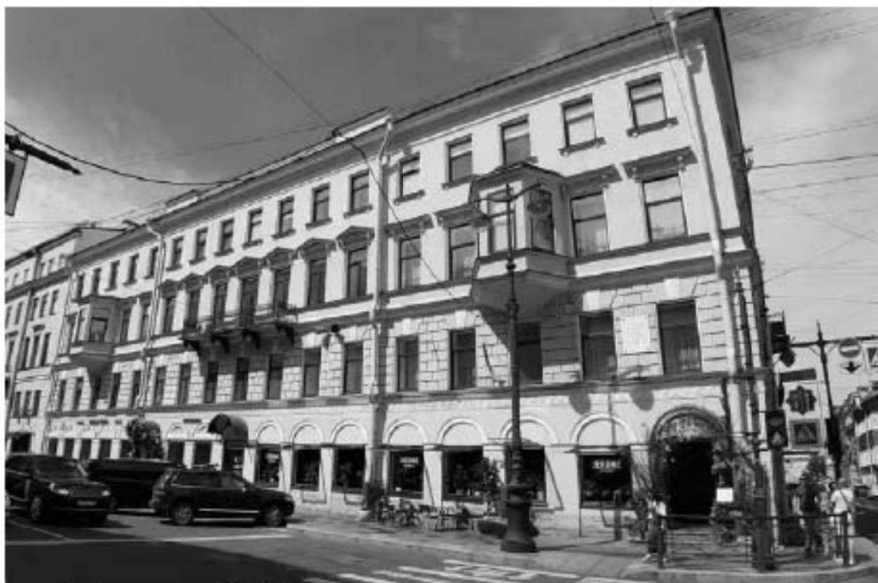
1. Дом, где в 1840-1841 гг. жил писатель и философ Герцен А.И. (Большая Морская ул., д. 25, лит. А). Лицевой фасад по Большой Морской ул. Штиглиц М.С. 11.06.2024.
