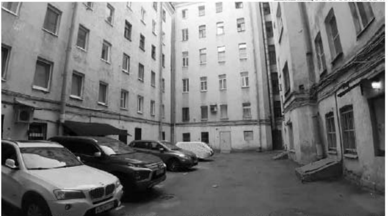
32. Доходные дома Н.И. Львовой (А.Д. Сивкова) (Московский пр., д. 63, лит. А). Дворовый фасад. Фото мест установки оборудования и прокладки кабельных трасс. Штиглиц М.С. 11.06.2024.
