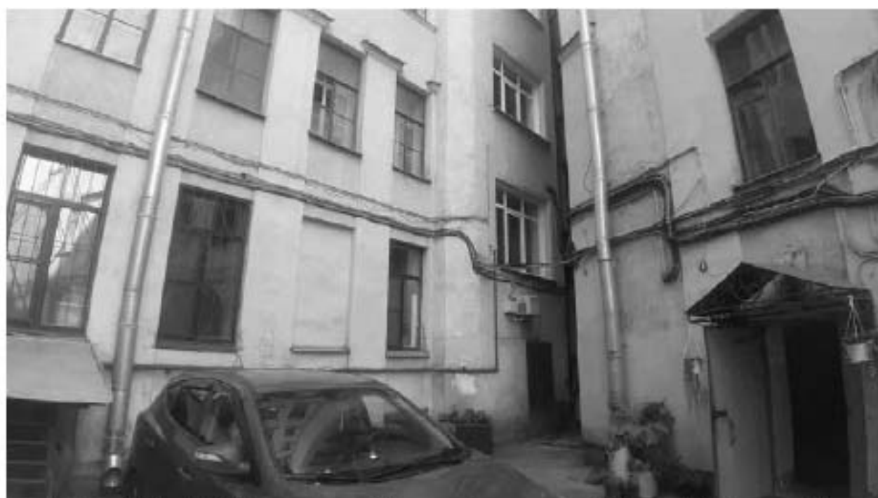
52. Дом С.И. и Б.И.Марголиных (наб. реки Фонтанки, д. 131, лит. А). Дворовый фасад. Штиглиц М.С. 11.06.2024.
