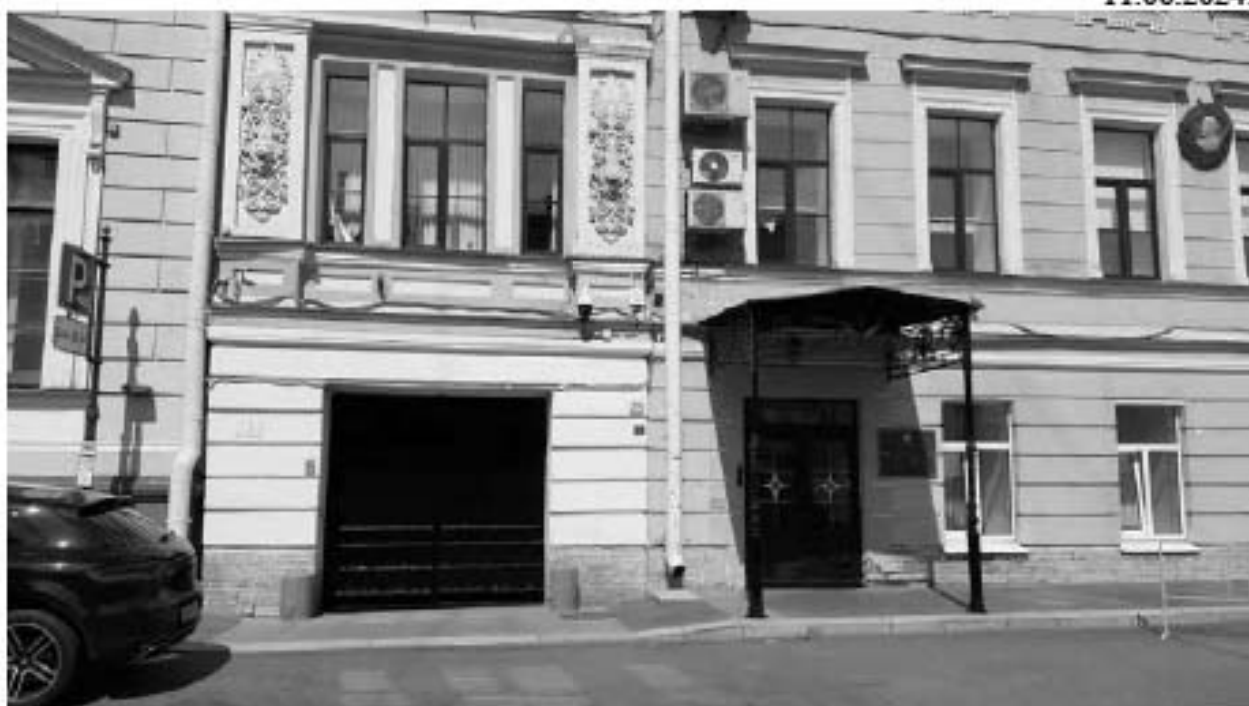
10. Дом Первого Российского страхового общества (Большая Морская ул., д. 40, лит. А). Лицевой фасад. Фото мест установки оборудования и прокладки кабельных трасс. Штиглиц М.С. 11.06.2024.
