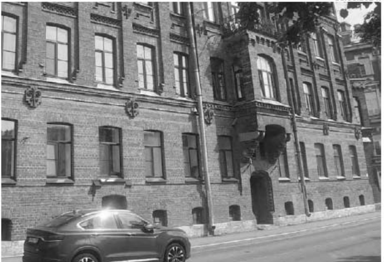
40. Доходный дом (в составе «Дом и фабрика шелковых изделий А.И.Ниссена») (наб. реки Фонтанки, д. 183, лит. А). Лицевой фасад. Фото мест установки оборудования и прокладки кабельных трасс. Штиглиц М.С. 11.06.2024.
