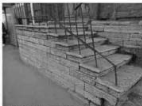
10. Крыльцо со стороны западного фасада.
