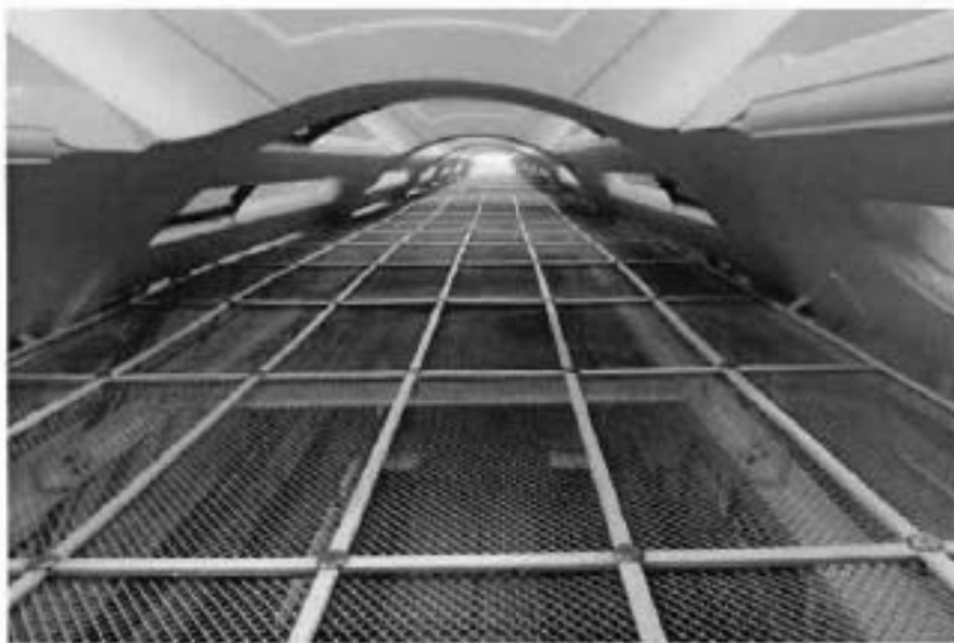
34. Лестничные марши парадной лестницы и шахта лифта. Вид снизу.
