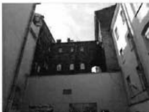
9. Северный фасад здания.
