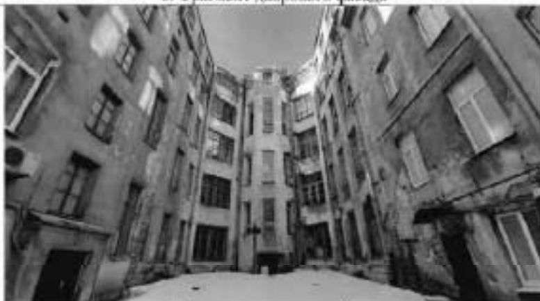
6. Фрагмент дворового фасада
