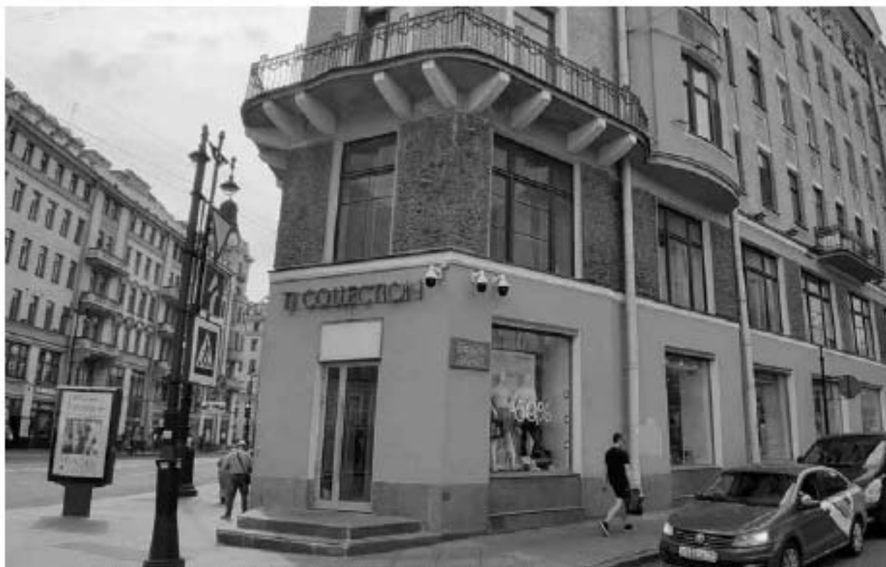
25. Дом Я.И. Перетца (Московский пр., д. 1/2, лит.А). Лицевой фасад. Фото мест установки оборудования и прокладки кабельных трасс. Штиглиц М.С. 11.06.2024.
