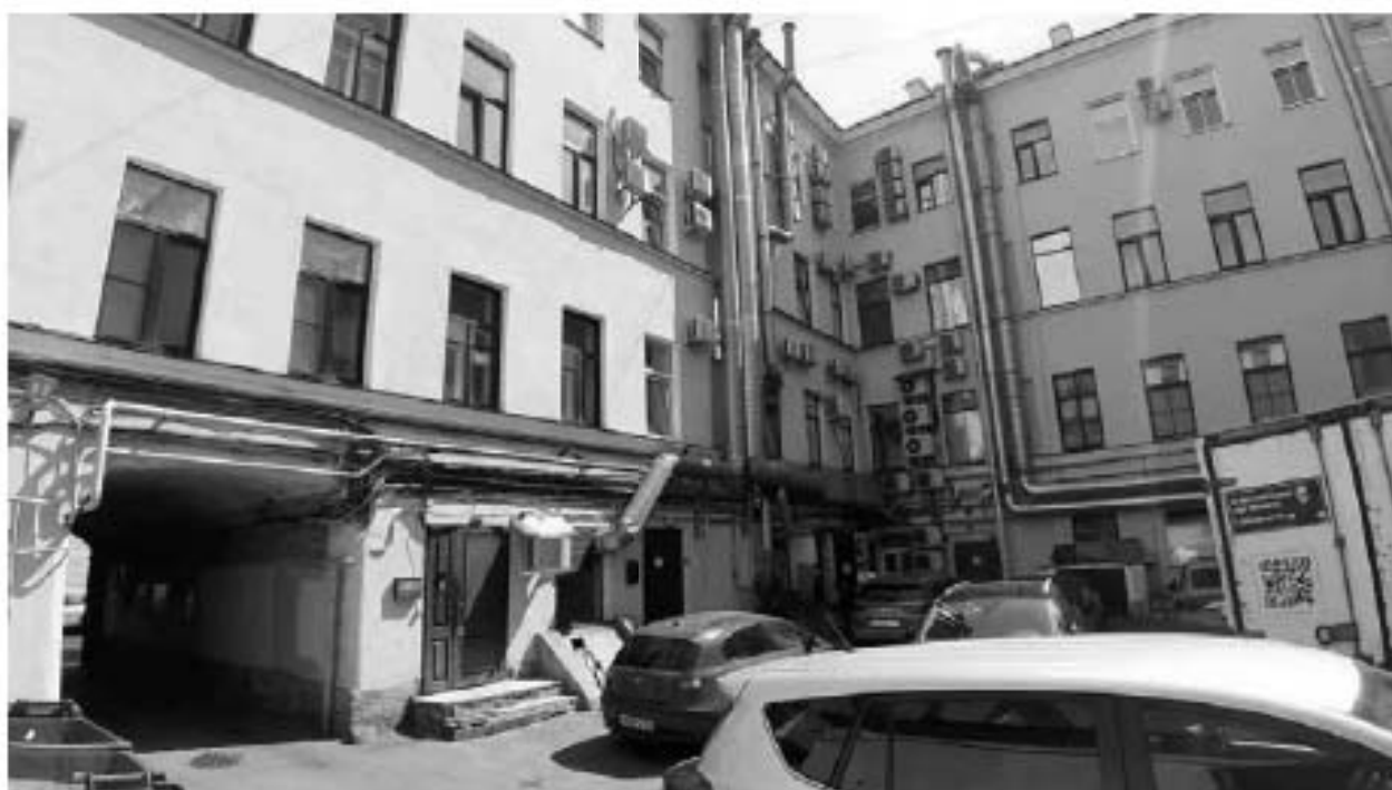
3. Дом, где в 1840-1841 гг. жил писатель и философ Герцен А.И. (Большая Морская ул., д. 25, лит. А). Дворовый фасад. Штиглиц М.С. 11.06.2024.
