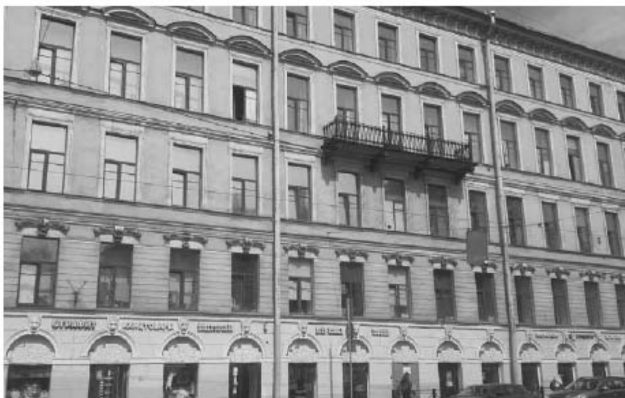
47. Дом Г.Р. Державина (Кукановых) (Садовая, ул., д. 51, лит. А). Лицевой фасад. Фото мест установки оборудования и прокладки кабельных трасс. Штиглиц М.С. 11.06.2024.
