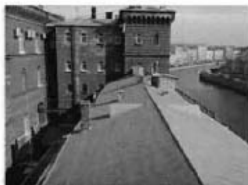
3. Северный дворовой фасад
