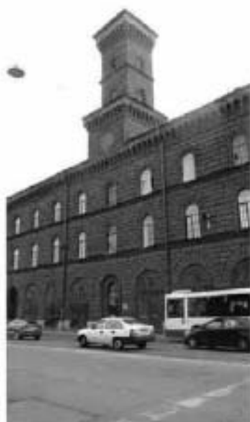
5. Фрагмент западного фасада. Башня-каланча.
