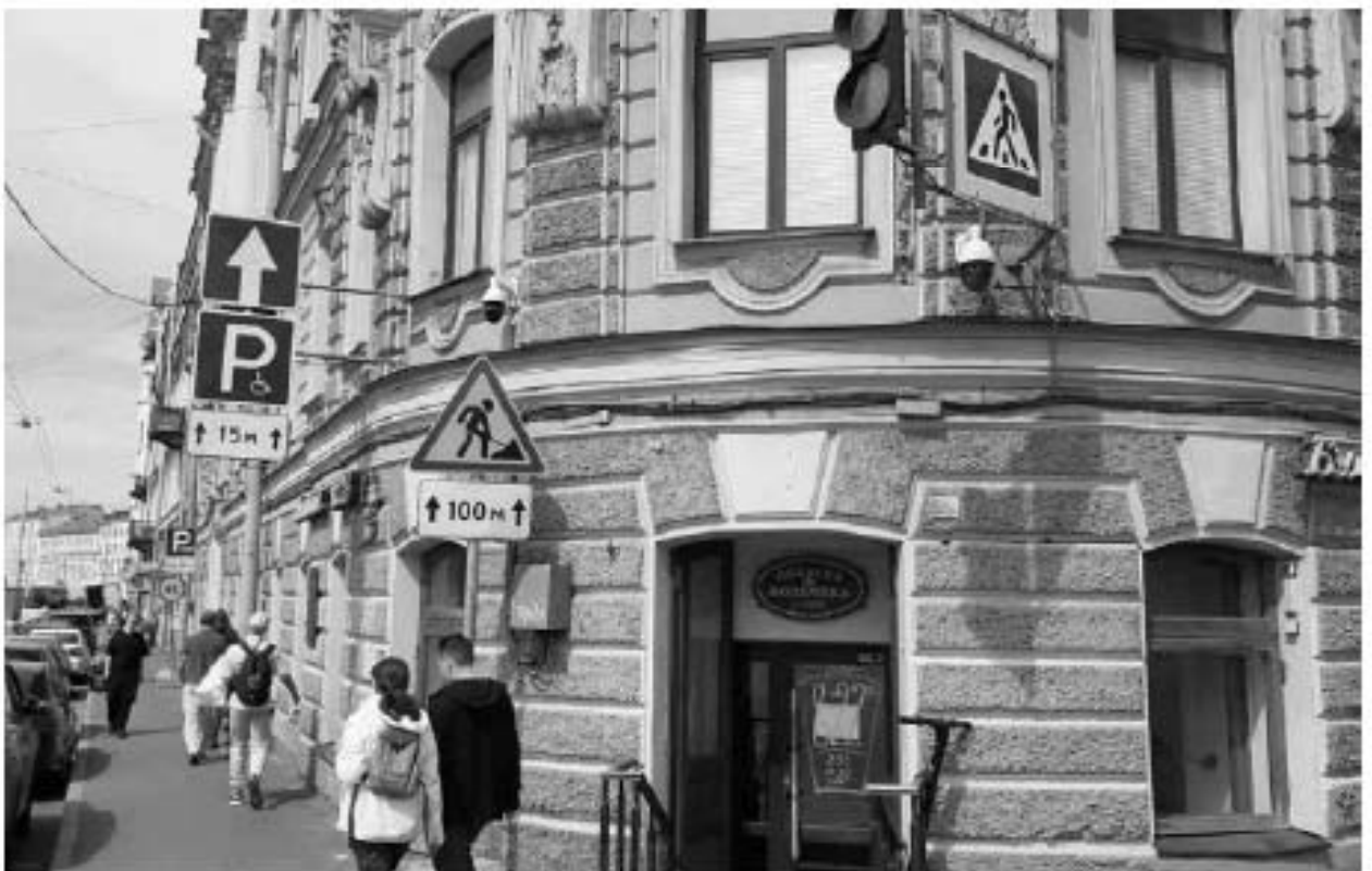
14. Дом С.О. Китнера (наб. канала Грибоедова, д. 79/23, лит. А). Лицевой фасад. Фото мест установки оборудования и прокладки кабельных трасс. Штиглиц М.С. 11.06.2024.
