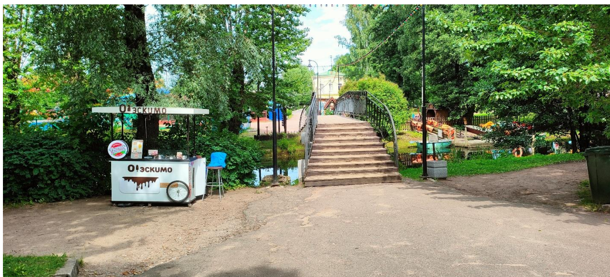
Фото 6. Общий вид на мост через пруд с южной аллеи.
