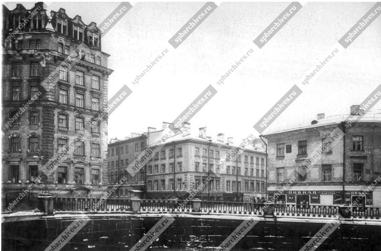
Илл. 42. Фасады домов №104-106 по набережной канала Грибоедова. Фотография до 1926 г. ЦГАКФФД СПб. Гр 65625.
