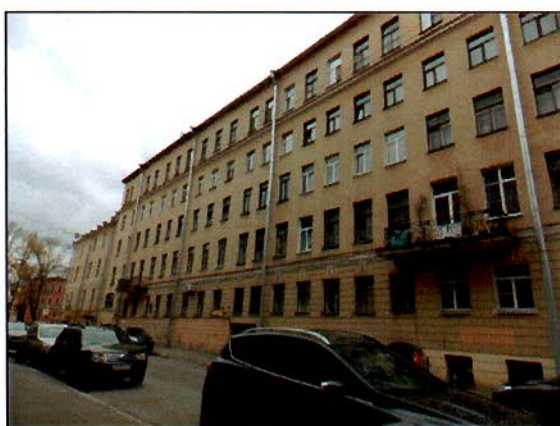
Фото 2. Восточный фасад со стороны ул. Средняя Подъяческая
