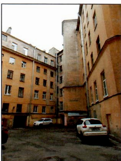
Фото 16. Западный дворовый фасад.
