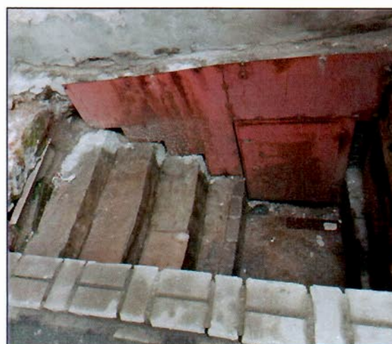
Фото 19. Вход с южного фасада через приямок.
