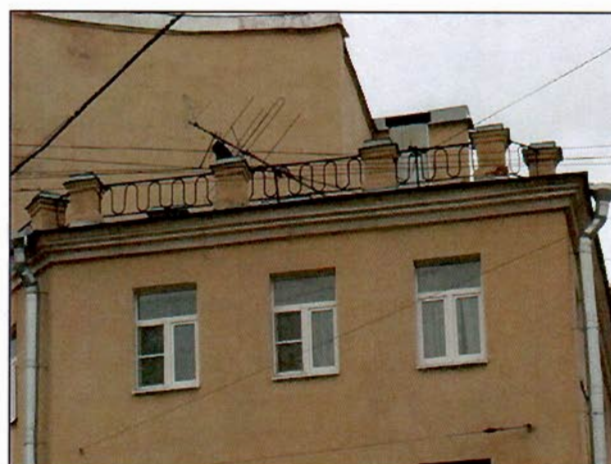
Фото 5. Фрагмент южного фасада.
