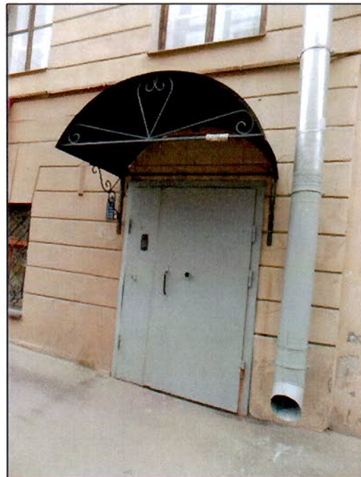
Фото 11. Вход со стороны восточного фасада (лестница).
