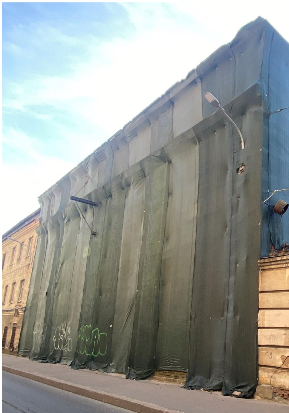
Фото 1. Лицевой фасад «5-1» по Масляному каналу. Общий вид. 30.09.2024
