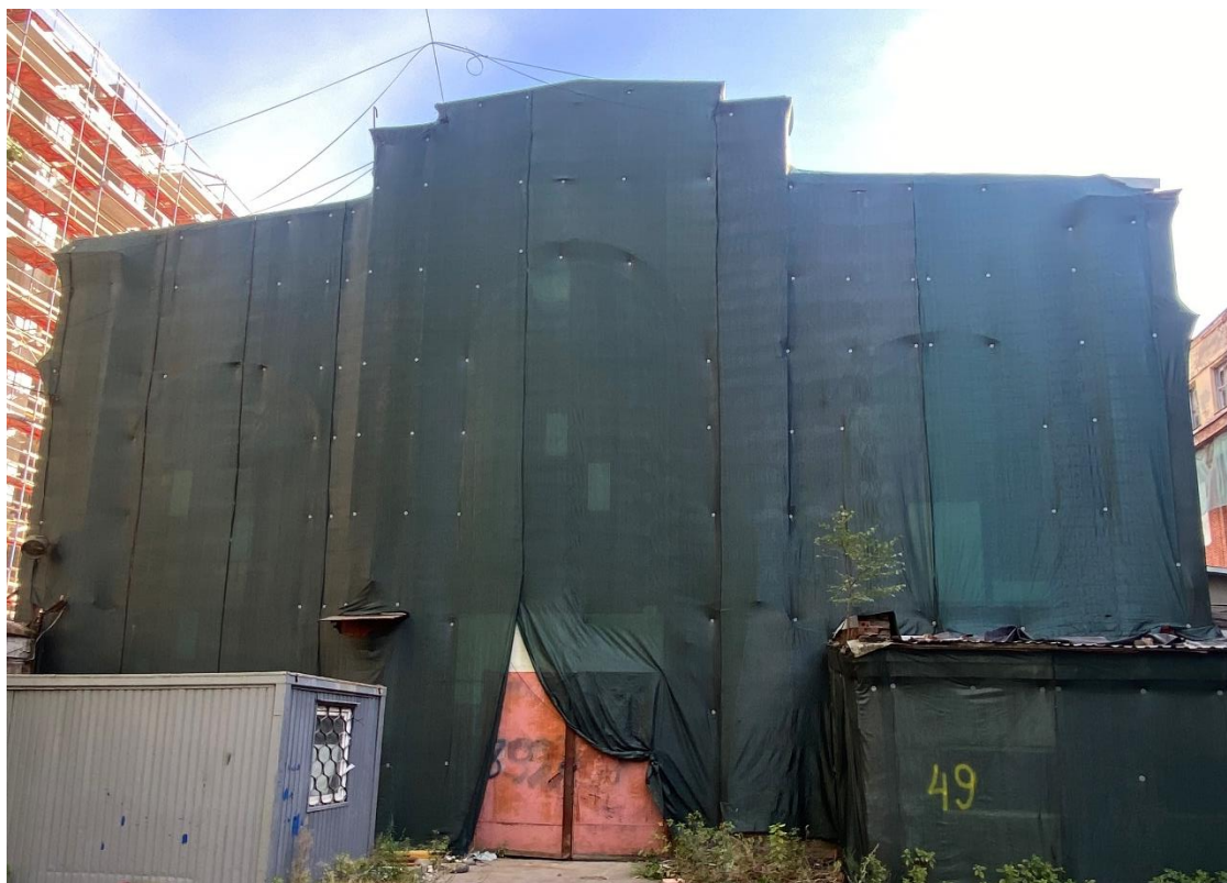
Фото 2. Фасад «Б-А» с торцевой стороны со двора. Общий вид. 30.09.2024
