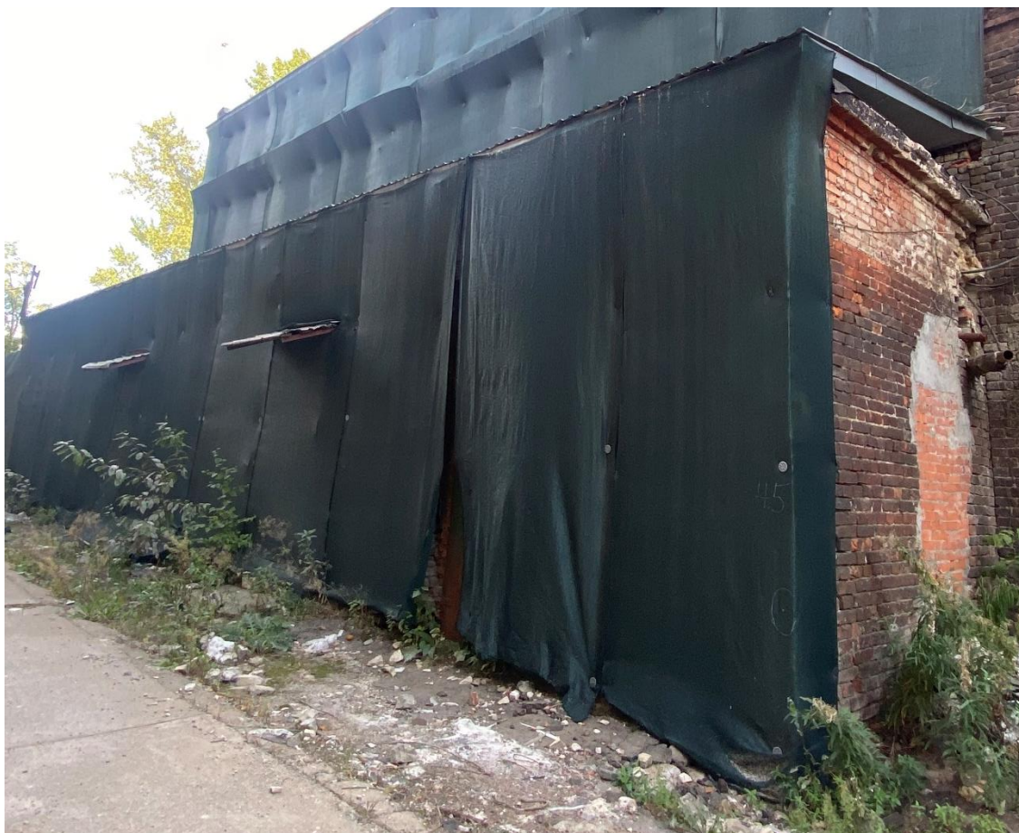
Фото 7. Фасад пристройки со стороны двора. 30.09.2024
