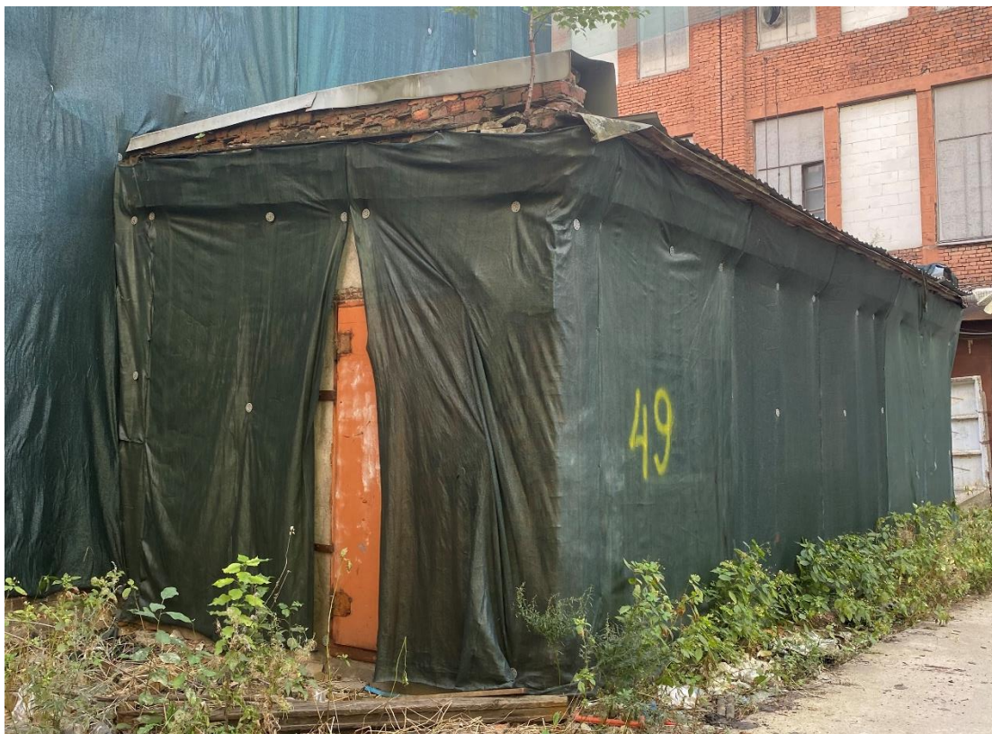
Фото 5. Торцевого фасад пристройки. 30.09.2024
