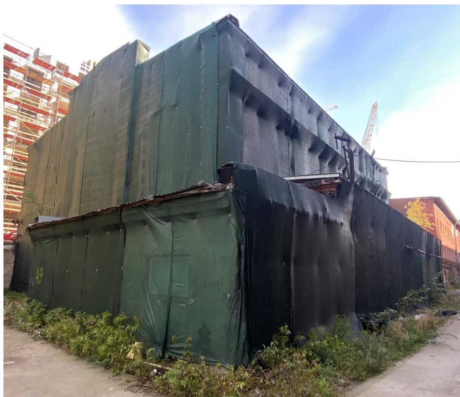
Фото 3. Фасад «1-5» со стороны двора. Общий вид. 30.09.2024
