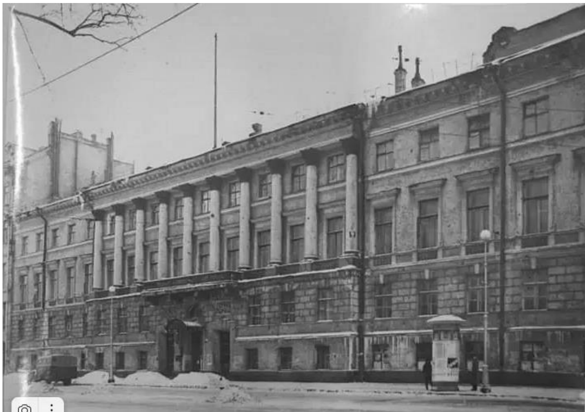
Илл. 13. Здание по Адмиралтейскому пр., 6/ ул. Дзержинского, 2 (ул. Гороховой, 2). Фото (копия) 1946-1949 гг. (ист. ГНИМА ОФ-6196/82 - Госкаталог: 7678883 - http://goskatalog.ru/portal/#/collections?id=7794979 ).
