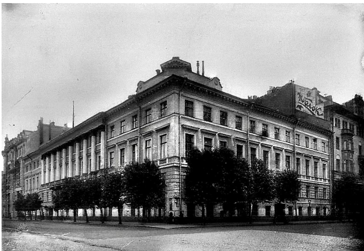
Илл. 12. Здание по Адмиралтейскому пр., 6/ул. Дзержинскаго (Гороховой, 2) - бывш. дом губернских присутственных мест. Фото (копия) 1930-е гг. ЦГАКФФД.
