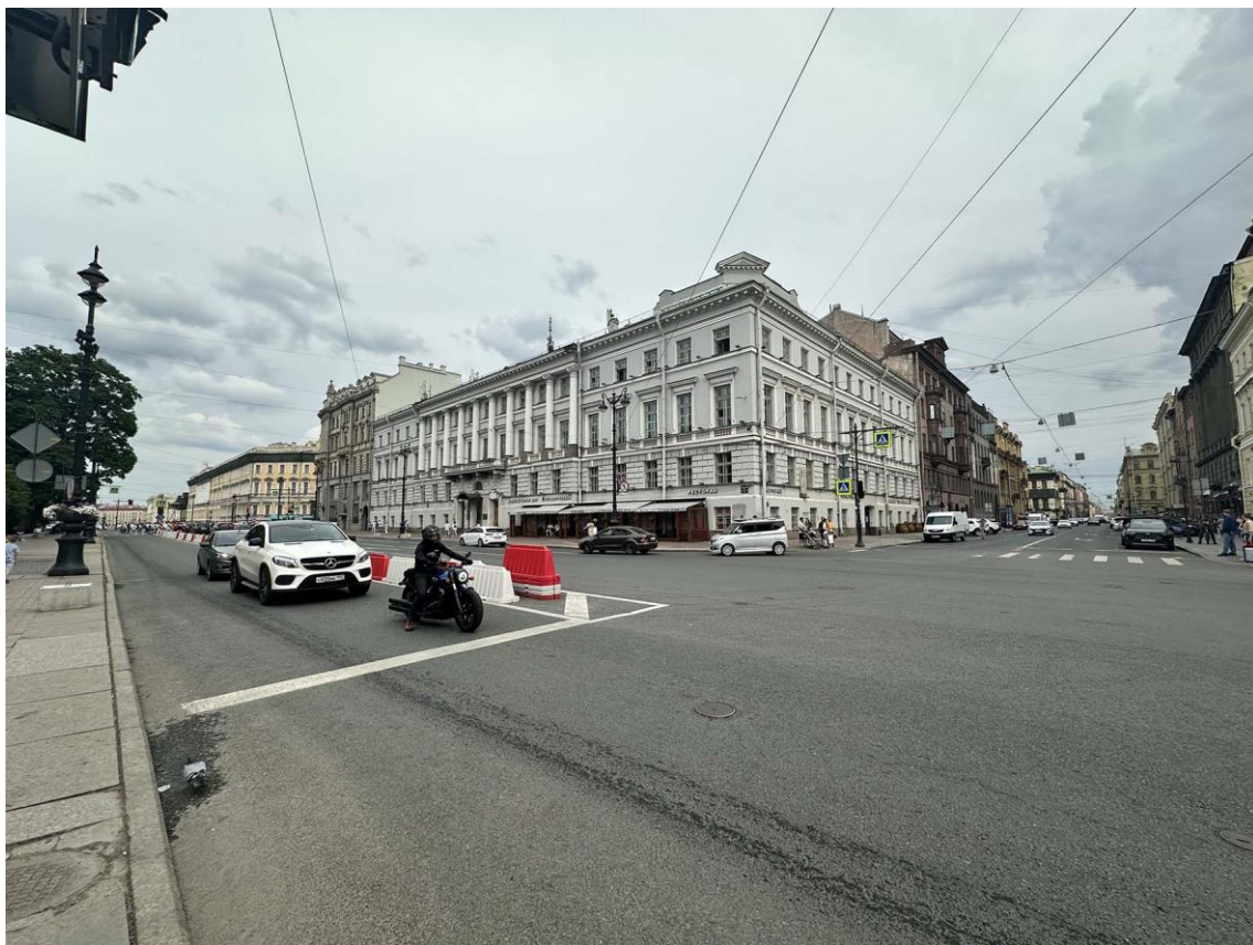
Фото 1. Общий вид объекта культурного наследия федерального значения «Дом Фитингофа И.Ф. (Губернские присутственные места)», г. Санкт-Петербург, Адмиралтейский пр., 6; Гороховая ул., 2. Фото с запада. Дата съемки: 10.06.2024 г. Автор съемки: Куваева Ю.П.
