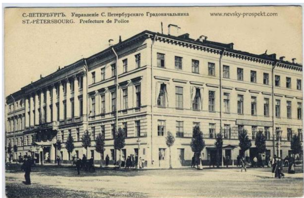
Илл. 10. Дом губернских присутственных мест. Фото (копия) 1896 г.
