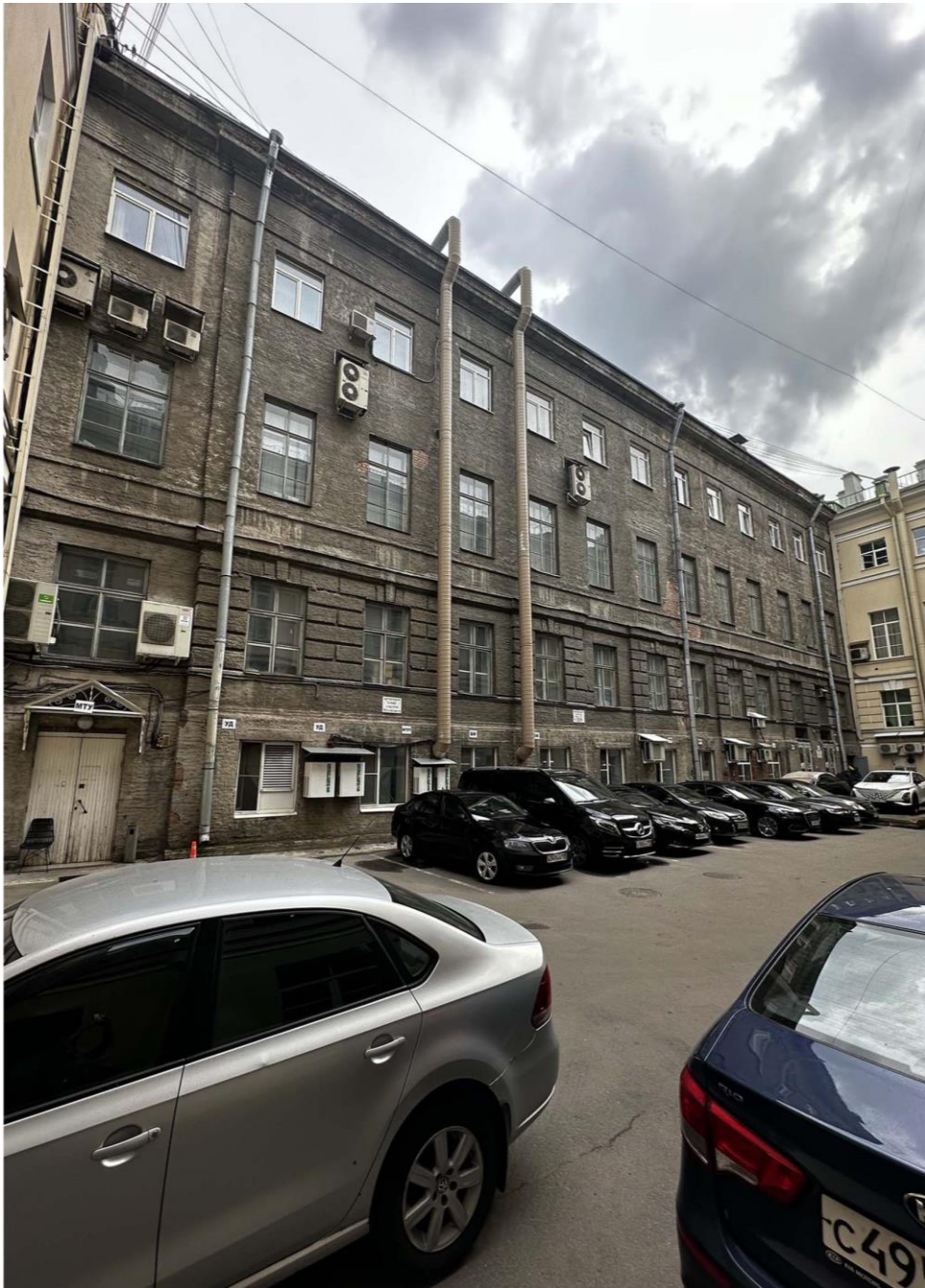
Фото 7. Общий вид северо-западного фасада дворового корпуса по Гороховой ул., 2/6, литера А, расположенного на территории объекта культурного наследия федерального значения «Дом Фитингофа И.Ф. (Губернские присутственные места)», г. Санкт-Петербург, Адмиралтейский пр., 6; Гороховая ул., 2. Фото с севера. Дата съемки: 10.06.2024 г. Автор съемки: Куваева Ю.П.
