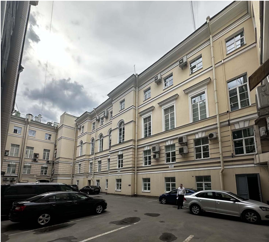
Фото 5. Общий вид дворовых фасадов объекта культурного наследия федерального значения «Дом Фитингофа И.Ф. (Губернские присутственные места)», г. Санкт-Петербург, Адмиралтейский пр., 6; Гороховая ул., 2. Слева – северо-восточный фасад юго-западного крыла, справа – юго-восточный фасад. Фото с востока. Дата съемки: 10.06.2024 г. Автор съемки: Куваева Ю.П.
