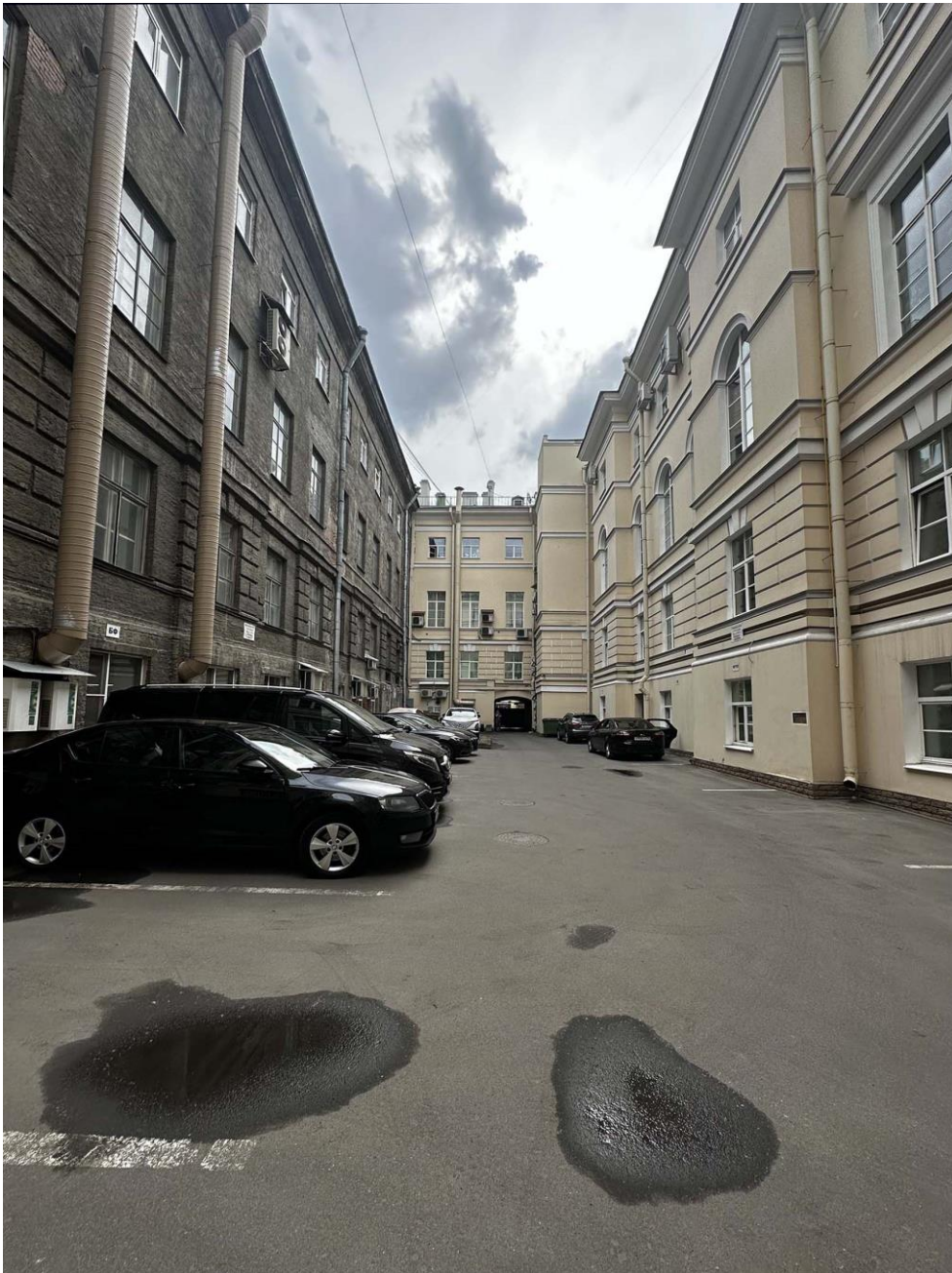
Фото 6. Общий вид дворовых фасадов объекта культурного наследия федерального значения «Дом Фитингофа И.Ф. (Губернские присутственные места)», г. Санкт-Петербург, Адмиралтейский пр., 6; Гороховая ул., 2, и корпуса по Гороховой ул., 2/6, литера А. Фото с северо-востока. Дата съемки: 10.06.2024 г. Автор съемки: Куваева Ю.П.
