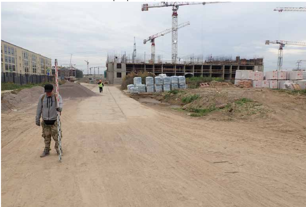
Рис. 23. Земельный участок по адресу Санкт-Петербург, п. Стрельна, ш. Красносельское. Точка фотофиксации 5, вид с севера северо-запада.
