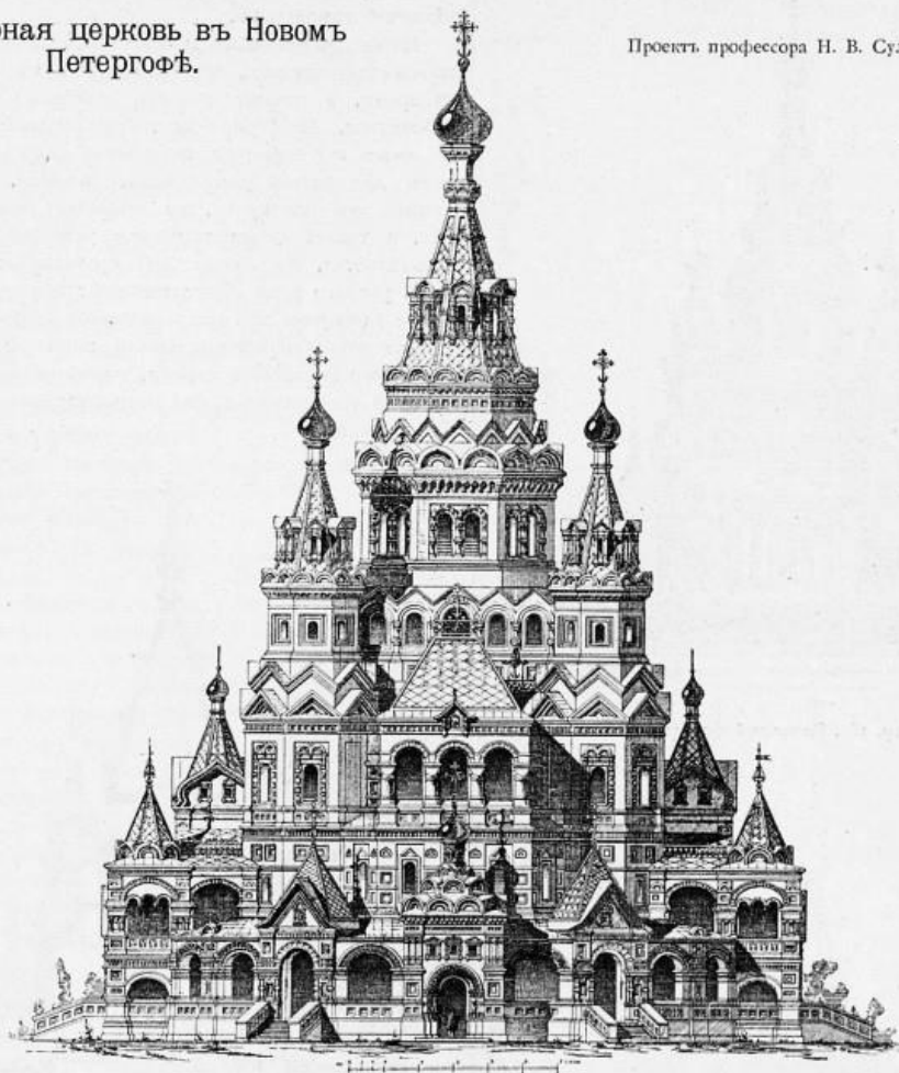
Чер. 382. Западный фасадъ.
