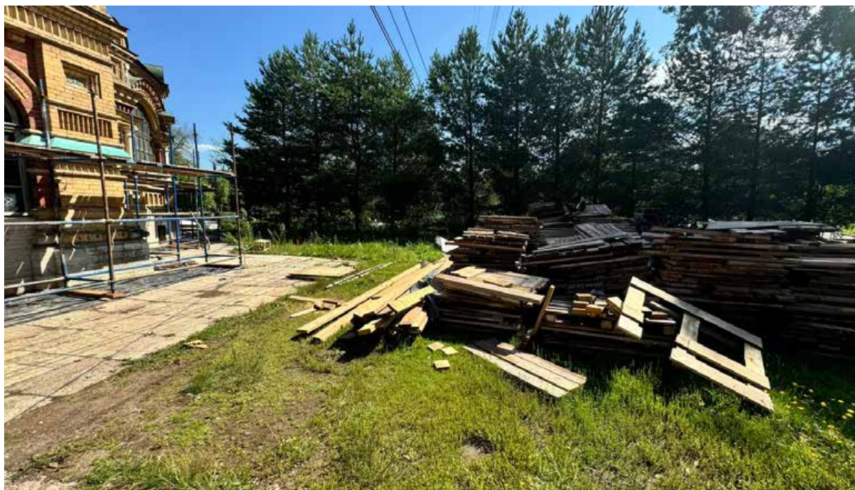
11. Общий вид территории объекта культурного наследия регионального значения «б. Собор Петра и Павла Красный просп., 32 со зданием б. Церковно-приходной школы, Красный пр., 43», расположенного по адресу: г. Санкт-Петербург, город Петергоф, Санкт-Петербургский проспект, дом 32, литера А (Красный просп., 32, Красный пр., 43).
