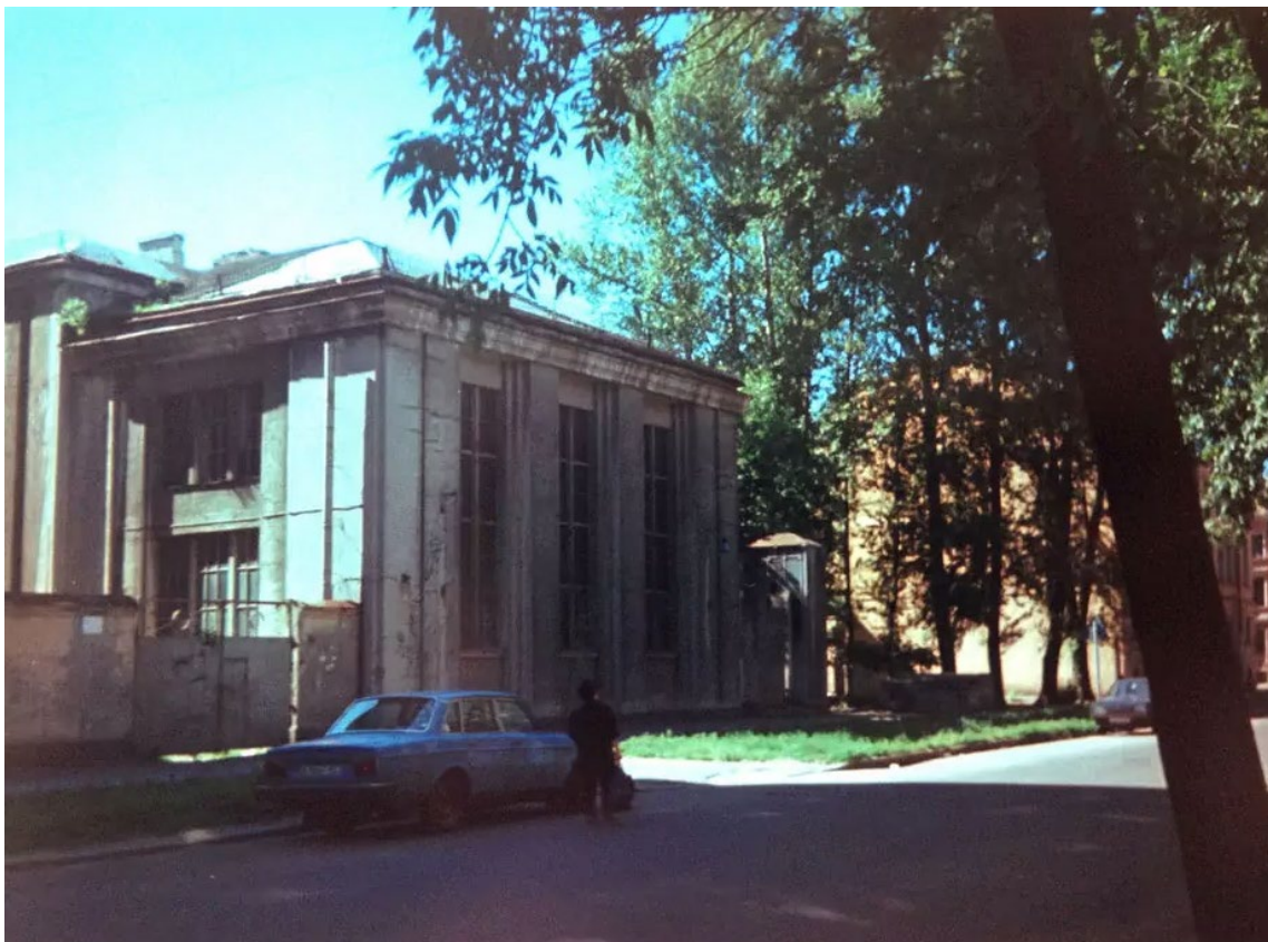
26. Здание понижающей подстанции Волховской ГЭС. 1997 г. // https://pastvu.com/p/696934
