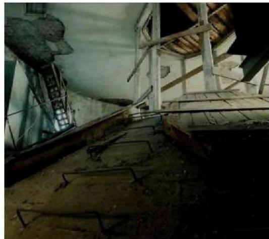
конструкция перекрытия второго этажа в восточной части здания с фонарем верхнего света прямоугольной конфигурации в плане (рисунок расстекловки - геометрический);
