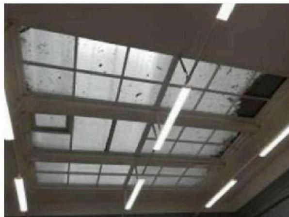
конструкция перекрытия второго этажа в восточной части здания («зимний сад») с фонарем верхнего света прямоугольной конфигурации в плане (рисунок расстекловки - падуги с ромбовидными фигурами в расстекловке, в квадрат центрального поля вписан круг с радиальной разбивкой);
