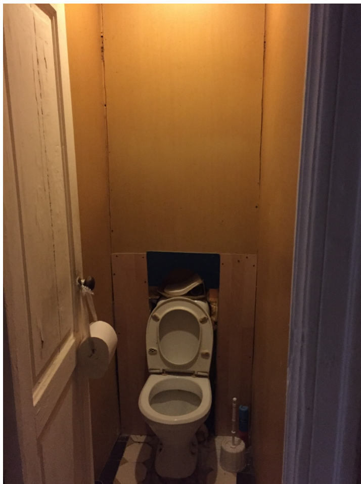
Илл. 31. Туалет (помещение № 12). Вид с северо-востока.
