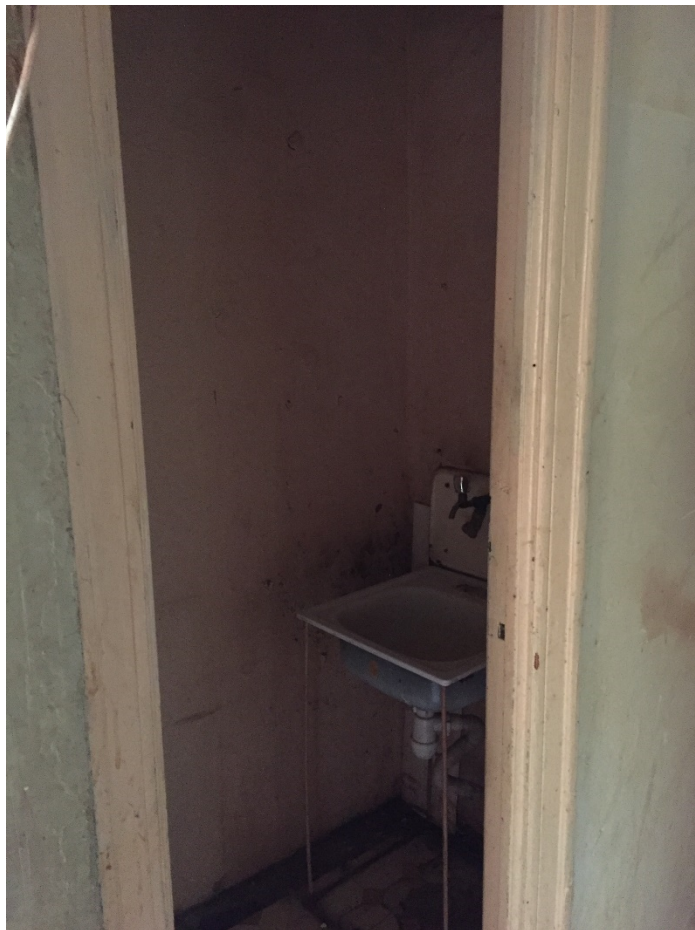
Илл. 33. Умывальная (помещение № 14). Вид с северо-востока.
