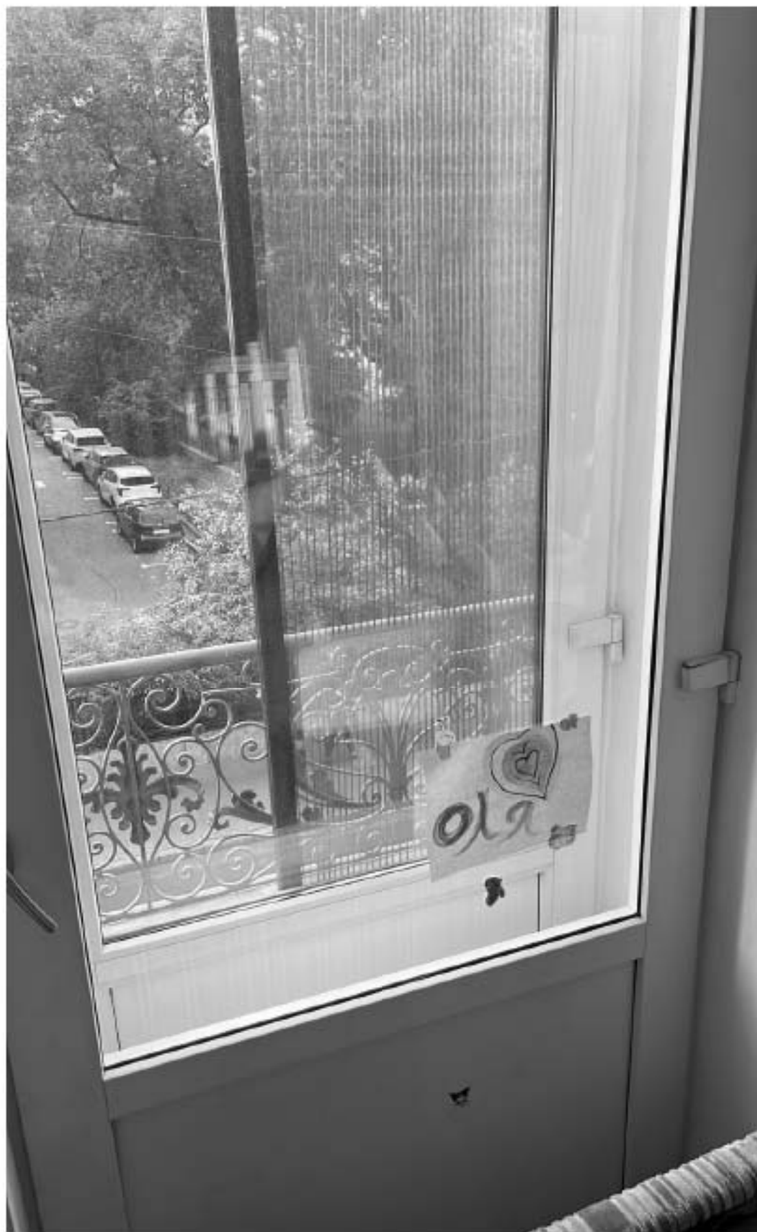
19. Вид на балконную дверь
