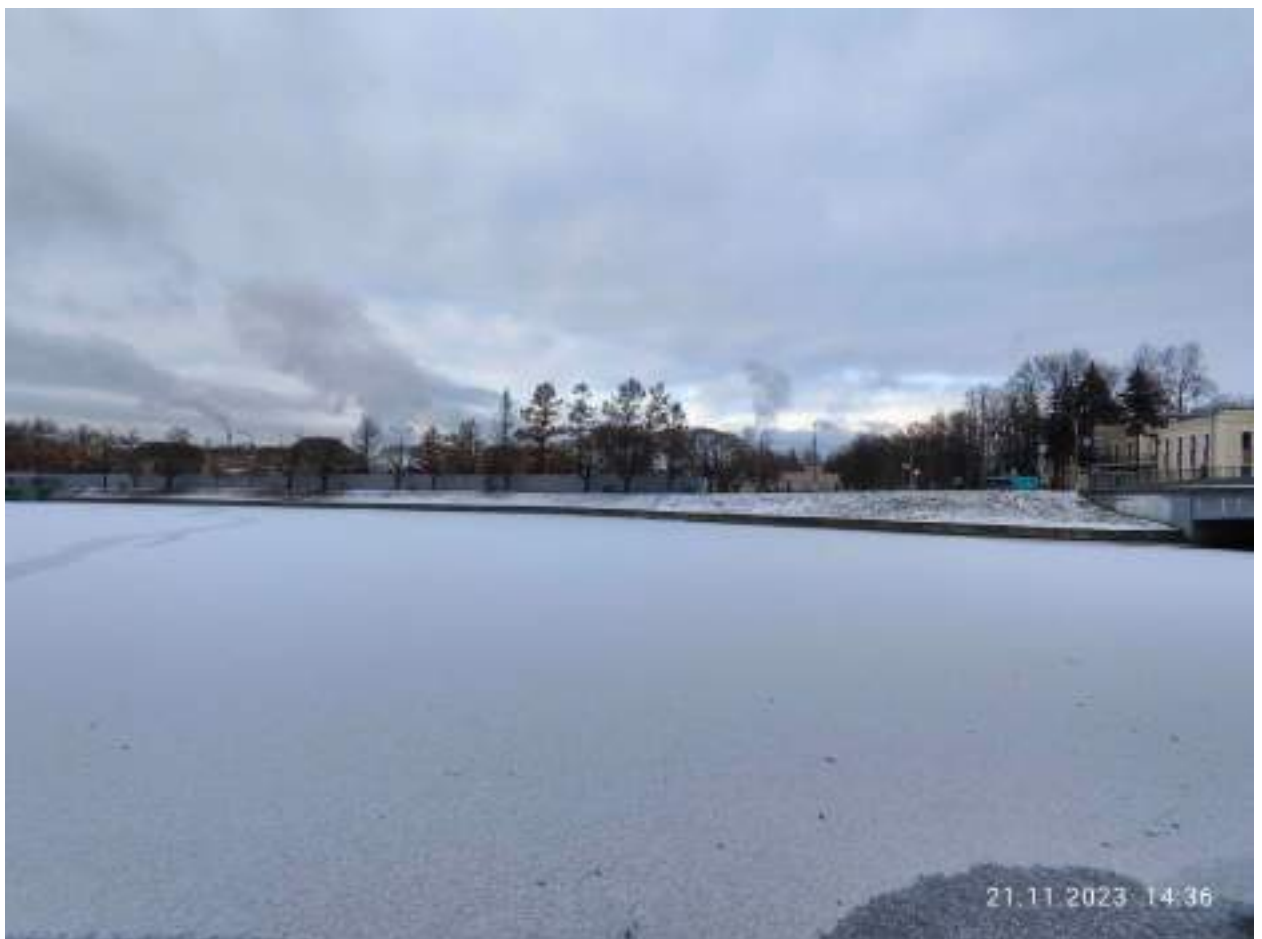
7. Вид на объект культурного наследия федерального значения «Заводы Ижорские Адмиралтейские. Плотина главная №1 с подпорной стеной». 21.11.2023
