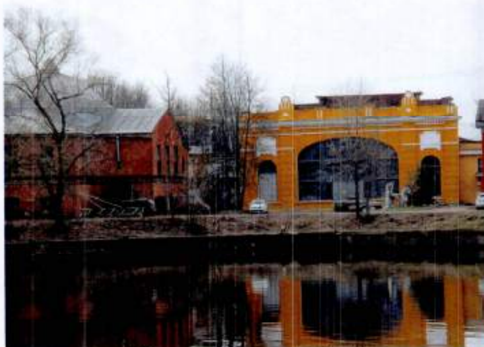
2. Вид со стороны нижнего бьефа
