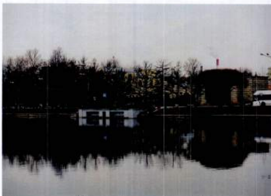
1. Вид со стороны верхнего бьефа
