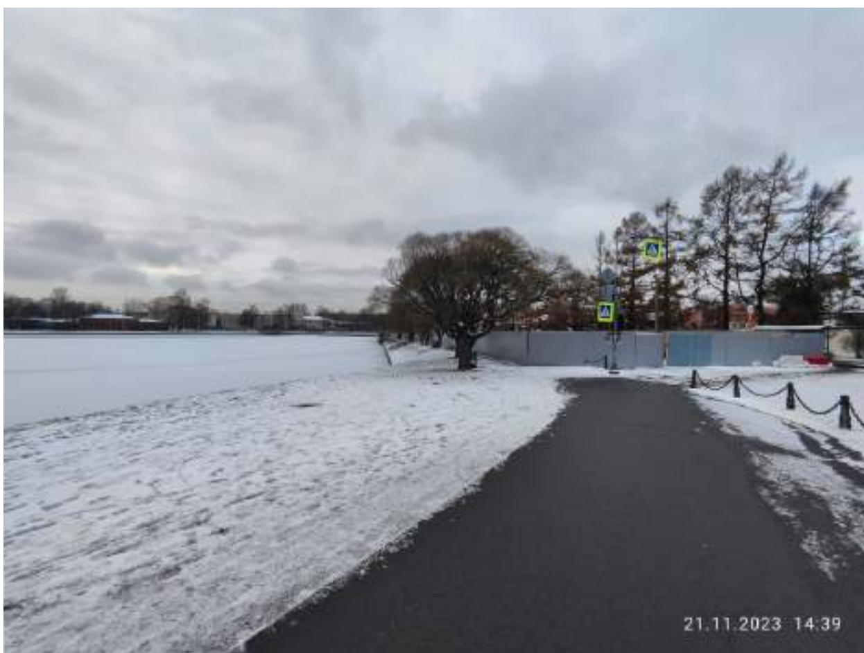
8. Вид на объект культурного наследия федерального значения «Заводы Ижорские Адмиралтейские. Плотина главная №1 с подпорной стеной». 21.11.2023
