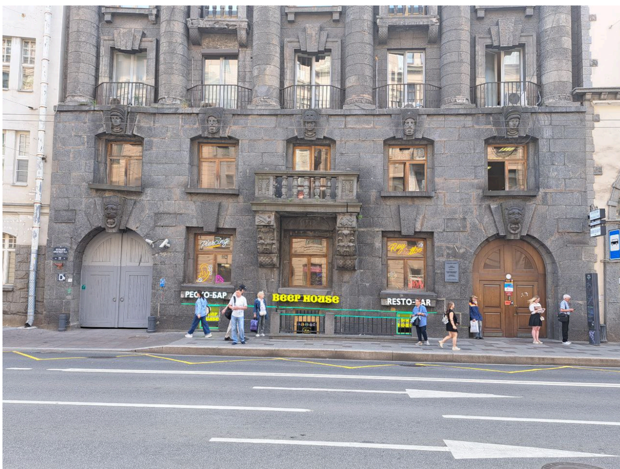
Фото №2. Лицевой северо-западный фасад здания.
