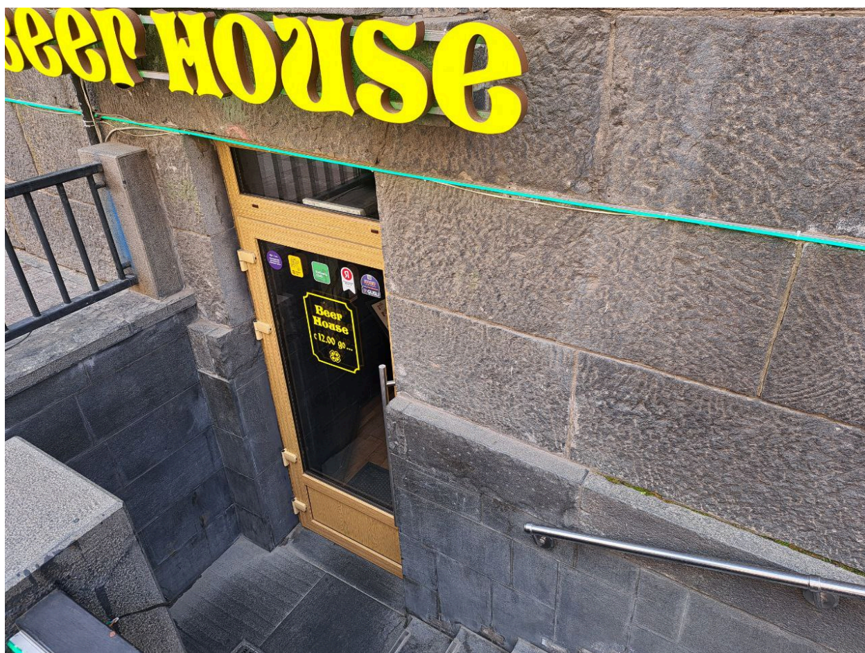
Фото №4. Вход в помещение 2-Н со стороны лицевого фасада.
