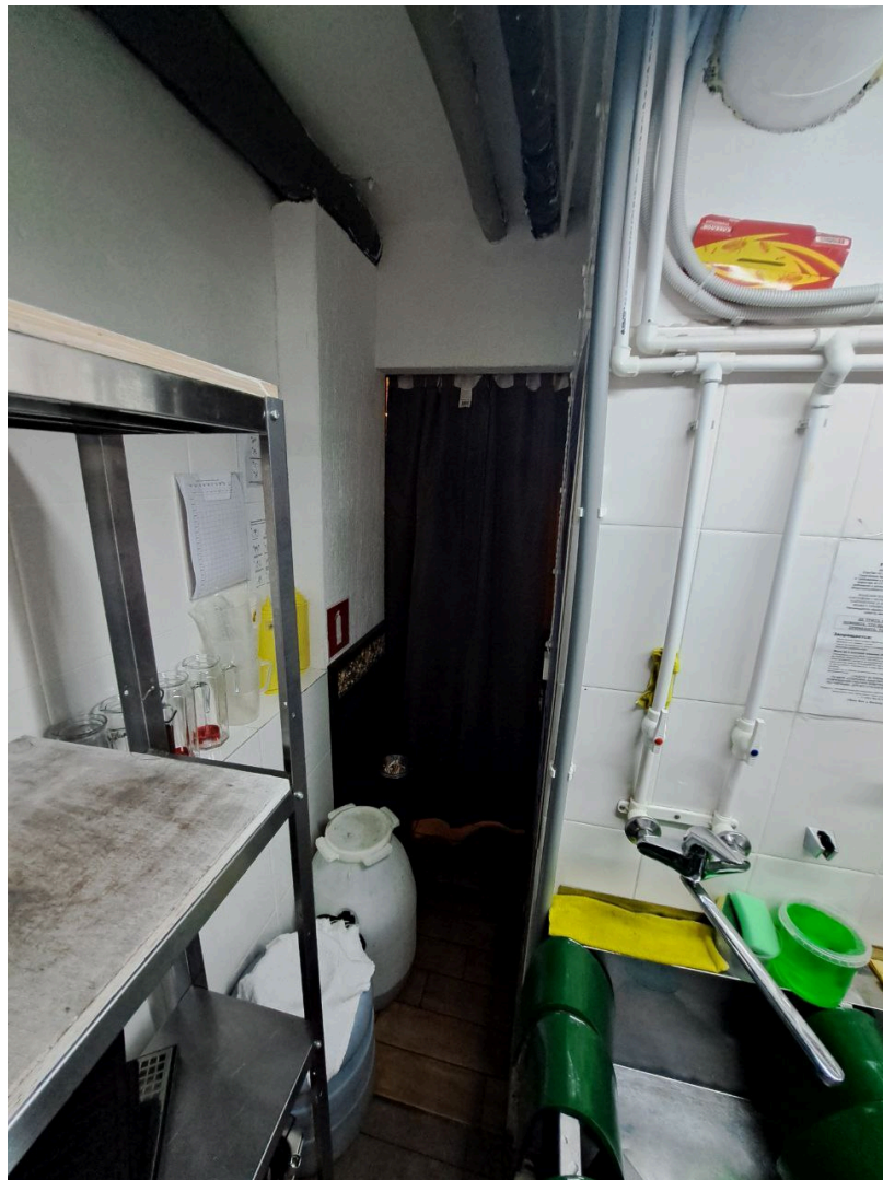
Фото №32. Помещение 2-Н (2).
