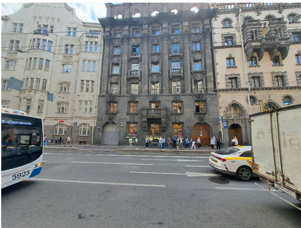
Фото №1. Лицевой северо-западный фасад здания.
