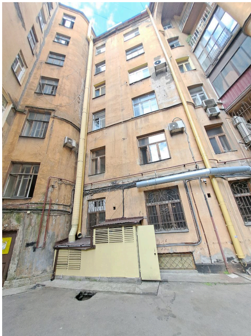
Фото №46. Дворовый юго-восточный фасад здания.
