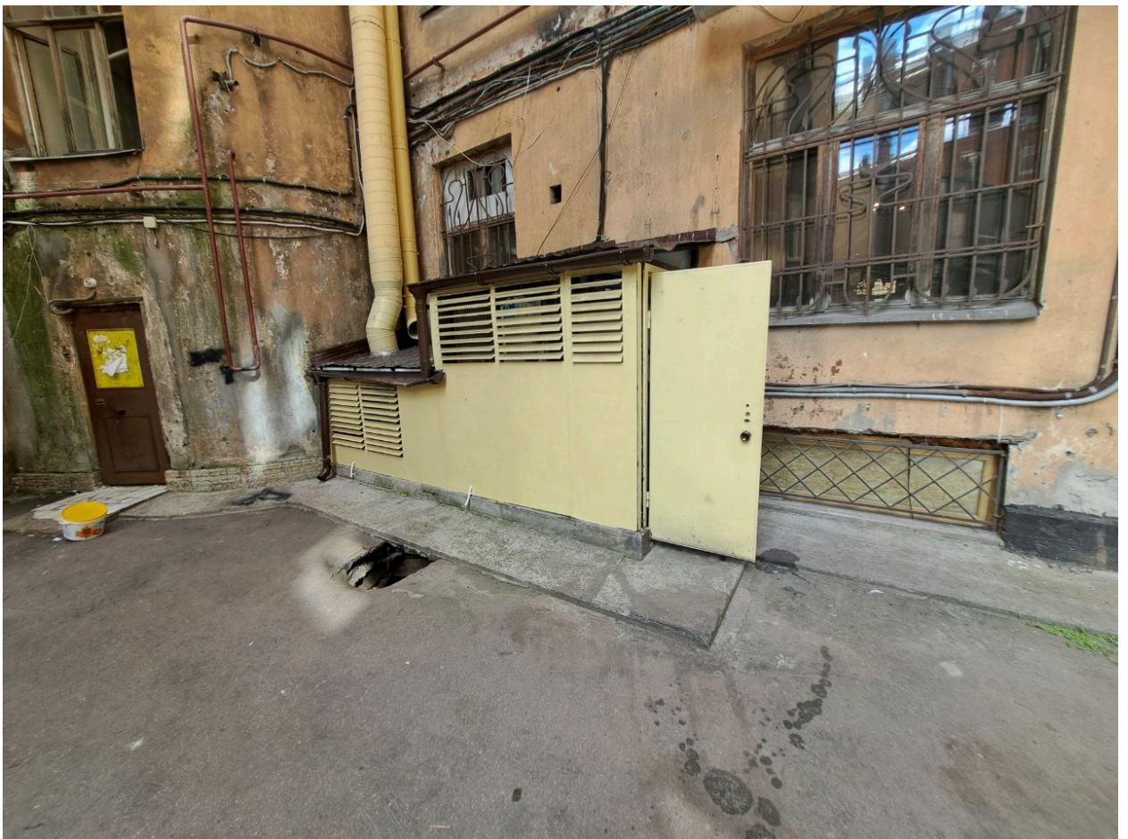
Фото №47. Дворовый юго-восточный фасад здания. Фрагмент.
