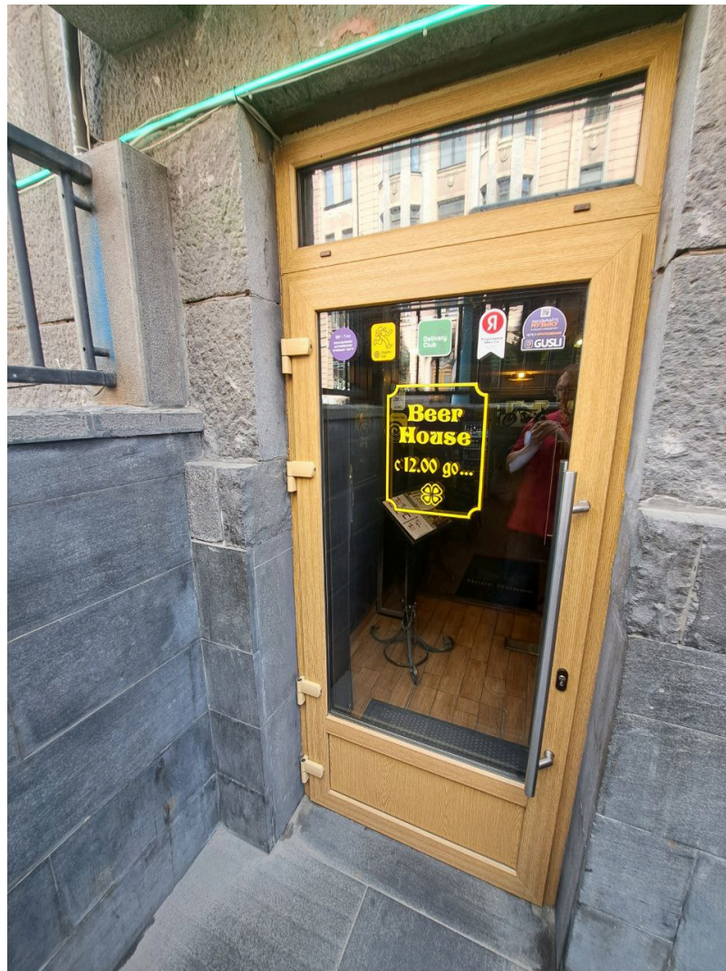
Фото №5. Вход в помещение 2-Н со стороны лицевого фасада.
