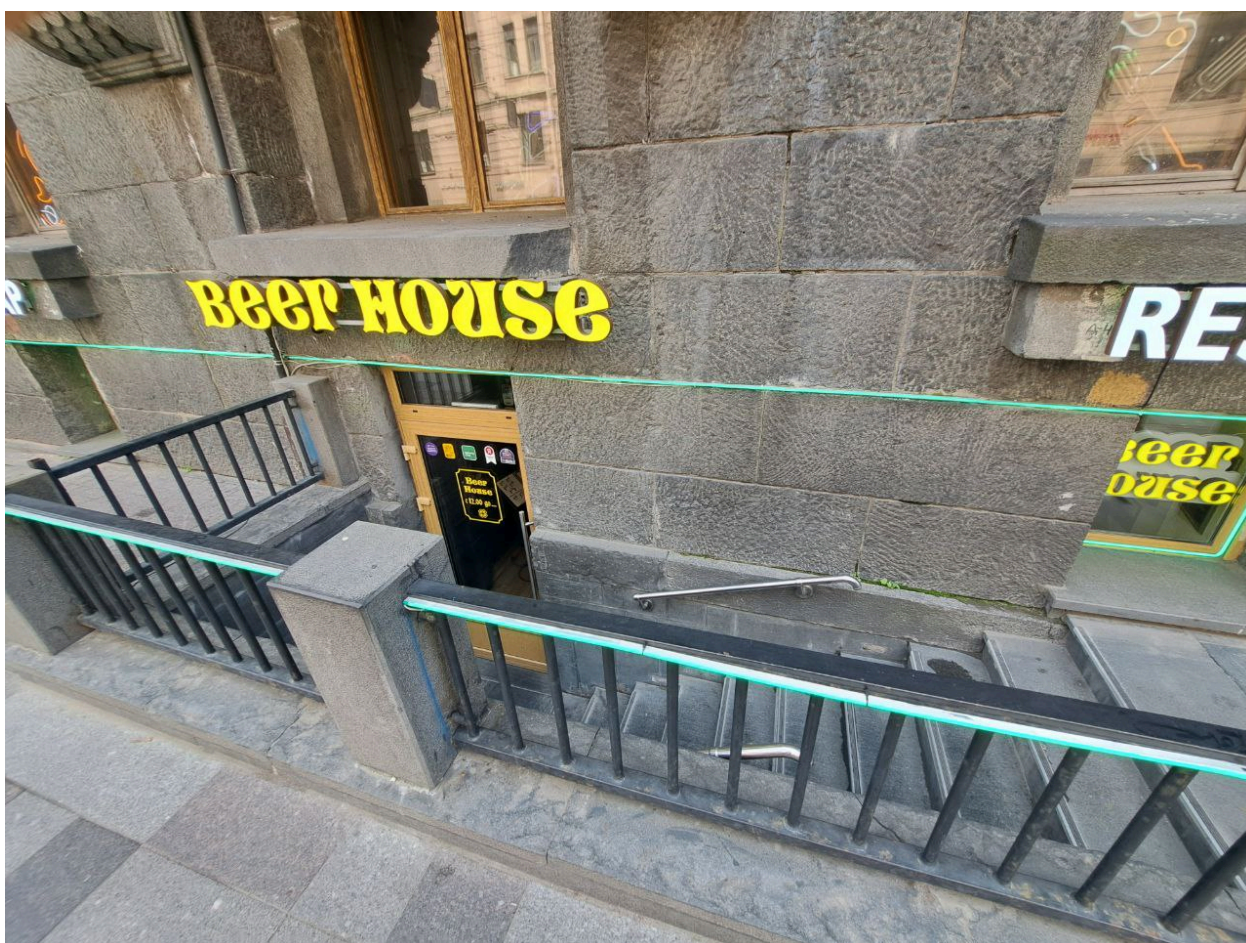
Фото №3. Лицевой северо-западный фасад здания. Фрагмент.
