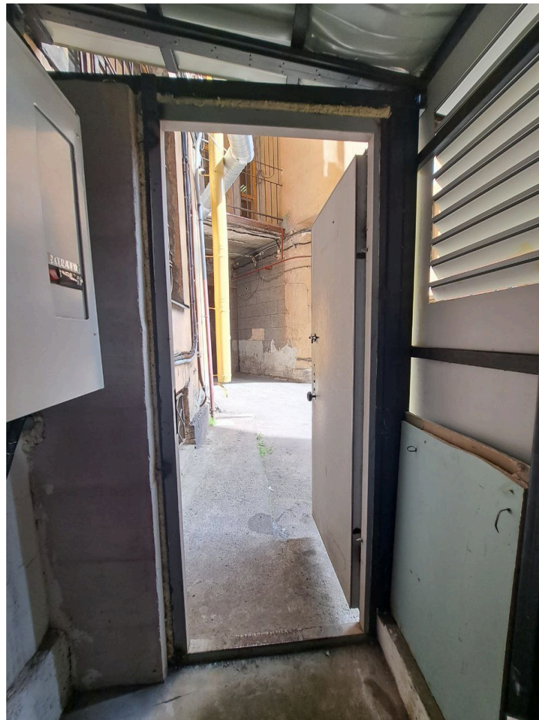
Фото №44. Вход в помещение 2-Н.
