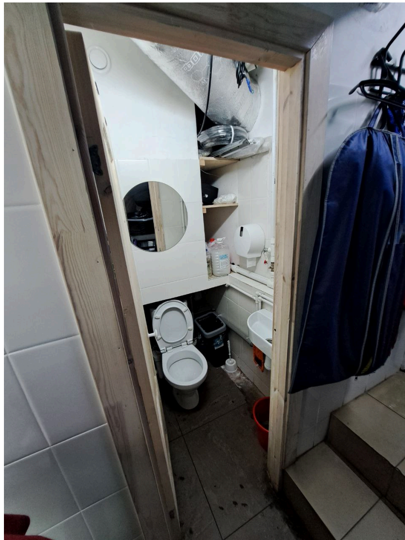
Фото №39. Помещение 2-Н (2).
