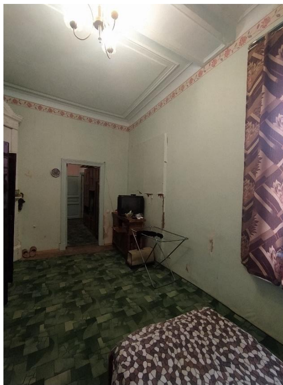
Фото 33. Вид на вход из комнаты № 6 в комнату № 5.
