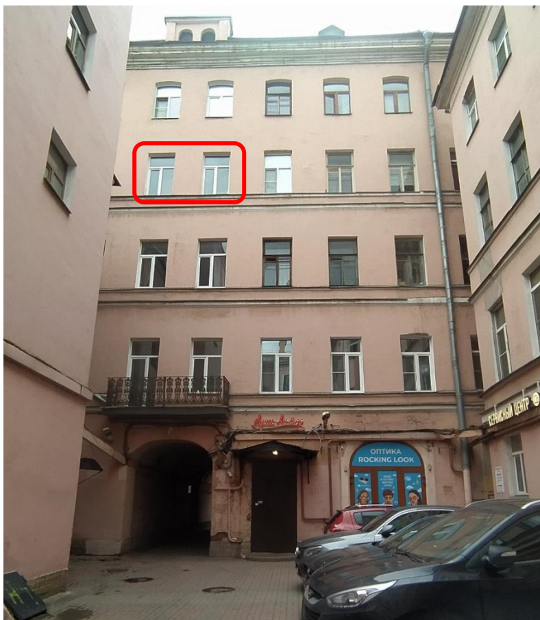
Фото 6. Южный фасад пятиэтажного дворового корпуса здания. Вид на окна квартиры №25 (на окна комнаты № 2).
