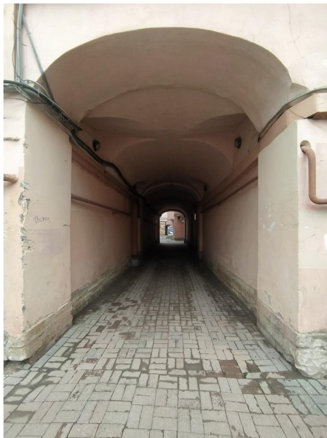
Фото 10. Воротный проезд пятиэтажного дворового корпуса здания. Вид с севера на юг.
