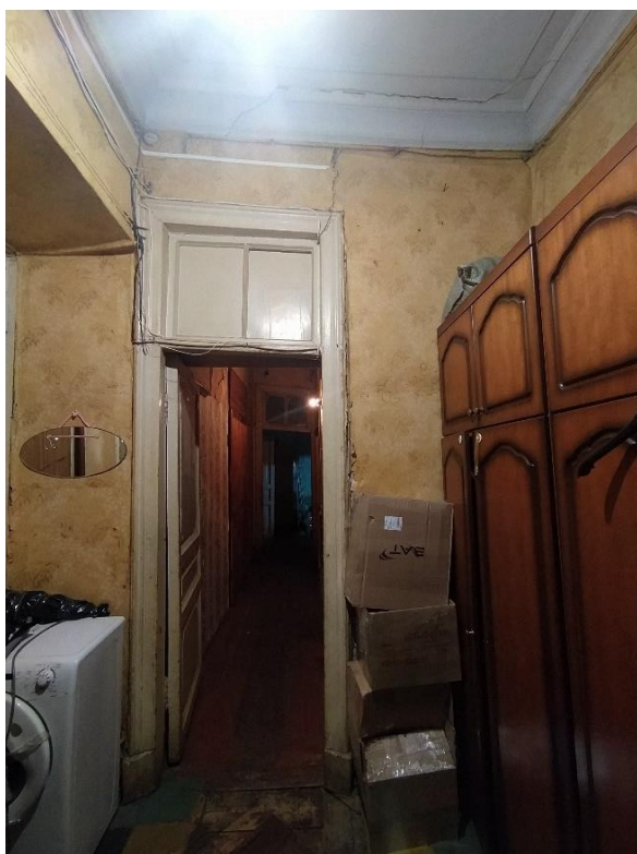
Фото 14. Вид на коридор (пом. № 1).
