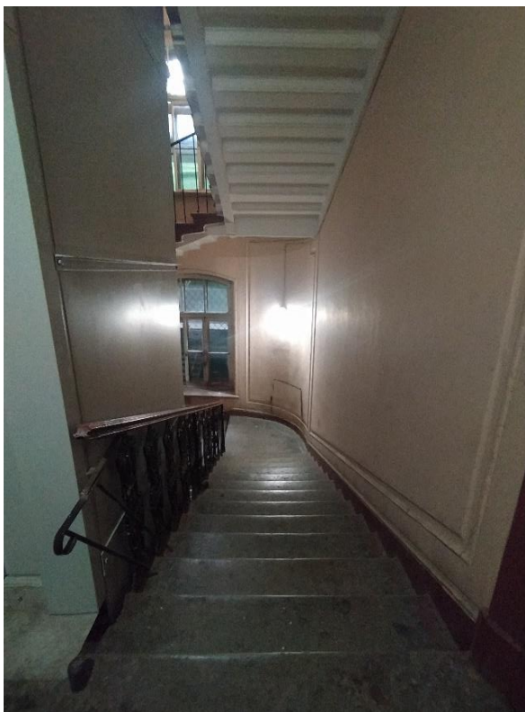
Фото 12. Вид на лестничный марш центральной парадной (ЛК № 5) пятиэтажного дворового корпуса.
