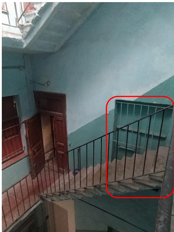
Фото 37. Вид на окно холла (пом. 6) со стороны лестничной клетки № 6, расположенной в западной части здания.
