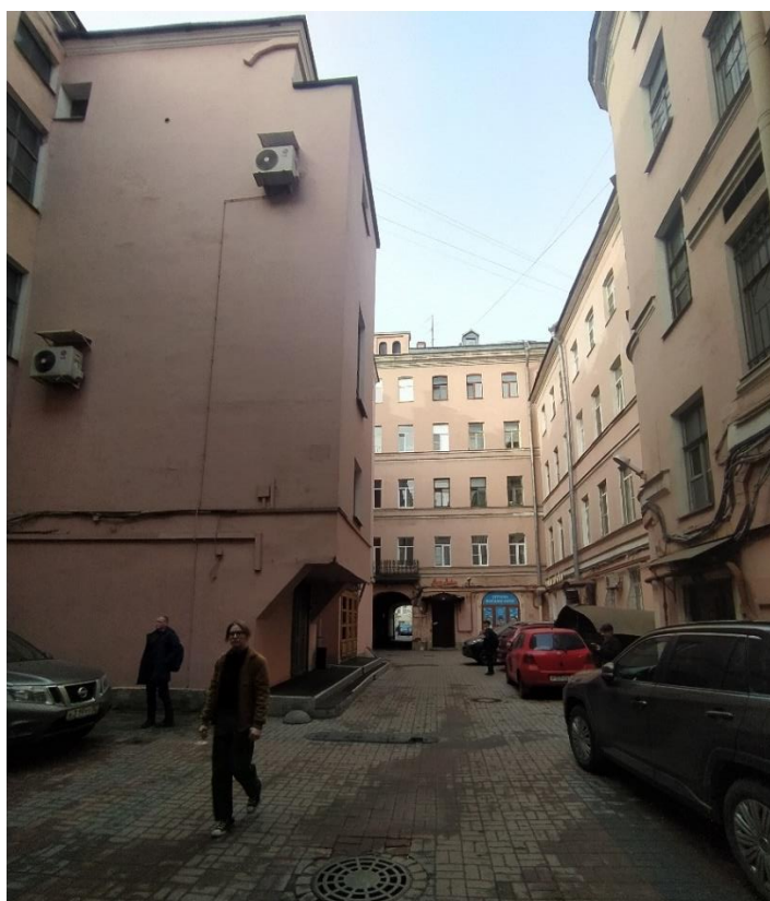
Фото 3. Объект культурного наследия регионального значения «Дом, где в 1906 г. находилась явочная квартира РСДРП(б)». Вид на южный фасад дворового пятиэтажного корпуса здания (прямо). Вид на западный дворовый фасад четырёхэтажного корпуса здания (справа).
