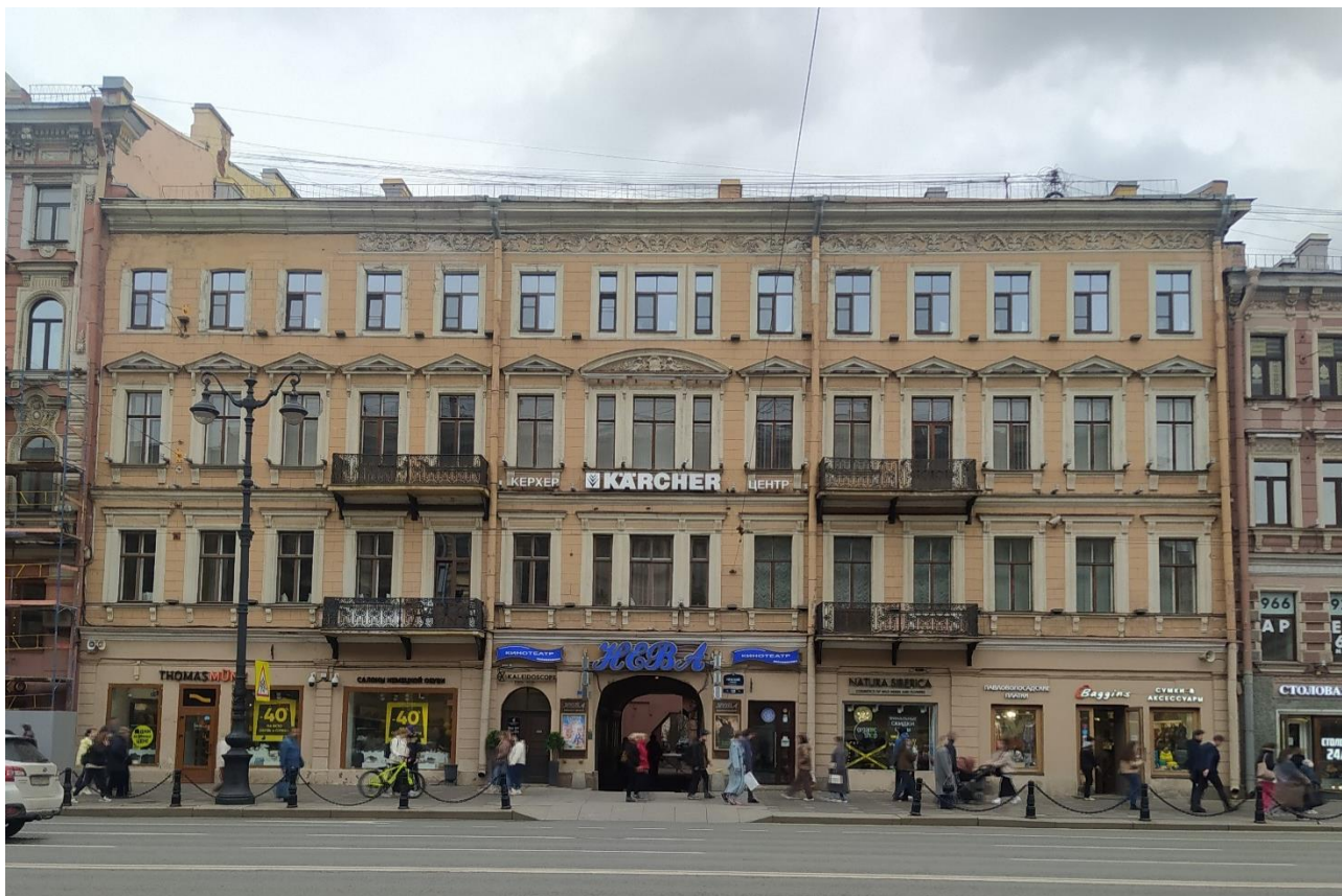
Фото 1. Объект культурного наследия регионального значения «Дом, где в 1906 г. находилась явочная квартира РСДРП(б)». Общий вид лицевого (южного) фасада здания по Невскому проспекту.
