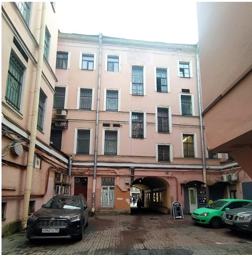
Фото 4. Вид на северный фасад лицевого четырёхэтажного корпуса здания.
