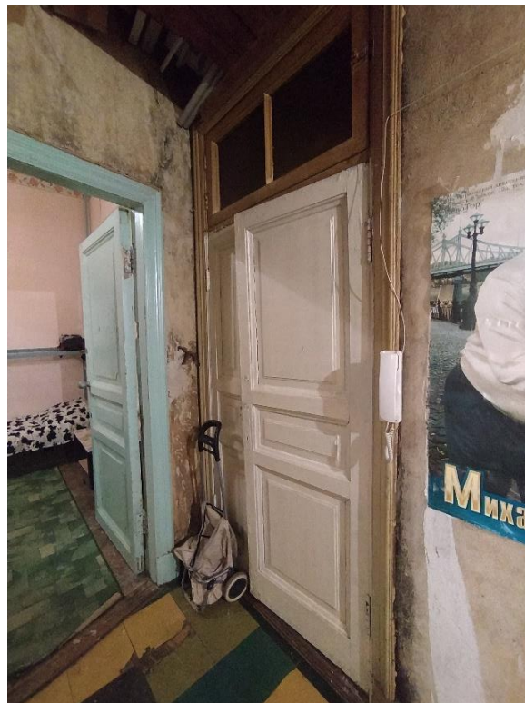
Фото 29. Вид из коридора (пом. № 7) на вход в комнату № 6 и на второй вход в квартиру № 25.
