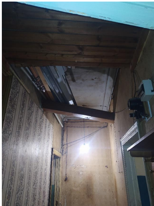
Фото 25. Вид на потолок в коридоре (пом. №7) и воздуховод, выходящий из помещения кухни (пом. № 4).
