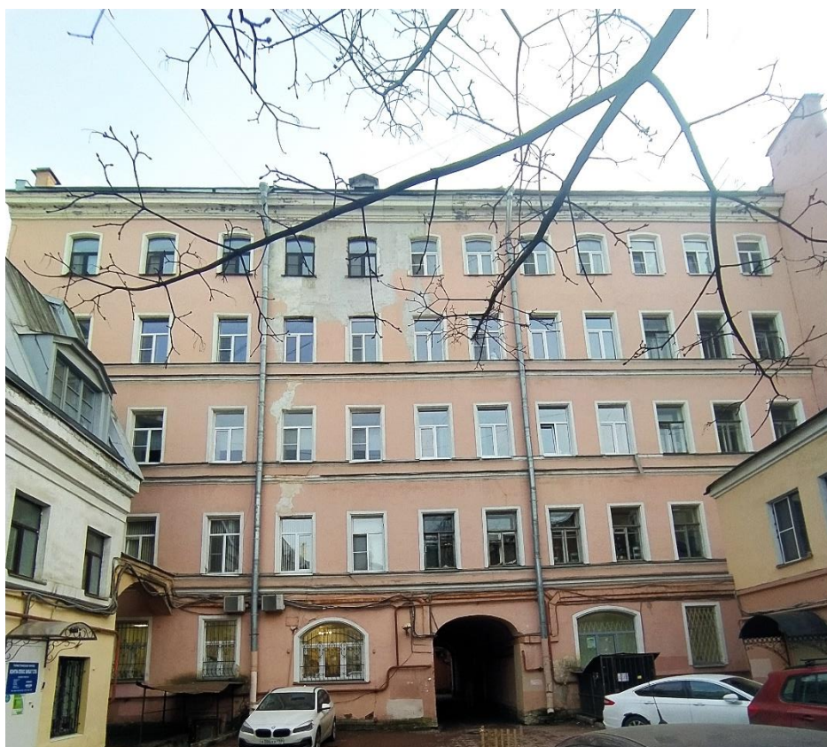
Фото 11. Северный фасад пятиэтажного дворового корпуса здания.
