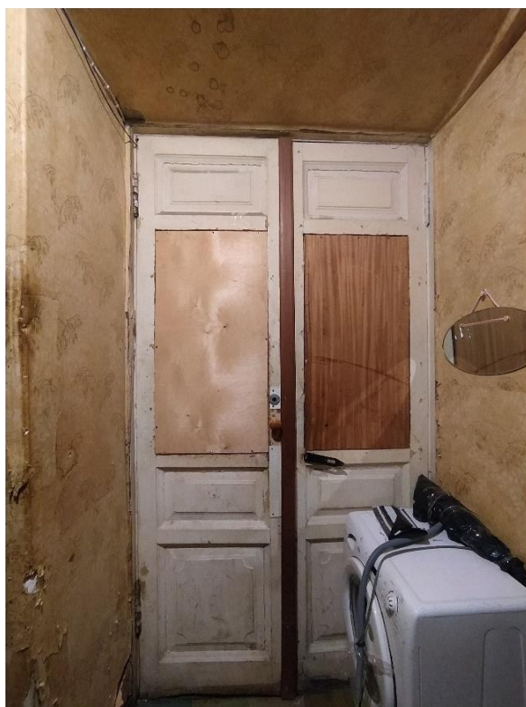
Фото 15. Вид на вход в комнату (пом. № 2).
