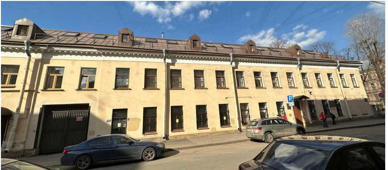
Фото 1. Общий вид здания
