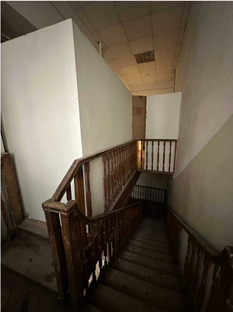
Фото 7. Деревянная лестница. Площадка 2-ого этажа
