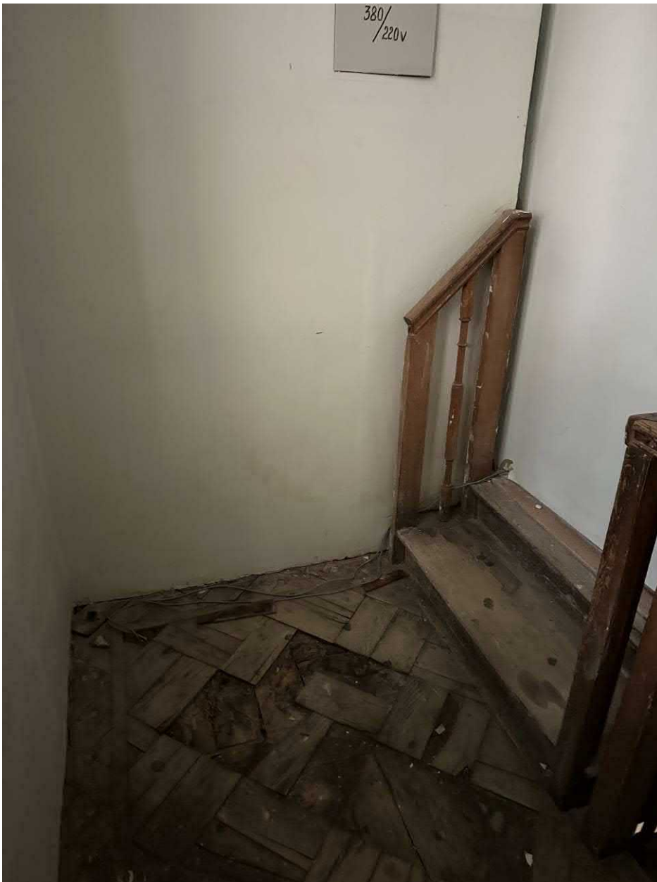
Фото 6. Деревянная лестница. Площадка 2-ого этажа
