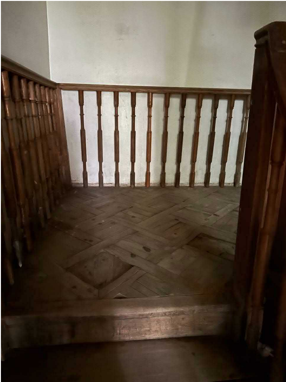
Фото 3. Деревянная лестница. Площадка между 1 и 2 этажом
