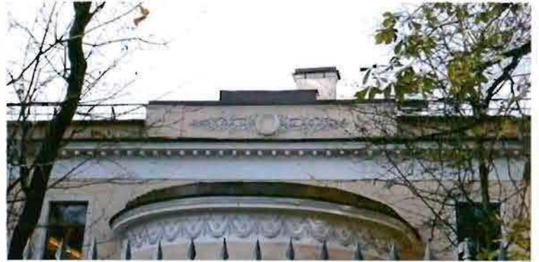
5. Аттик восточного фасада здания
