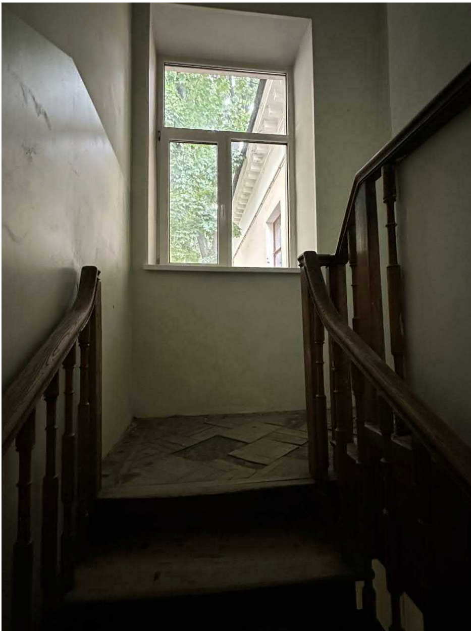
Фото 5. Деревянная лестница. Площадка 2-ого этажа
