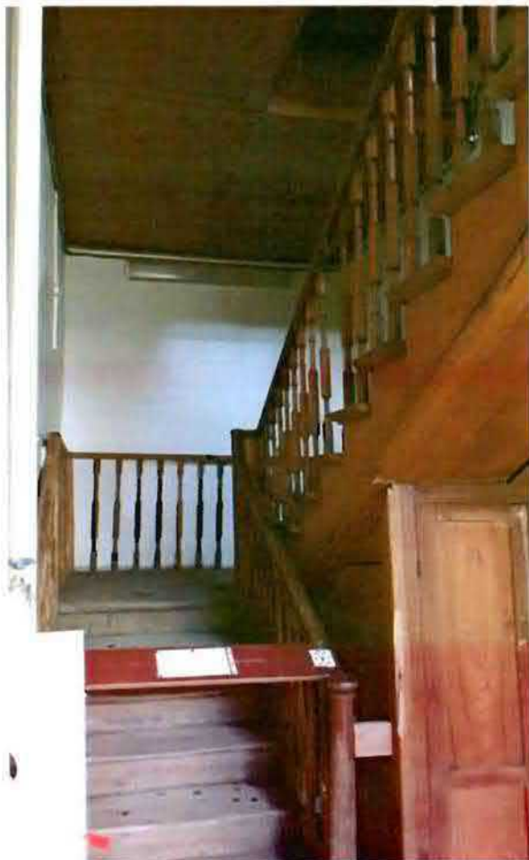
14. Деревянная лестница в северо-западной части здания
