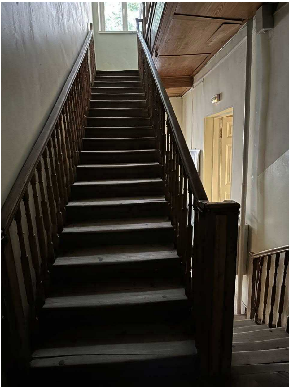
Фото 4. Деревянная лестница. 2 марш
