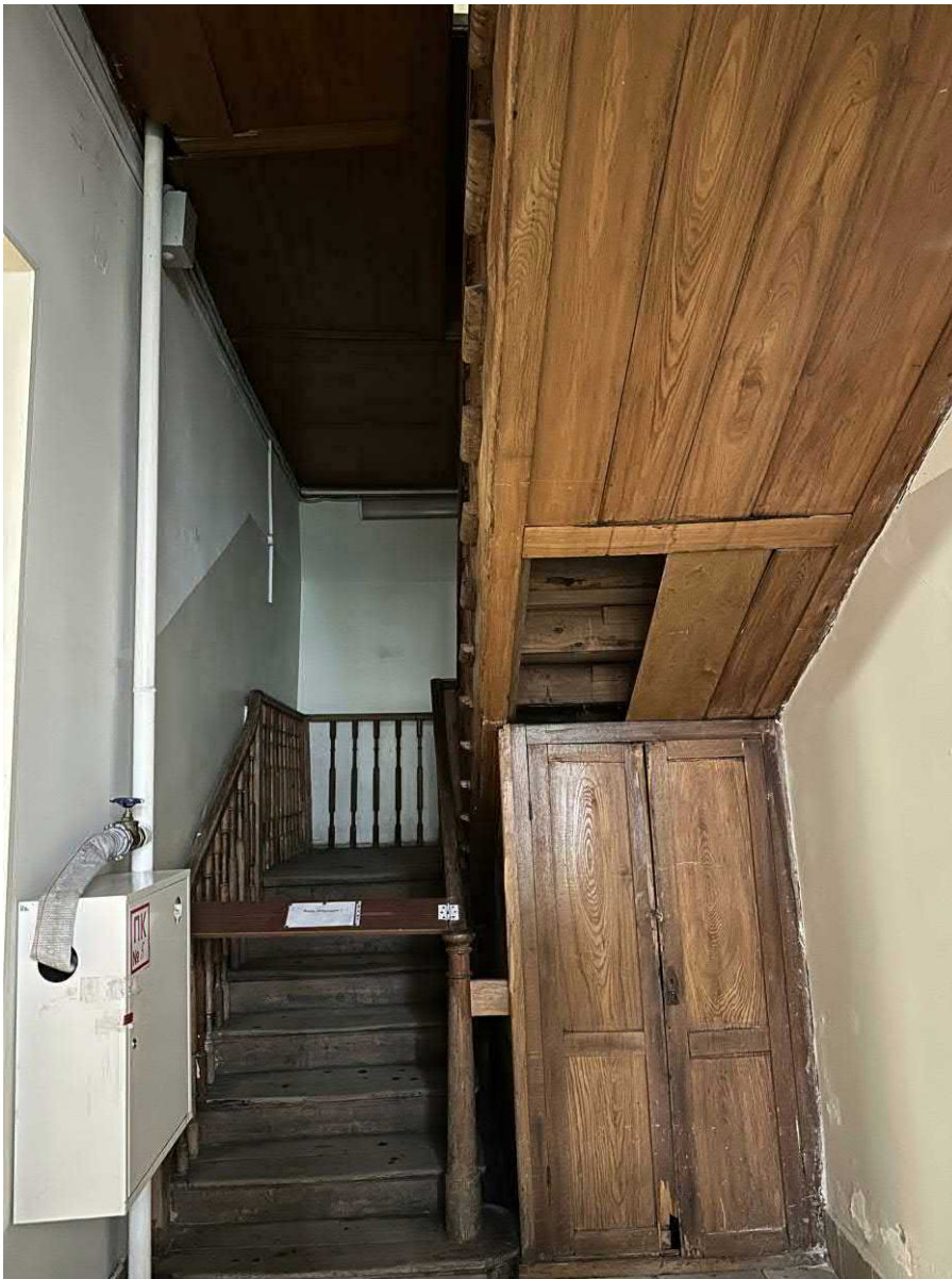
Фото 2. Деревянная лестница. 1 марш
