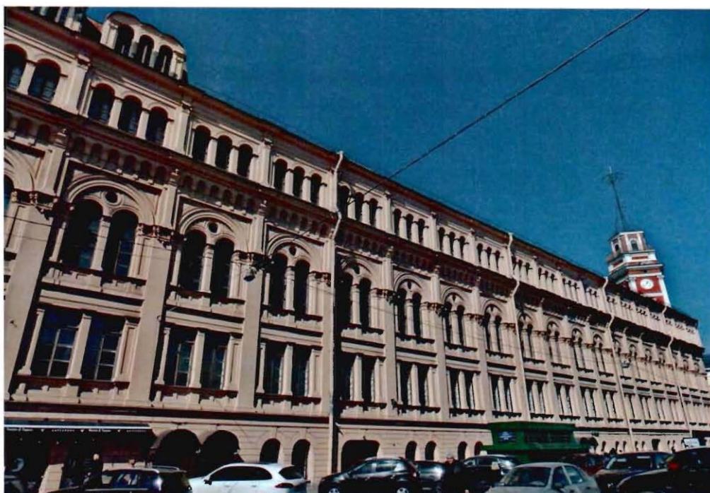
2. Вид на восточный фасад объекта культурного наследия.
