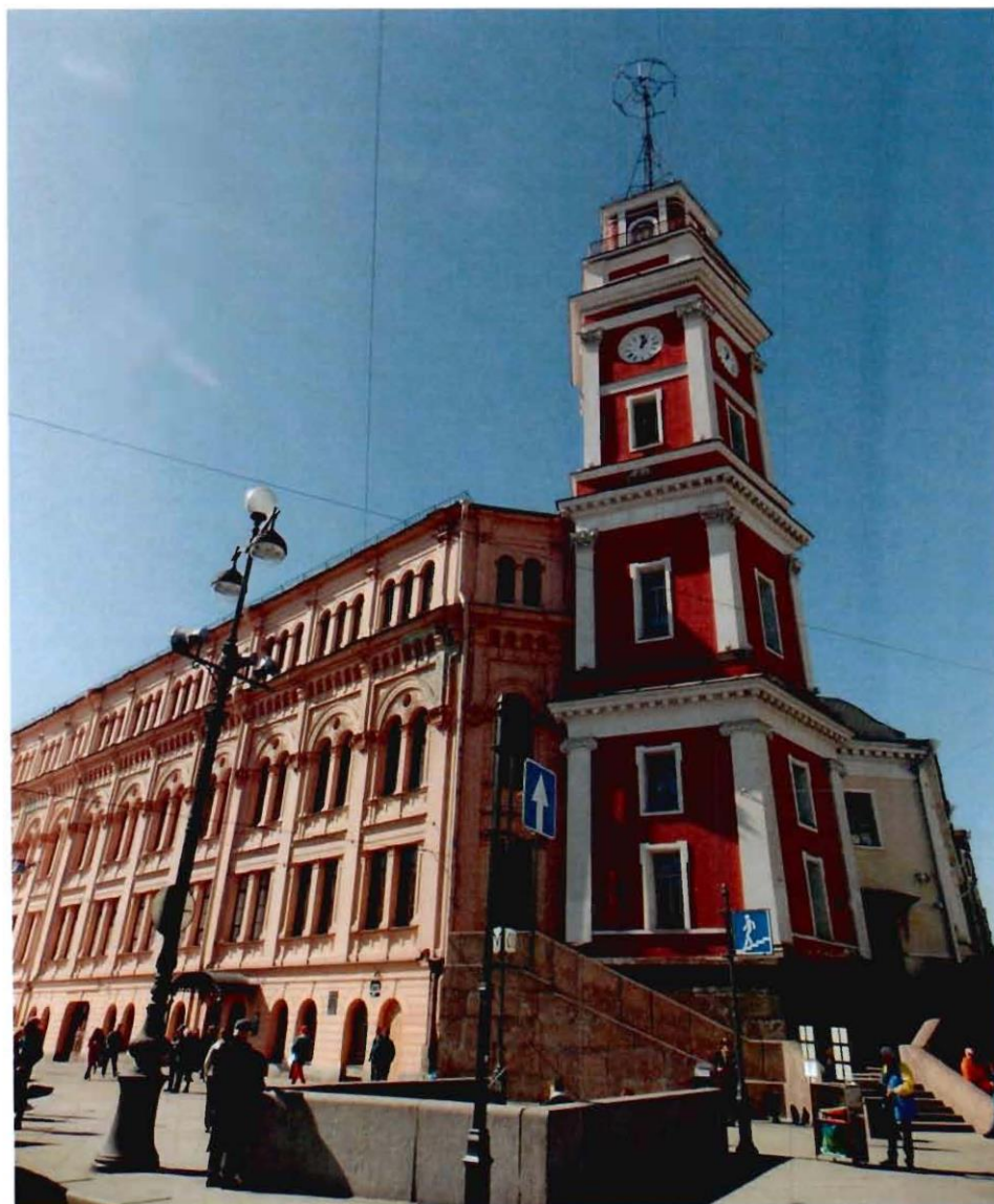
1. Вид на объект культурного наследия с северной стороны.
