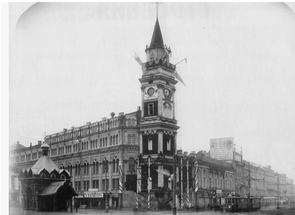
17. Вид здания Городской думы после надстройки четвертого и мансардного этажей. Фотография начало XX в. (после 1913 г.). Приведено на сайте: http://www.pastvu.com .
