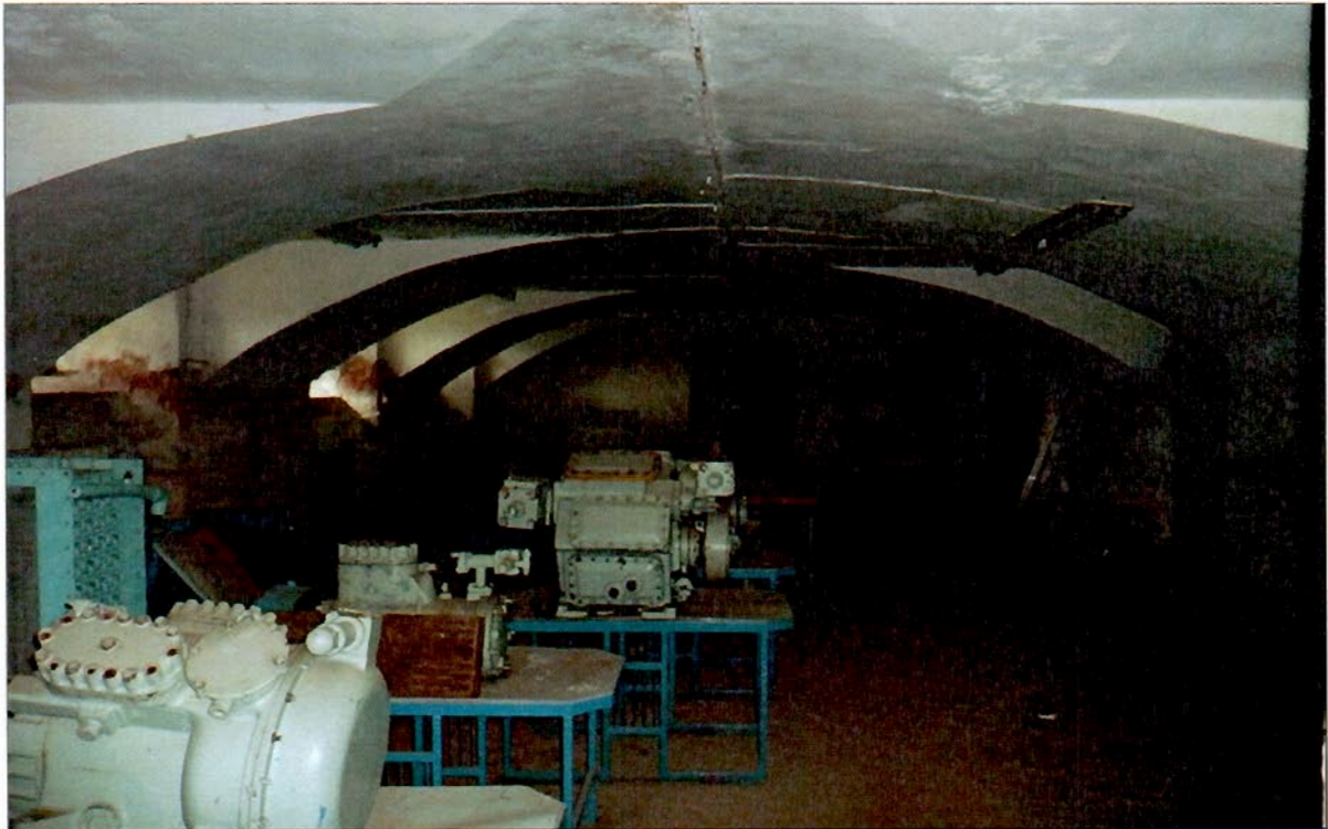
14. Сводчатые перекрытия. Цокольный этаж.
