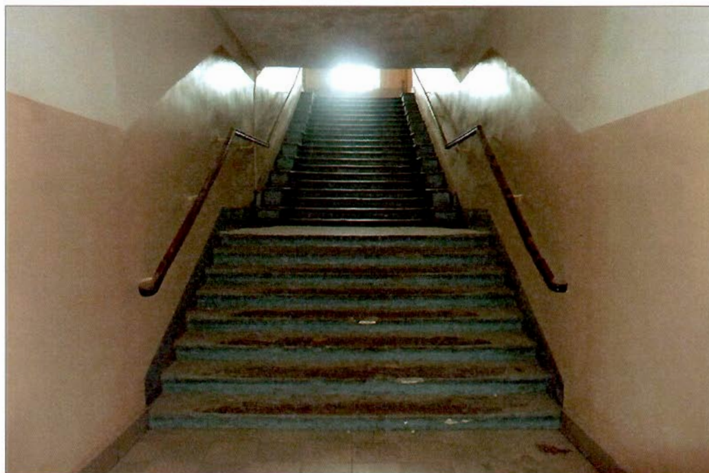
11. Лестница между 3-м и 4-м этажами в центральной части лицевого корпуса.
