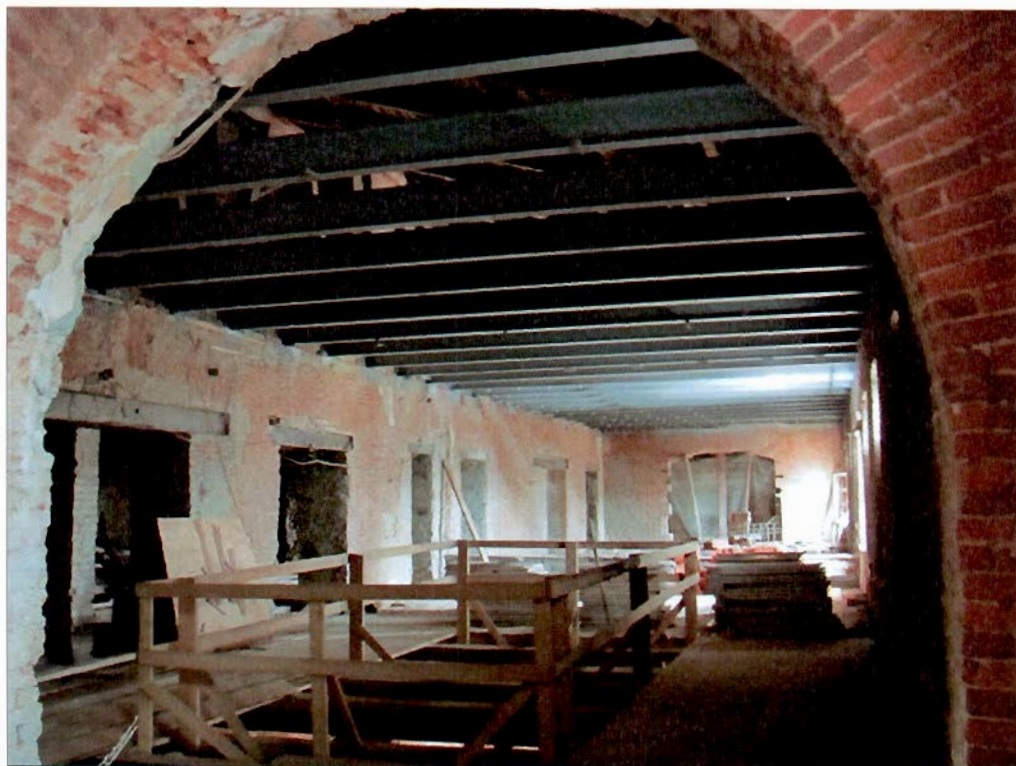
18. Интерьер в уровне 4-го этажа. Фрагмент.
