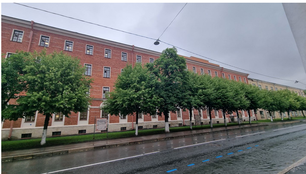
6. Вид на юго-западный фасад объект культурного наследия регионального значения «Здание Дворянского полка», расположенного по адресу: г. Санкт-Петербург, Пионерская ул., д. 28, литера А, и объект реконструкции. 14.06.2024
