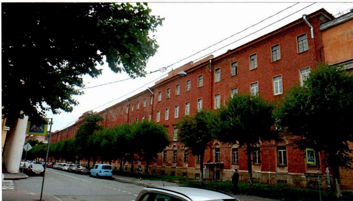
1. «Здание Дворянского полка». Общий вид с юга.
