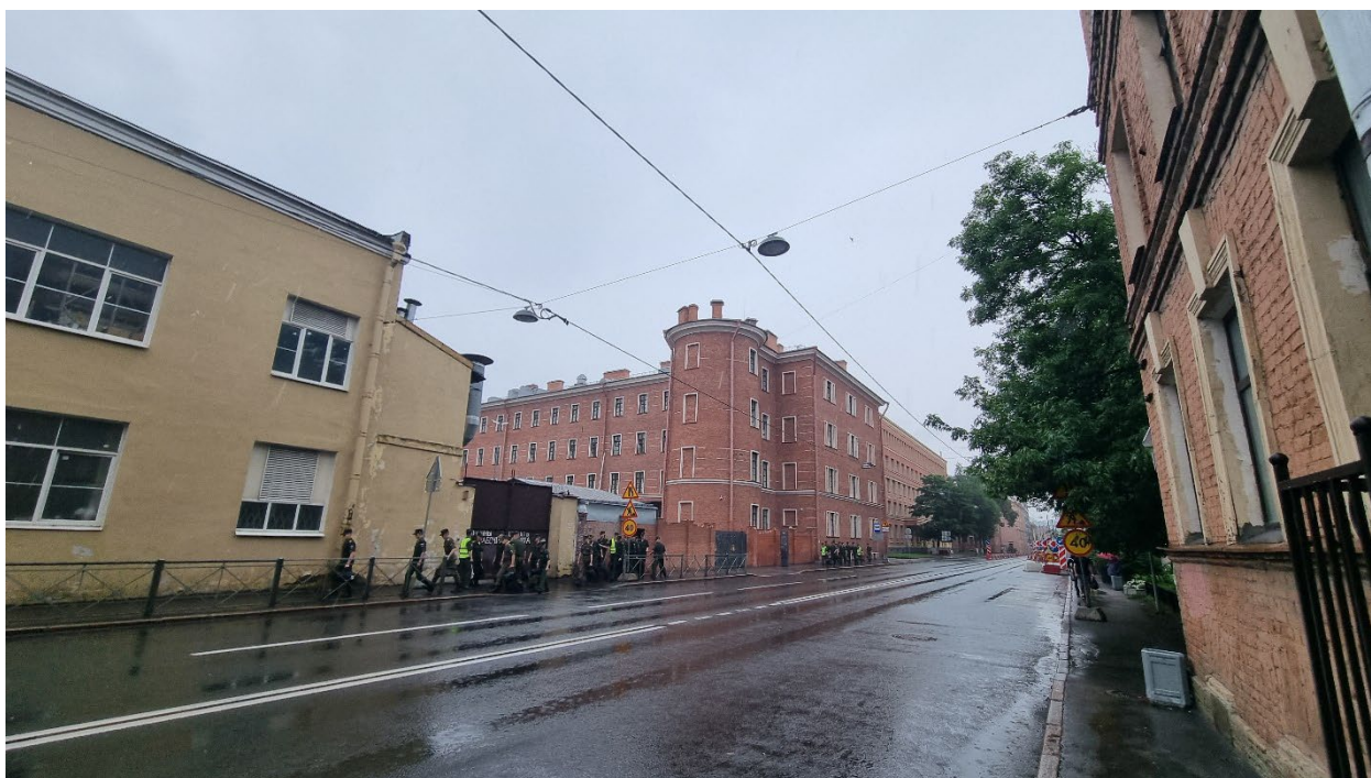
8. Вид на объект реконструкции и северо-восточный фасад объект культурного наследия регионального значения «Здание Дворянского полка», расположенного по адресу: г. Санкт-Петербург, Пионерская ул., д. 28, литера А. 14.06.2024
