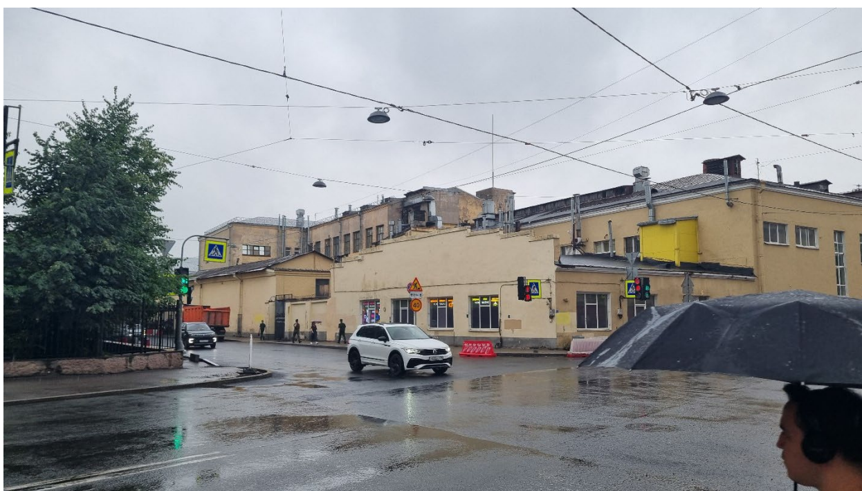
12. Вид на объект реконструкции, расположенный по адресу: г. Санкт-Петербург, ул. Красного Курсанта, дом 19. 14.06.2024
