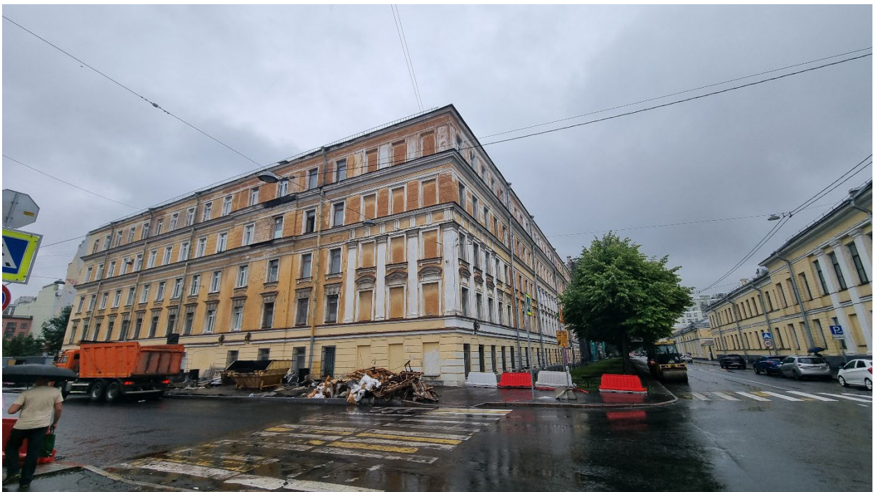
2. Вид на юго-западный и юго-восточный фасады объекта культурного наследия регионального значения «Здание, где с 1886 г. размещалось военно-топографическое училище, в котором преподавали Цингер Н.Я. и Витковский В.В.» расположенный по адресу: г. Санкт-Петербург, Пионерская ул., д. 20, литера Б. 14.06.2024
