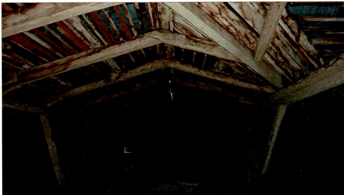
7. Чердак. Стропильная система.
