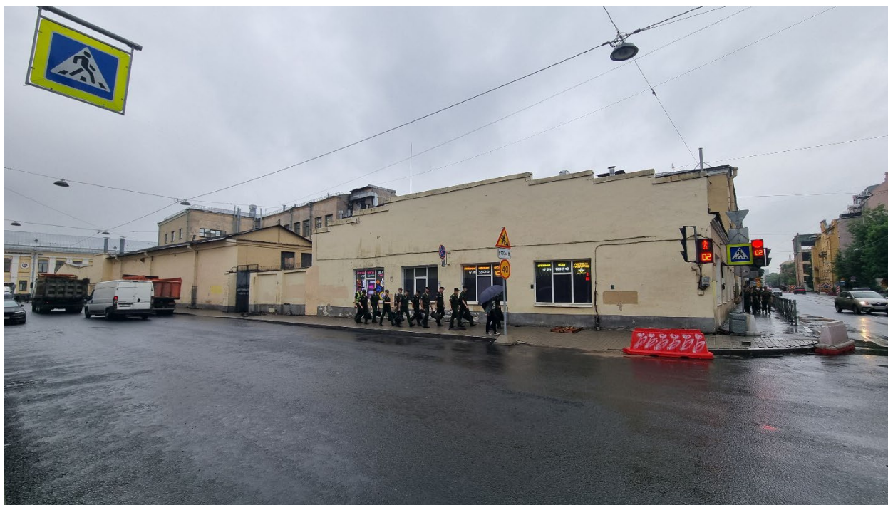
13. Вид на объект реконструкции, расположенный по адресу: г. Санкт-Петербург, ул. Красного Курсанта, дом 19. 14.06.2024
