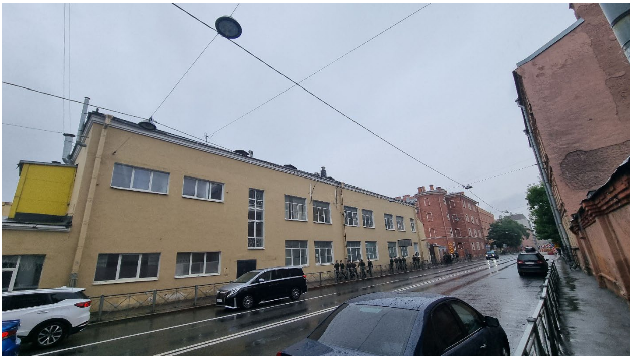
11. Вид на объект реконструкции. 14.06.2024
