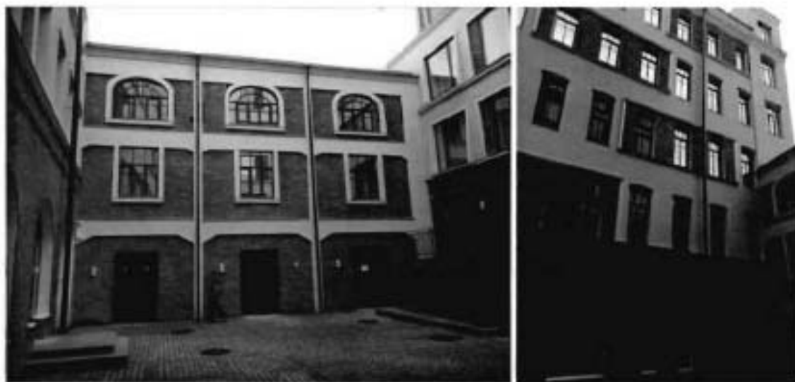
7, 8. Фасад лицевого корпуса по наб. Адмиралтейского канала
