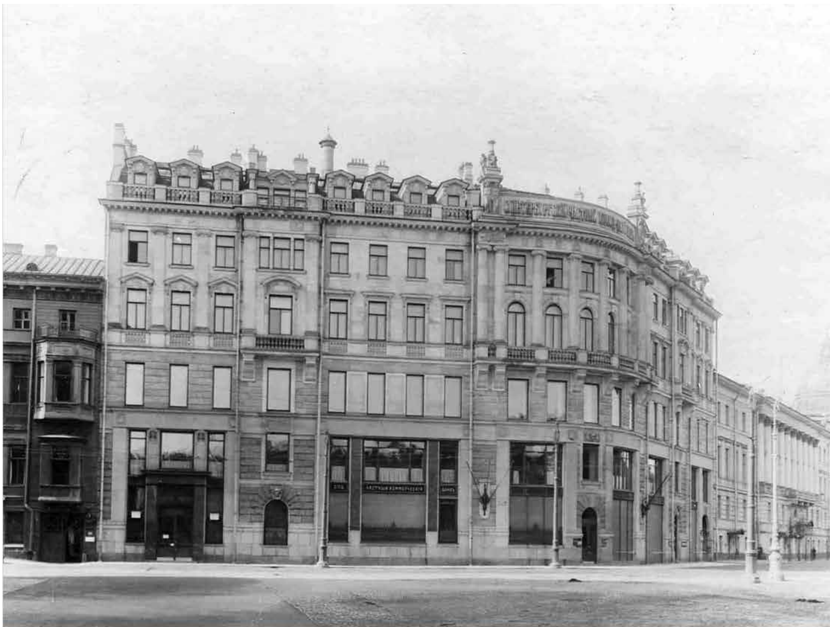
22. Внешний вид здания Петербургского частного коммерческого банка (Невский пр., д.1). 1914 г. Фотография ателье Буллы. // Источник: ЦГАКФФД СПб Е 8561.
