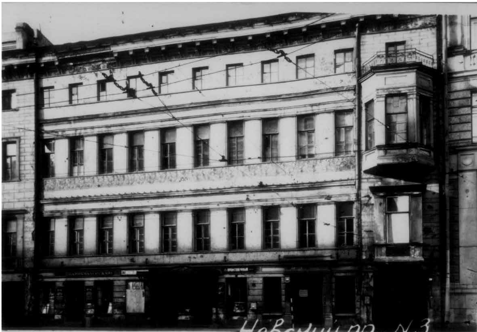
31. Фасад дома №3 на Невском проспекте. Фотография. Автор неизвестен. 1949 г. // Источник: ЦГАКФФД СПб Гр 72068.
