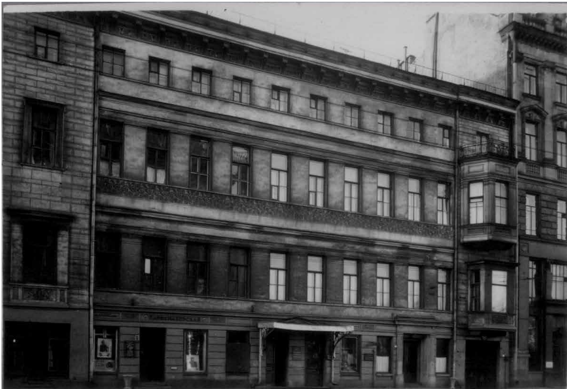
30. Фасад дома №3 на Невском проспекте. Фотография. Автор неизвестен. 1949 г. // Источник: ЦГАКФФД СПб Гр 72067.
