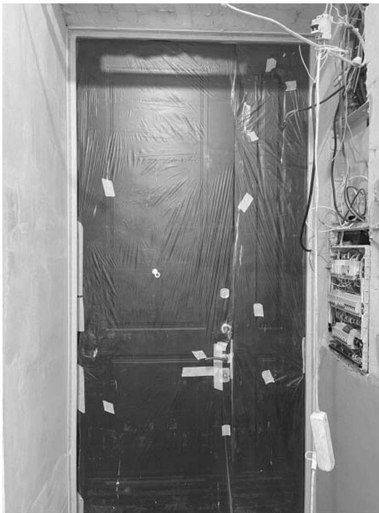
4. Вид на входную дверь в квартире;
