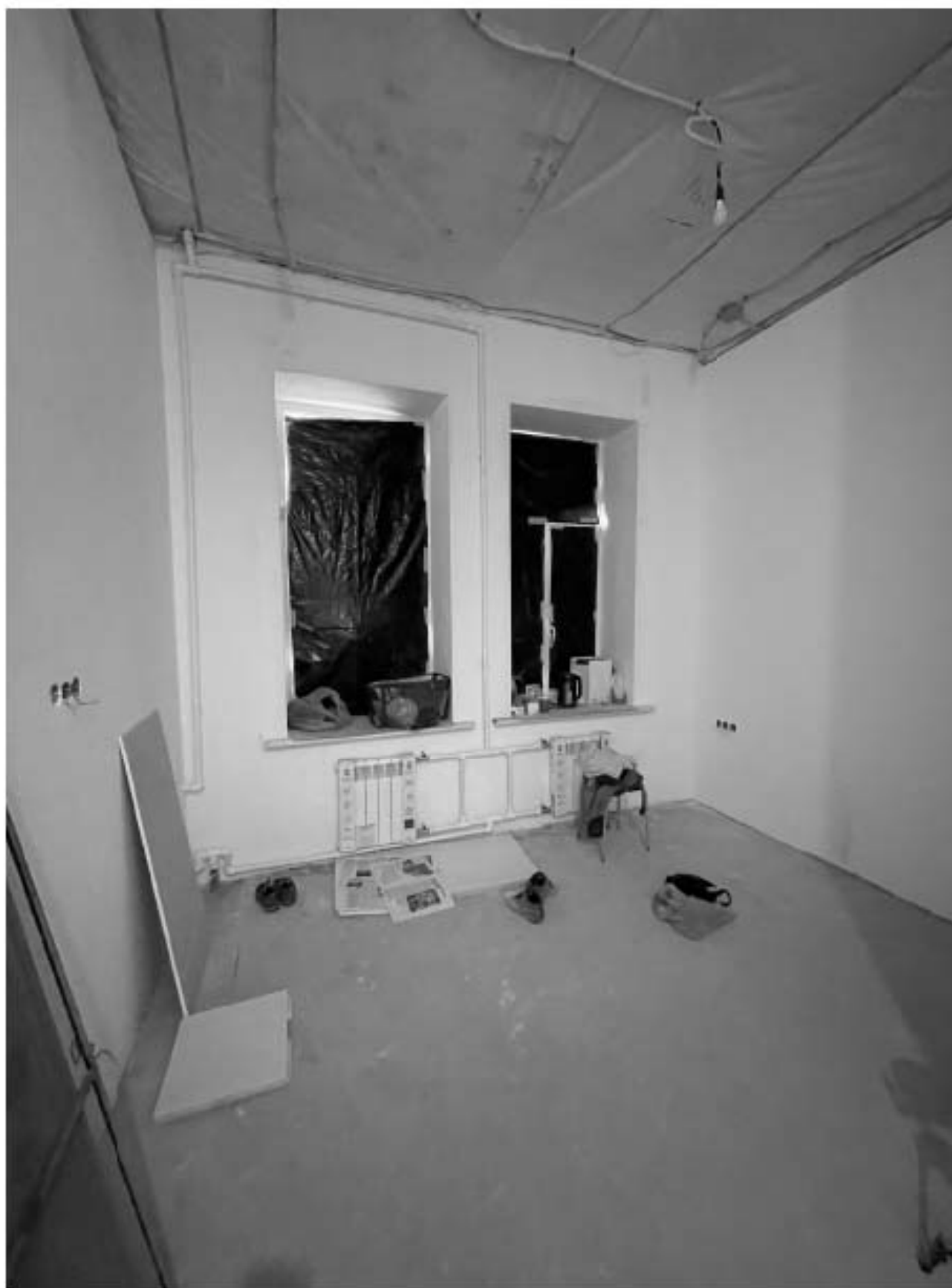
15. Фрагмент интерьера комнаты (помещение 5/17.1);
