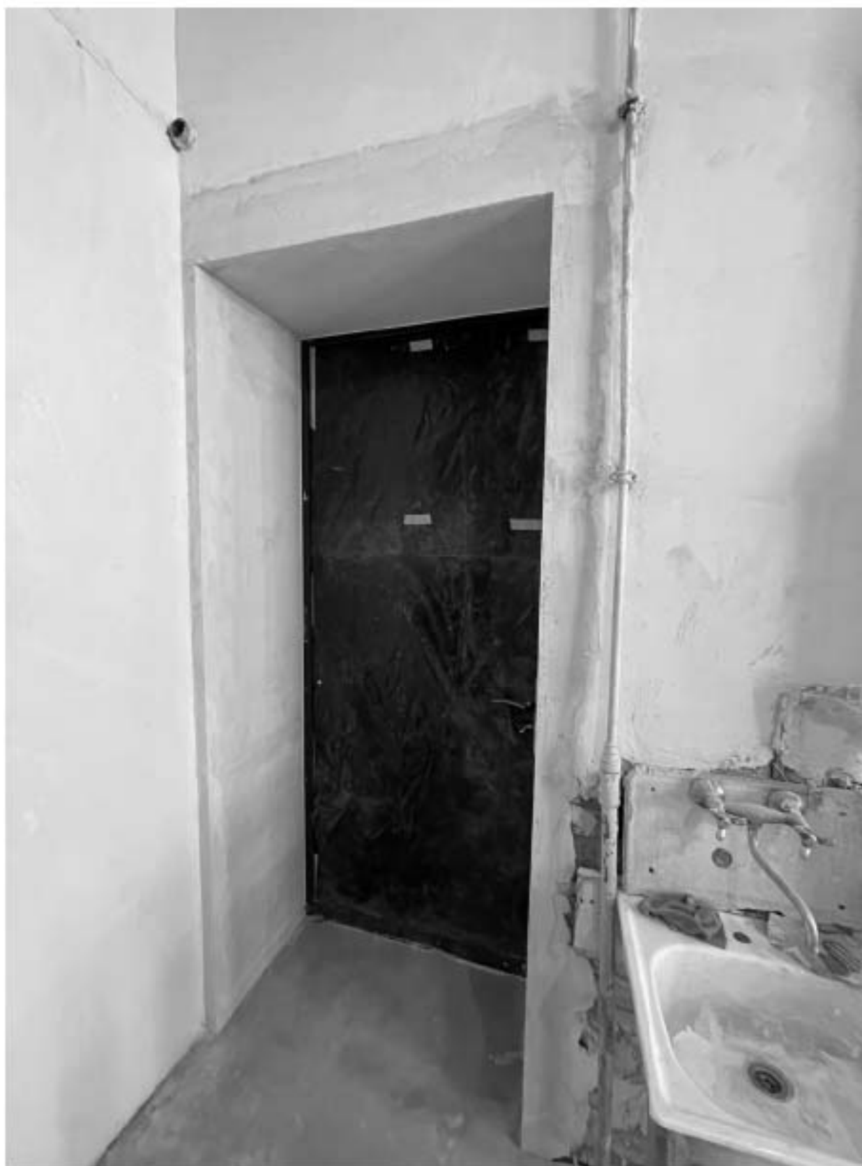
13. Вид на входную дверь в квартире;
