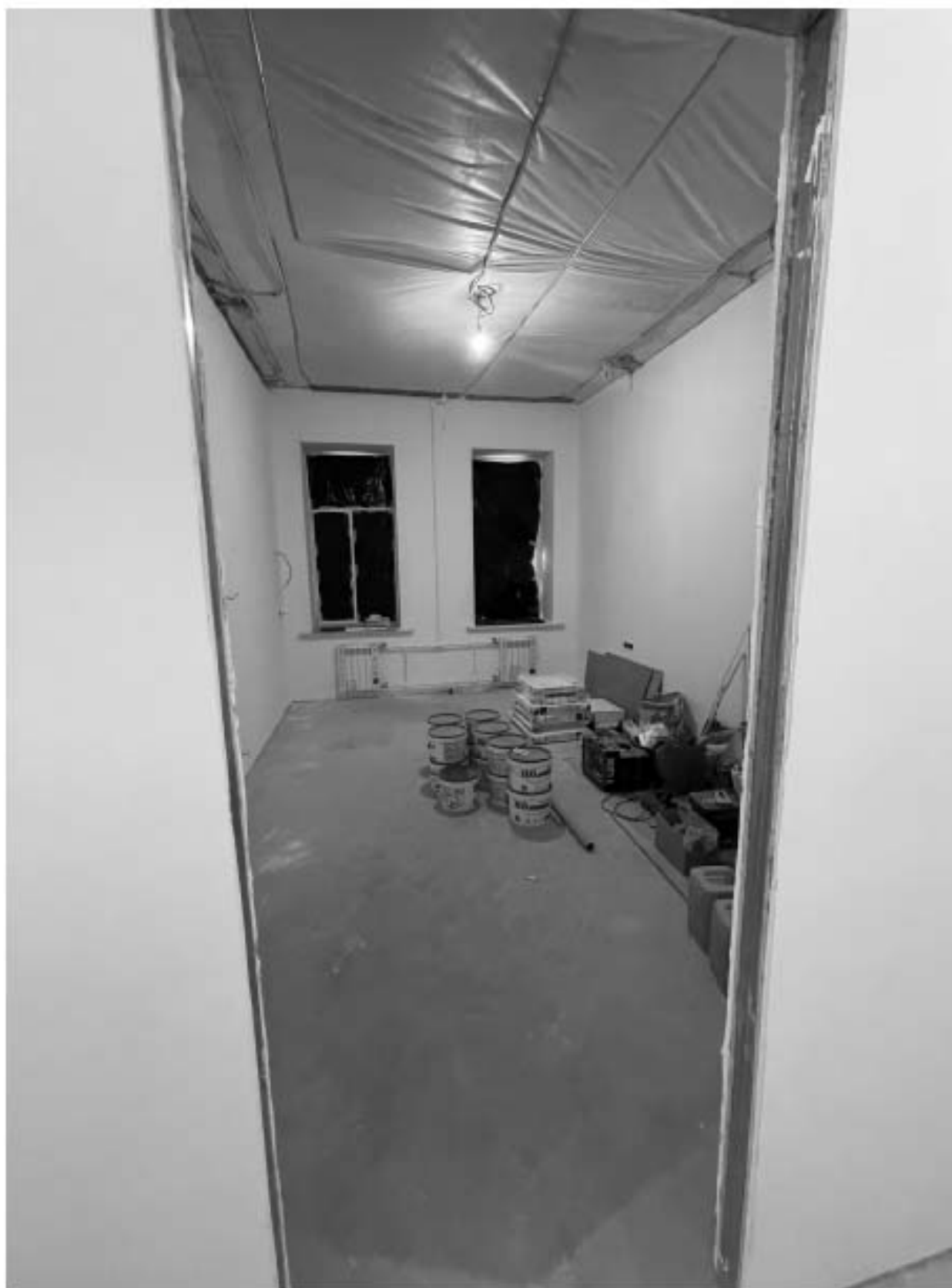
17. Фрагмент интерьера комнаты (помещение 6/23.3).
