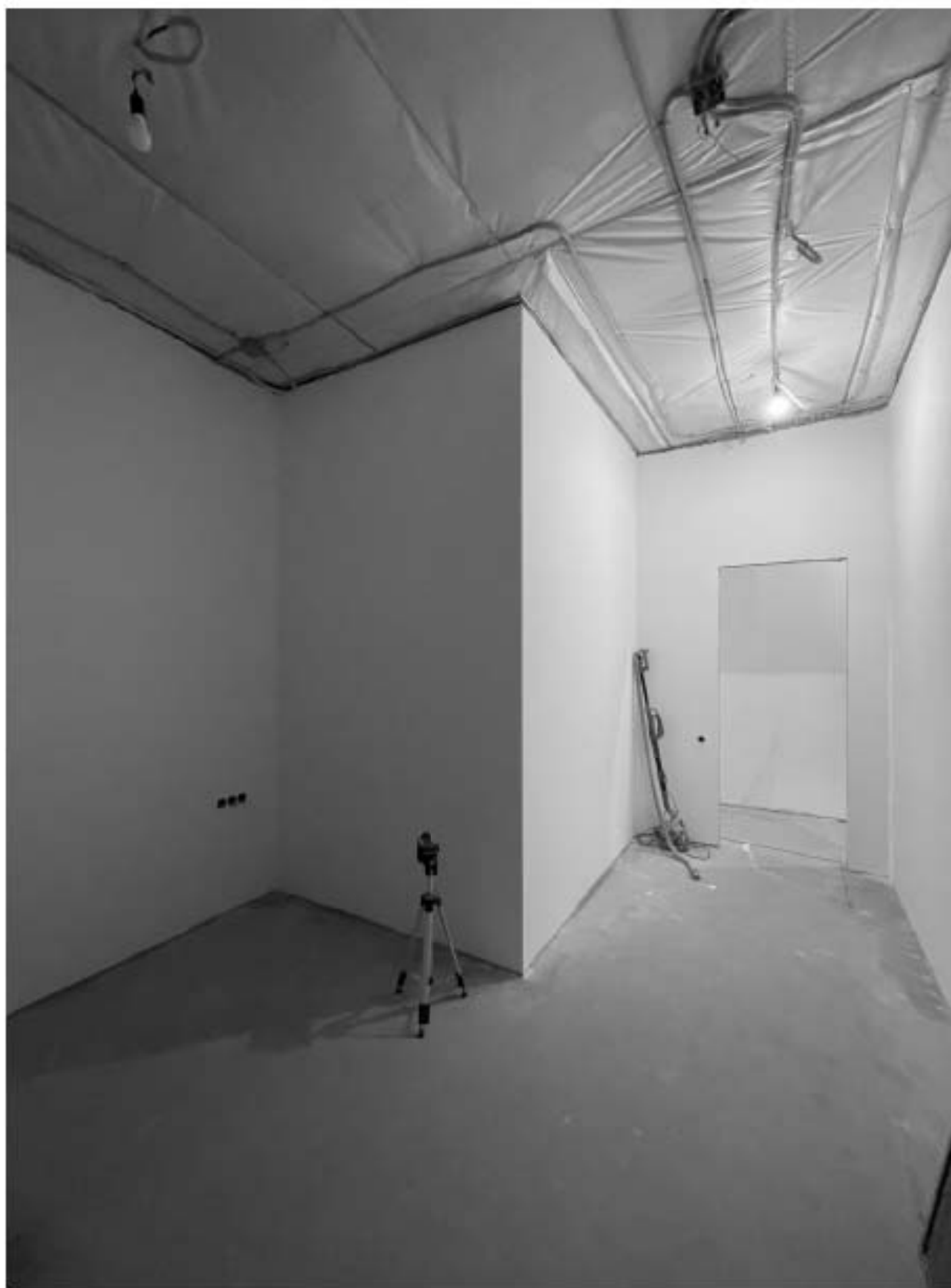
16. Фрагмент интерьера комнаты (помещение 5/17.1);
