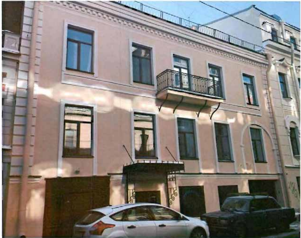
1. Лицевой фасад. Общий вид.
